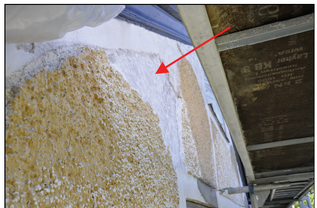
Samtliga fasadens äldre slätputsade partier fanns kvar under den sekundära spritputsen.
