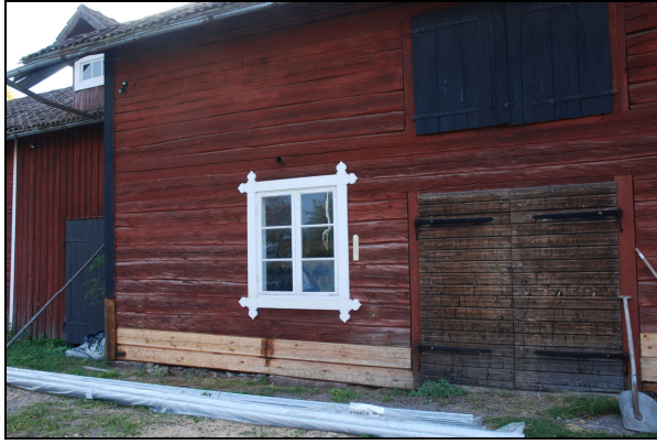
Nytt timmer, östra fasadens södra del.
