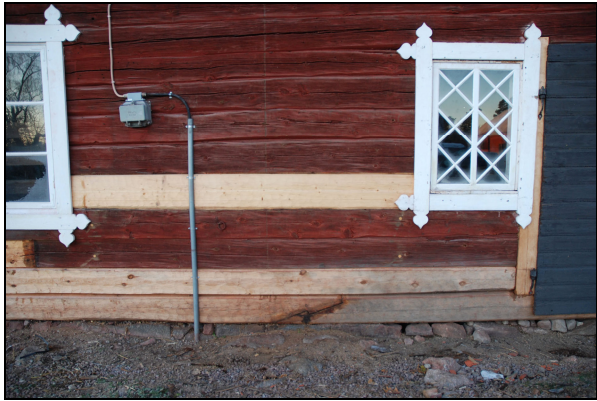
Nytt timmer, östra fasadens mitt.
