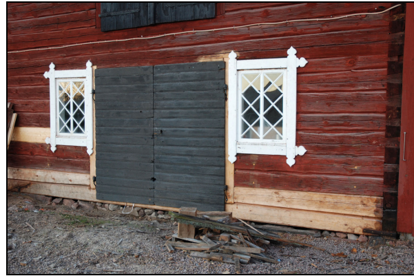
Nytt timmer, östra fasadens norra del.
