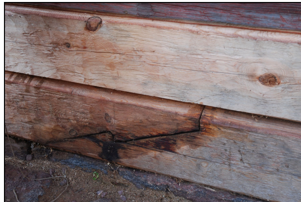
Närbild blixtskarv, struken med tjära för extra skydd.
