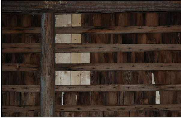
Skarvning med kluvna bitar av brädor.
