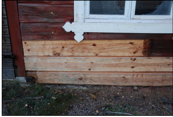
Nytt bilat timmer, östra fasadens mitt.
