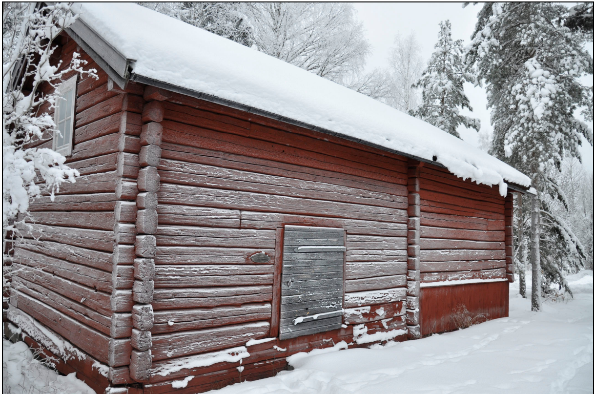
Kaplansboden före restaurering.
