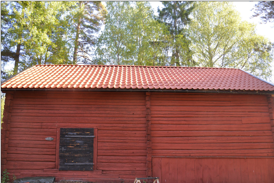
Byggnadens västra fasad efter takläggning.
