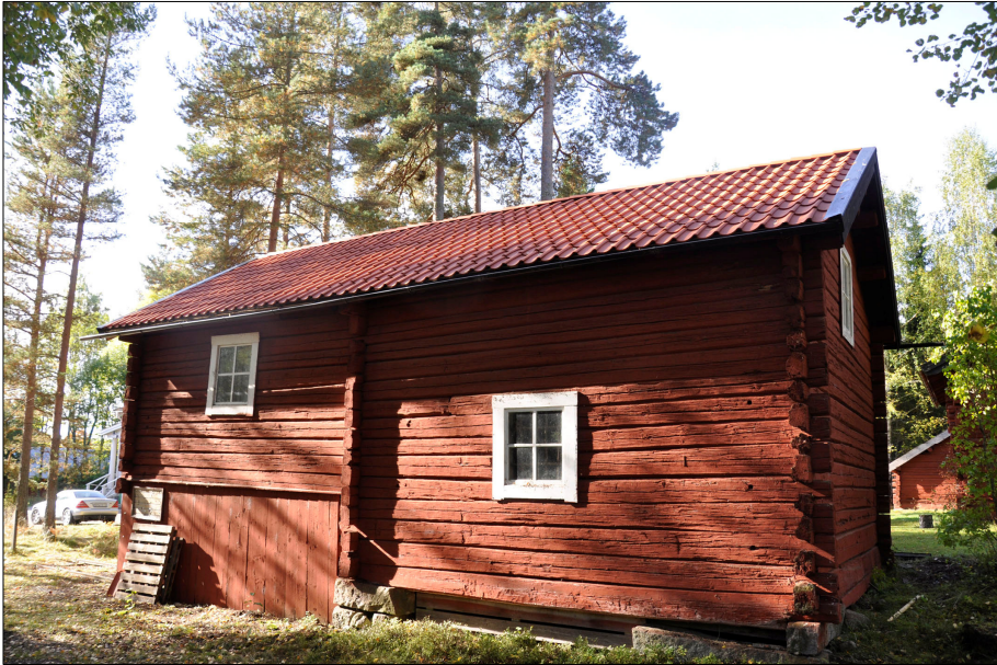
Byggnadens östra fasad efter takläggning.
