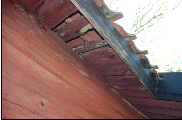
Fotbrädan spikad i ändträt på det gamla locktaket med rötskadat undertak som följd.
