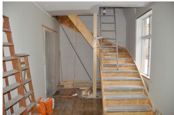
Bild 10 Pågående arbete med den nya trappen
