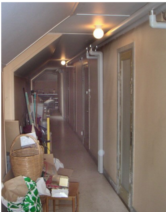
Bild 3 Befintlig korridor på vindsvåningen
