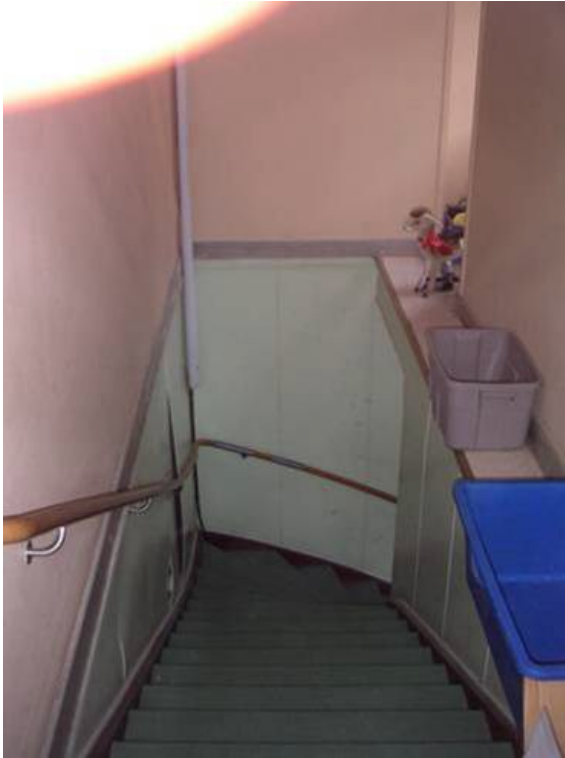
Bild 6 Befintligt trapphus ut mot Rådmansgatan
