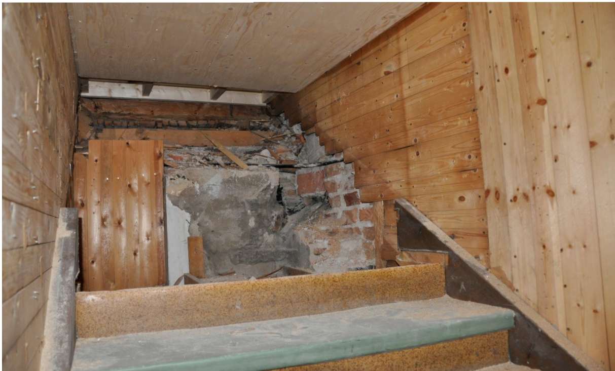
Bild 8 Trappan igensatt med skivor som bildar golv till en av lägenheterna i vindsvåningen.
