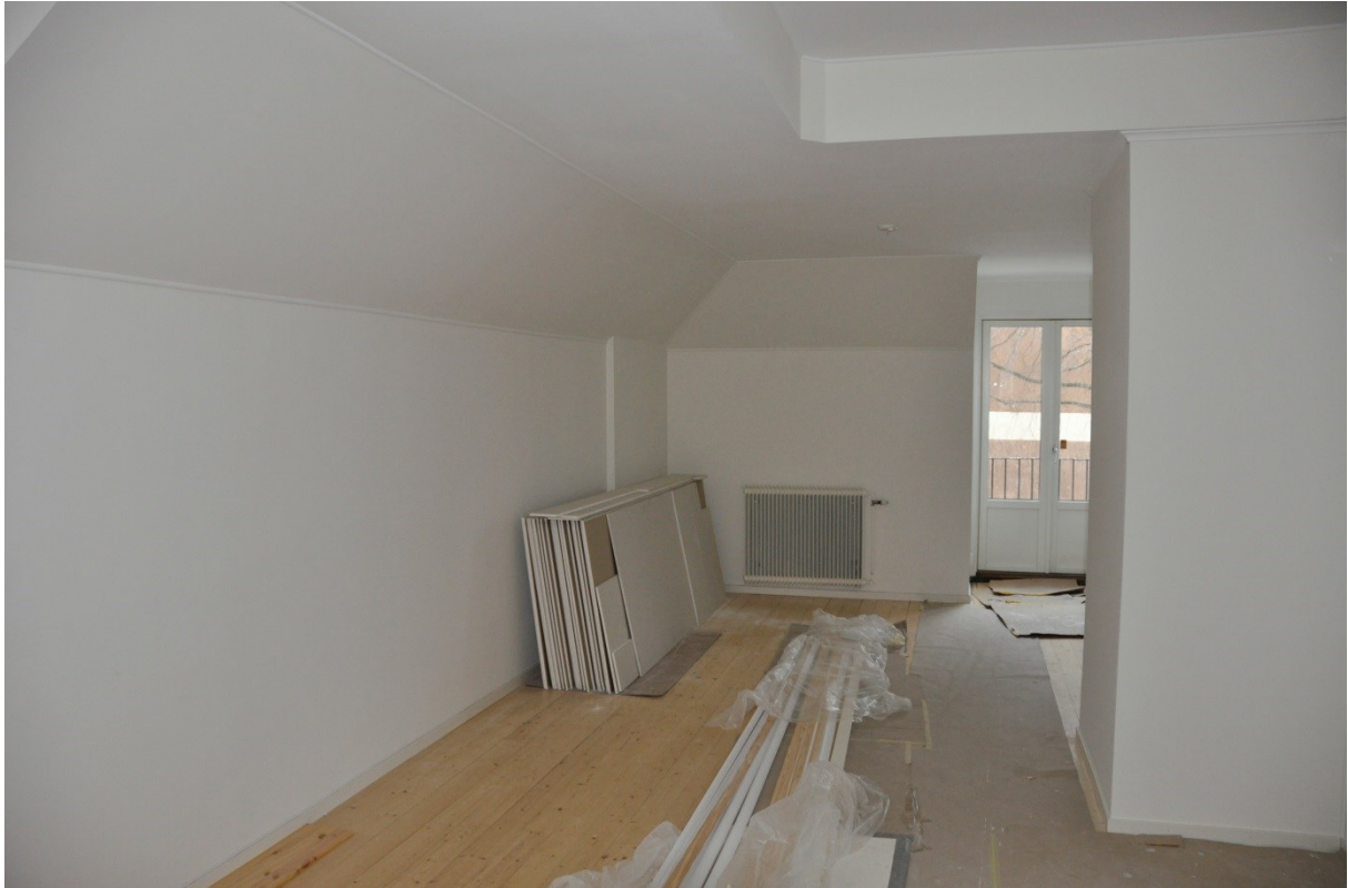
Bild 4 Inredd lägenhet med förändrad planlösning på vindsvåningen
