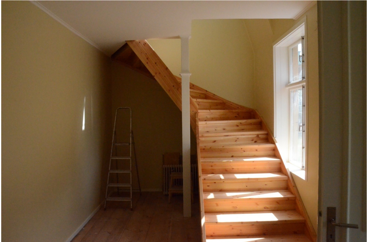
Bild 11 Ny trapp installerad
