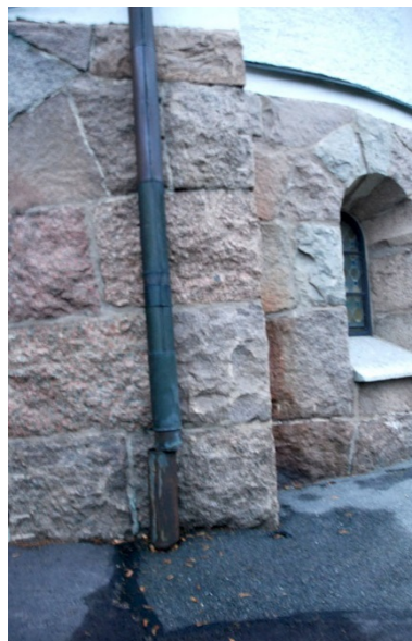
Kyrkans vattenavrinning var undermålig och fuktskador återfanns i kyrkan.
