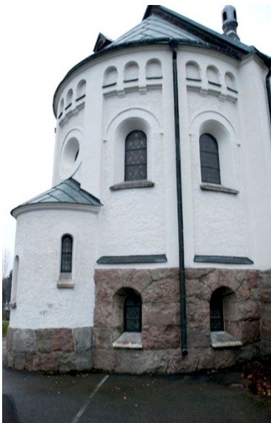
Kyrkans vattenavrinning var undermålig och fuktskador återfanns i kyrkan.
