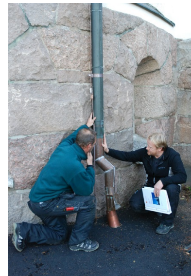
Nytt vattensystem har grävts ned, stuprör har lagats och kompletterats med lösilar.
