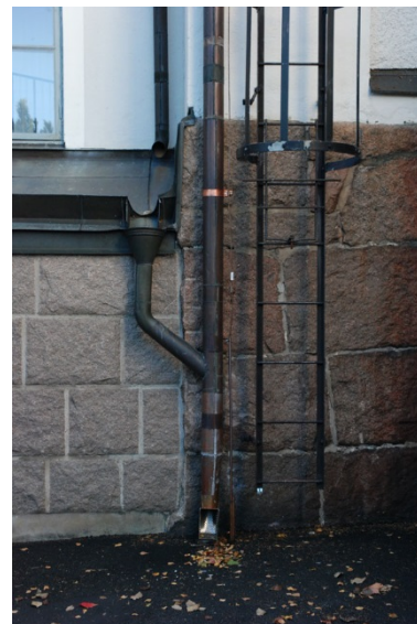
Nytt vattensystem har grävts ned, stuprör har lagats och kompletterats med lösilar.
