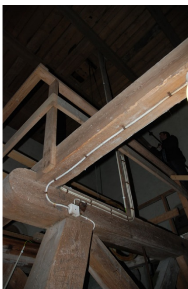
Det nya åskskyddet monterades efter stuprännor och ledningar drogs på vinden och på väggen vid orgelläktaren.
