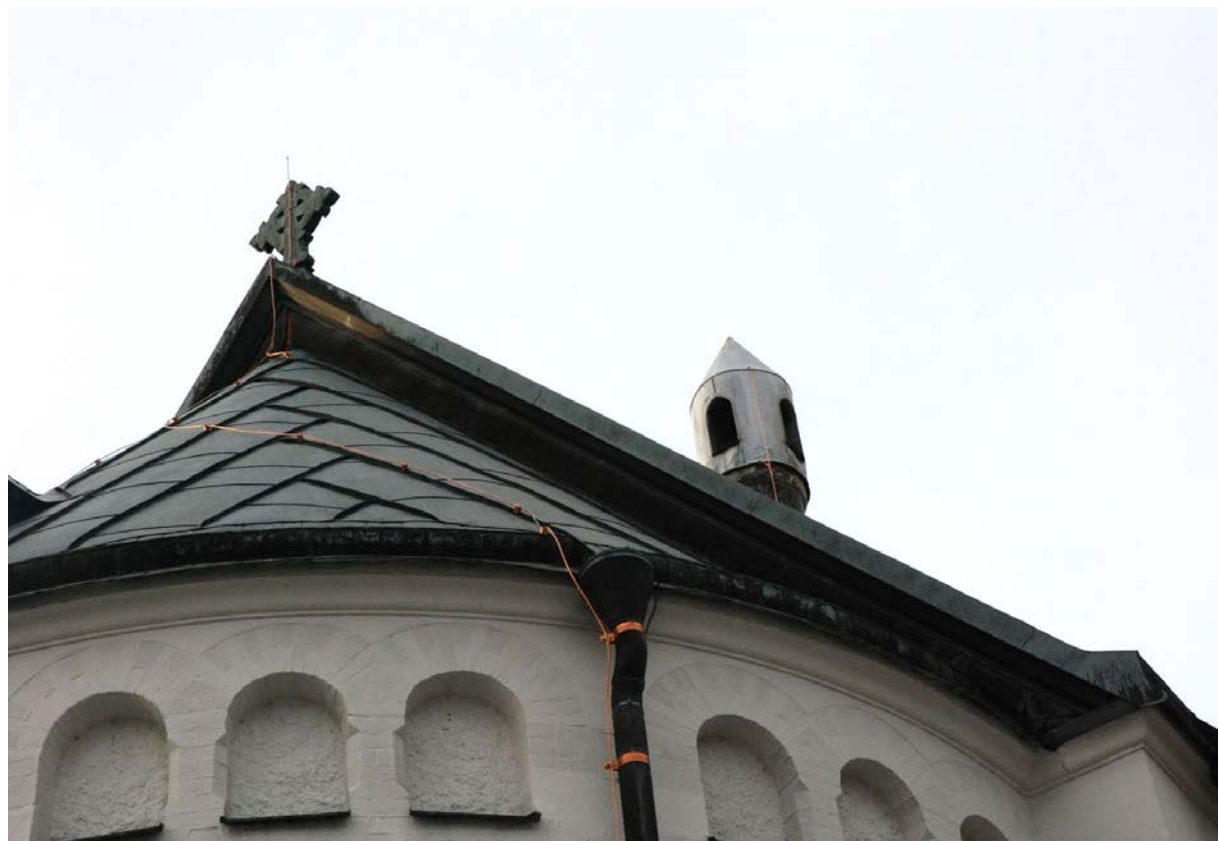
Ny kommarlina för åskskyddet monterades efter hängrännor och i koppertakets falsar.
