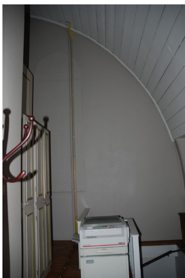
Det nya åskskyddet monterades efter stuprännor och ledningar drogs på vinden och på väggen vid orgelläktaren.
