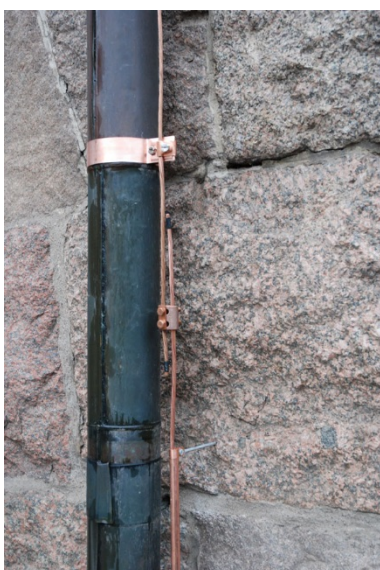
Det nya åskskyddet monterades efter stuprännor och ledningar drogs på vinden och på väggen vid orgelläktaren.
