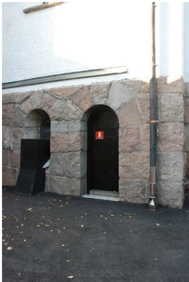
Nytt vattensystem har grävts ned, stuprör har lagats och kompletterats med lösilar.
