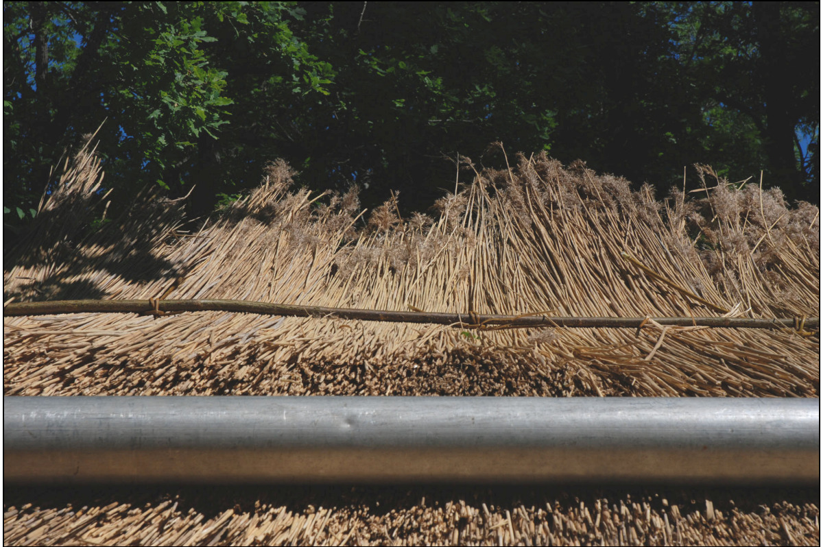
Vassläggning pågår. Foto: Vlm_kmvLS-398 taget av Anna Ahlberg.
