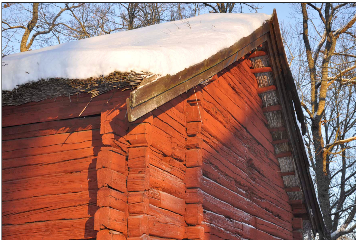
På bilden syns skador i, och bortfall av, vindskivor. Foto taget i januari 2010 av Lisa Skanser.
