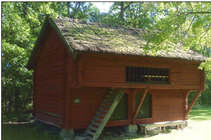
Loftboden i september 2009. Vasstaket är slitet och vassen ihopsjunken. De under vassen bundna hasselkäpparna är synliga. Foto: Kjell Gunnarsson.
