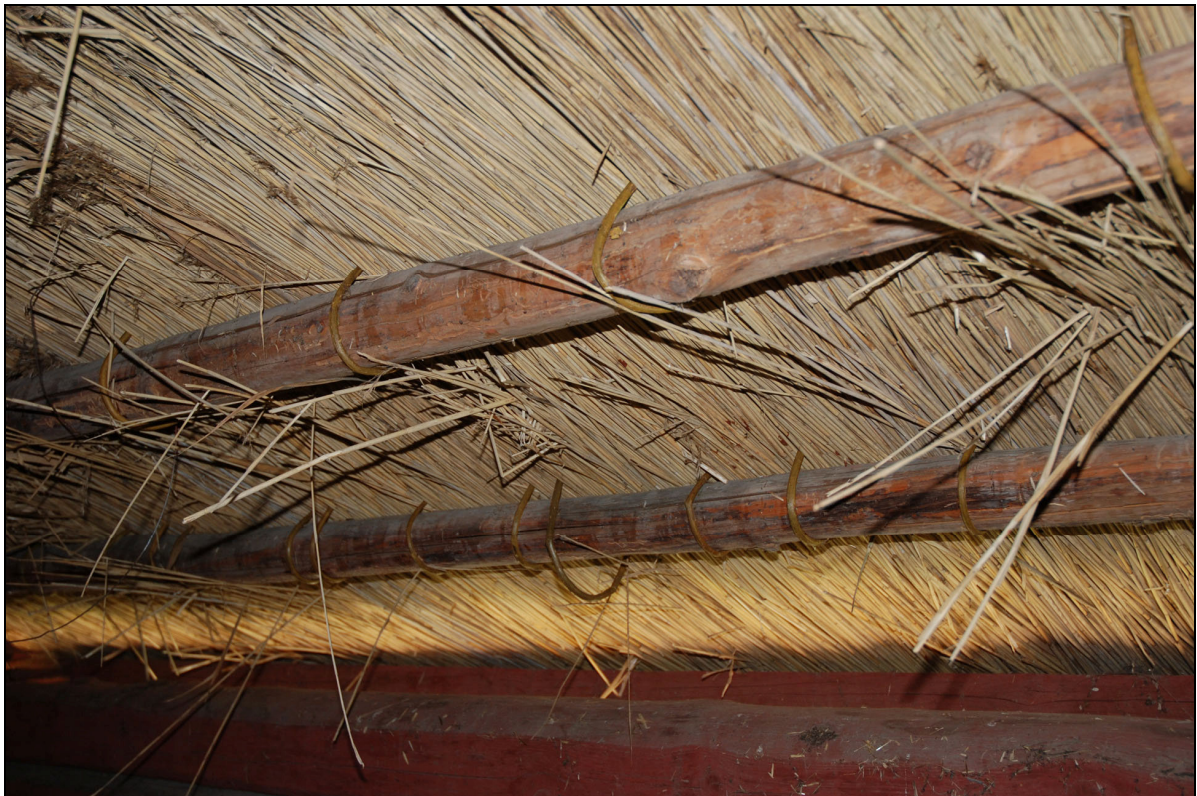
Taket från insidan, salixvidjornas omslag runt åsarna syns. Foto: Vlm_kmvLS-412 taget av Lisa Skanser.
