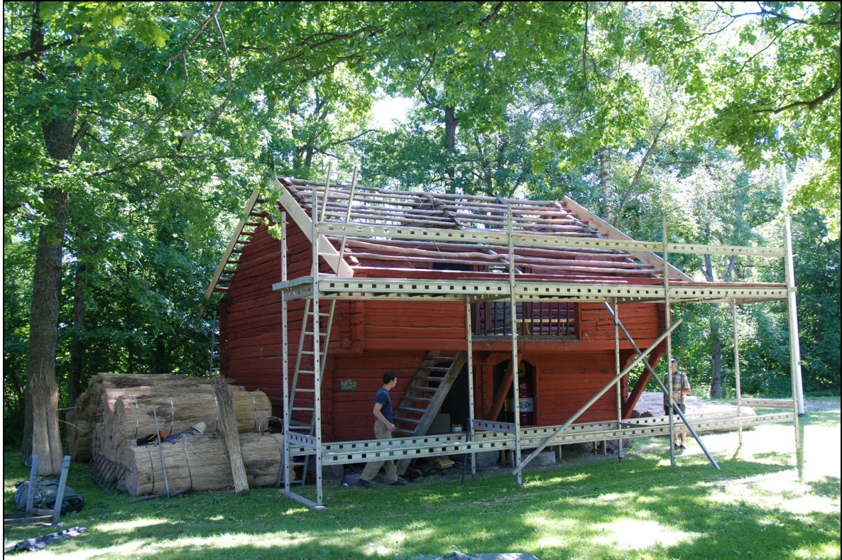
Nya vindskivor har monterats och vassläggningen skall påbörjas. På bilden syns Joar Nilsson till vänster och till höger skymtar Yngve Kullgren, styrelseledamot i sockengillet. Foto: Vlm_kmvLS-382 av Anna Ahlberg.
