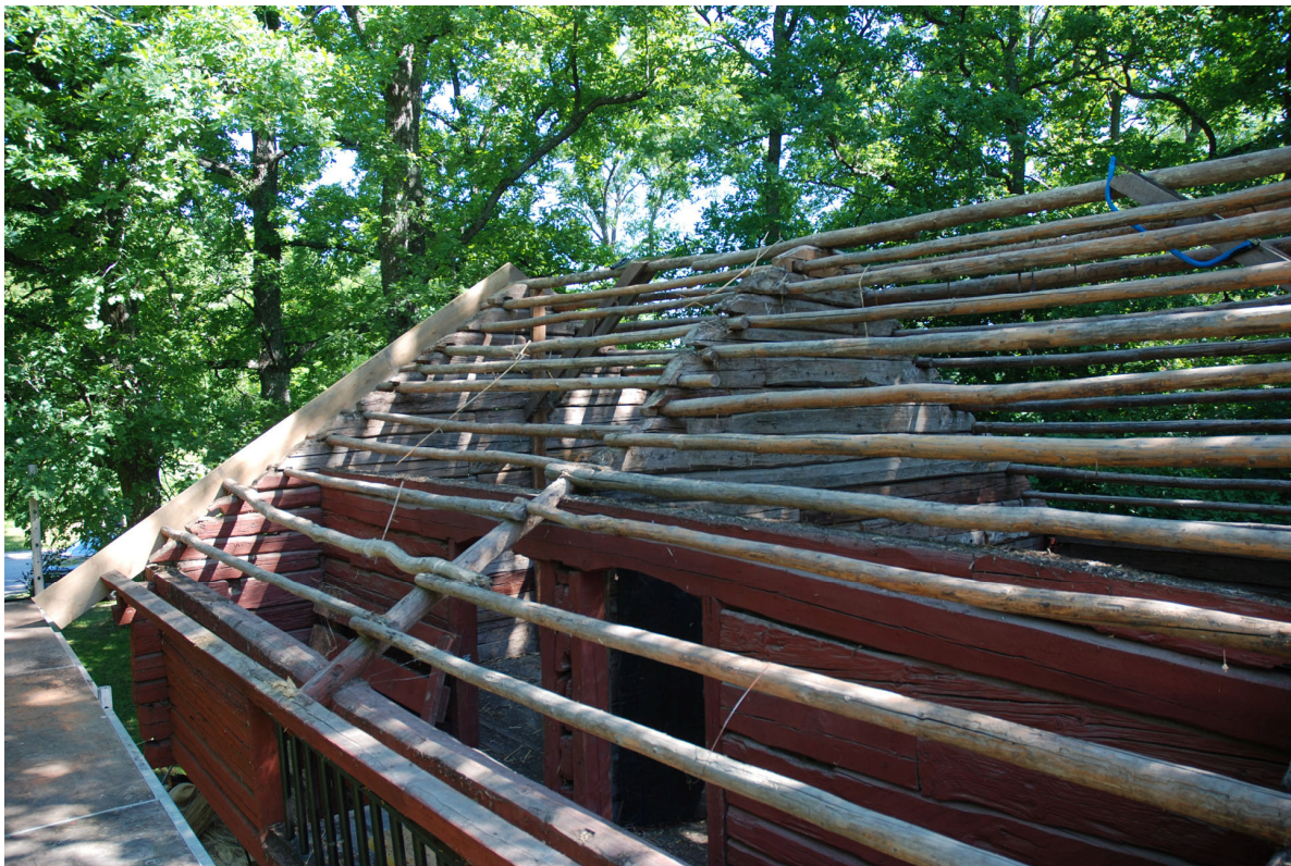
Åsar av granslanor, en ås för vardera timmerstock i röstet. Foto: Vlm_kmvLS-395 taget av Anna Ahlberg.
