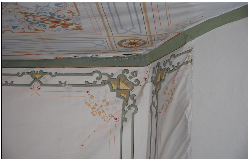
I hörnet invid spismuren fanns deformation av pappen. Tidigare ägare hade spikat fast pappen där den spruckit och retuscherat med en avvikande kulör.
