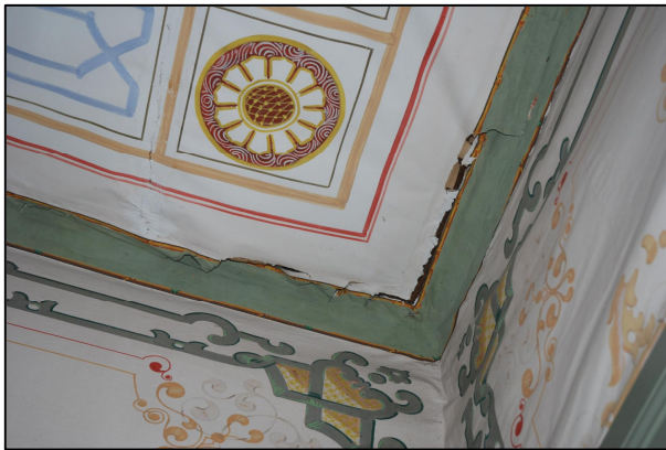
I det sydvästra hörnet i rum XII var sprickbildningen kraftig. Till vänster syns hörnet före konservering och till höger under konserveringen.
