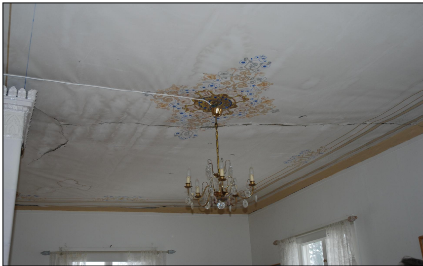
Rum XIV efter att väggen tagits ned. Tvärs över taket går en kraftig spricka.
