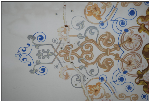
En kraftig spricka skar igenom takrosen i rum XIV. Till höger syns taket efter restaurering.
