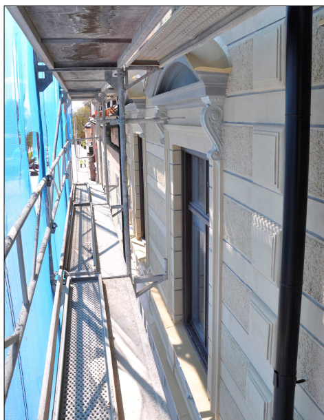
För att understryka koadrerindelningen på övervåningen målades fogarna grå.
