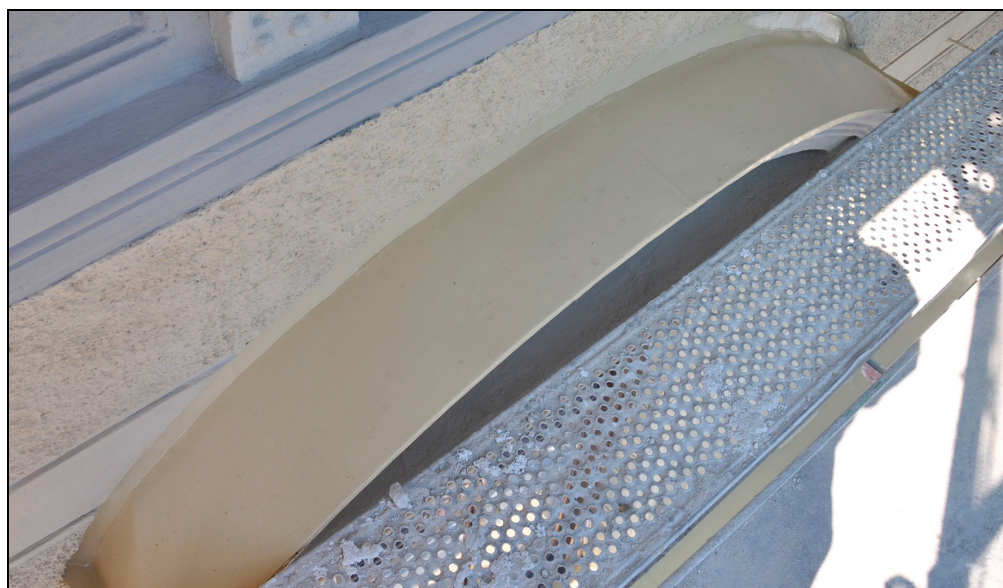
Plåt detaljerna målades med linoljefärg i en gul kulör som överensstämde med den gula kalkfärgens kulör.
