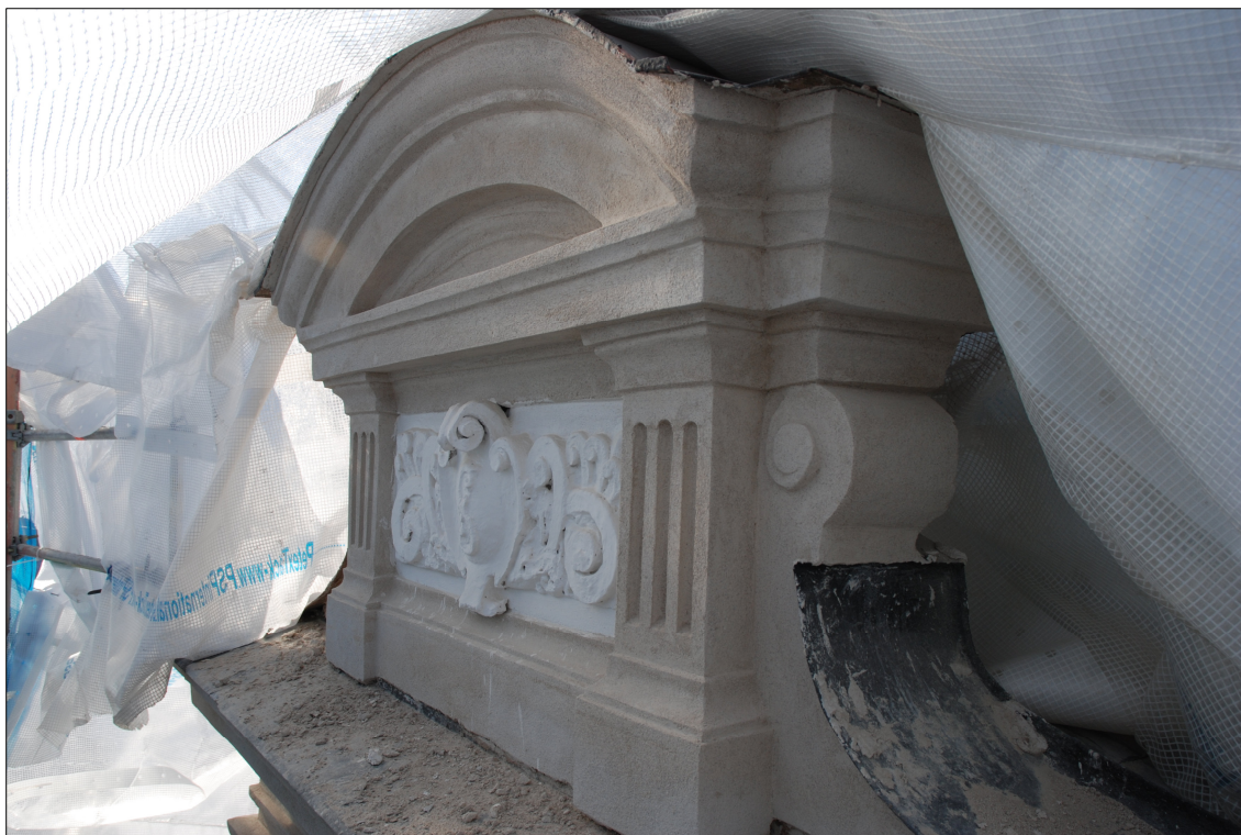
Stora sammanhängande delar av fasaden fick byggas upp på nytt.
