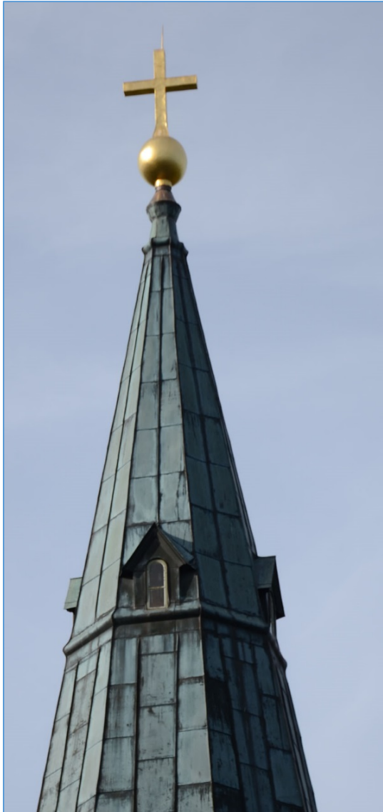
13. Tornfönster innan renoveringen
