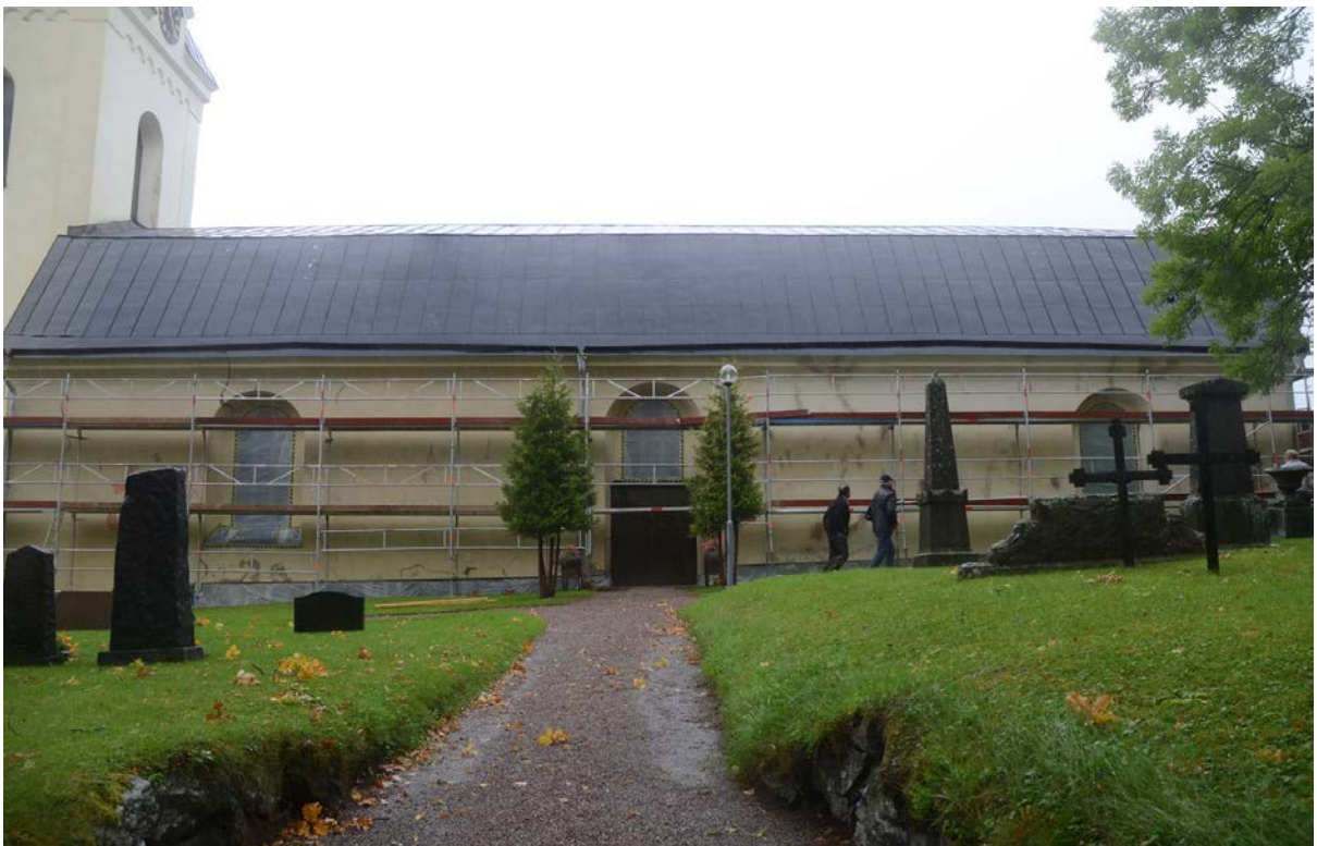
29. Södra fasaden under fasadarbetet.
