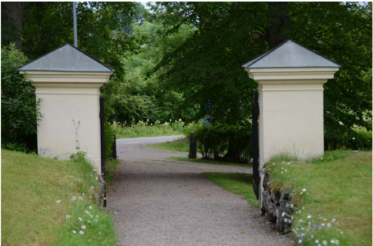
50. Stigporten mot söder innan renoveringen.
