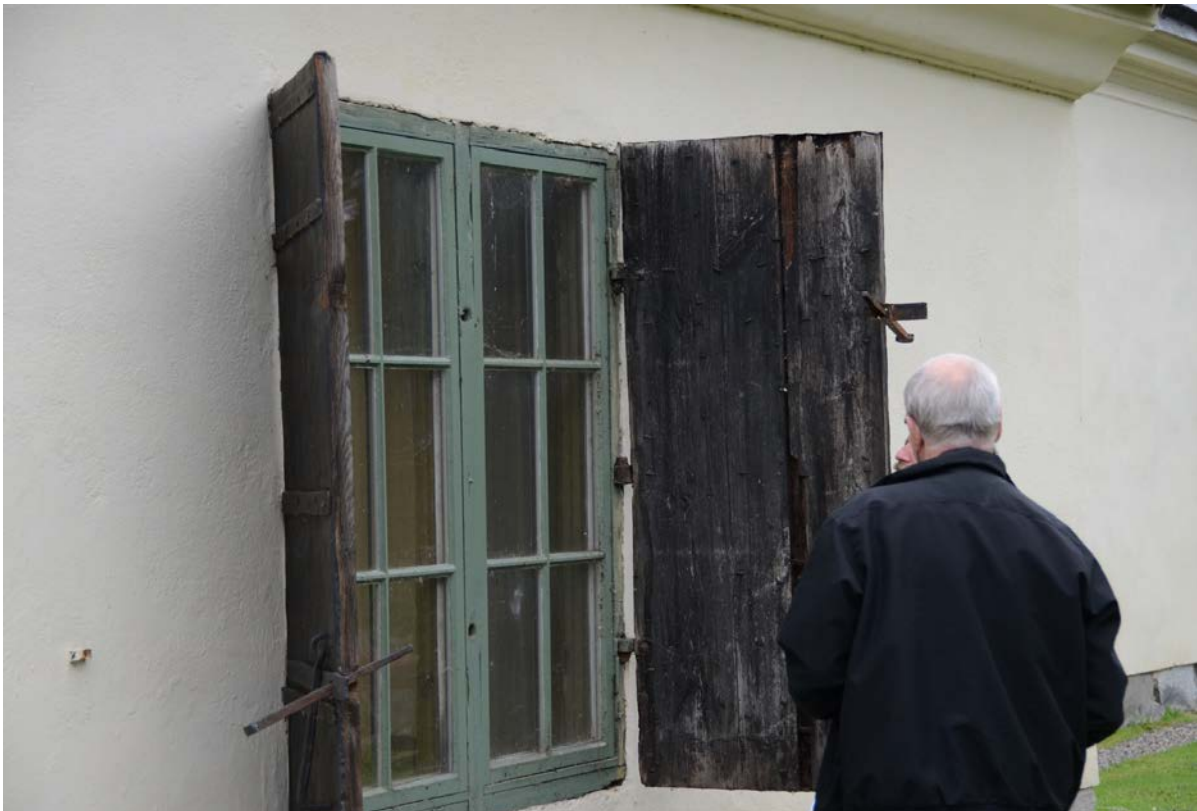
16. Luckorna vid sakristians fönster är plåtbeklädda.
