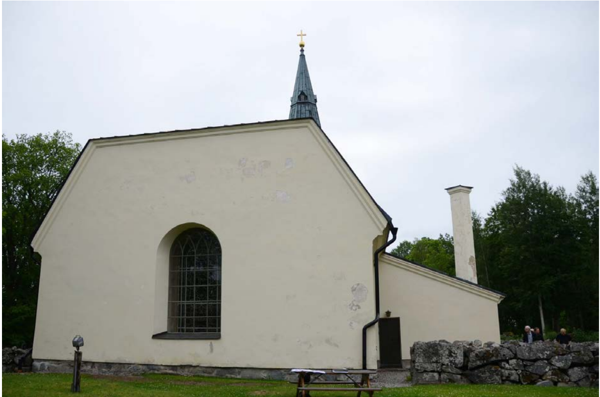
28. Fasad mot öster innan fasadrenoveringen.
