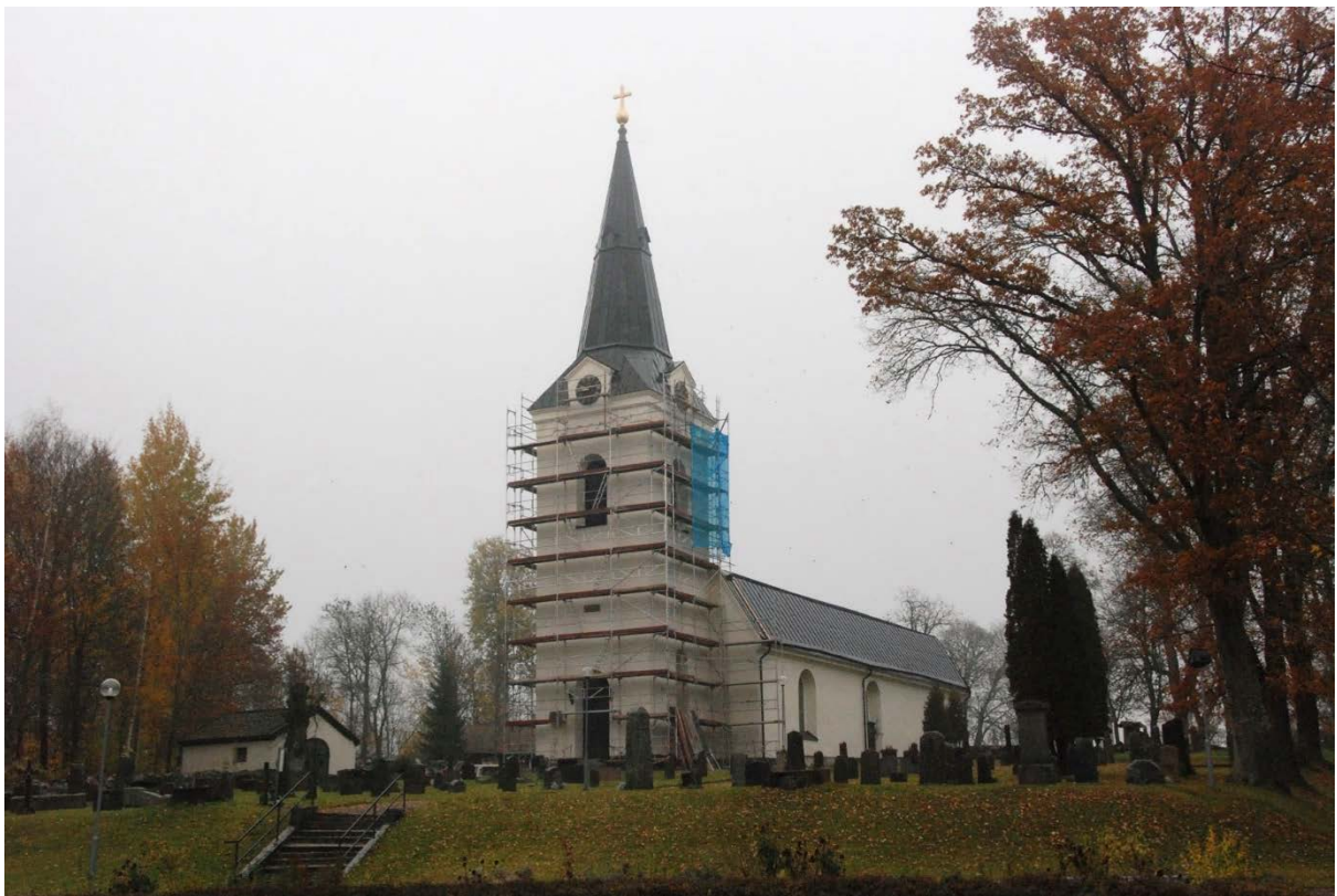
40. Fasadarbetet på tornet genomfördes allra sist.
