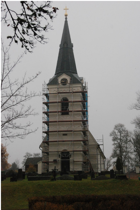
37. Tornet under pågående arbete.
