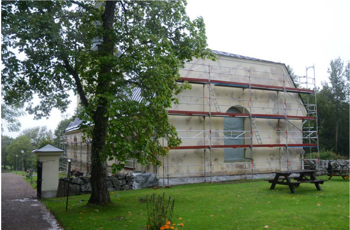
34. Östra fasaden under pågående arbete.
