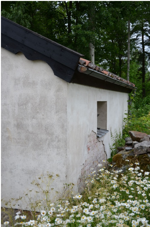
41–43. Bårhuset innan renoveringen. Pust har släppt på den norra fasaden. Häng- och stuprännor läcker.
