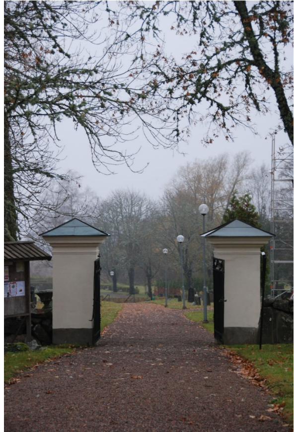
49. Stigporten efter renoveringen.
