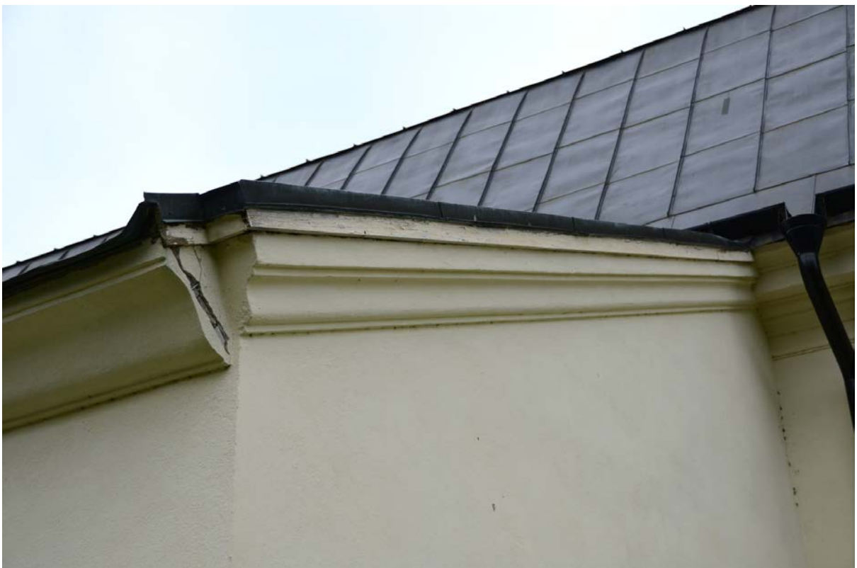
33. Sprickor i takfoten.
