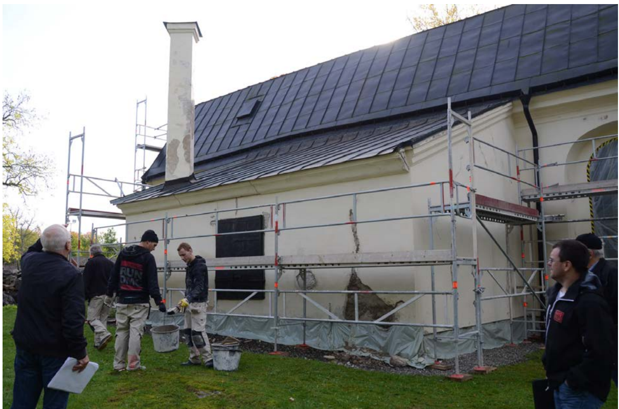
31. Lagning av fasadputs på norra fasaden.
