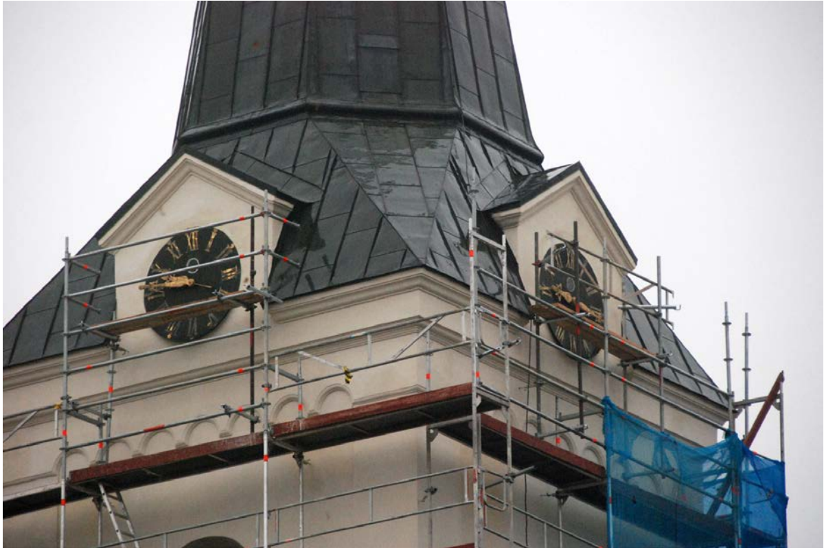
55. Blecken över urtaolorna är bortmonterade och putsningsarbete pågår.
