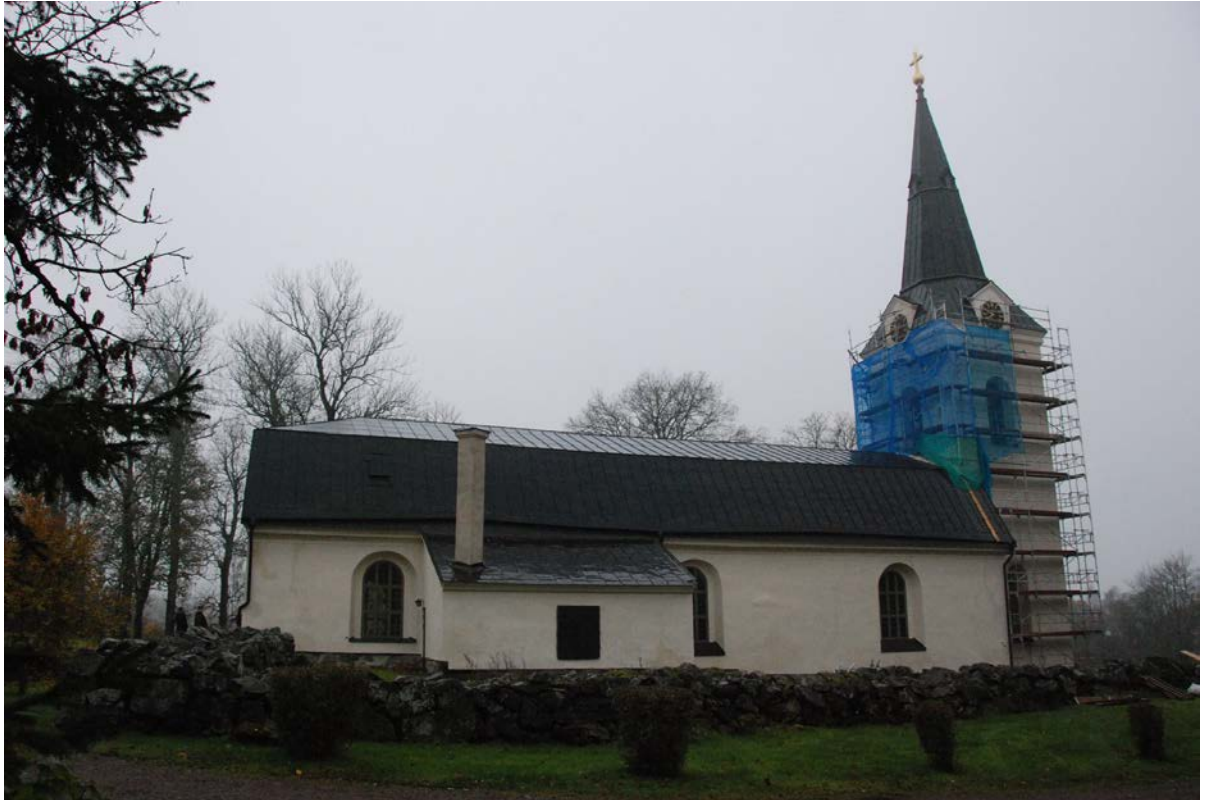
36. Norra fasaden vid slutbesiktningen, omputsad och avfärgad
