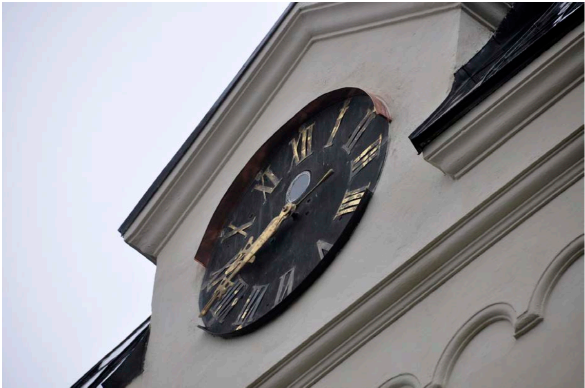
56. Ny puts runt urtaolan och det nya droppblecket av kopparplåt.
