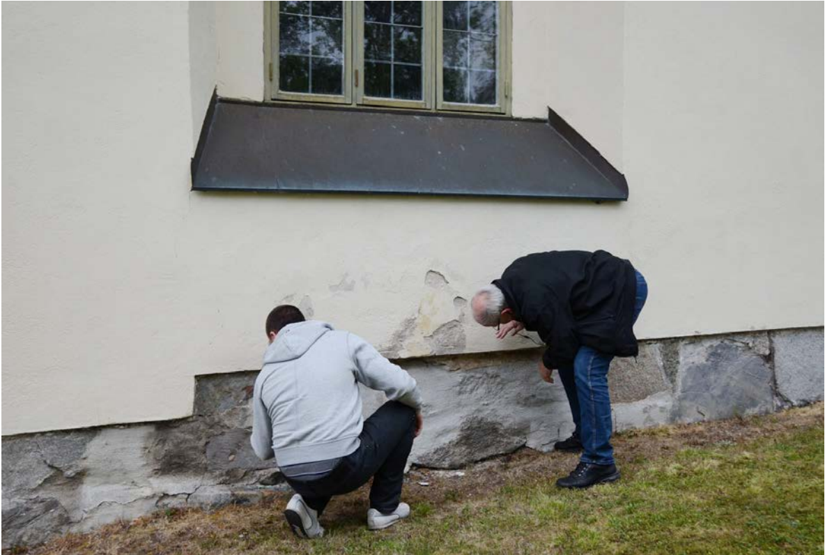
23. Putssläpp under fönster mot söder.
