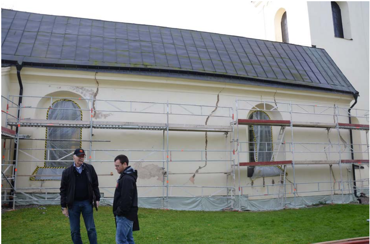
30. Putsen vid sprickor hackas bort och fylls upp med ny puts.
