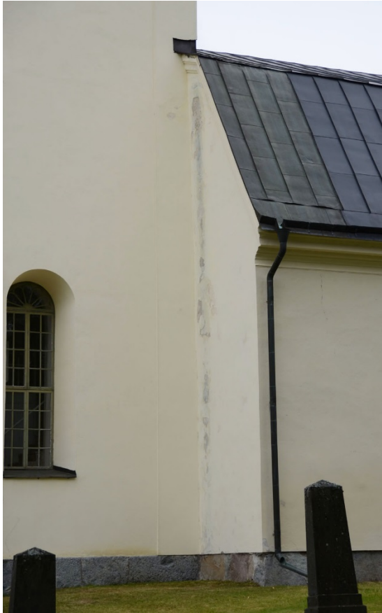
25–26. Vatten har runnit på fasaden på grund av felaktigt riktad plåt. Omfattande putssläpp på tornet.
