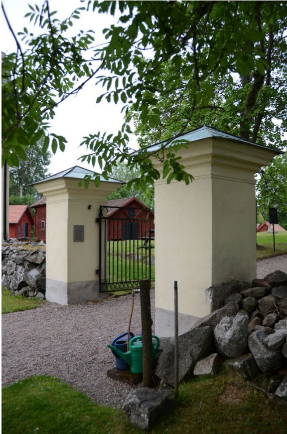
48. Putsskador vid anslutningen till muren.
