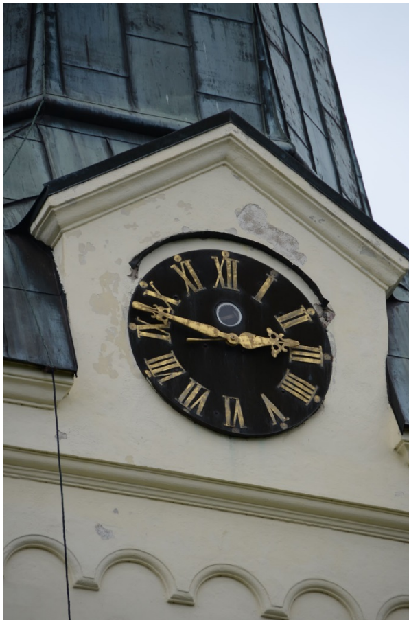
53-54. Droppblecken över urtavlan bidrog till felaktig vattenavrinning. Äldre bleck efter nedtagning.
