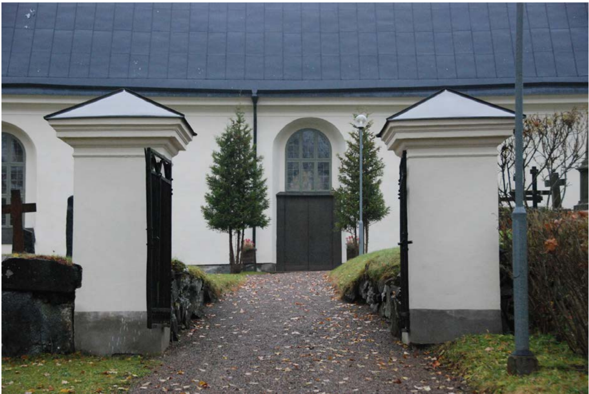
52. Stigporten i söder, mot kyrkan efter renoveringen.
