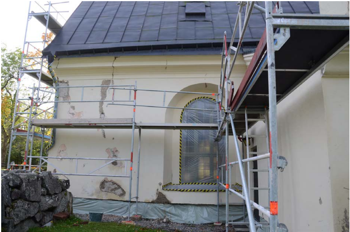
32. Putslagningar på norra fasaden.
