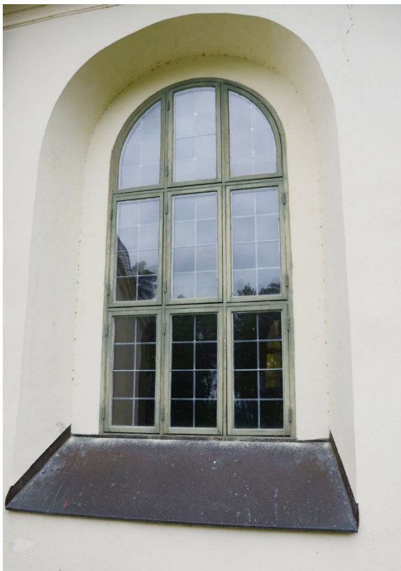
3. Fönster mot söder innan renovering.
