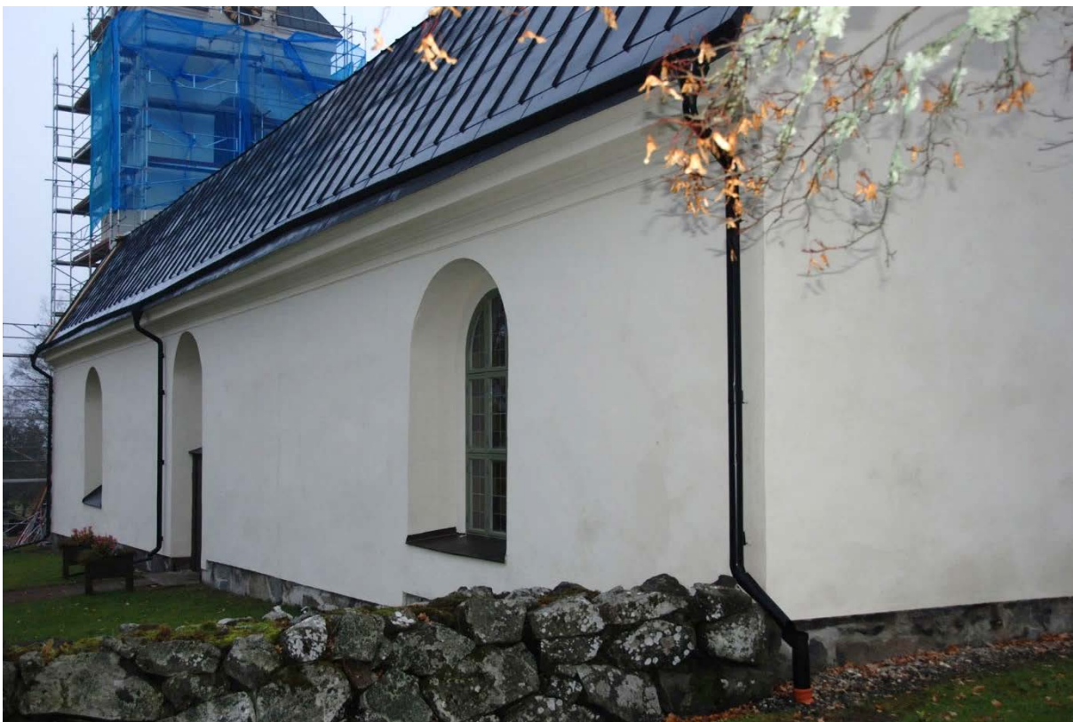
35. Södra fasaden vid slutbesiktningen, omputsad och avfärgad.
