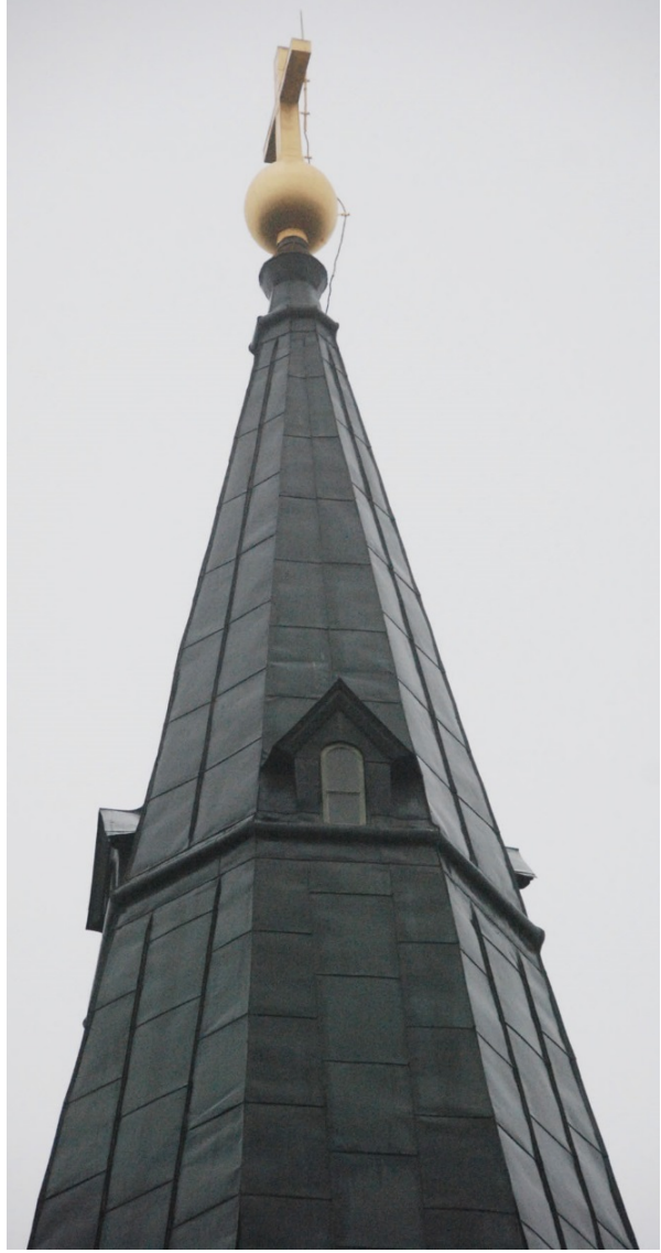
14. De nyttillverkade fönsterna efter renoveringen.
