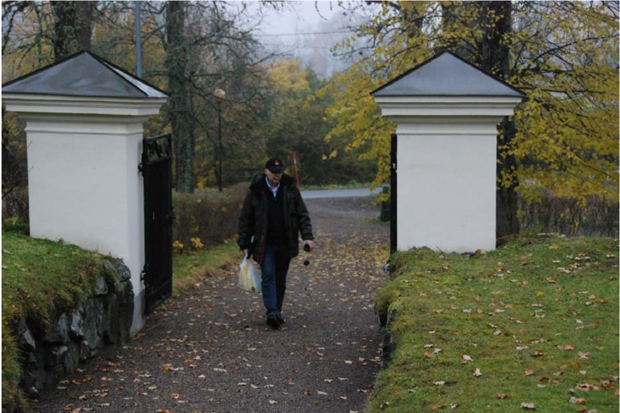
51. Stigporten i söder efter renoveringen.
