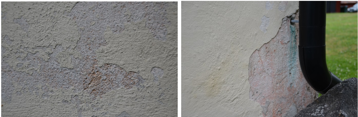
21-22. Fasadputsens hade släppt på flera ställen. Extra tydlig vid utkastarna vid hängrännorna.
