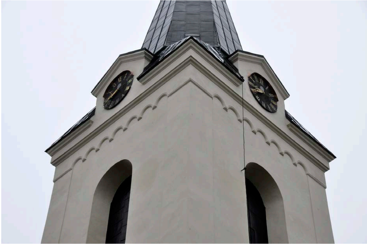
57. Nya bleck monterade över urtavlorna. Dessa är placerade närmare taflan än de tidigare
