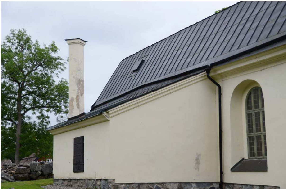
27. Även på sakristians skorsten och fasad lossnade putsen.
