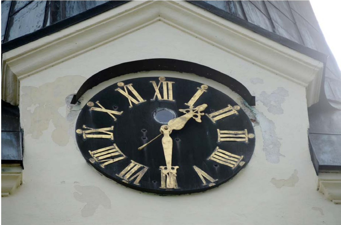
15. Fönsterrutorna vid urtavolorna. Från droppblecken har vatten runnit och påverkat putsen.
