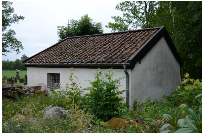
41–43. Bårhuset innan renoveringen. Pust har släppt på den norra fasaden. Häng- och stuprännor läcker.
