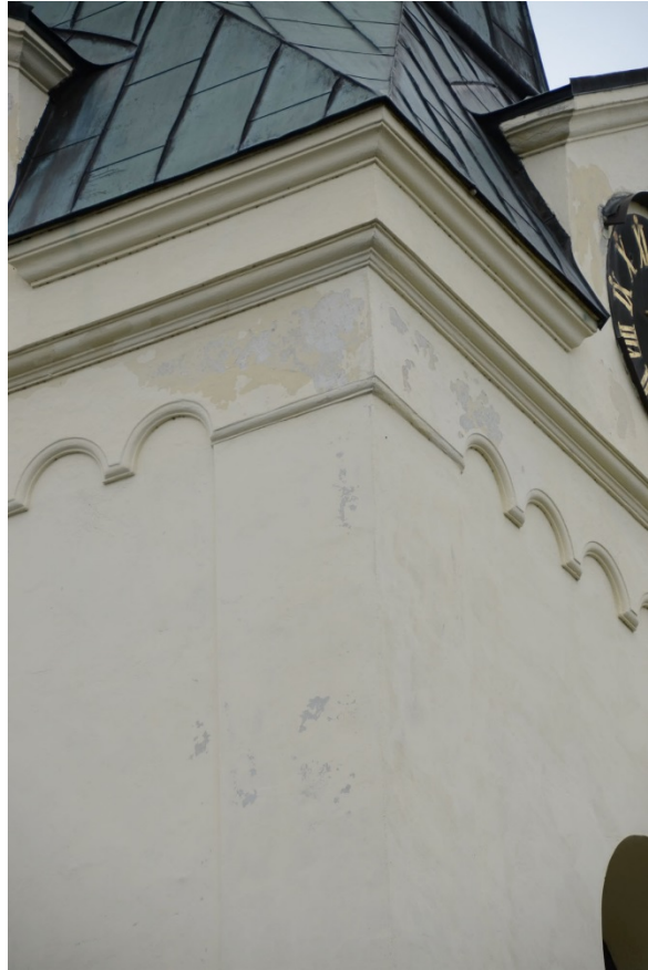
25–26. Vatten har runnit på fasaden på grund av felaktigt riktad plåt. Omfattande putssläpp på tornet.
