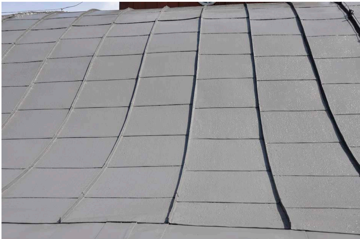
Detalj av takfall mot söder, mellanstrykning.
