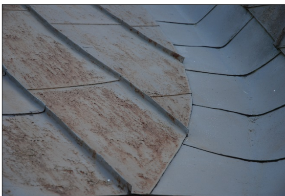
T.v. det äldre plåttaket och t.h. ränndal från 1998. Foto från VLM:s besiktning 2009.
