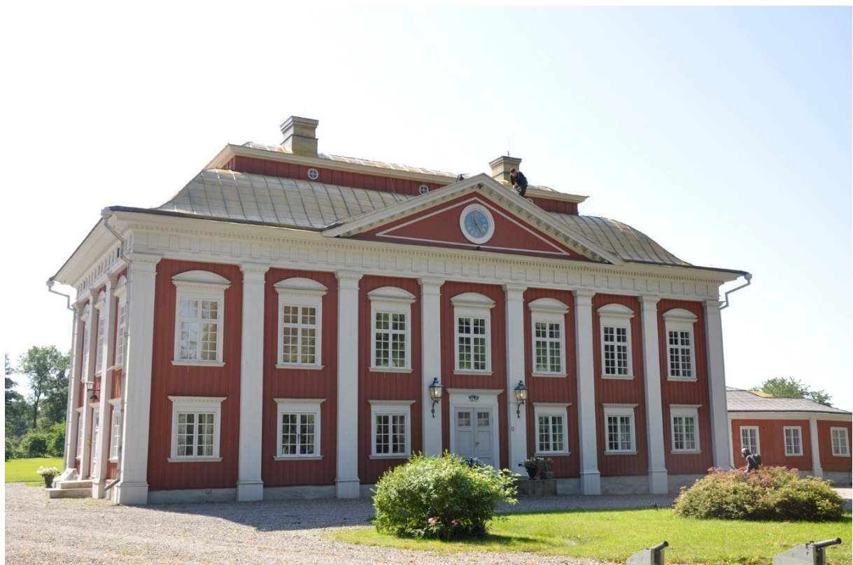
Säteriet mot norr, där målning pågår.
