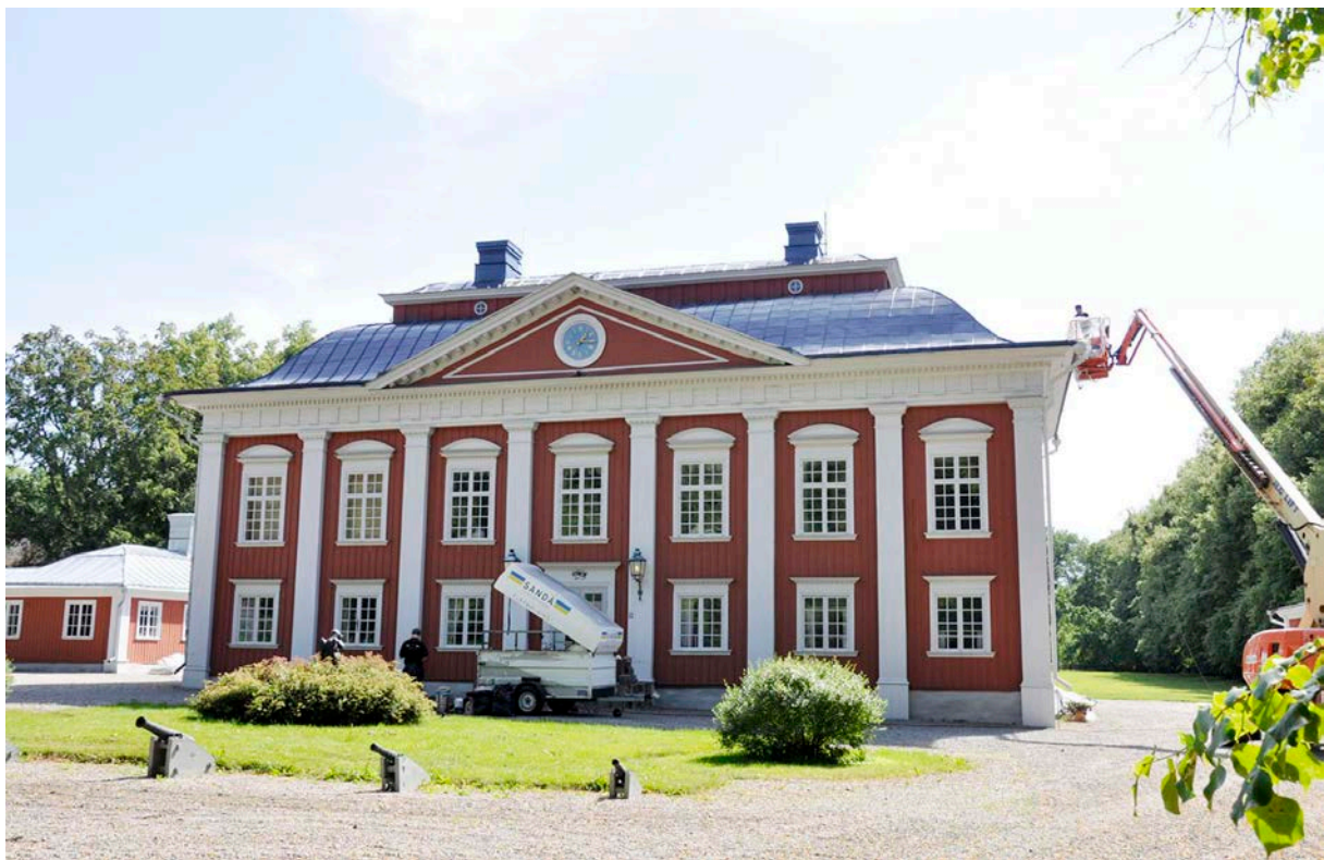
Målning av norra takfallet.
