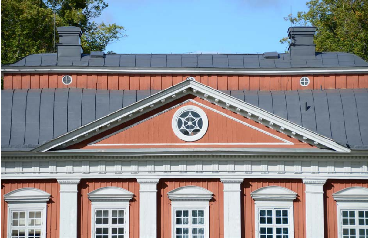
Södra takfallet efter slutstrykning.
