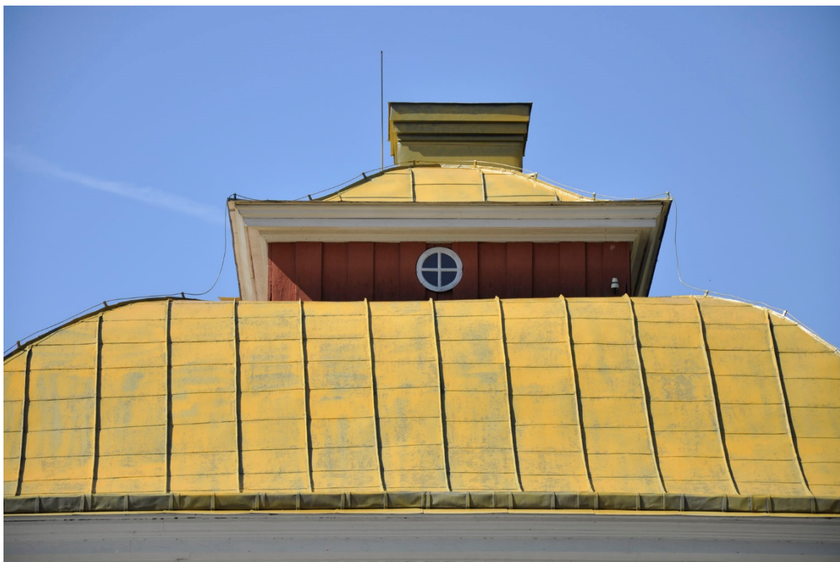
Östra takfallet, grundmålat.
