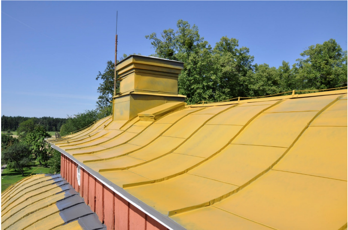
Grundmålning av italianen. Grå partier vid panelen är mellanstrykningsfärg målad för hand.
