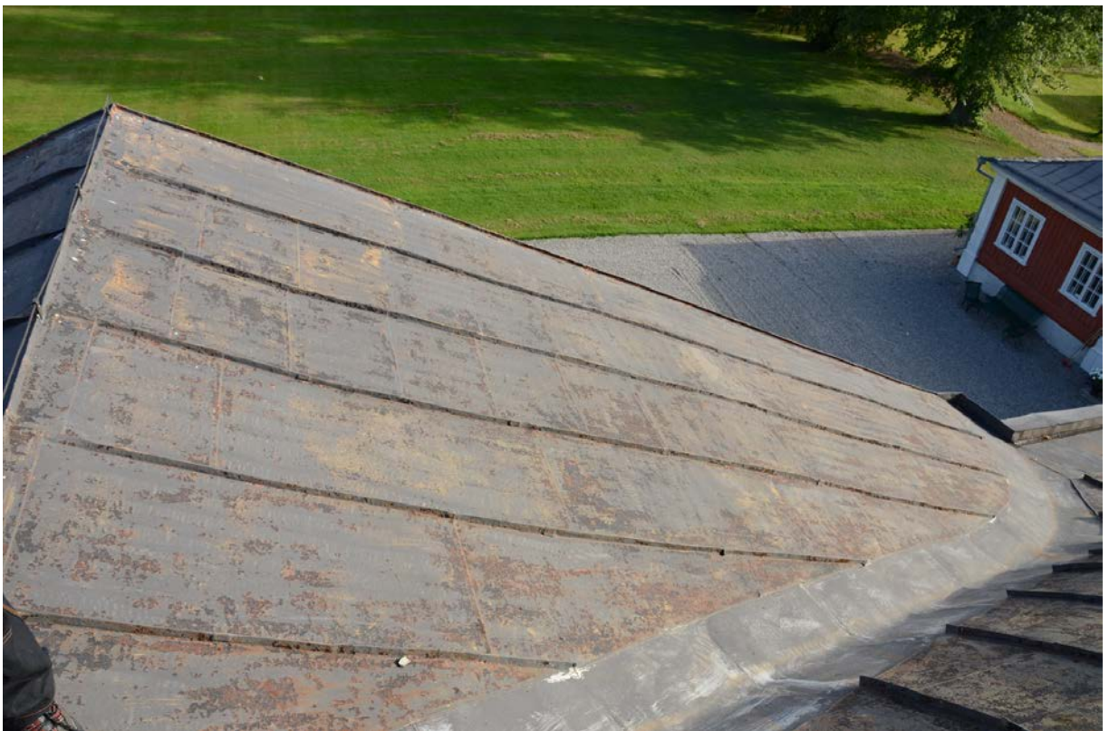
Det södra takfallet, över tympanonfältet. Efter blästring.
