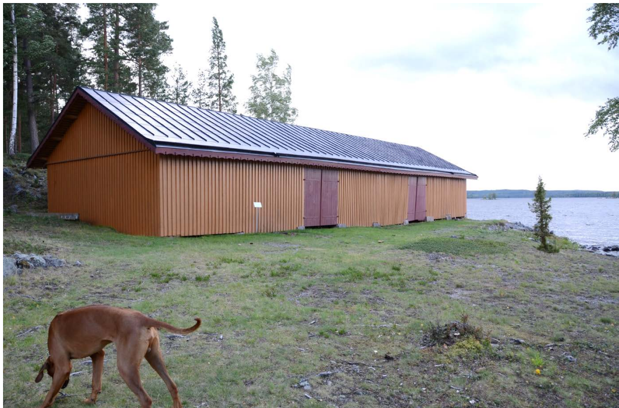
81. Vedboden med färdigmålat tak.
