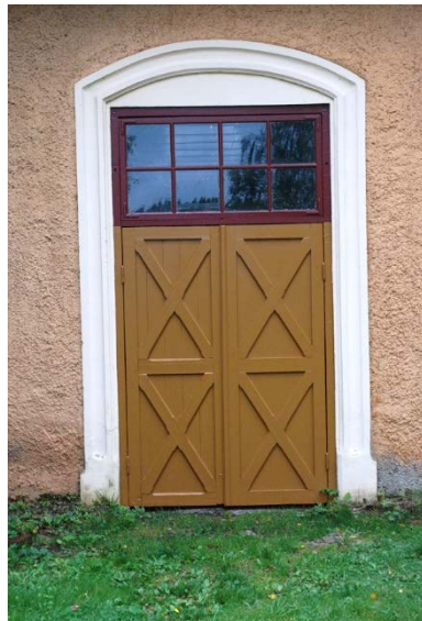
19-27. Fönster och dörrar på fabriksbyggnaden efter renoveringen. Fönsterspröjs har lagats och kittats om och därefter målats.
