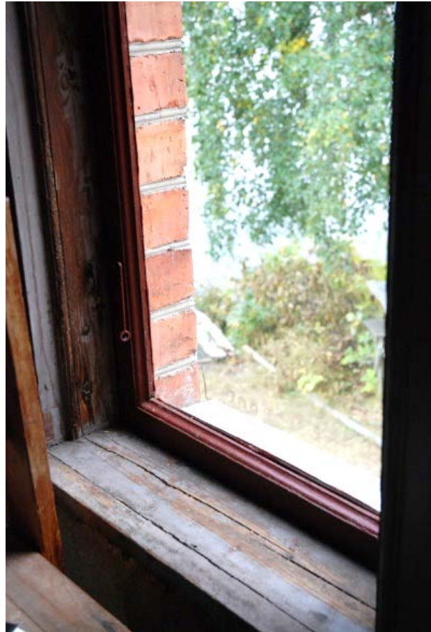
50. Bryggstugans fönsterbåge färdigrenoverad.
