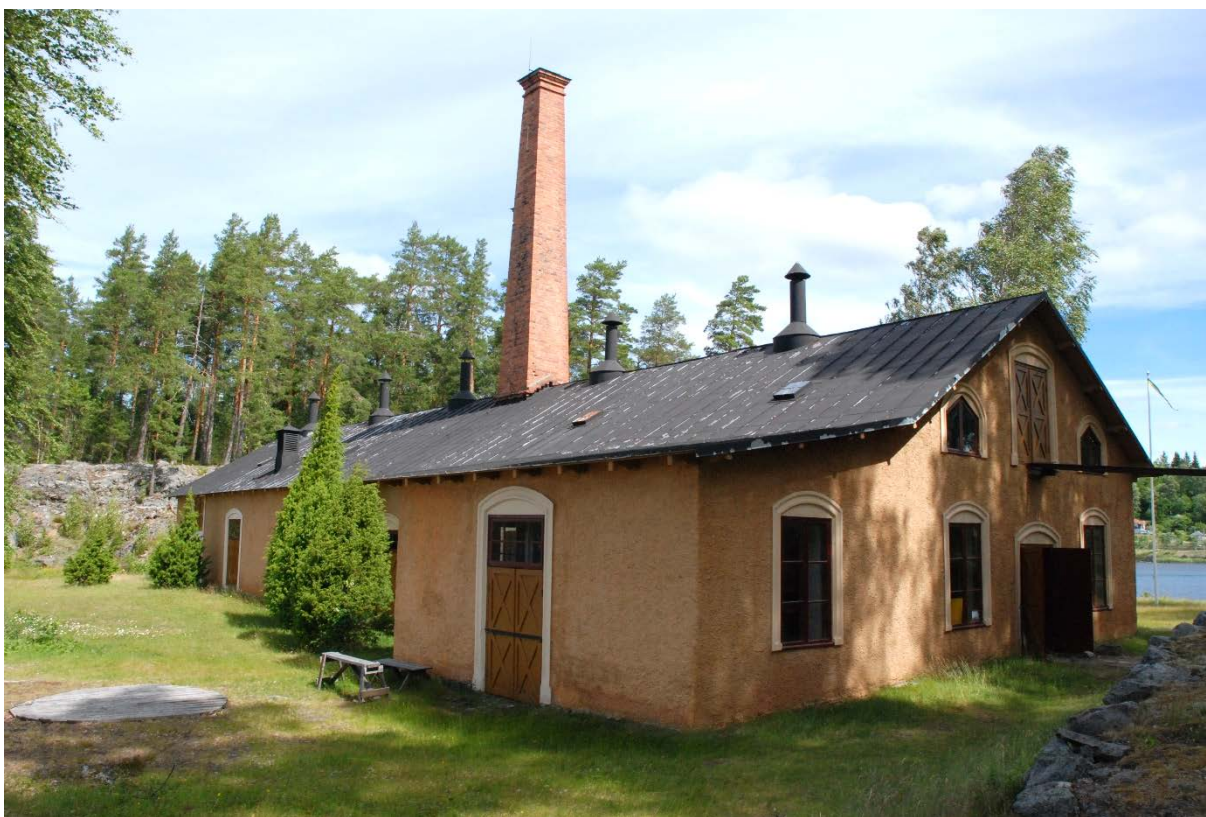
59. Fabriksbyggnadens tak mot väster innan reoveringen. Färger på taken flagnar kraftigt.
