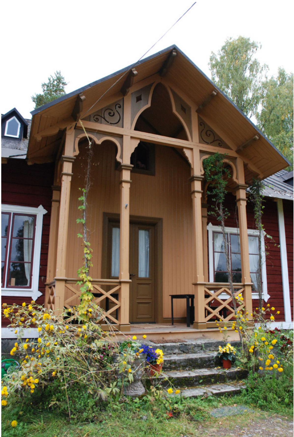
43. Verandan efter reoveringen.
