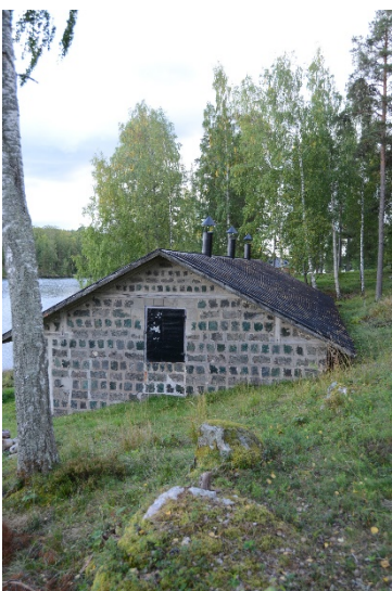
96–101. Tak, huvar och luckor efter renoveringsåtgärderna. Det översta färgskiktet på taket ströks med pensel.
