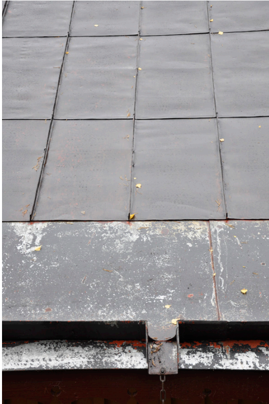
77-78. Taket skrapades och rengjordes med vatten. Därefter ströks falsarna med blymönja.
