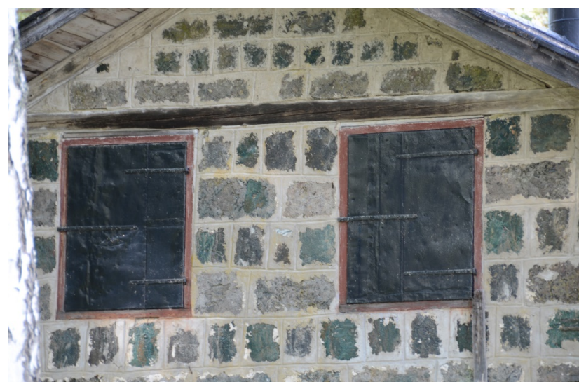
96–101. Tak, huvar och luckor efter renoveringsåtgärderna. Det översta färgskiktet på taket ströks med pensel.
