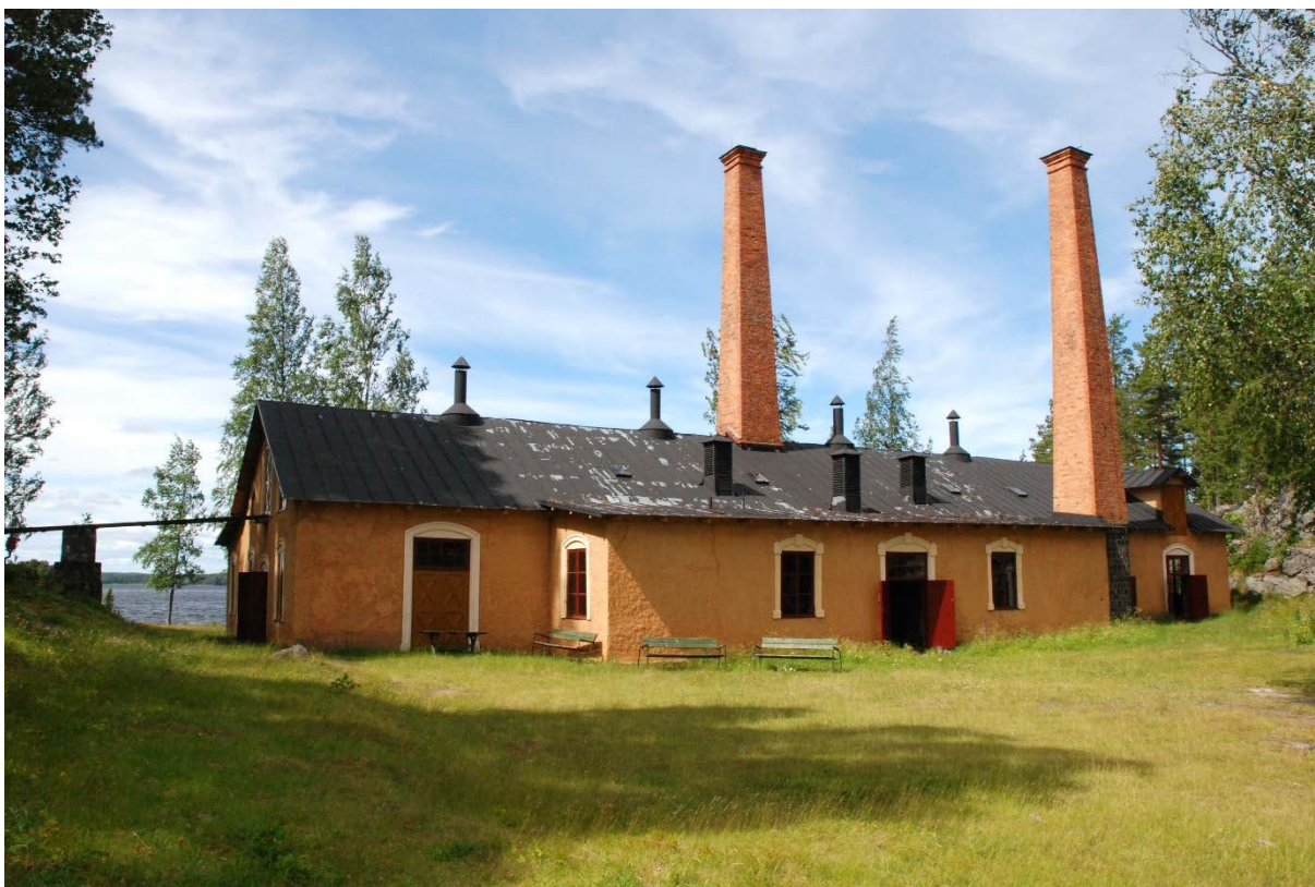
58. Fabriksbyggnadens tak mot öster innan reoveringen. Färger på taken flagnar kraftigt.
