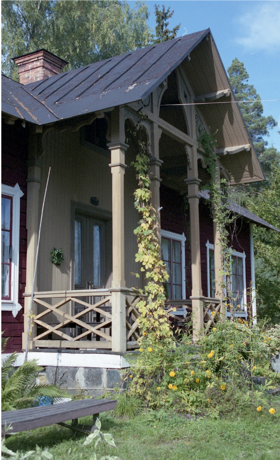
38. Bostadshusets veranda innan renoveringsåtgärderna.
