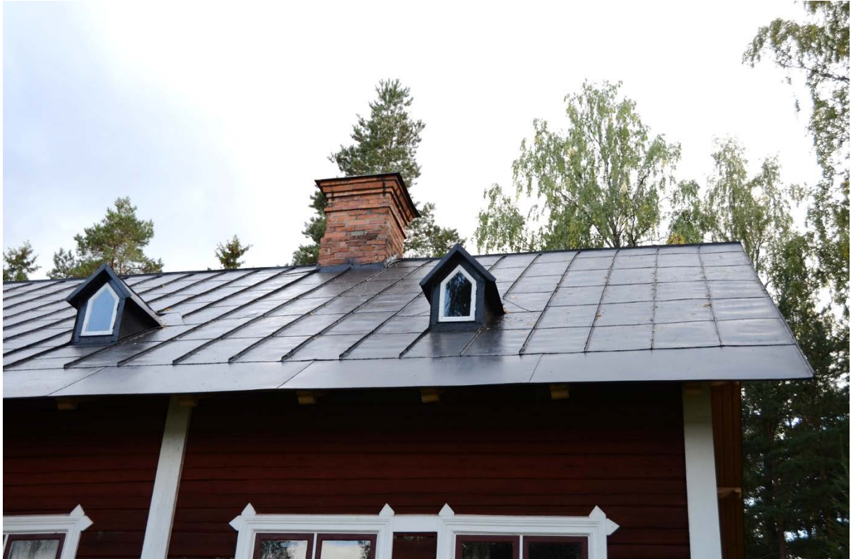
112. Bostadshuset mot väster, efter målningsåtgärderna.
