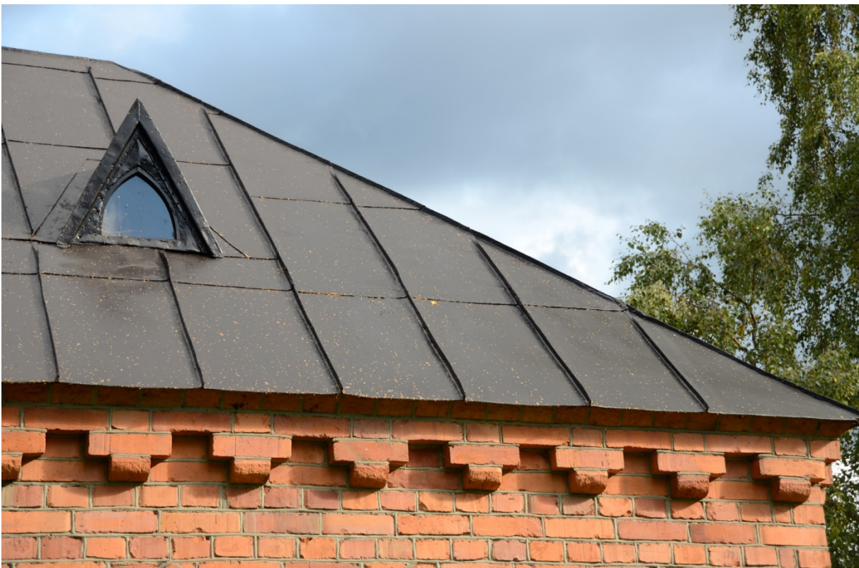
117. Bryggstugan mot söder efter målningsåtgärderna.
