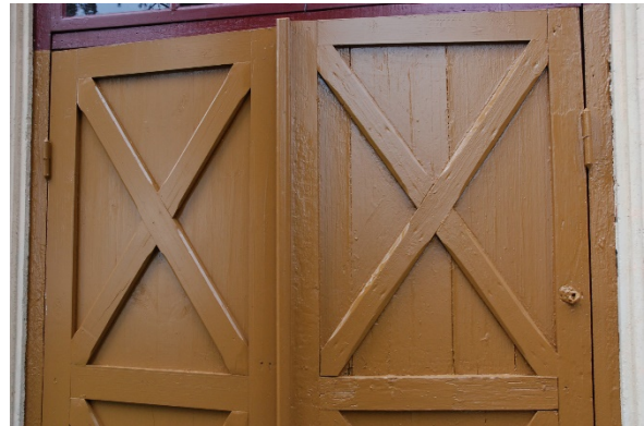
15–16. Dörrblad före och efter renovering. Delar fick bytas ut då det var kraftigt rötskadade.
