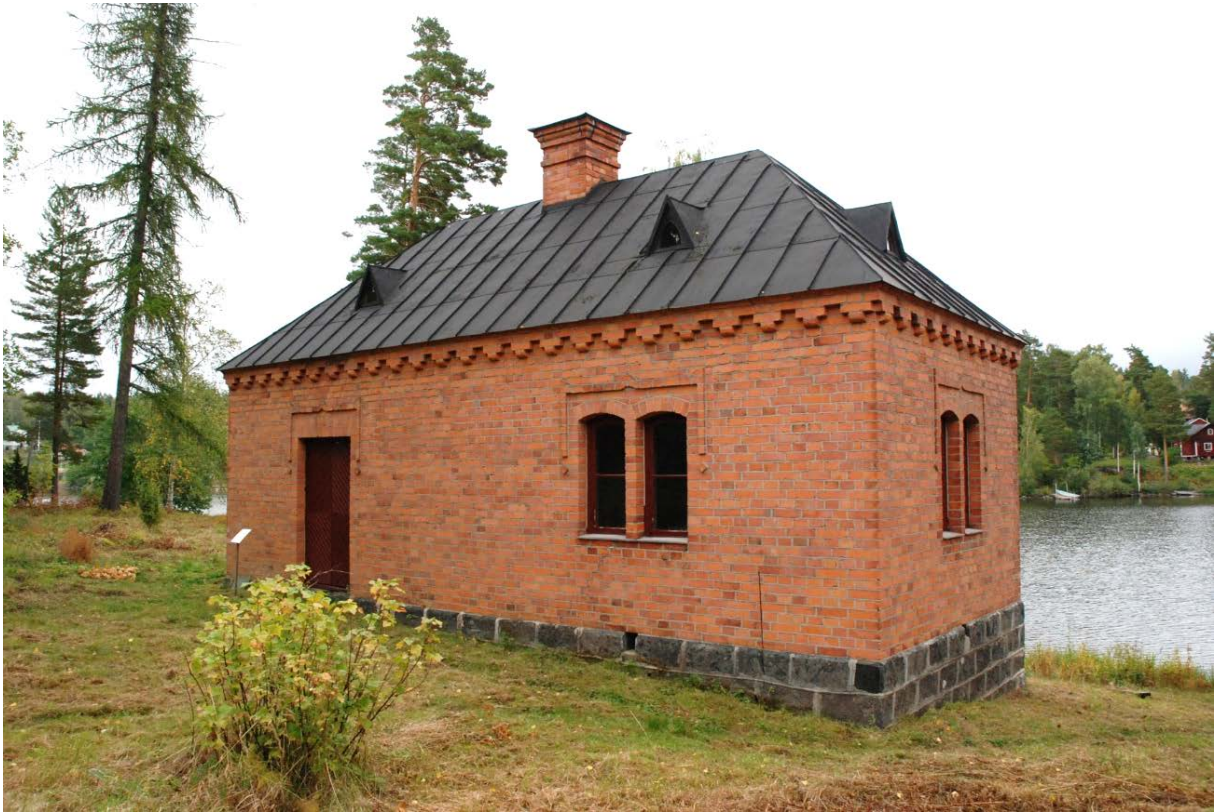
47–48. Bostadshusets fönster efter renoveringen. Bryggstugans fönster och dörrar renoverades och målades.
