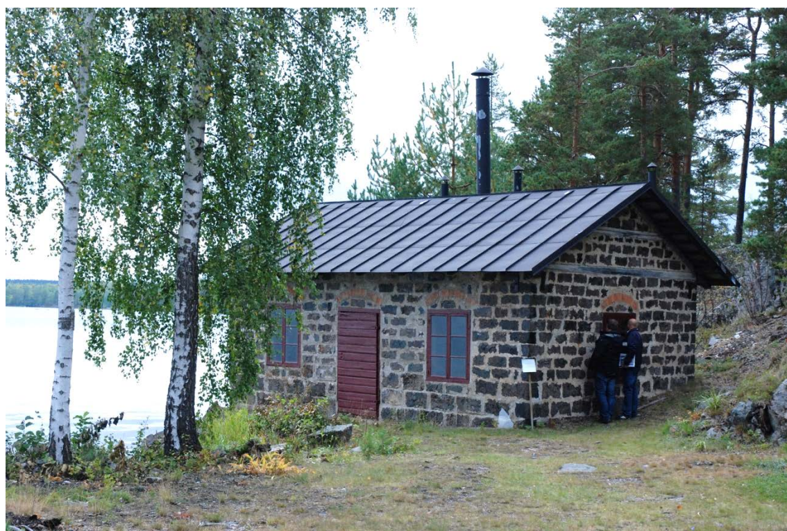
11–13. Klensmedjans dörr innan åtgärder. Dörren skrapades och målades. Fönster skrapades, kittades och målades med linolja.
