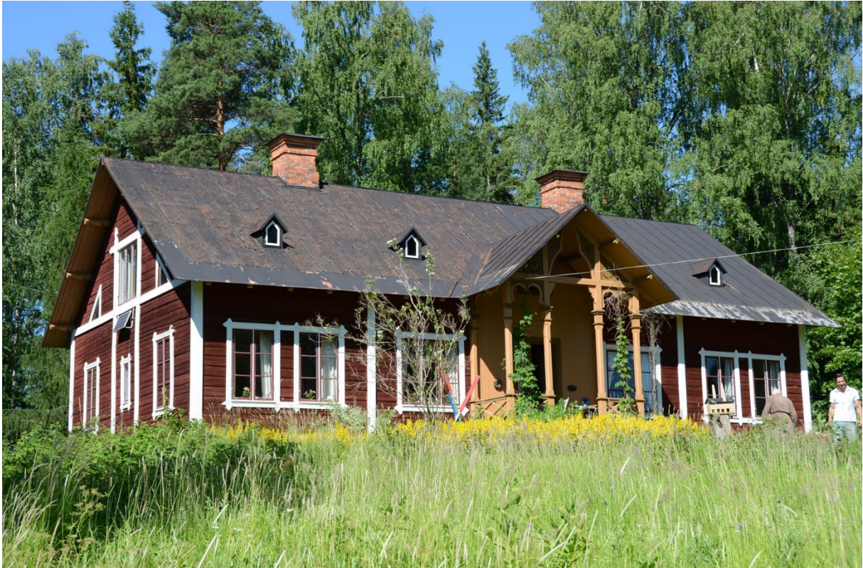
104. Bostadshusets takfall mot öster, före målningsåtgärderna.
