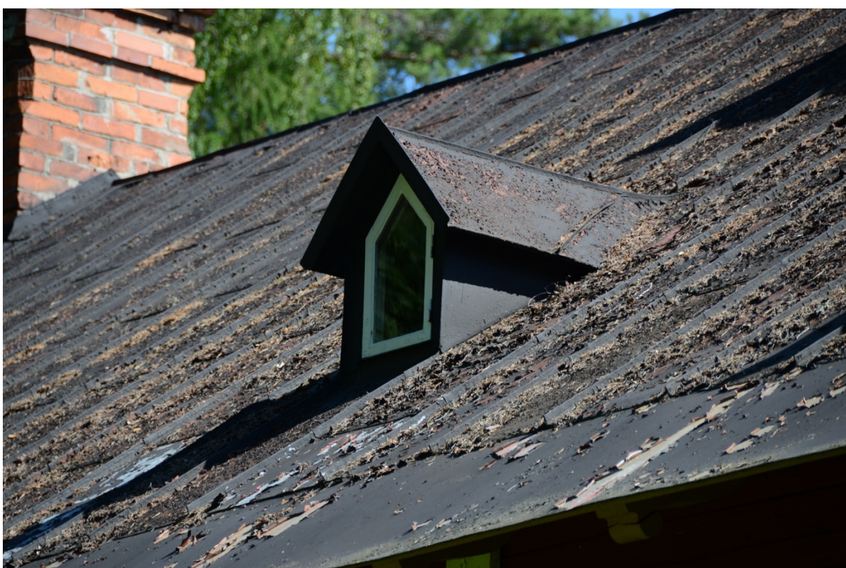
107. Bostadshusets takfall före målningsåtgärderna.
