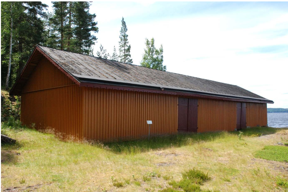
72. Takfärger på vedboden flagnade kraftig. En stor mängd barr täckte taket.
