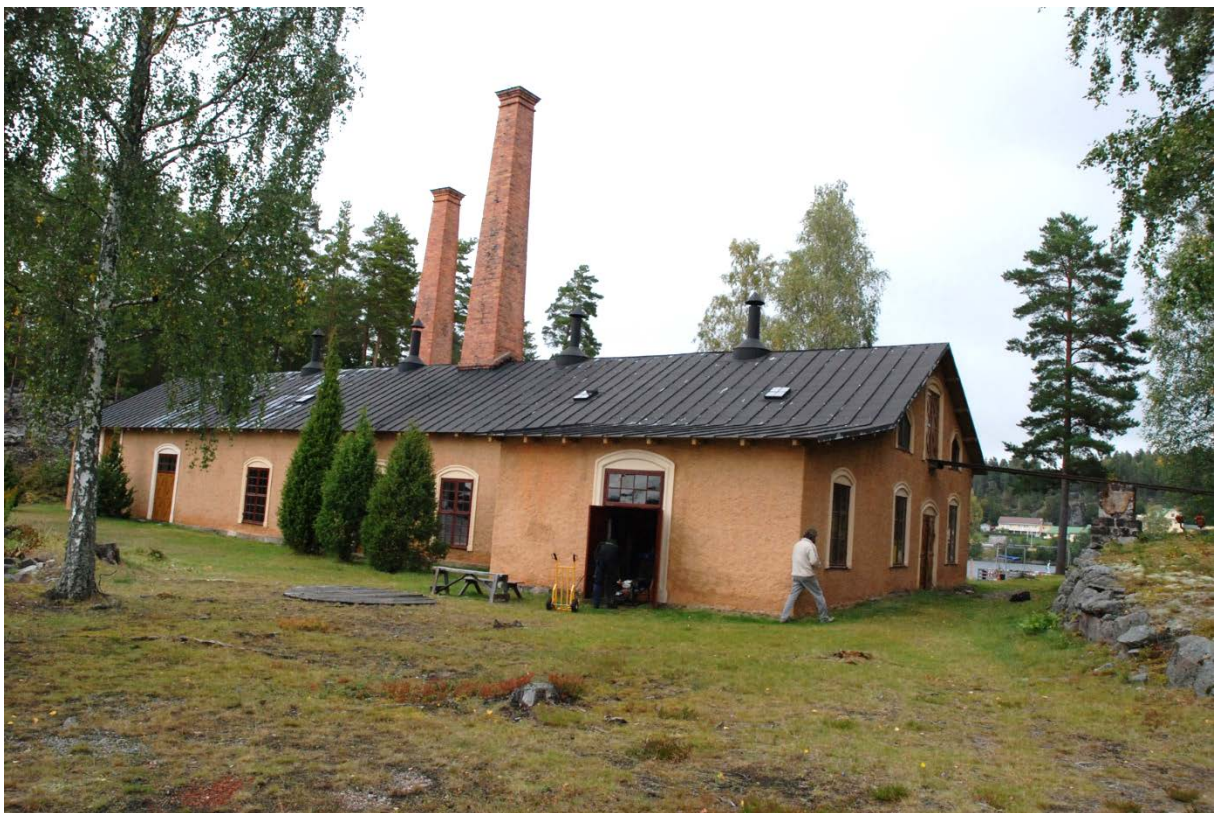
29. Fabriksbyggnaden mot väster.
