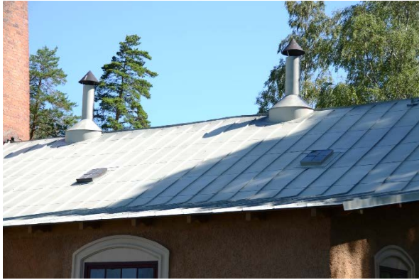
66-67. Taket med grundfärg.
