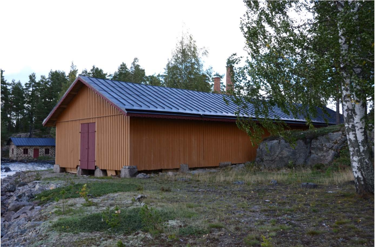
82. Vedboden med färdigmålat tak
