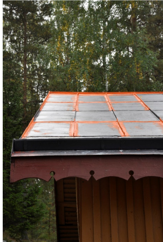
77-78. Taket skrapades och rengjordes med vatten. Därefter ströks falsarna med blymönja.
