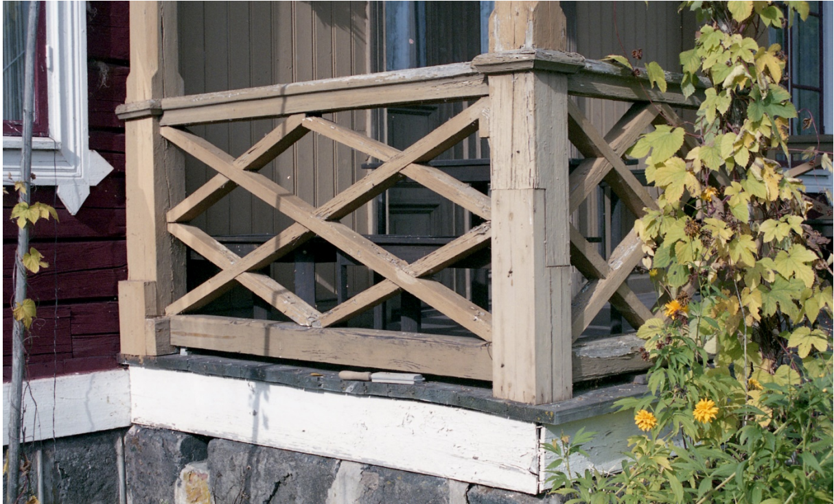
39. Syllstockar och stolpar var kraftigt rötskadade och fick bytas ut.
