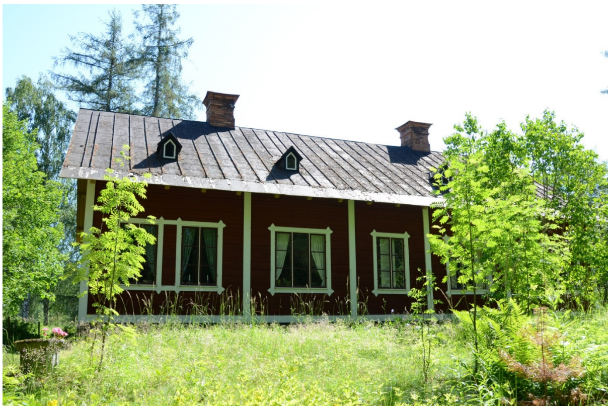
108. Bostadshusets takfall mot väster före målningsåtgärderna.
