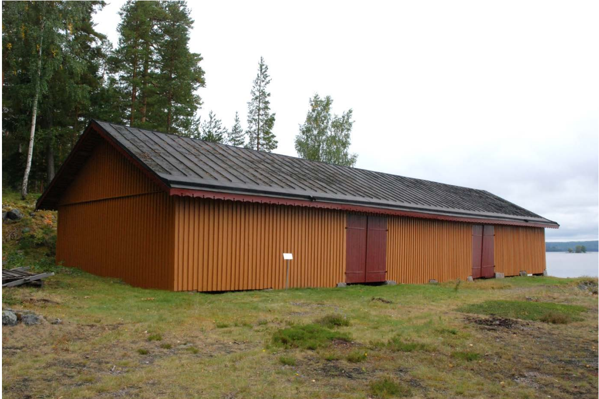
36. Vedbodens fasad mot norr efter renoweringen av fasad, dörrar och vindskivor.
