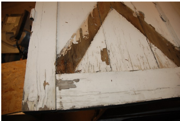
15–16. Dörrblad före och efter renovering. Delar fick bytas ut då det var kraftigt rötskadade.
