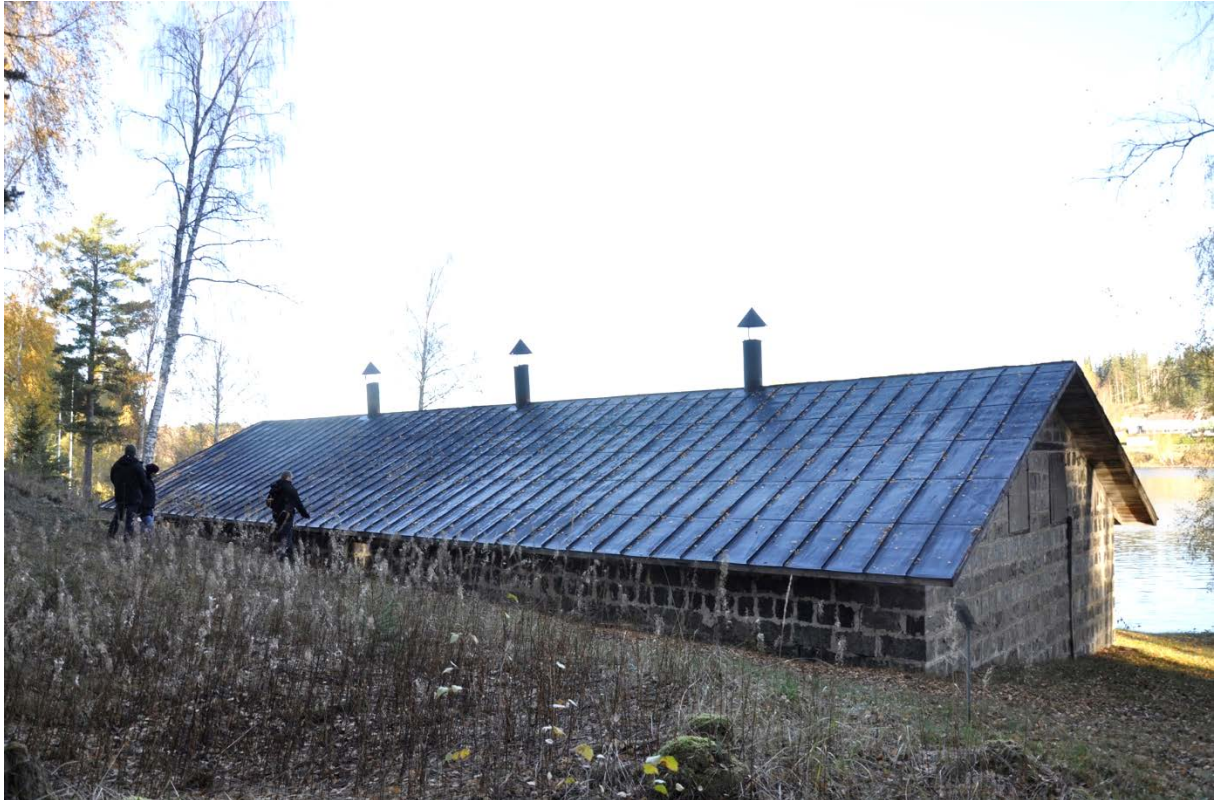
102. Takfallet mot väster efter målningsåtgärderna.
