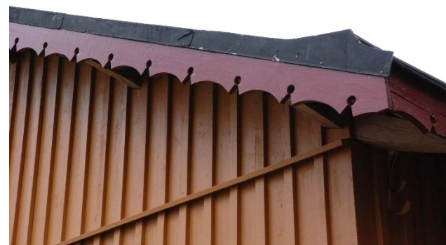
30–35. Delar av vedbodens panel och delar av dörrarna var uttjänt och byttes. De dekorativa vindskiorna nytillverkades efter den äldre modellen. Allt och målades därefter med linoljefärg.
