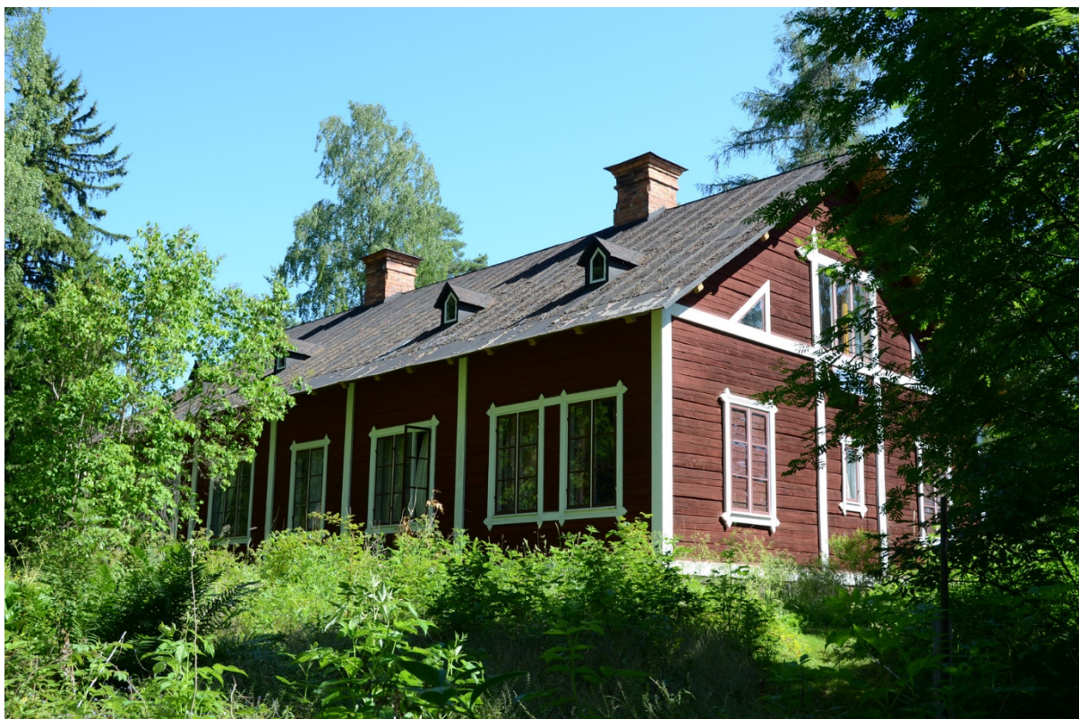
106. Bostadshusets takfall mot väster före målningsåtgärderna.
