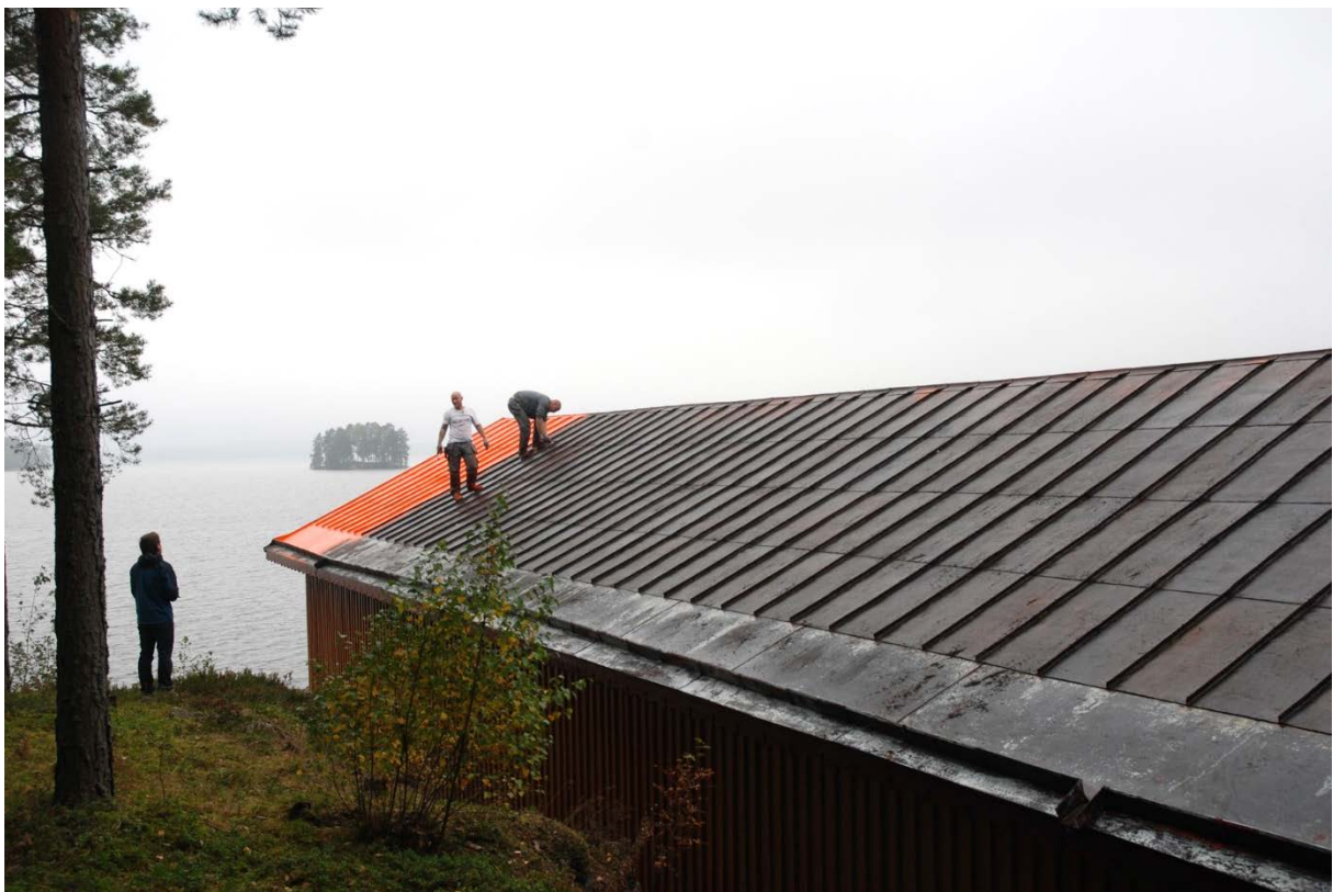
79. Färgen skrapades och borstades bort. Blymönja har målats på hela taket.
