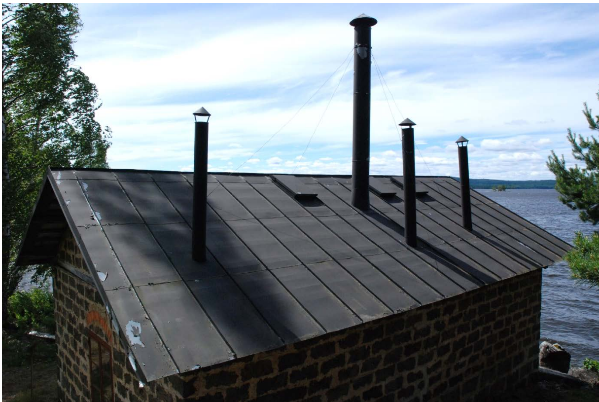
56. Klensmedjans tak innan renovering.
