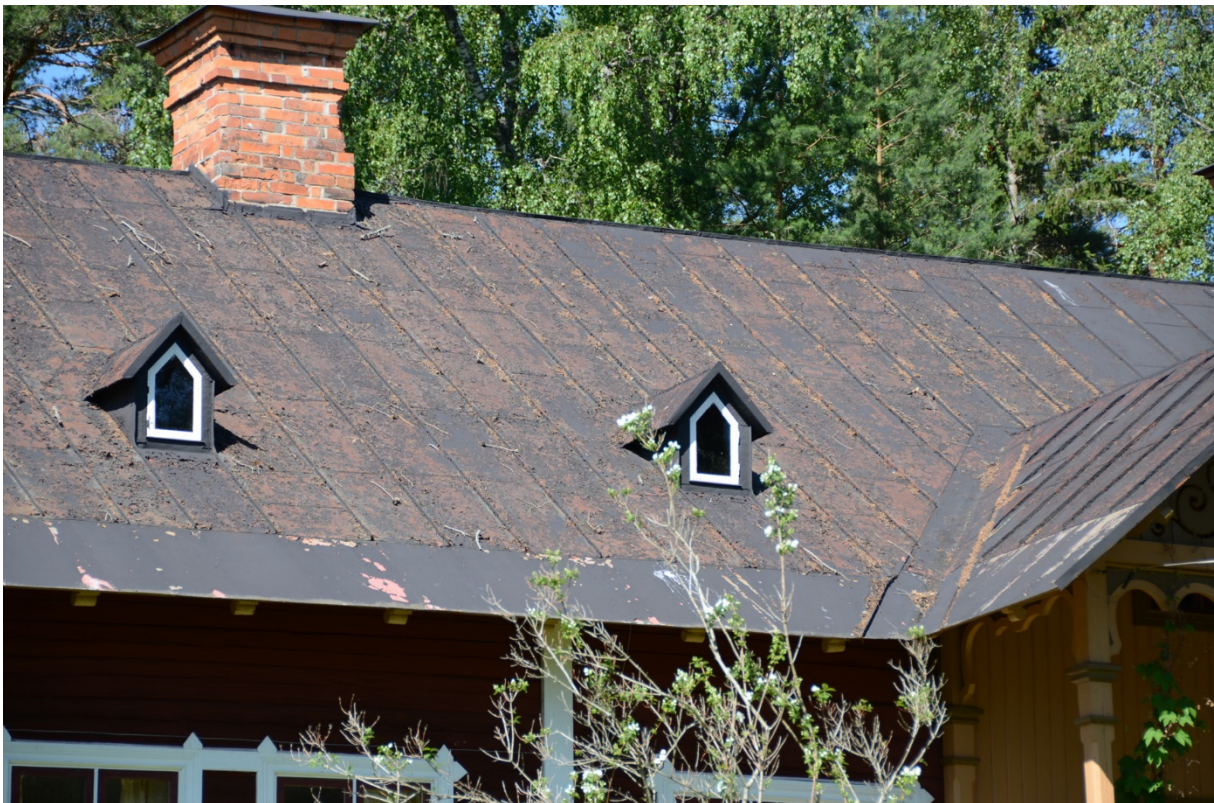
105. Bostadshusets takfall mot öster före målningsåtgärderna. Färgen flagnade kraftigt.
