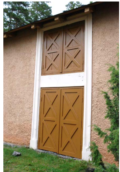
19-27. Fönster och dörrar på fabriksbyggnaden efter renoveringen. Fönsterspröjs har lagats och kittats om och därefter målats.
