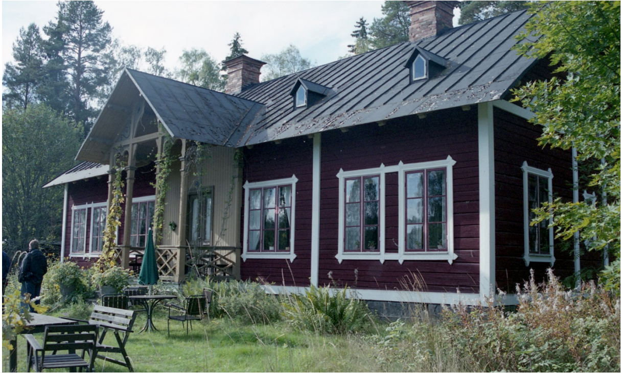
41. Bostadshuset innan renoveringsåtgärder på veranda och fönster.
