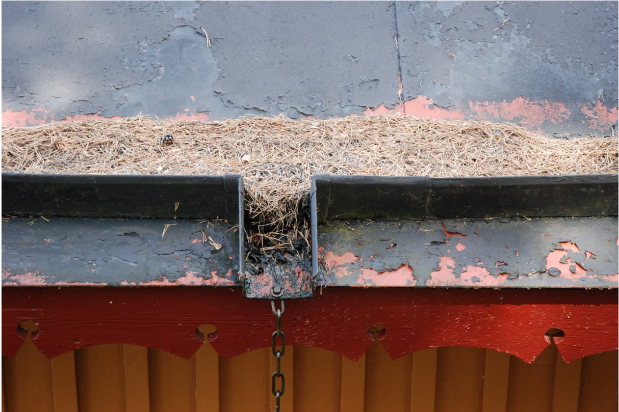
75. Detalj på tak, den äldre blymönjan syns under det övre färgskiktet.
