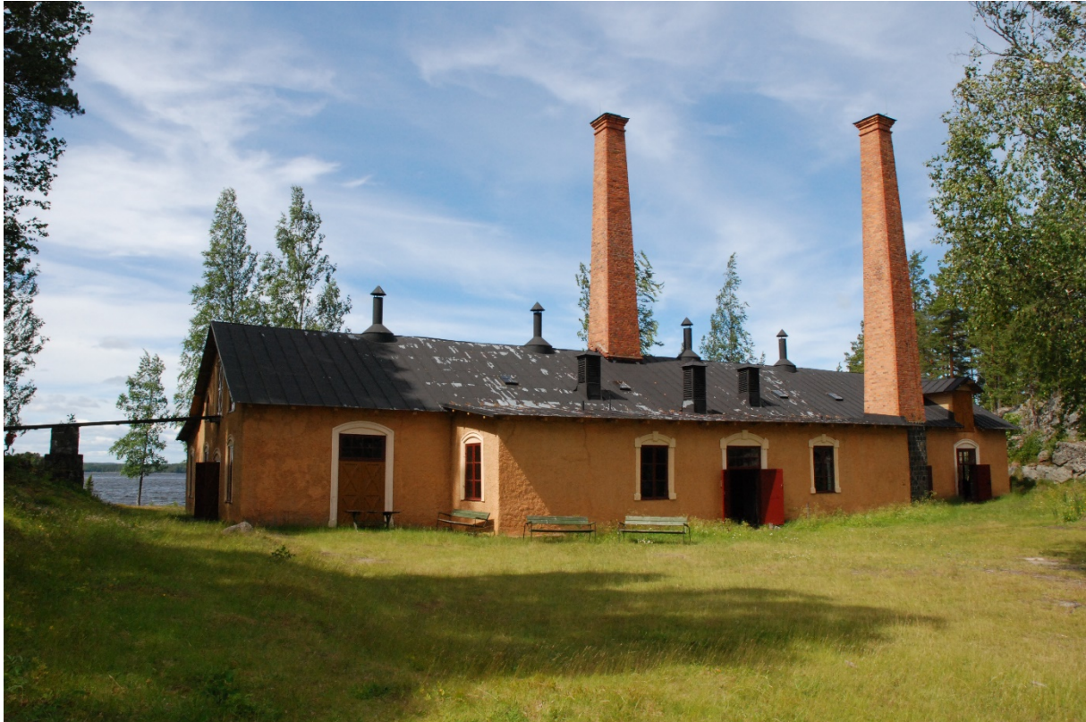
14. Fabriksbyggnadens fönster och dörrar lagades och målades med linolja.
