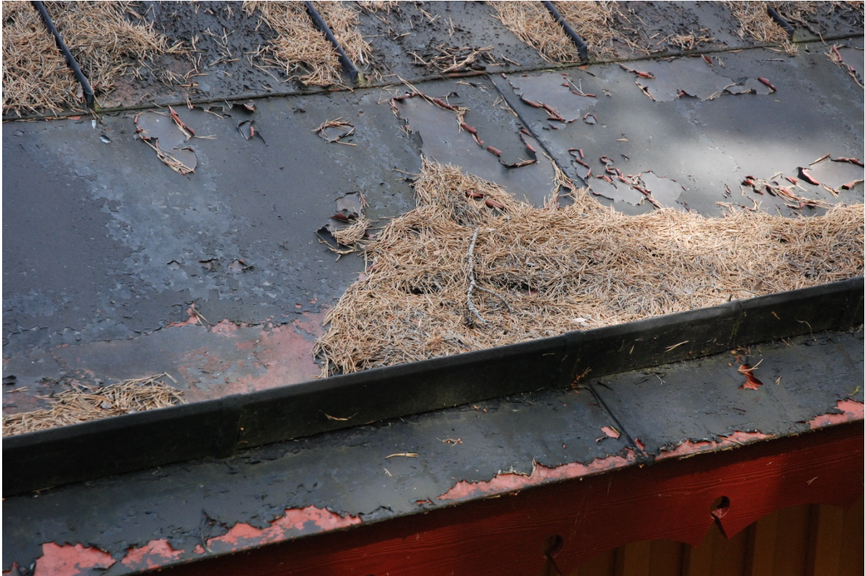
76. Detalj på vedbodens tak, den äldre blymönjan syns under det övre färgskiktet
