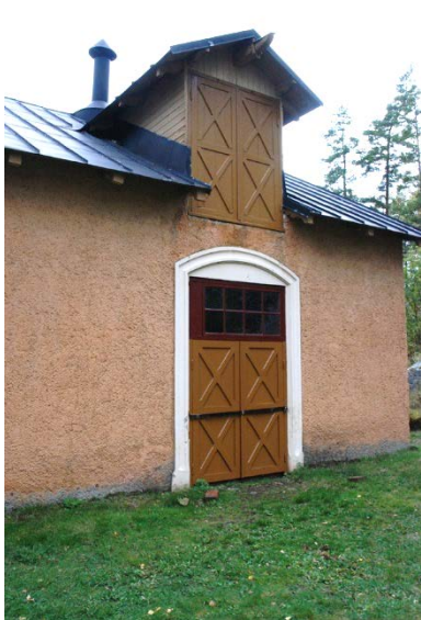
19-27. Fönster och dörrar på fabriksbyggnaden efter renoveringen. Fönsterspröjs har lagats och kittats om och därefter målats.
