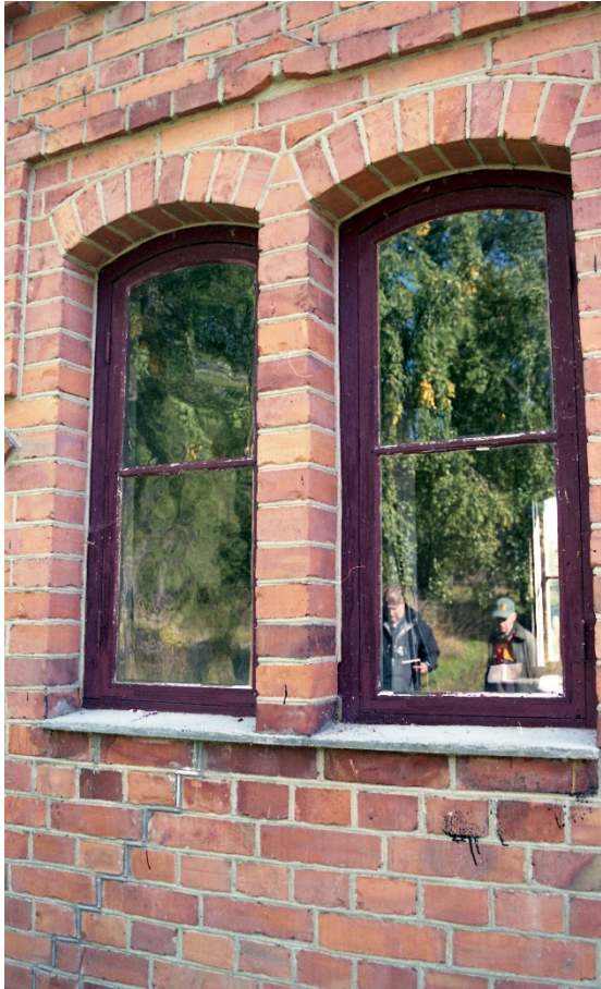
49. Bryggstugans fönster innan renovering.
