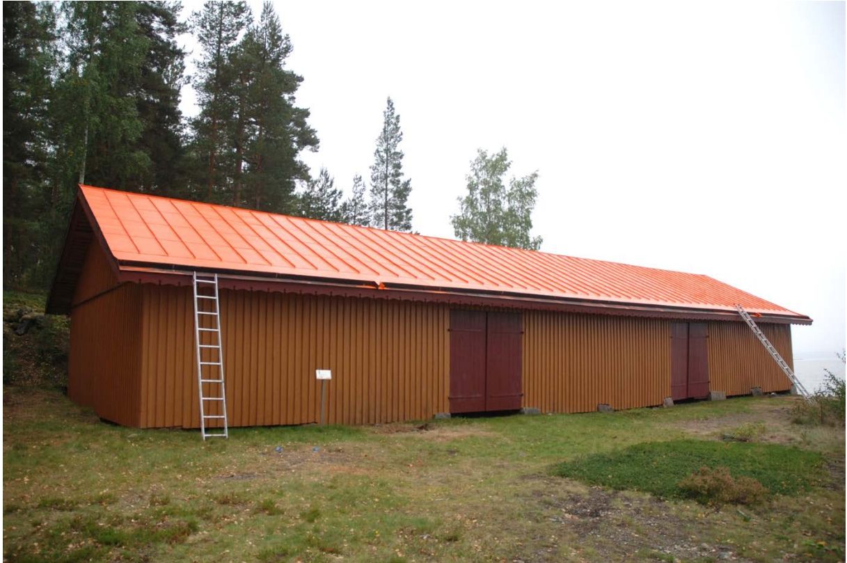
80. Vedboden mot norr, taket är målat med blymönja.
