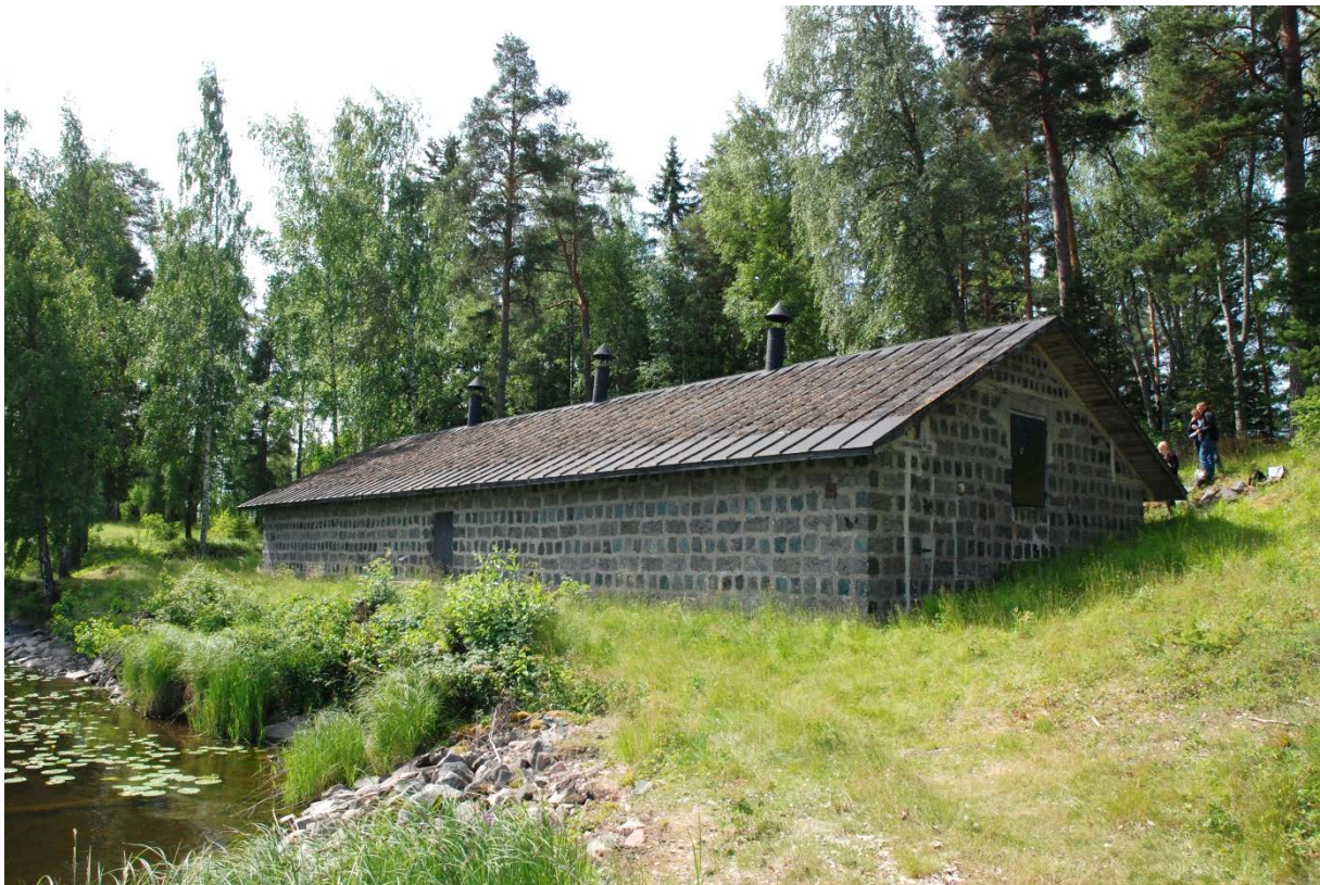
83. Oljekällaren innan renovering av tak, dörrar och luckor.
