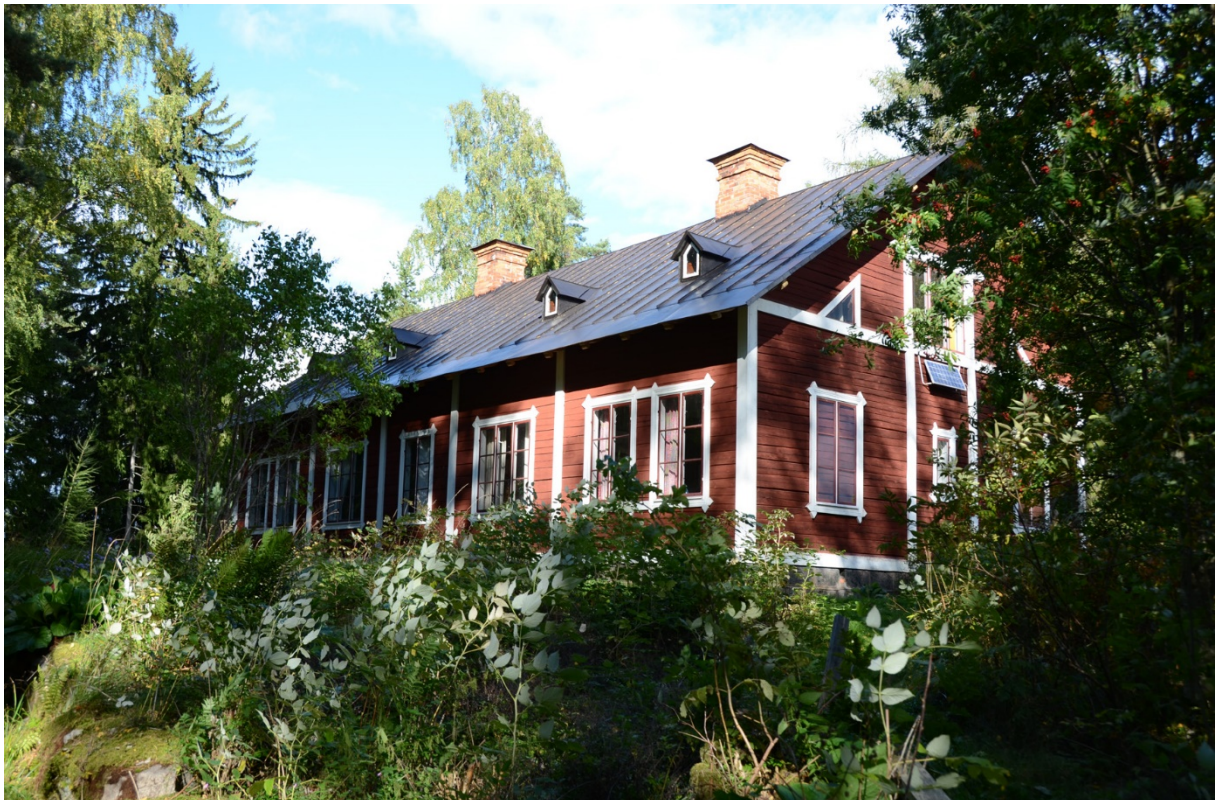
111. Bostadshuset mot väster, efter målningsåtgärderna.
