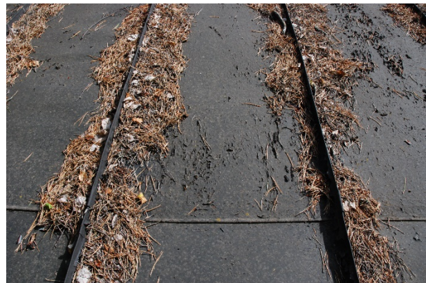
88–90. Takfärgen på oljekällrens tak hade kraftig sprickbildning och på vissa ställen flagnade den.
