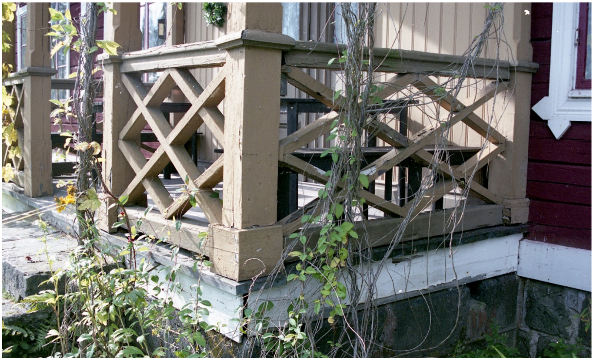
40. Verandans underrede och syllar var i dåligt skick.
