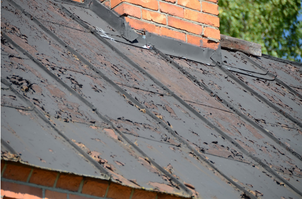
116. Bryggstugans takfall mot öster. Även här flagnade färgen kraftigt.
