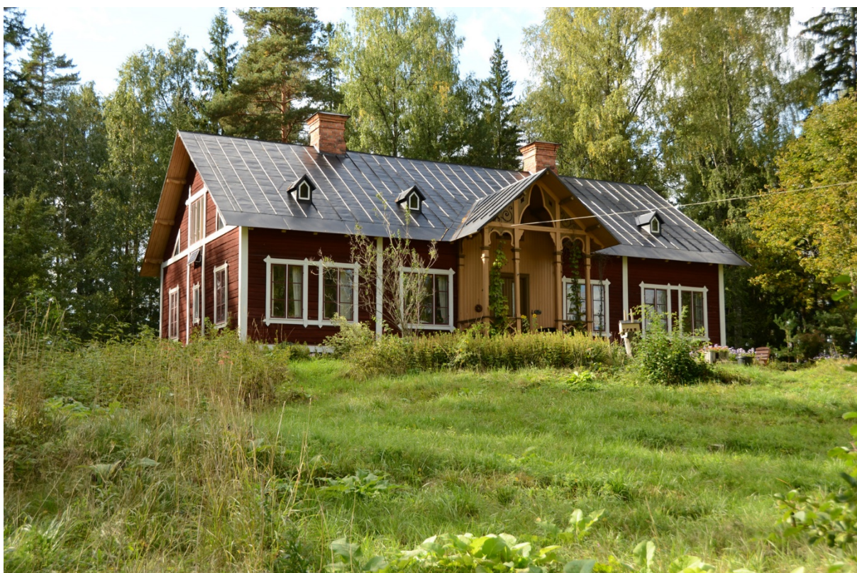
109. Bostadshusets takfall mot öster efter målningsåtgärderna.
