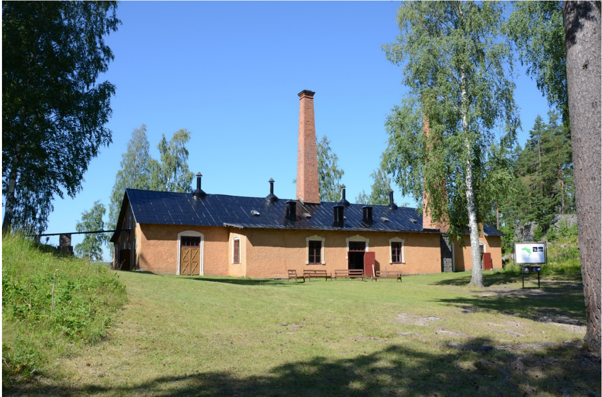
71. Det färdigmålade taket, mot öster.
