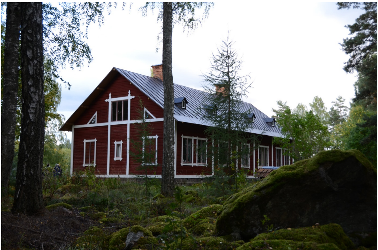
113. Bostadshuset mot väster, efter målningsåtgärderna.
