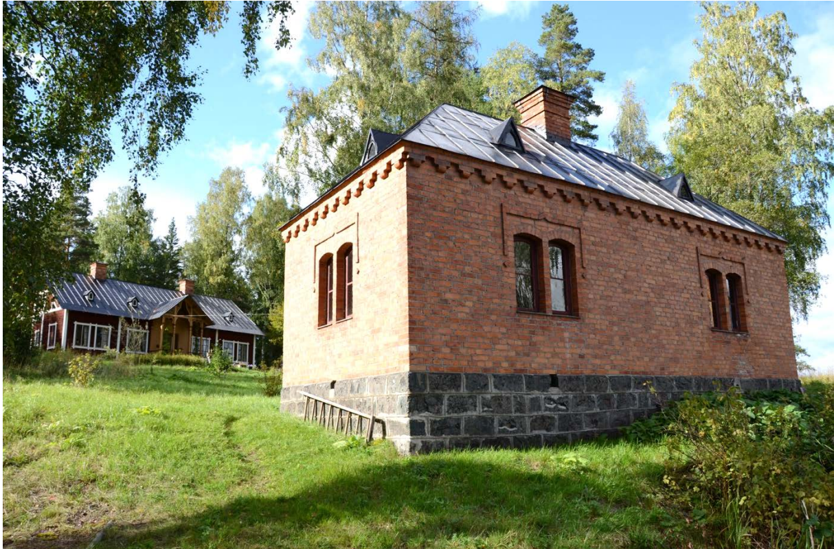
54. Bryggstugans fasad mot öster. I bakgrunden skymtas bostadshuset.
