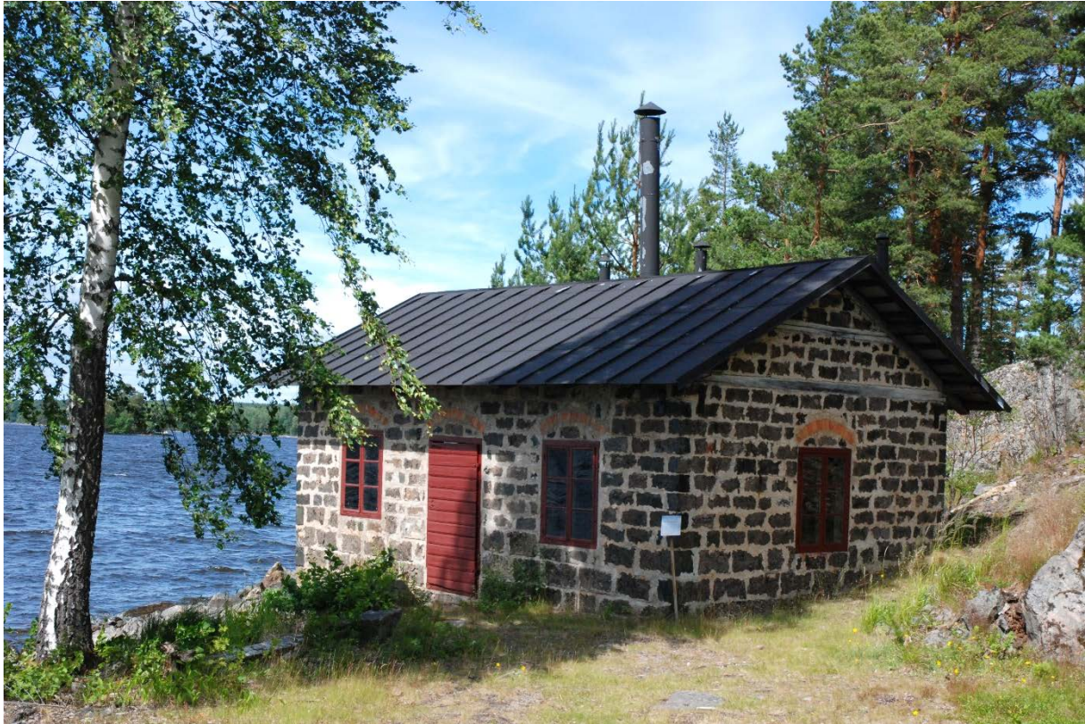
55. Klensmedjans tak innan renovering.
