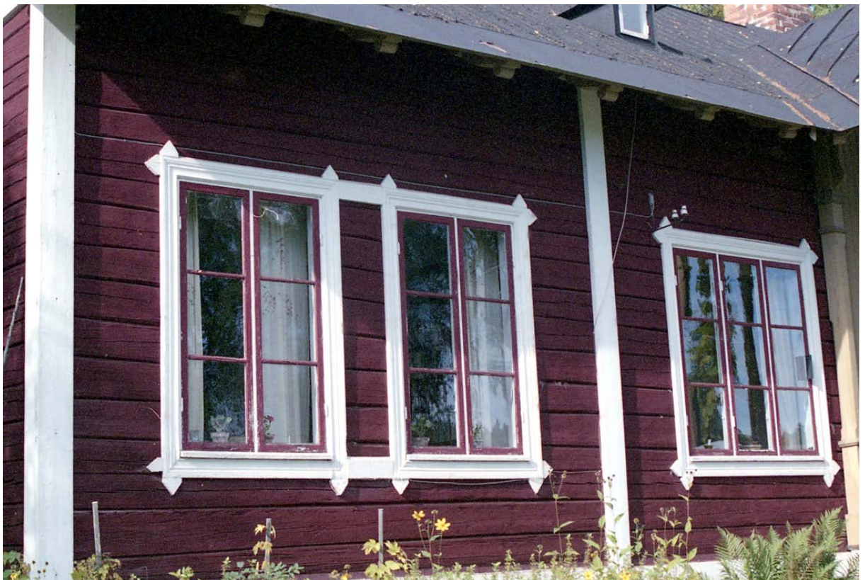
44–46. Detalj på verandan under renoveringen. Bostadshusets fönster under renoveringen där fåglar har pickat bort kitt. Bild nedan innan renovering av fönster.
