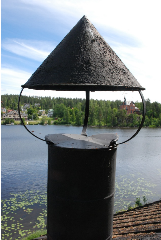
86–87. Huvorna hade kraftiga rostangrepp och delar av plåten var deformerad. Delar byttes ut.
