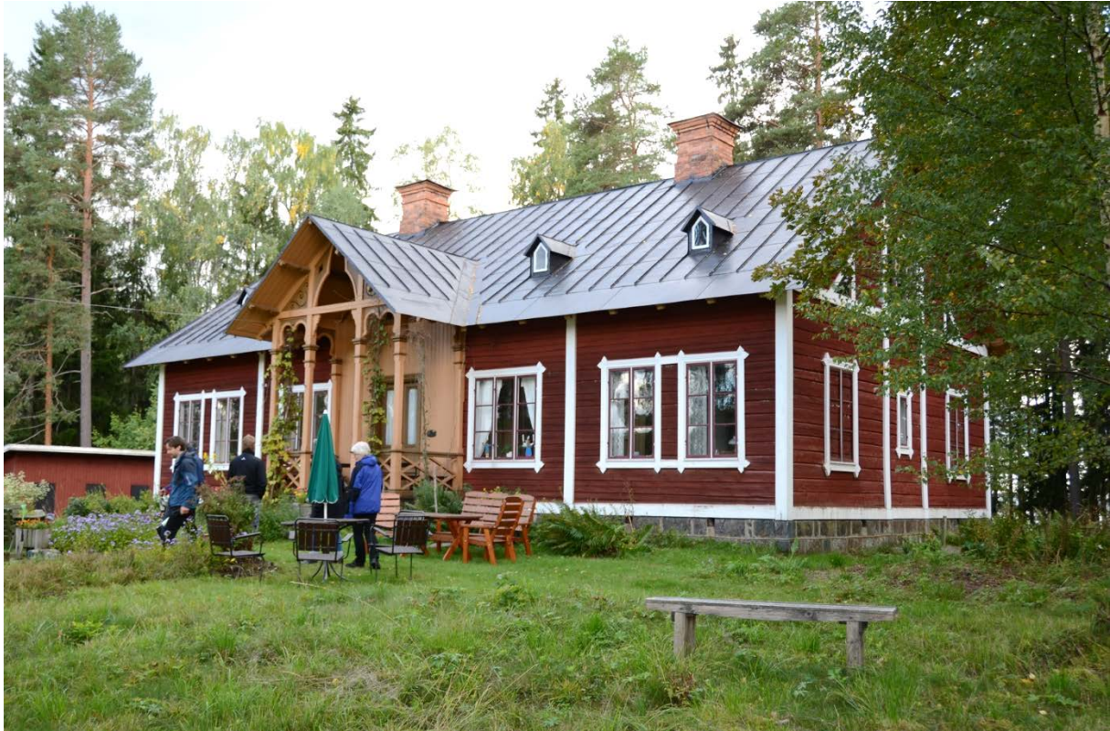
110. Bostadshuset mot öster, efter målningsåtgärderna.
