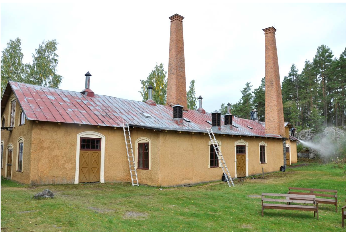
65. Fabriksbyggnadens tak under pågående rengöring.
