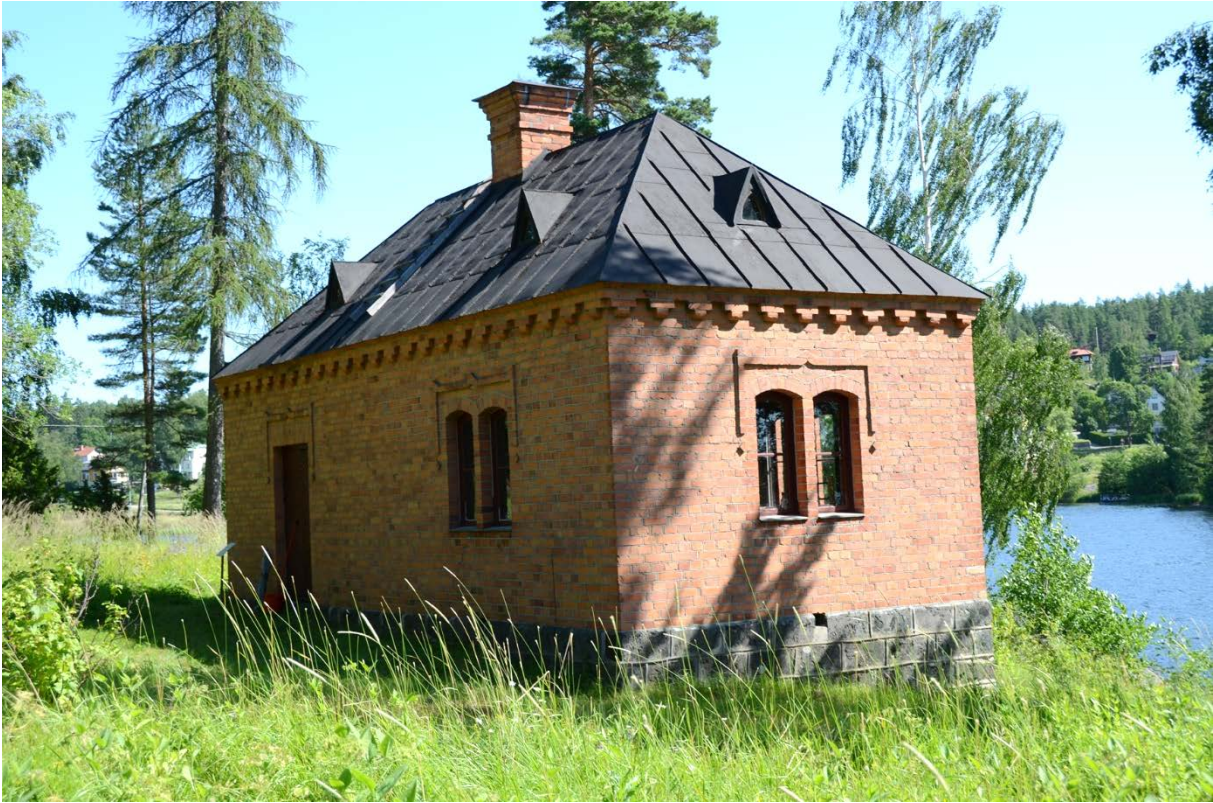
114. Bryggstugan mot söder, innan målningsåtgärderna.
