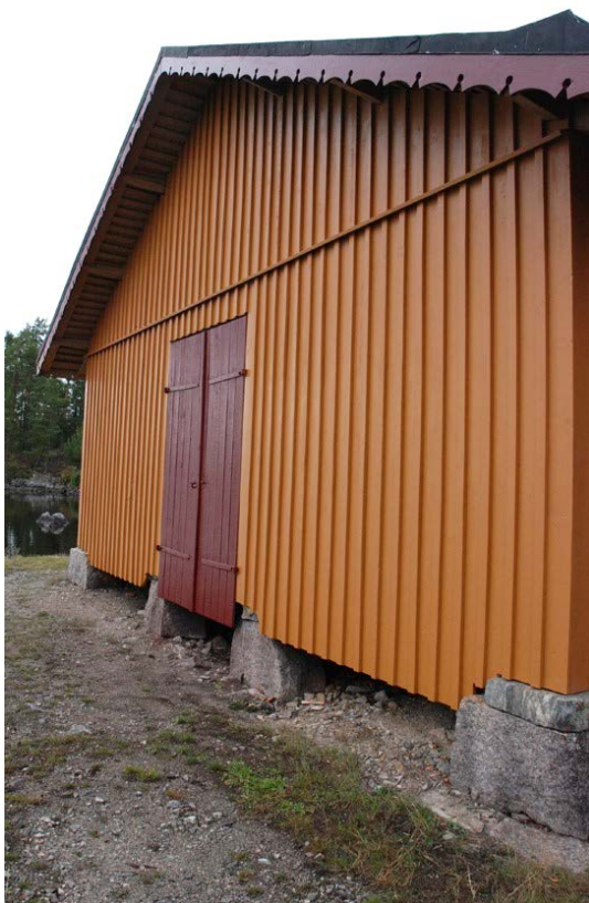
30–35. Delar av vedbodens panel och delar av dörrarna var uttjänt och byttes. De dekorativa vindskiorna nytillverkades efter den äldre modellen. Allt och målades därefter med linoljefärg.
