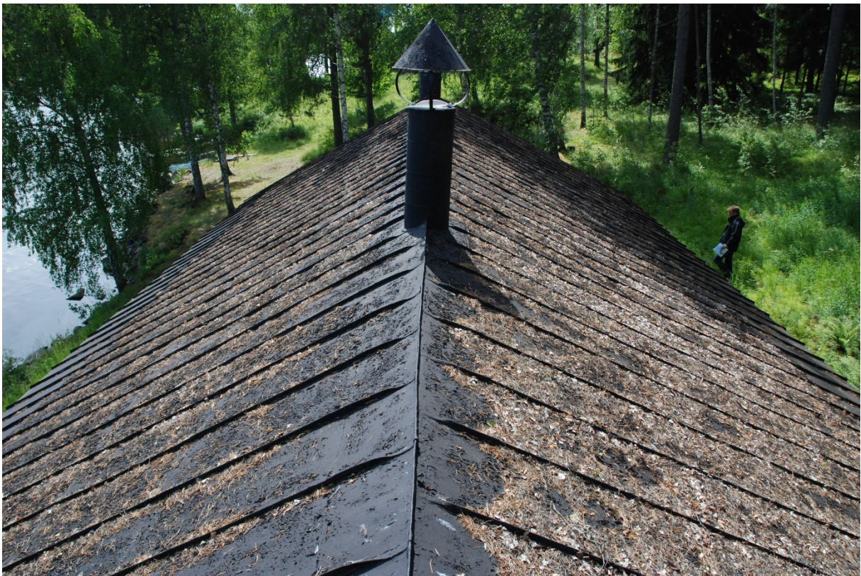
85. Oljekällarens tak mot söder, innan rengöring och ommålning.
