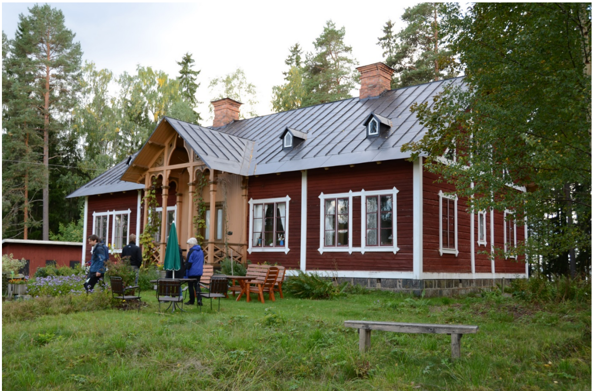
42. Bostadshuset efter renoveringsåtgärder på veranda, fönster och tak.
