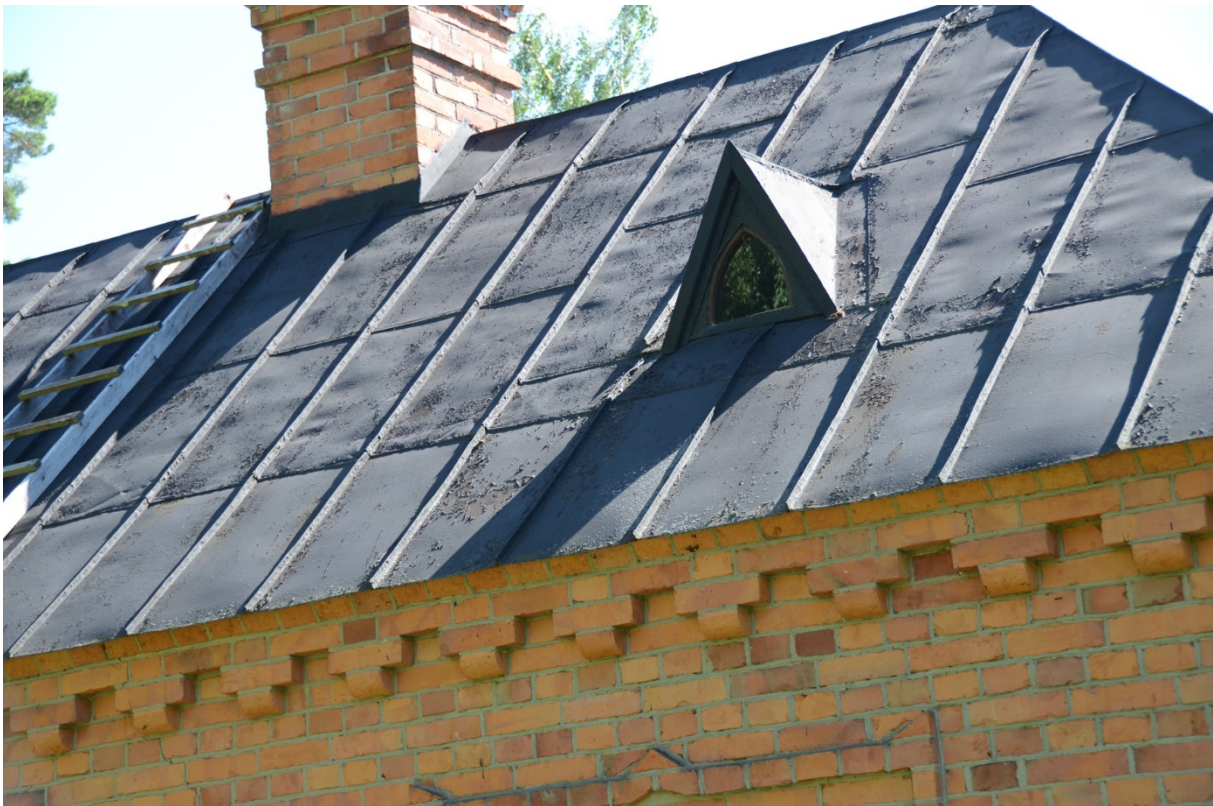
115. Bryggstugans takfall mot väster, innan målningsåtgärderna.
