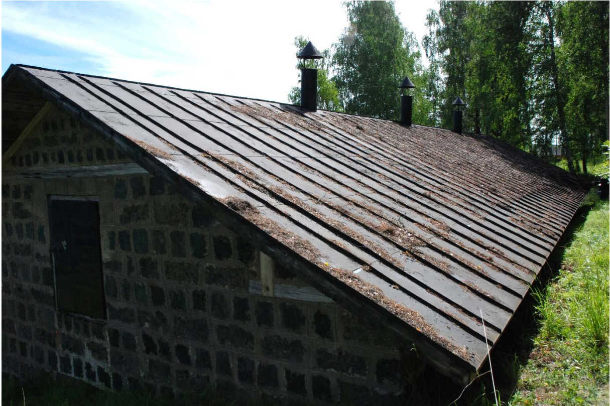
84. Oljekällarens takfall mot väster, innan rengöring och ommålning.
