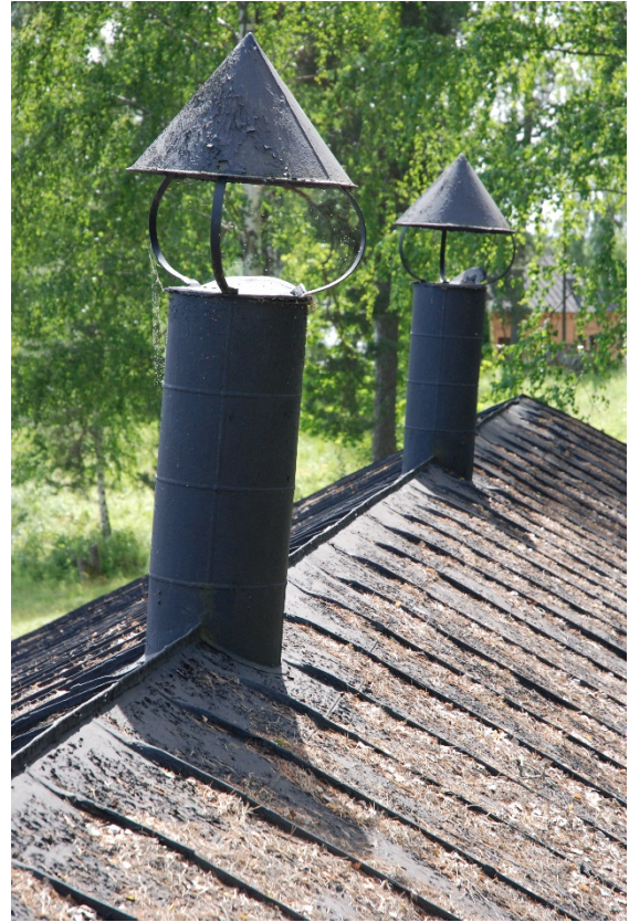
86–87. Huvorna hade kraftiga rostangrepp och delar av plåten var deformerad. Delar byttes ut.
