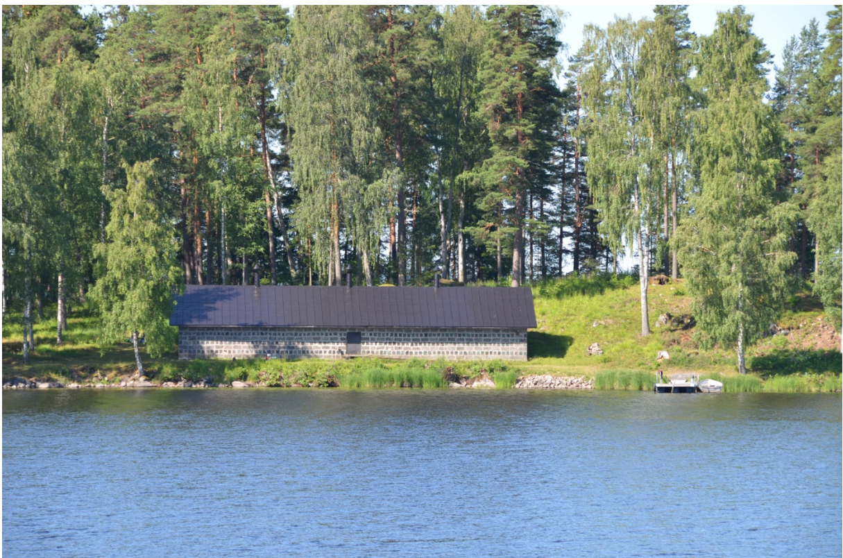
103. Takfallet mot öster efter målningsåtgärderna.
