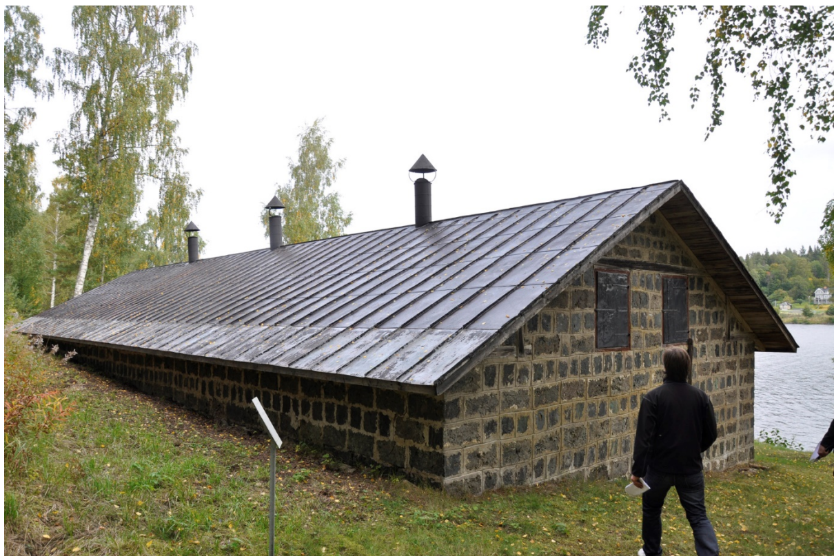
91. Oljekällarens tak efter rengöring.
