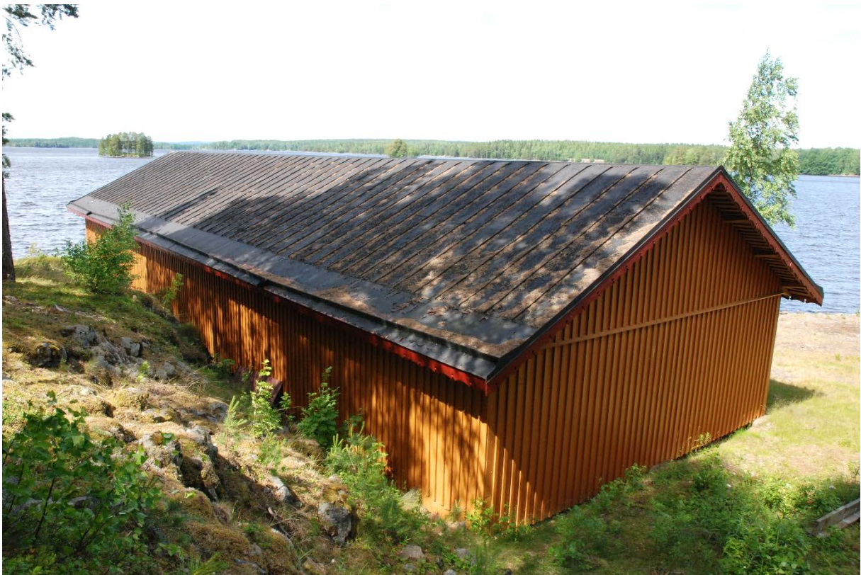
74. Takfallet mot söder innan rengöring och ommålning.
