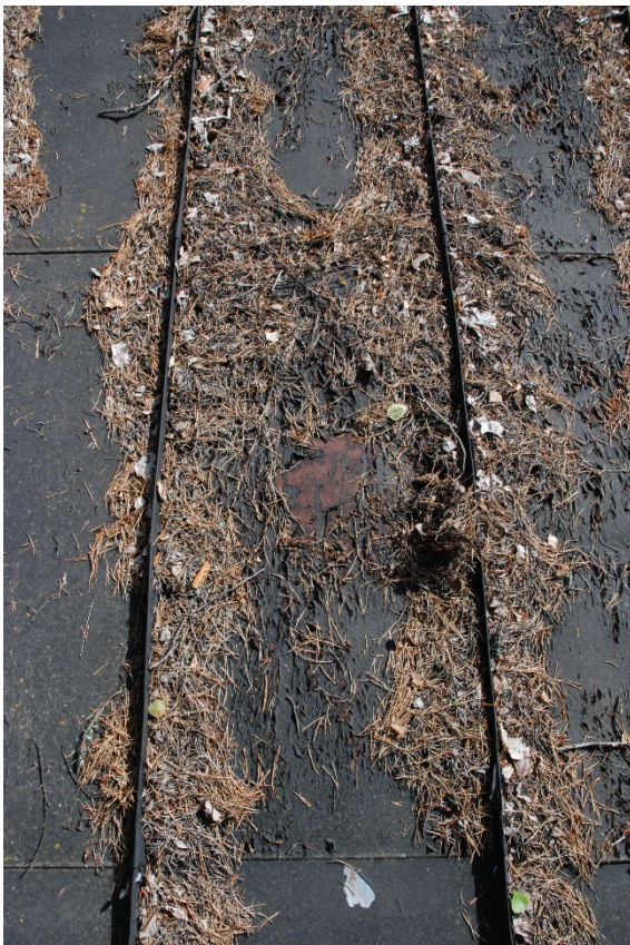
88–90. Takfärgen på oljekällrens tak hade kraftig sprickbildning och på vissa ställen flagnade den.
