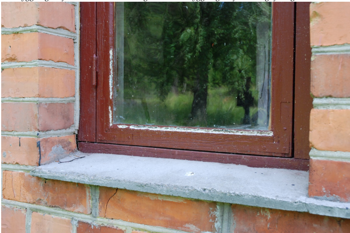
51. Fåglar har pickat bort kittet på den nyrenoverade fönsterbågarna. Bågarna kittades om och då lades olika kryddor i kittet, vilket verkar ha avskräckt fåglarna.
