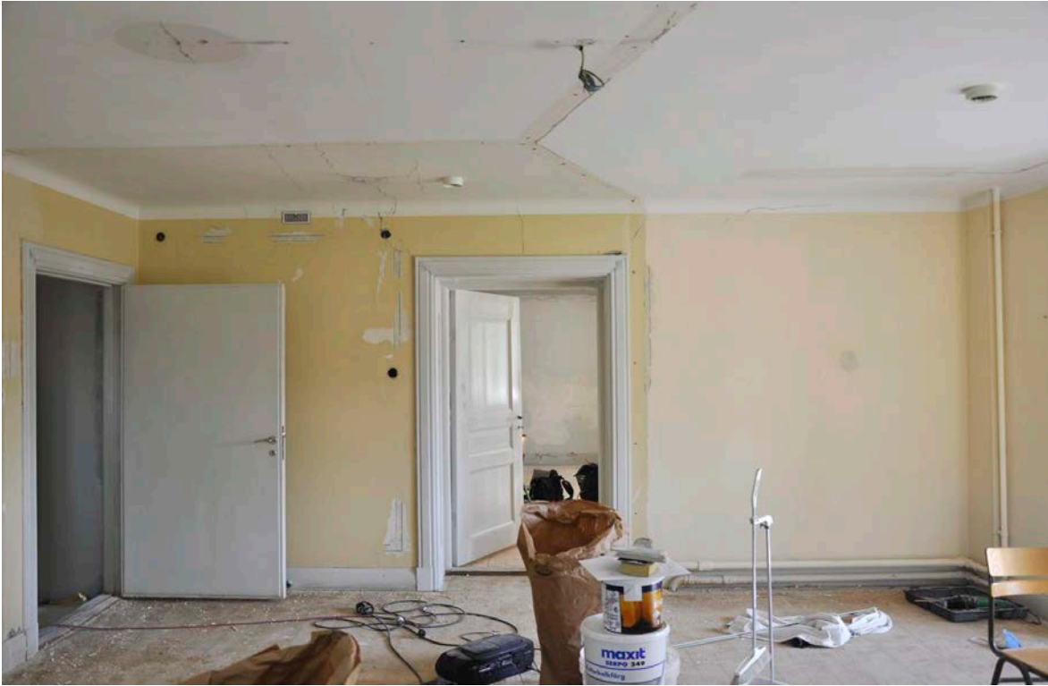
44. Vagg mot soder. Spar av den tidigare rumsindelningen syns pa vagg och tak. Aldre maleri ar framtaget.
