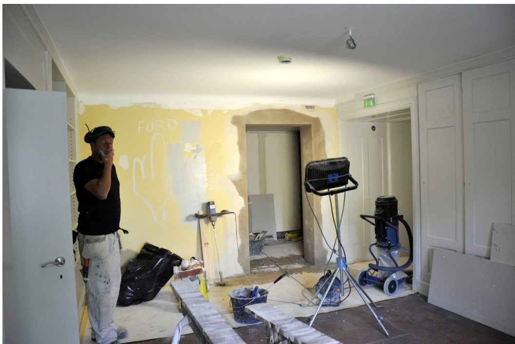
8. Rum 129 efter håltagningen i väggen mot rum 117. T.v. Peo Törngren, murare.
