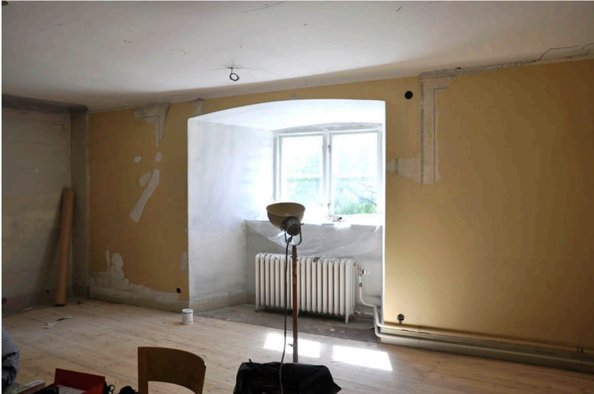
33. På väggen mot väster togs måleriet delvis fram inför ommålningen.
