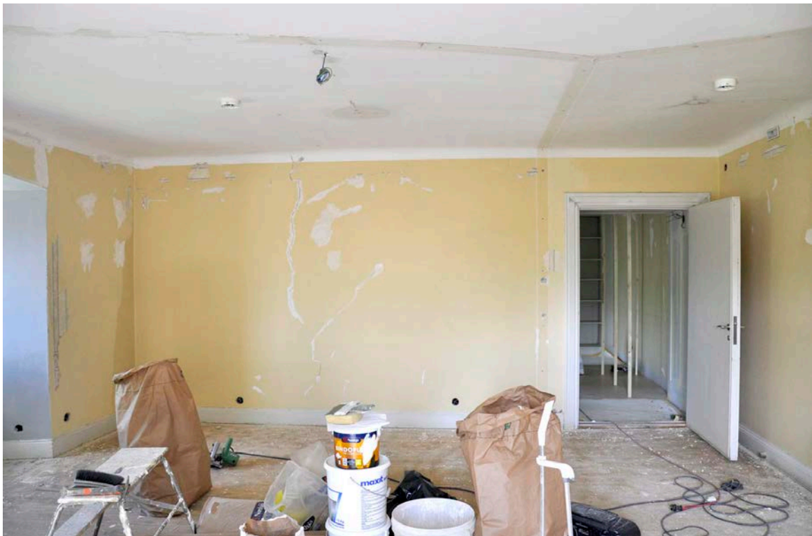
41. Vägg mot öster, mot rum 129. I taket syns spår av de väggar som delat rummet i tre delar
