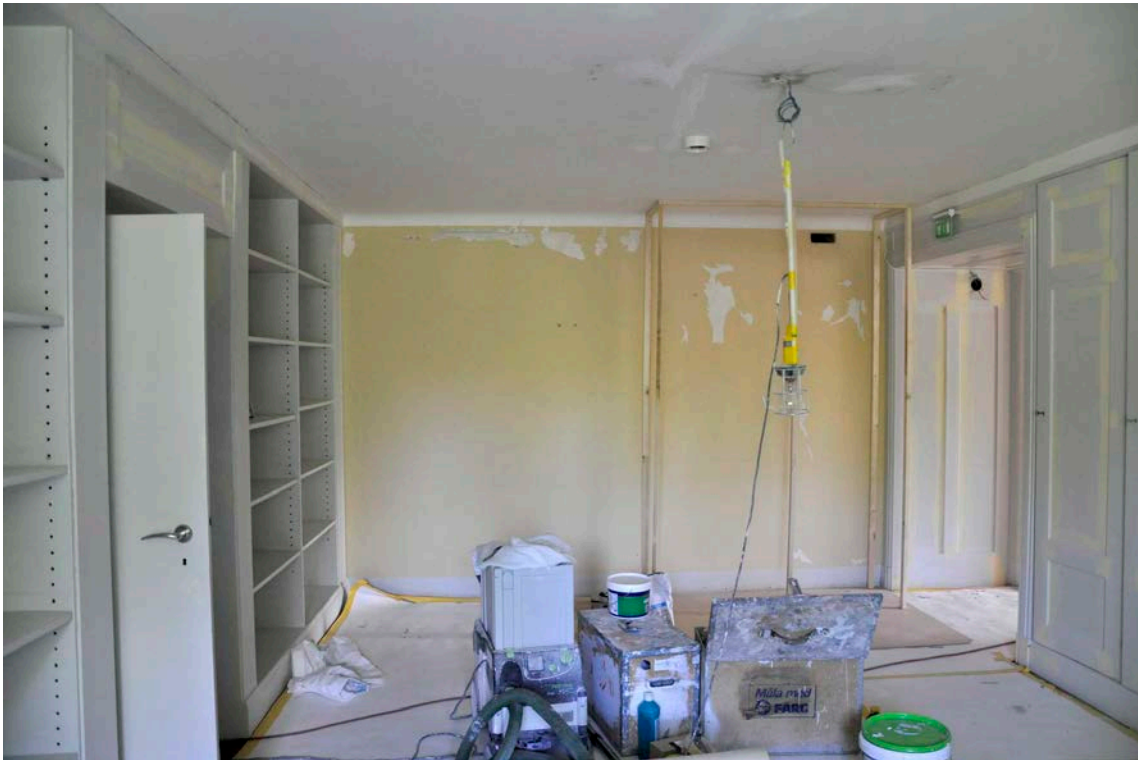
59. Vägg mot söder och rum 117 innan håltagning.
