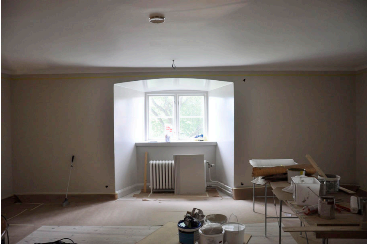
35. Under pågående målning av väggarna med den nya väggfältsindelningen.
