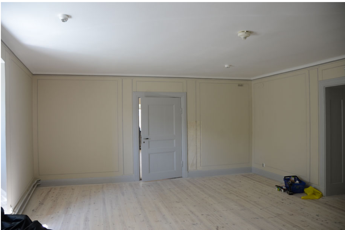
38. De nymålade väggarna och nyslipade golvet. Ett parti av det äldre måleriet är bevarat vid dörren mot norr. Den nya väggfältsindelningen påminner om den äldre från 1920-talet. Alla snickerier, fönstersmygar och dörrar är målade med linoljefärg.
