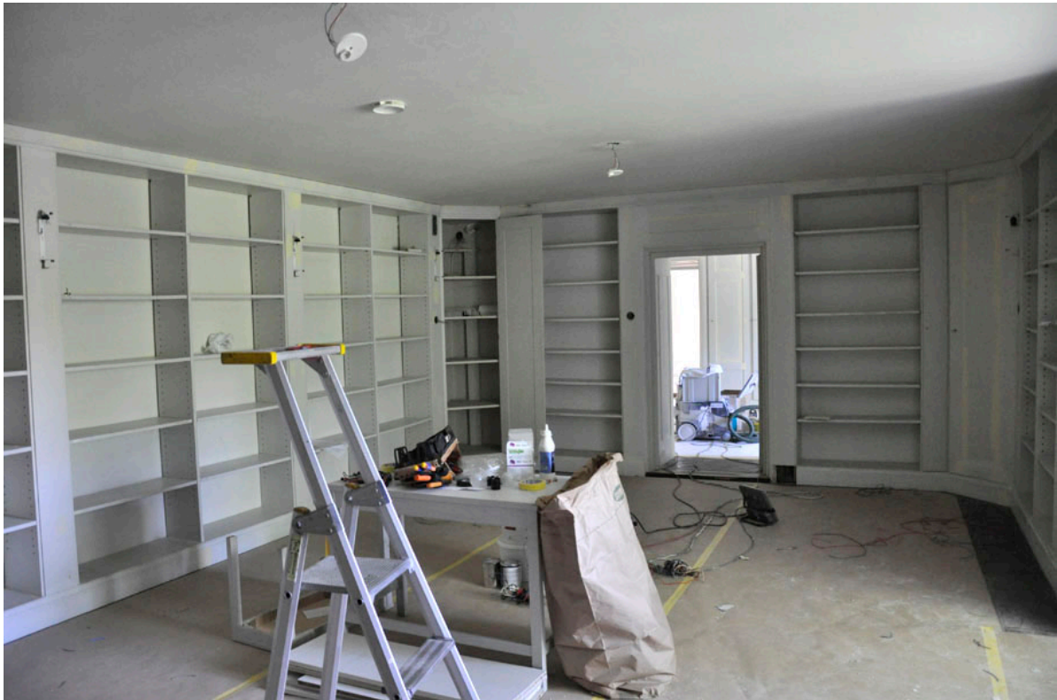
66. Hyllinredningen målades med linoljefärg. Den äldre väggbelysningen monterades ned.
