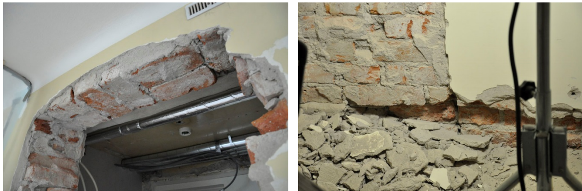
12-13. Detalj av dörröppningens överliggare och nedknackningen av puts från rum 129.
