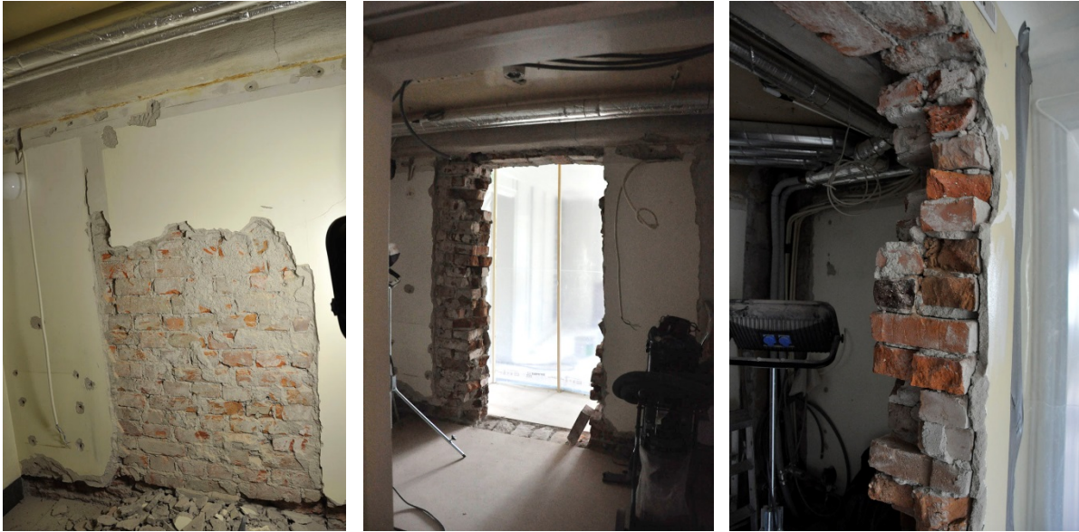
9-11. Håltagning av den tidigare igensatta dörröppningen, från rum 129 och 117.
