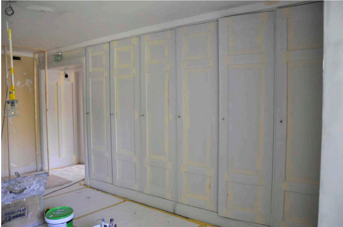
61. Skåp- och hyllinredningen är ritad av Nils Tesch och slipades, spacklades och målades om.
