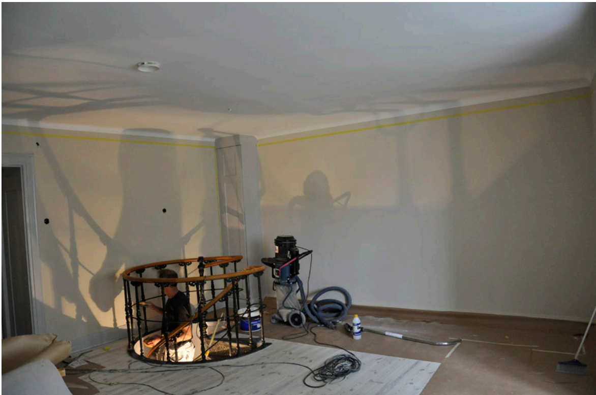
36. Under pågående målning av väggarna med den nya väggfältsindelningen. Trappräcket målades och handledaren oljades.
