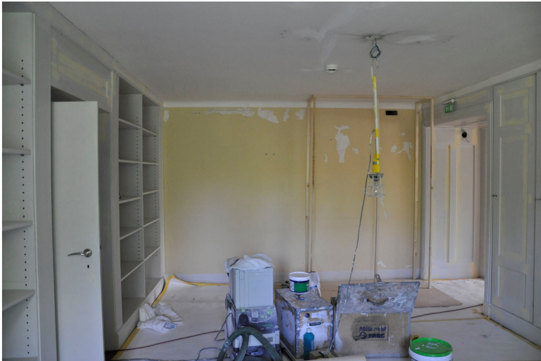
7. Rum 129 innan håltagningen i väggen mot rum 117.
