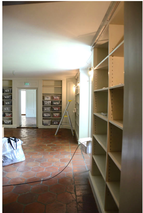
70–71. Rum 130 vid slutbesiktningen. Ny belysning under montering i bokhyllorna.
