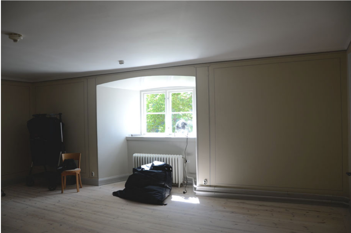
39. De nymålade väggarna. Alla snickerier, fönstersmygar och dörrar är målade med linoljefärg.
