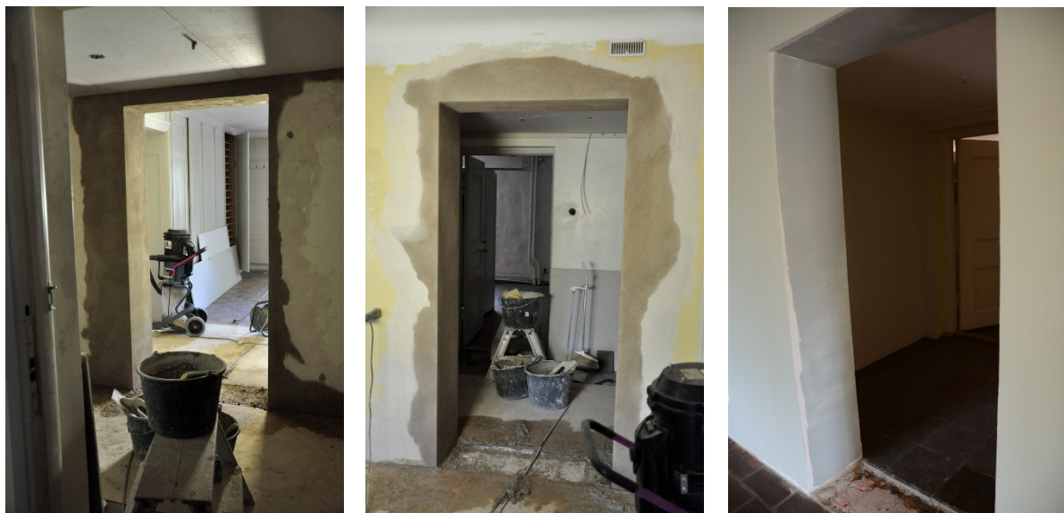
14-16. Dörröppning putsades upp, bild från trapphallen och från rum 129.
