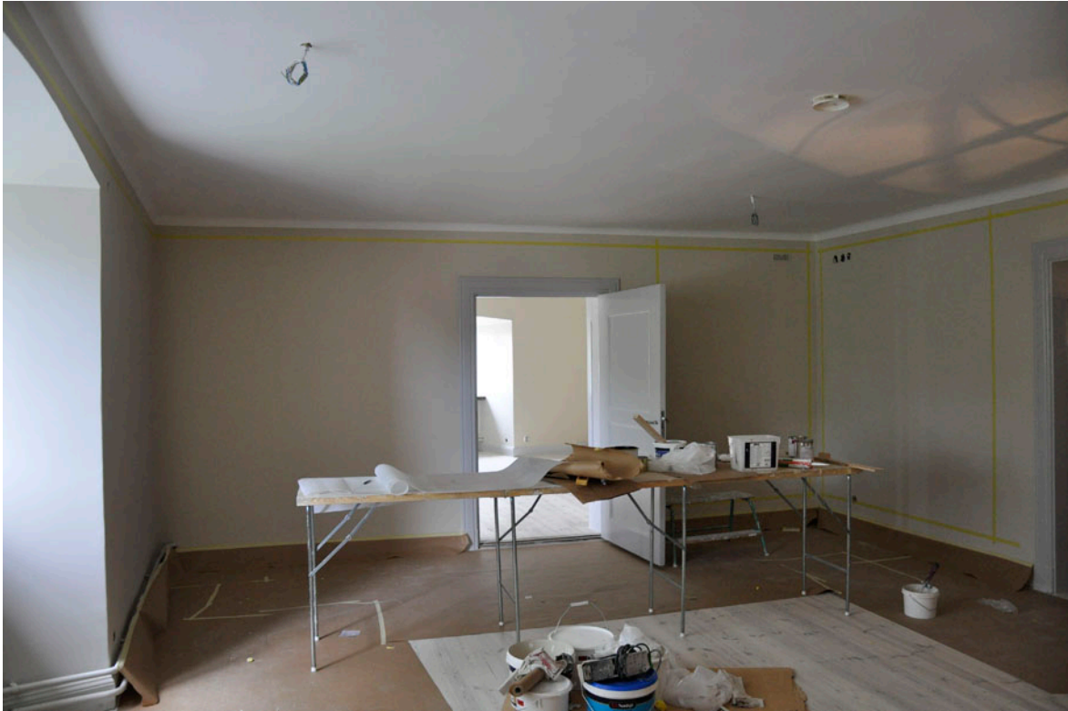
37. Under pågående målning av väggarna med den nya väggfältsindelningen.
