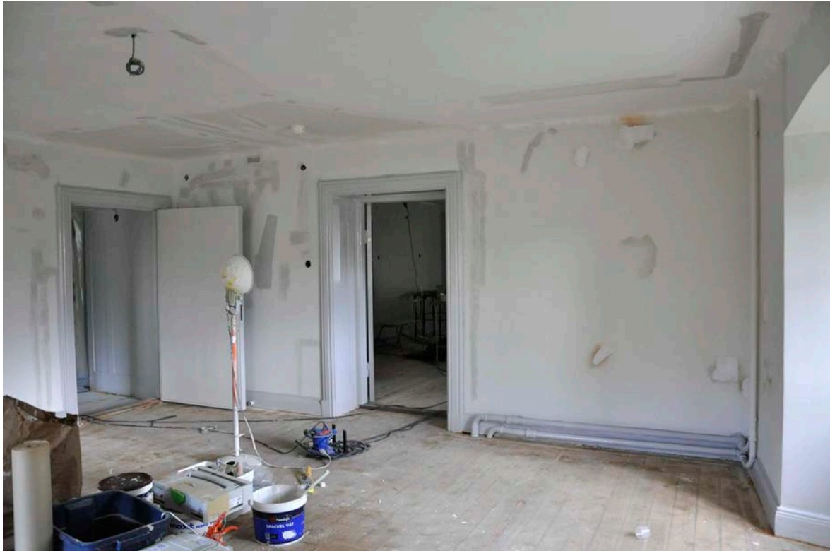
53. Väggen mot söder under pågående renovering.
