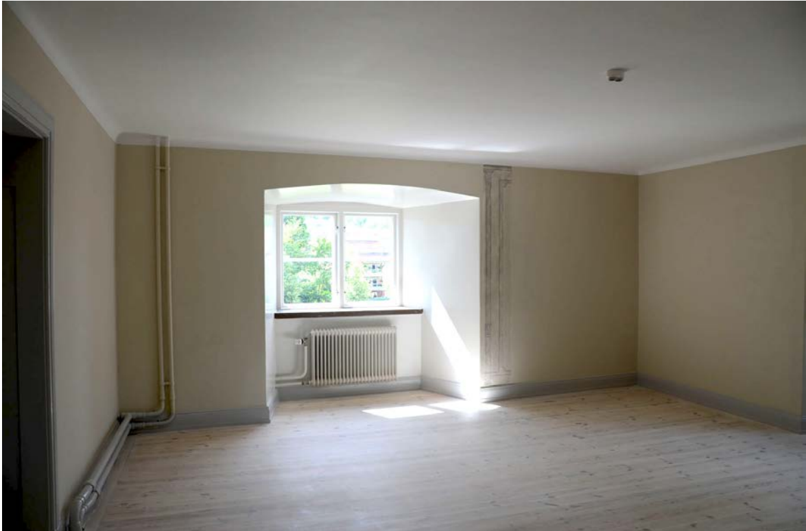
55. Vagg mot väster vid slutbesiktningen.
