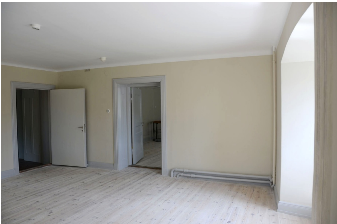
56. Vagg mot söder vid slutbesiktningen.
