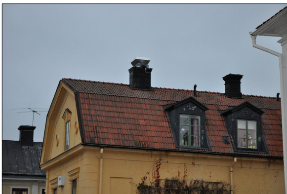
Fläktdonet ovanpå skorstenen, före åtgärd. Foto: Fredrik Ehltun, VLM, bildnr Vlm_kmvFE-848 och Vlm_kmvFE-849.
