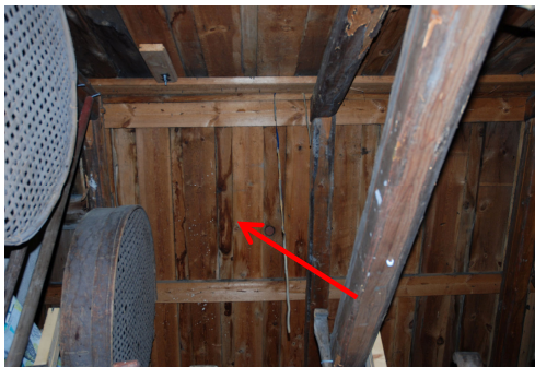
Fuktfläckar. Vlm_kmvLS-905 och Vlm_kmvLS-904.
