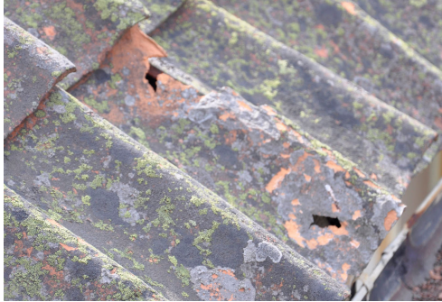
Enkupigt lertegel ligger på bärläkt spikad i undertakets lockbrädor. Vlm_kmvFE-13 visar en skadad panna och Vlm_kmvFE-9 visar taket under lerteglet.
