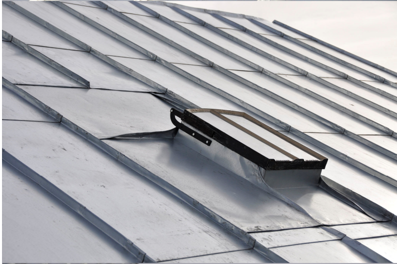
Renoverat och upphöjt takfönster. Vlm_kmøLS-2356
