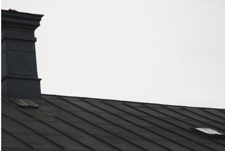
Takfönster innan åtgärder. Vlm_kmvLS-656
