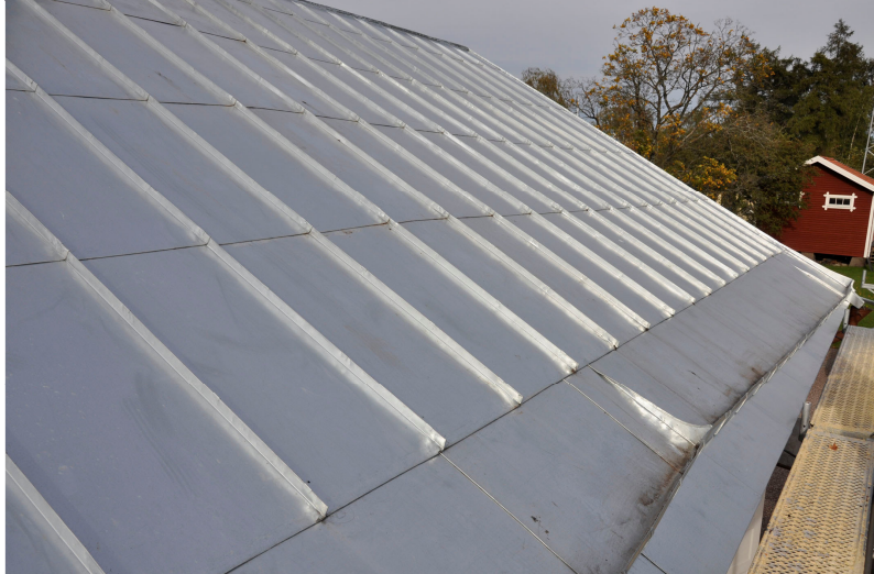
Del av södra takfallet. Vlm_kmøLS-2352
