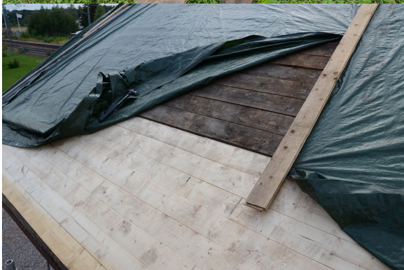
Lagningar av undertak på norra takfallet. Vlm_kmvLS-1973
