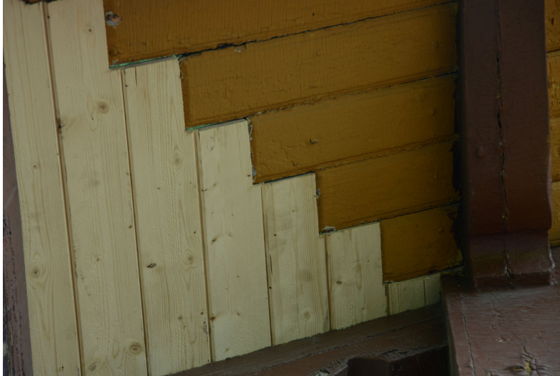
Lagningar av undertak på norra takfallet. Vlm_kmvLS-1972
