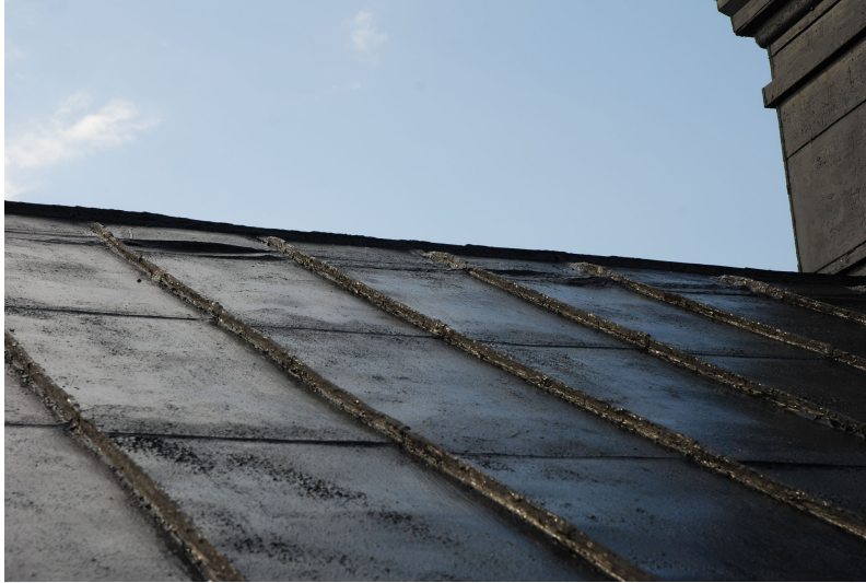
Plåttak innan omläggning. Vlm_kmvLS-1709
