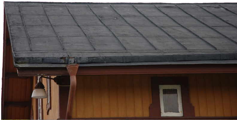
Plåttak innan omläggning. Vlm_kmvLS-654
