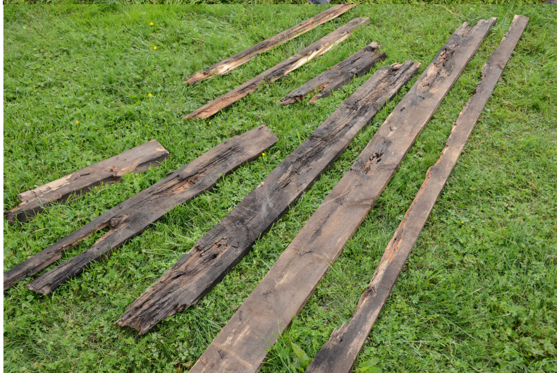
Rötskadade undertaksbrädor. Vlm_kmvLS-1970
