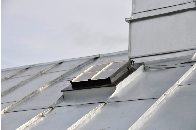
Renoverat och upphöjt takfönster. Vlm_kmøLS-2354
