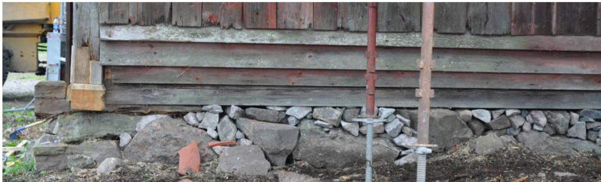
Bild 9 10 . Stenar lades in i grunden där det saknades sten för att stödja syllens bärande av stolpverkskonstruktionen.
