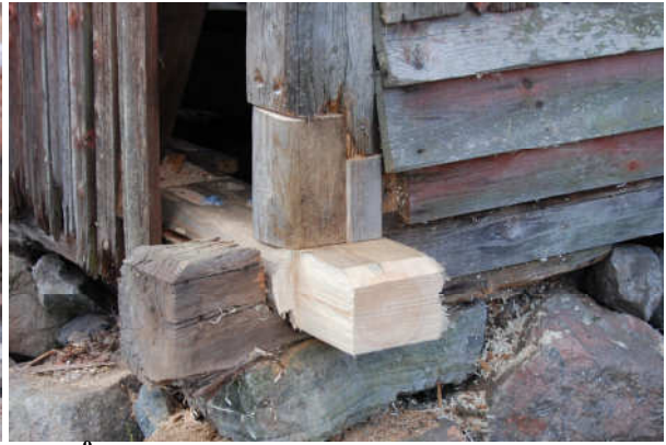
Bild 8 9 . Syllstocken lagades med halvsulning.
