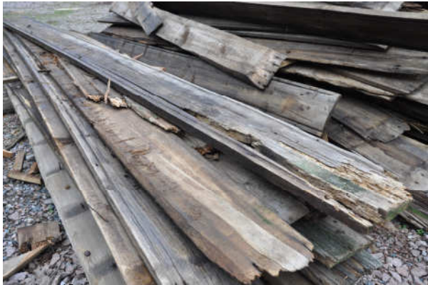
Bild 14 15 . Det befintliga undertaket var mycket skadat.
