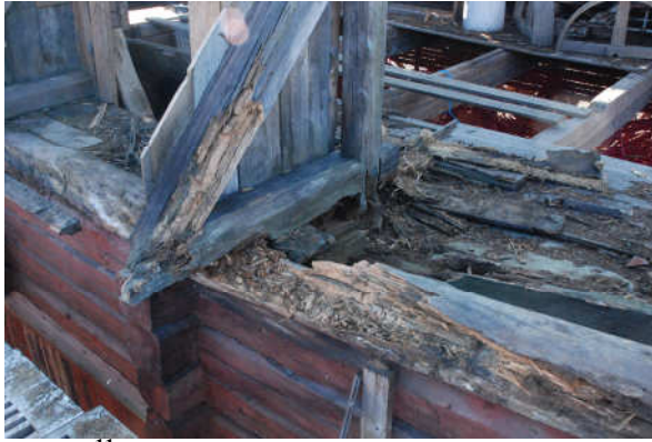
Bild 10 11 . Skadade delar på takstolen och bjälklag.
