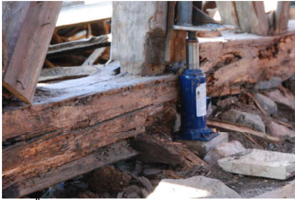
Bild 7 8 . Syllstocken och grunden under restaurering.
