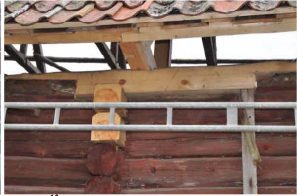
Bild 11 12 . Nytt timmer lades in med halvsulning.
