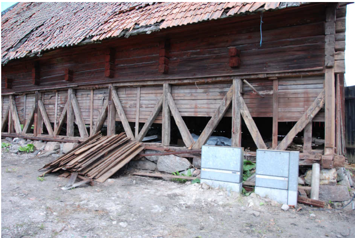
Bild 3 3 . Stolpverkskonstruktionen i bottenplanet och den timrade överdelen tyder på byggnadens funktion som kollada.
