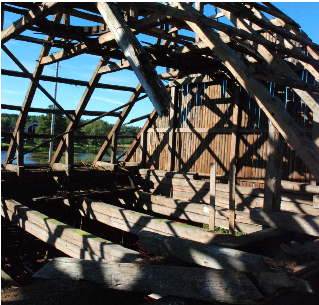
Bild 12 13 . Skadorna på takstolen var omfattande och vissa delar saknades helt.
