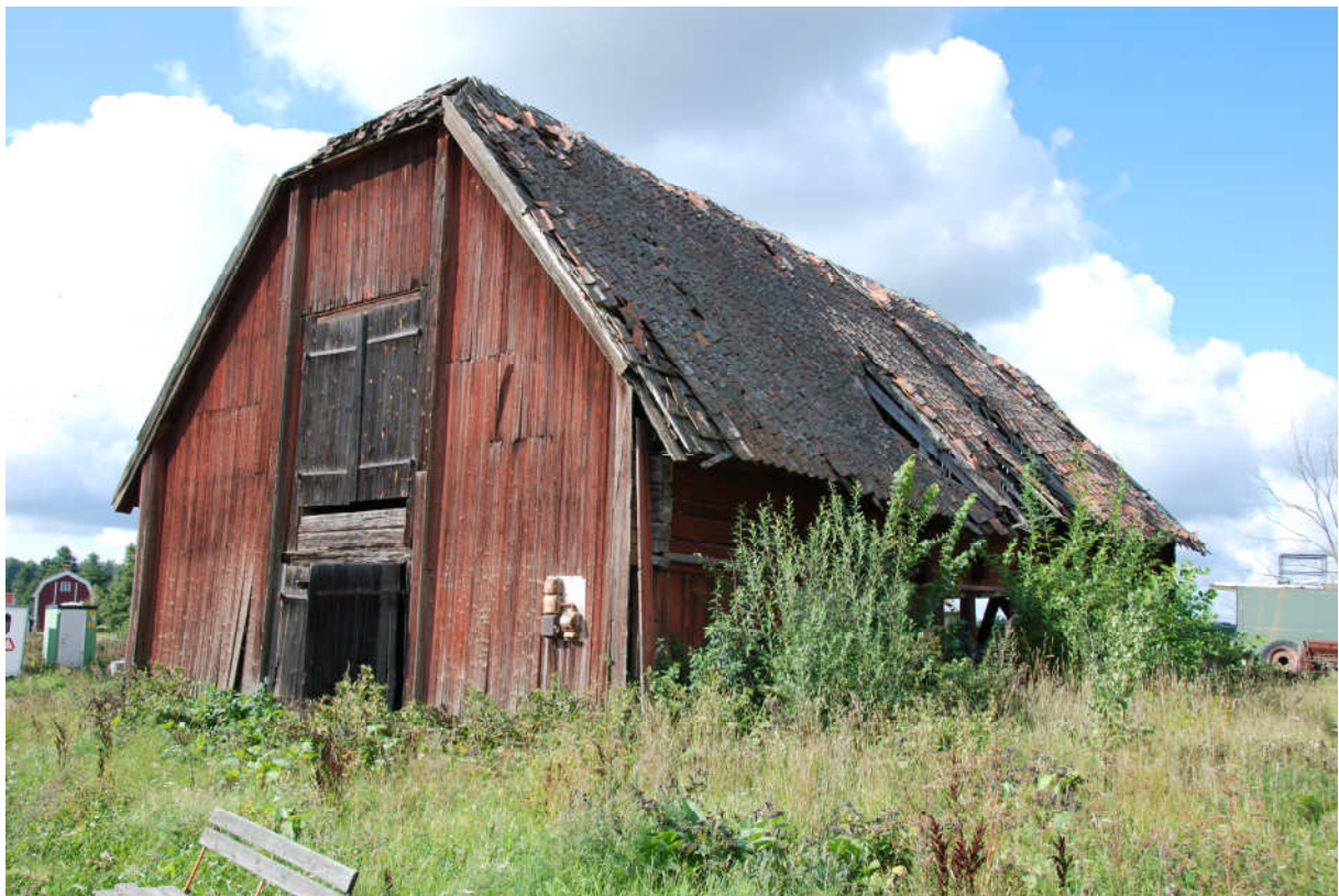
Bild 5 6 . Kolladan var i förfallet skick med skador på takstolar, taktäckning, panel och syllstock.
