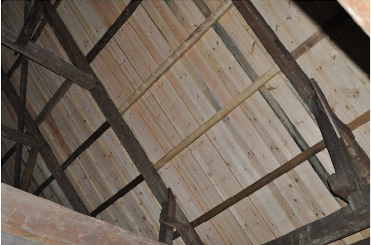
Bild 13 14 . Lagningarna på takstolskonstruktionen genomfördes med halvsulning.
