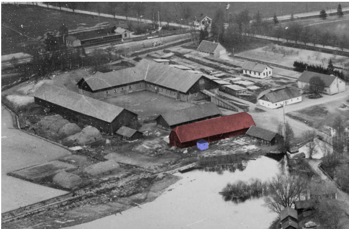
Bild 2 2 . På ett flygfoto från 1922 syns kolladan två gånger så lång som idag. Kolladan är markerad i rött och transformatorstationen är markerad i blått.
