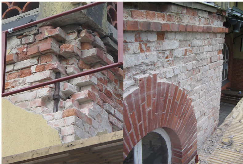
Toå närbilder på balkongens sydvästra hörn och sydöstra del. Löst sittande puts och skadat tegel har rensats bort inför lagning med nytt tegel och omputsning. Foton tagna av hantverkaren Christian Olsén.
