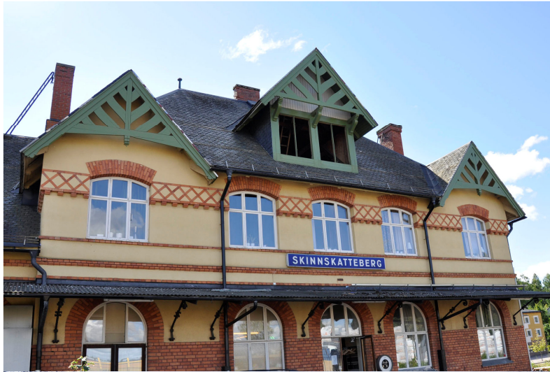
Snickerier restaurerade och ommålade på spårsidan. Vlm_kmvLS-2023.
