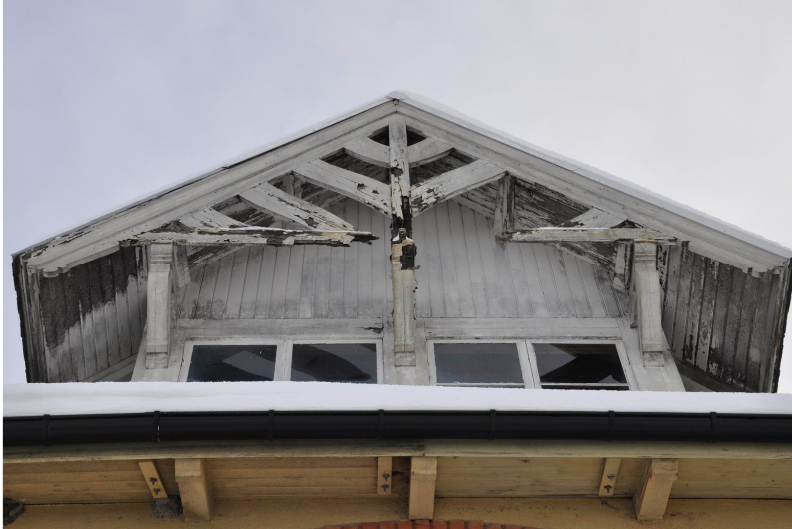
Rötskadade snickerier på takkupa mot spårsidan. Vlm_kmoLS-2816
