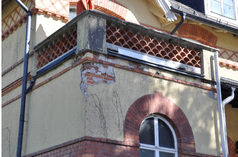
Putsbortfall på balkong innan arbetet påbörjas. Vlm_kmvIM-373
