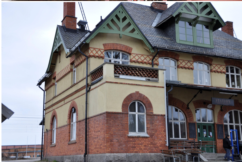
Balkong efter åtgärd. Vlm_kmvLS-2796
