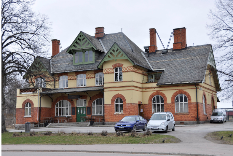
Snickerier restaurerade och ommålade, sydöstra fasaden. Vlm_kmvLS-2790
