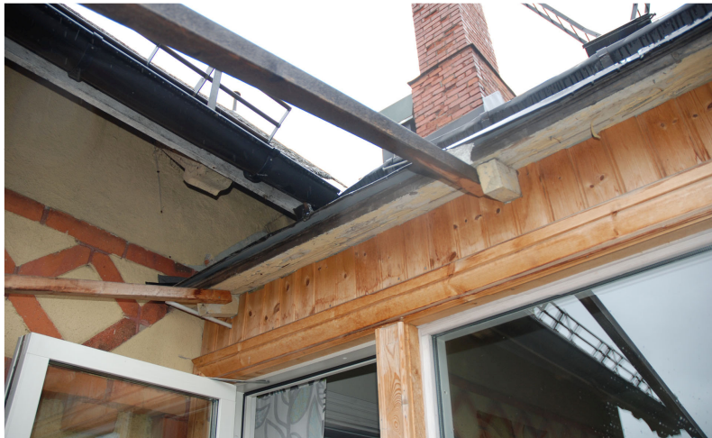
Närbild av den provisoriska konstruktionen av reglar. Vlm_kmvLS-1929
