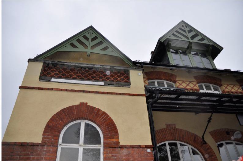
Balkong efter åtgärd. Vlm_kmvFE-719
