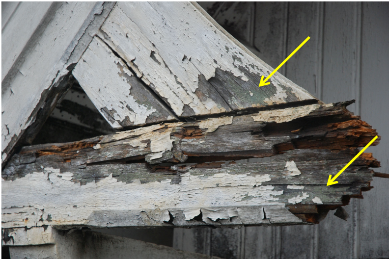
Rötskadade snickerier med gröna färgrester under den vita. Vlm_kmoLS-1958
