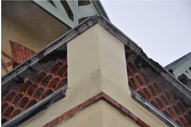
Gamla plåten har avlägsnats. Vlm_kmvFE-717
