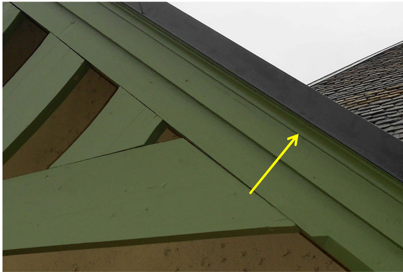
Närbild på ny plåtaotäckning där nedre delen av hålkärslisten framträder. Foto taget av Fredrik Skog.
