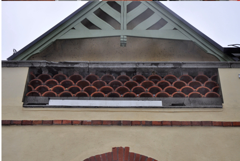
Balkong efter åtgärd. Vlm_kmvFE-720
