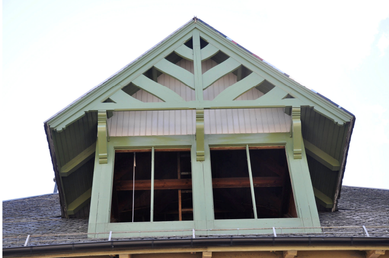
Takkupa mot spårsidan efter restaurering och ommålning. Vlm_kmvLS-2024
