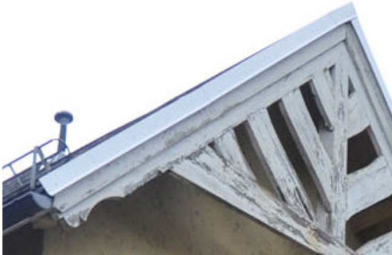
Vlm_kvIM-727. På bilden syns tidigare utförande av vit plåt-avtäckning som går ner över en hålkärslis som är fäst mellan övre vindskivan och yttersta undertaksbrädan.
