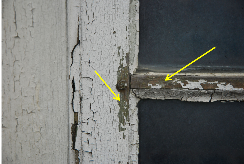
Fönsterbågar med gröna färgrester under den vita. Vlm_kvLS-1954
