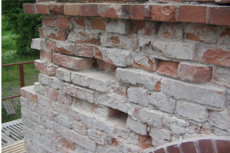
Närbild på balkongens fasad. Löst sittande puts och skadat tegel har rensats bort inför imurning med nytt tegel och omputsning. Foton tagna av hantverkaren Christian Olsén.
