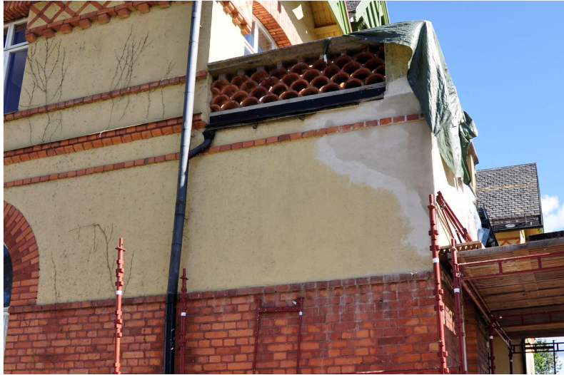
Lagningar av murverket har utförts och putsning pågår. Vlm_kmvLS-2028
