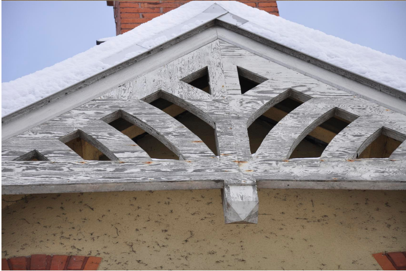
Snickerier reparerade med Byggplyfa. Vlm_kmoLS-2817
