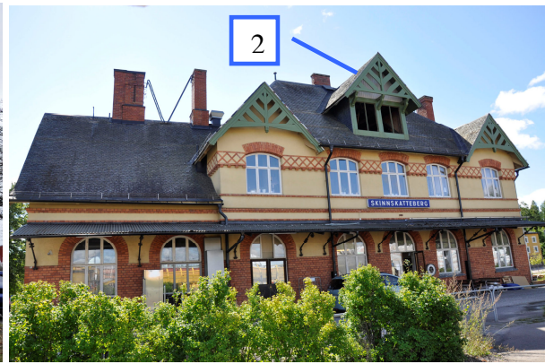
Vlm_kmvLS-2022. Fasaden mot spårsidan.
