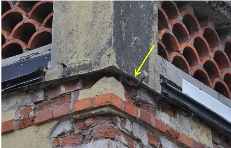
Vattskiva av plåt innan åtgärd. Vlm_kmvIM-726
