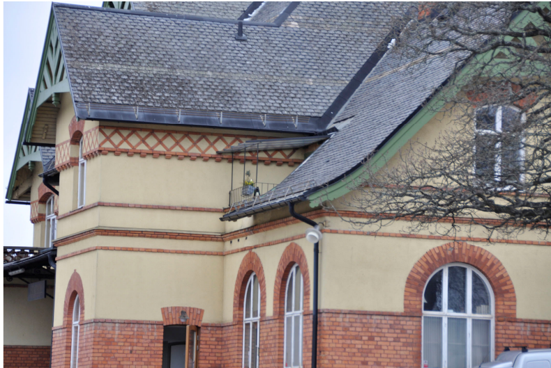
Balkongen efter åtgärd. Vlm_kmvLS-2798
