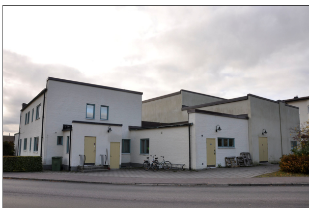
Bild 21. Läkarvillan från nordost. Bildnr Vlm_kmvIM-2234.
