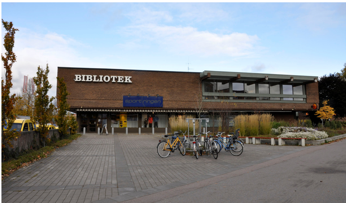
Bild 39. Biblioteket från 1972 är, trots vissa tillskott av skyltar och kulörbytte, välbevarat. Bildnr Vlm_kmvIM-2175.
