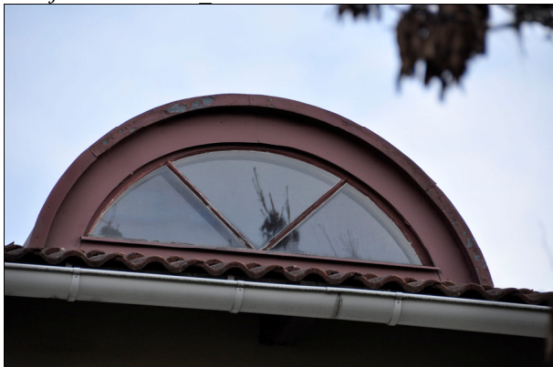
Bild 15. Takkuporna har lunettfönster med smäckra spröjs. Bildnr Vlm_kmvIM-2243.
