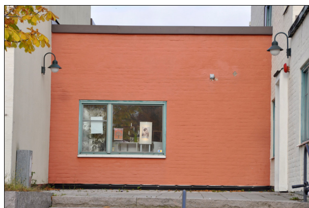
Bild 22. Länken mellan den ursprungliga villan och teatern är avfärgad i klarorange. Bildnr Vlm_kmvIM-2238.
