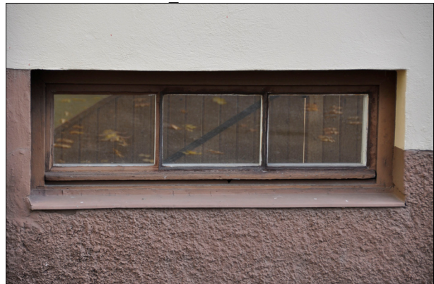
Bild 16. Källarfönstren är i original, även kulörmässigt, vilket kan vara användbart vid en restaurering. Bildnr Vlm_kmvIM-2220.
