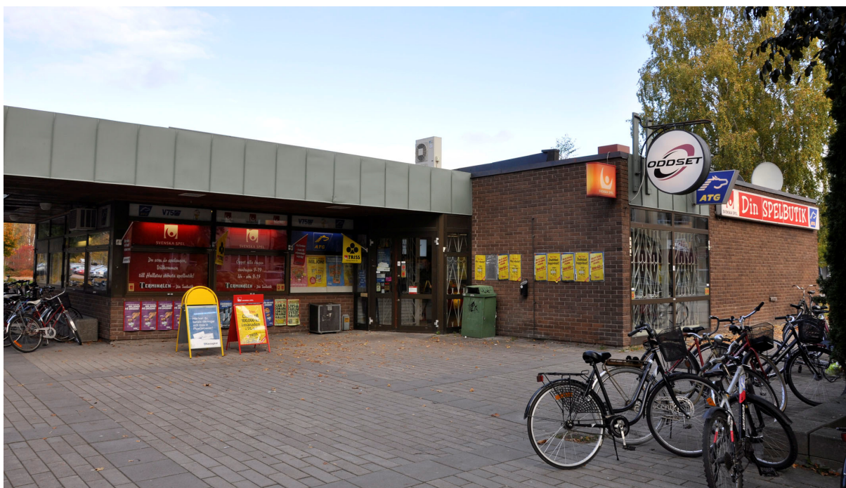
Bild 40. Kiosken som ligger öster om biblioteket uppfördes samtidigt som detta och de båda byggnaderna har en tydlig samhörighet genom den sparsmakade arkitekturen. Bildnr Vlm_kmvIM-2141.
