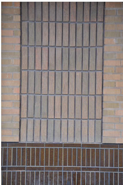
Bild 35. I Centrumhusets fasad har man arbetat med olika typer av tegel, kakel och fog, allt i olika nyanser av brunt. Bildnr Vlm_kmvIM-2216.
