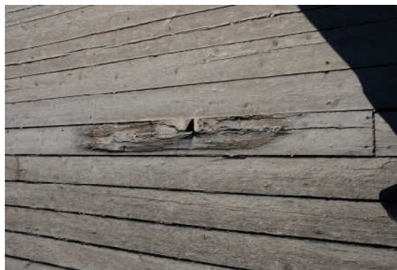
Bild 9 9 . Körbanan hade även skador från vinterunderhåll.
