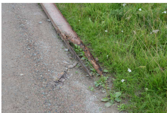
Bild 6 6 . Rostangreppet på stål balkarna var värre än väntat.
