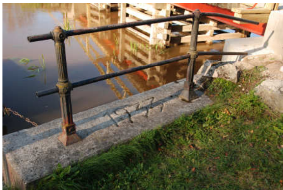
Bild 2 2 . Datering märkt i betongen när kajen förstärktes.
