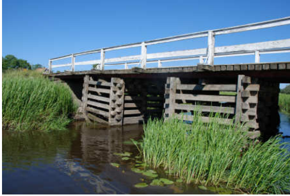
Bild 16 16 . Rostangreppet på stålbalkarna var värre än väntat.
