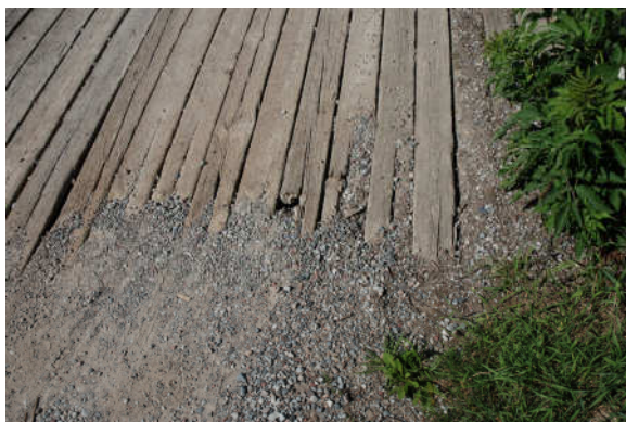
Bild 8 8 . Körbanan var sliten vid brofästet.
