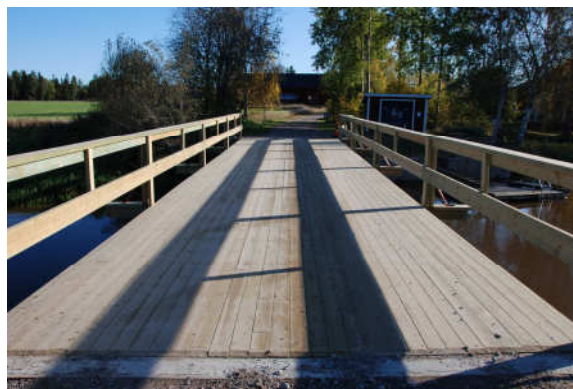
Bild 13 13 Körbanan hade även skador från vinterunderhåll.
