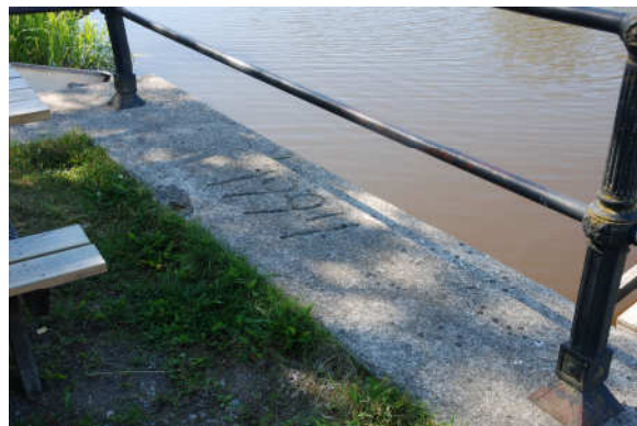
Bild 3 3 . Datering i betongen när kajen rustades upp 1994.
