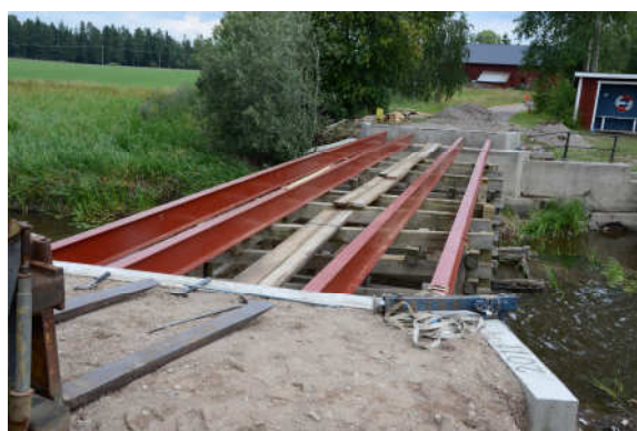
Bild 11 11 . De nya stålbalkarna är grövre än de gamla.
