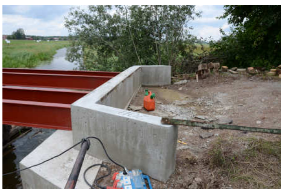
Bild 10 10 . En betongkant göts på brofästet för att hindra vatten att skada de nya stålbalkarna. Gjutningen märktes med "2011"
