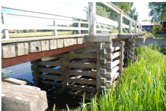
Bild 4 4 . Bron är en balkbro. Större delen är av trä, men den är försedd med längsgående röda stål balkar.
