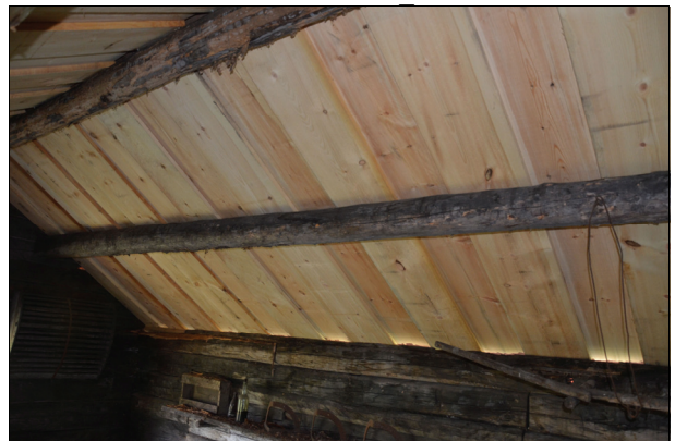
Det nya undertaket är av kilsågad kärnfura. Bildnr Vlm_kmvIM-1558 och 1559.
