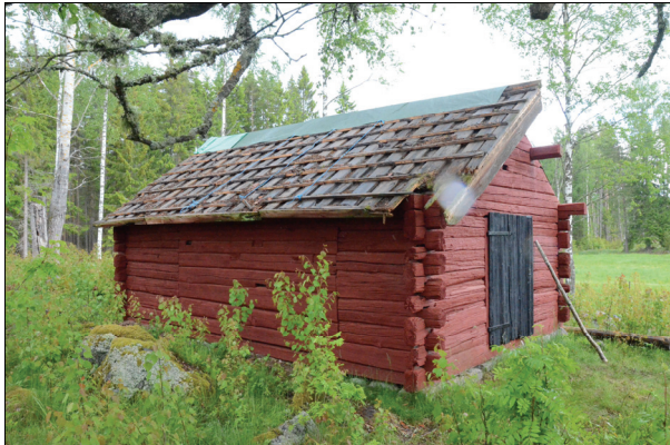
Smedjan från sydväst under restaurering. Att undertaket var i det närmaste genomrötat blev tydligt när teglet plockats bort. Bildnr Vlm_kmvIM-1409 och 1406.
