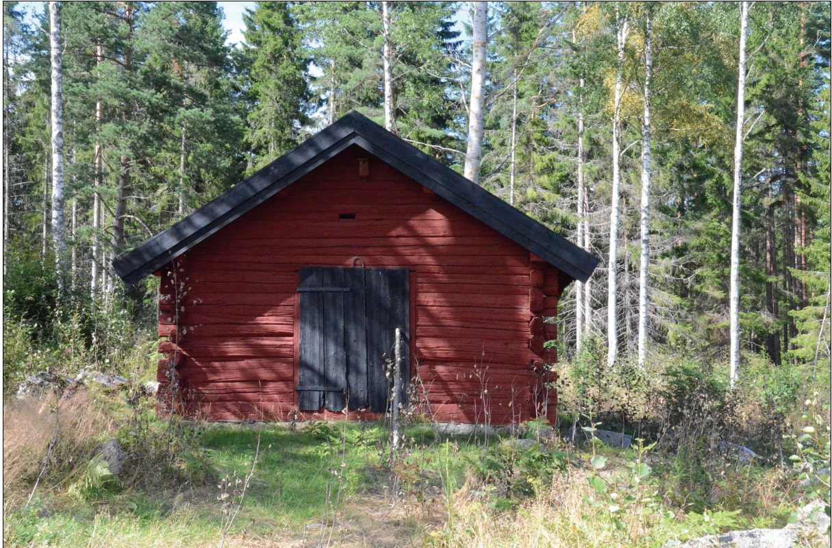
Byggnadens södra fasad efter restaurering. De nya vindskeivorna målades svarta. Bildnr Vlm_kmvIM-1553.
