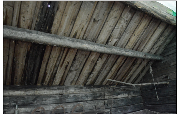
Smedjan från sydväst under restaurering. Att undertaket var i det närmaste genomrötat blev tydligt när teglet plockats bort. Bildnr Vlm_kmvIM-1409 och 1406.
