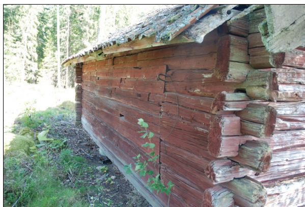
Byggnadens västra fasad före restaurering. Bildnr Vlm_abgFE-206.
