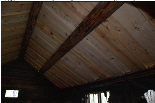
Det nya undertaket är av kilsågad kärnfura. Bildnr Vlm_kmvIM-1558 och 1559.
