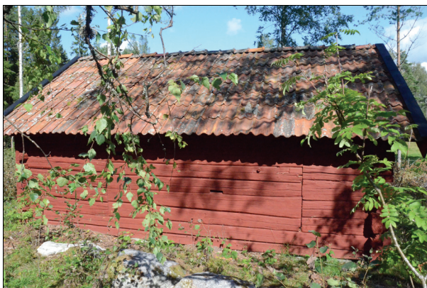
Det västra takfallet efter takomläggningen. Bildnr Vlm_kmvIM-1556.
