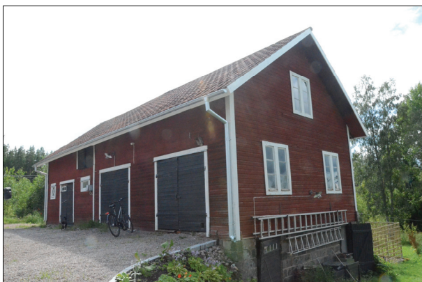
Byggnaden från nordöst efter restaurering. Den nya takavvattningen har stuprör med skarpa knän. Bildnr Vlm_kmvIM-1543.
