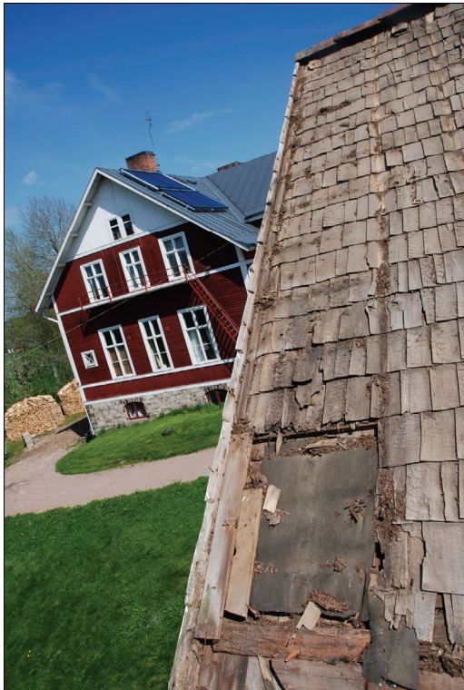
Th: På undertaket fanns sekundära lagningar. Vindskivan är uthuggen efter tegelpannorna. Bildnr Vlm_kmbvIM-1327.
