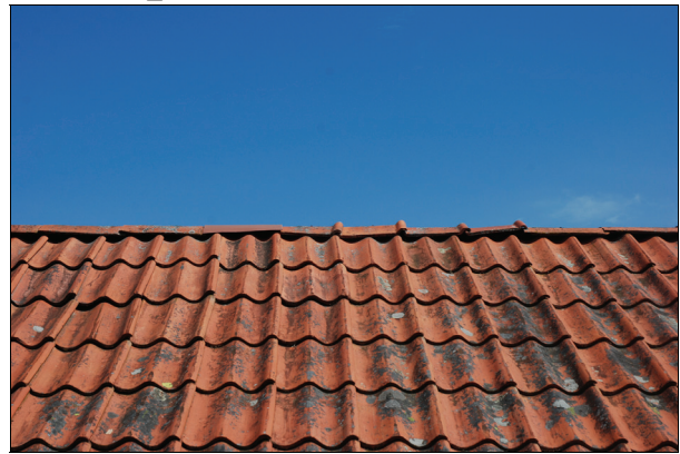
Nocktäckningen bestod av olika typer av nockpannor och på vissa ställen var den kompletterad med rödlackerad plåt. Bildnr Vlm_kmvIM-1330.
