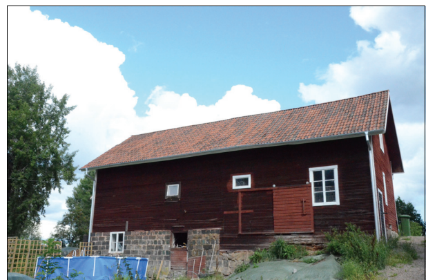
Den västra fasaden efter restaurering. Bildnr Vlm_kmvIM-1549.
