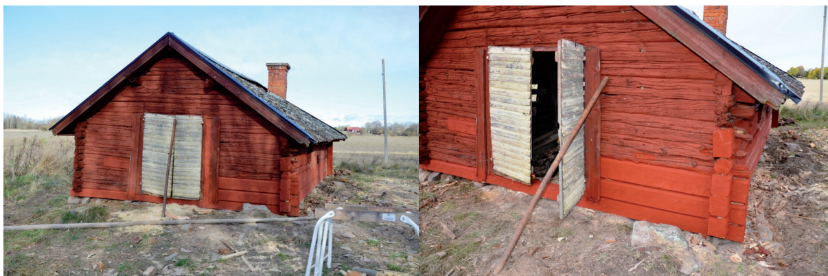
Södra fasaden. Syllstocken och 2 stockvarv till höger om dörren har bytts ut. Vlm_kmvFE-1974
