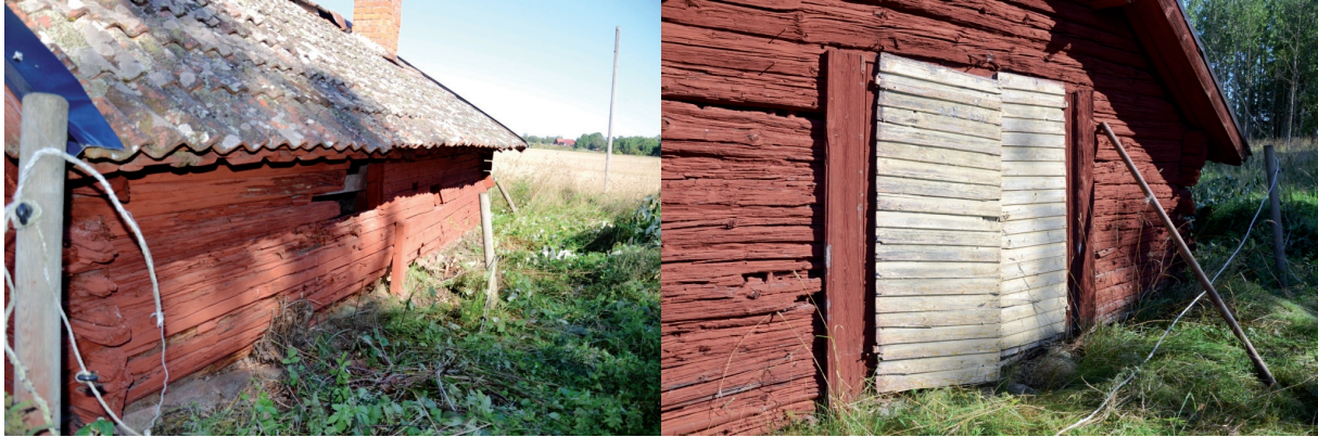
Smedjans östra fasad som buktar utåt, rötskador i timmerstockarna.
