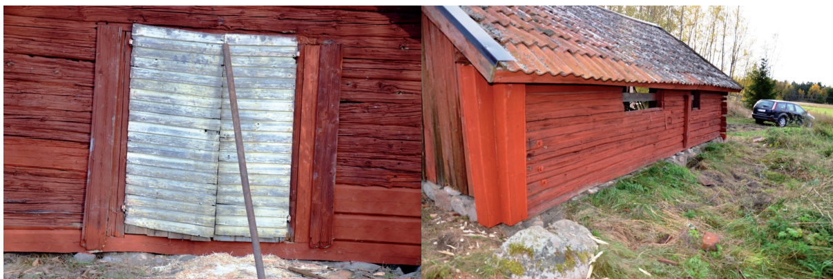
När byggnadens rätades upp och höjdes blev avståndet mellan dörrposterna längre, vilket gjorde att dörrbladen inte gick ihop. Karmen fick därför byggas på med en stolpe. Vlm_kmvFE-1972
