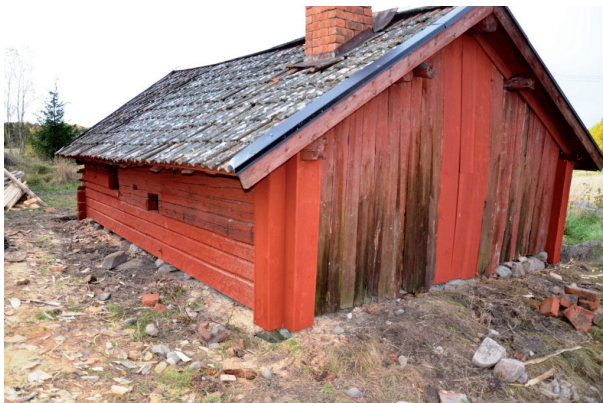
Panelen på den norra fasaden avlägsnades och sattes tillbaka när byggnaden hade höjts. De mittre brädorna ersattes med nya. Vlm_kmvFE-1921
