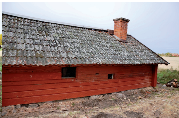
Västra fasaden. Vlm_kmvFE-1920
