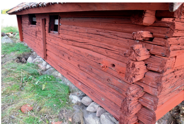
Östra fasaden. Vlm_kmvFE-1924
