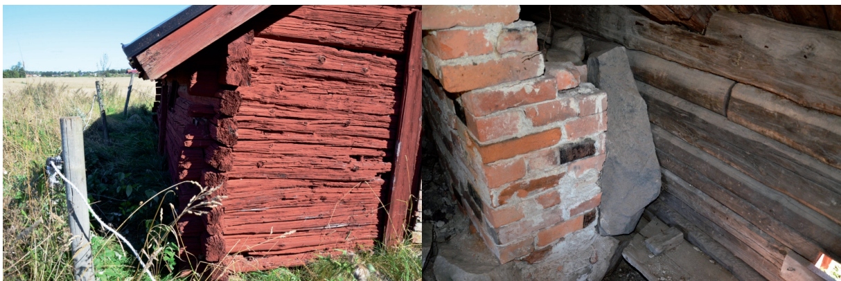
Även den västra väggen buktade utåt.
