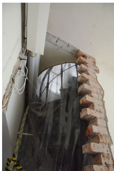
28-36. Rum 019 och 020 under ombyggnationen. Delar av väggen mot rum 017 rivs.
