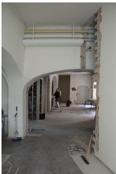
28-36. Rum 019 och 020 under ombyggnationen. Delar av väggen mot rum 017 rivs.
