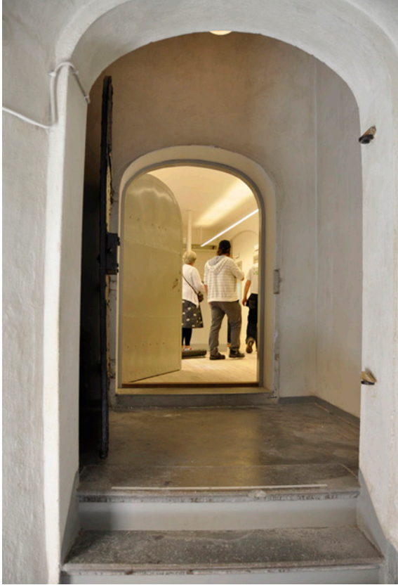
55 – 56. Från trapphuset i öst. Den äldre plåtdörren målades och fick nytt lås. Dörren ställs i uppställt läge ur utrymningssynpunkt.
