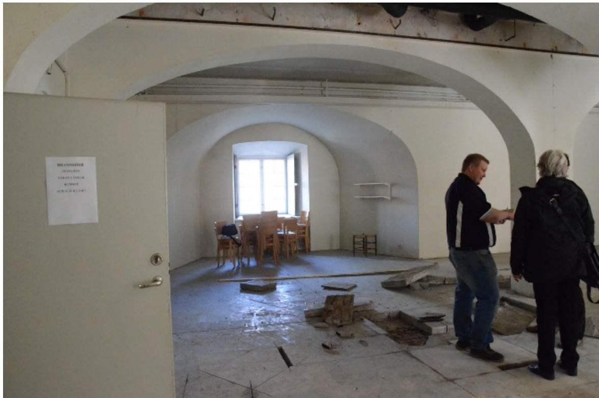
8-9. Rum 117 under rivningsarbetet.
