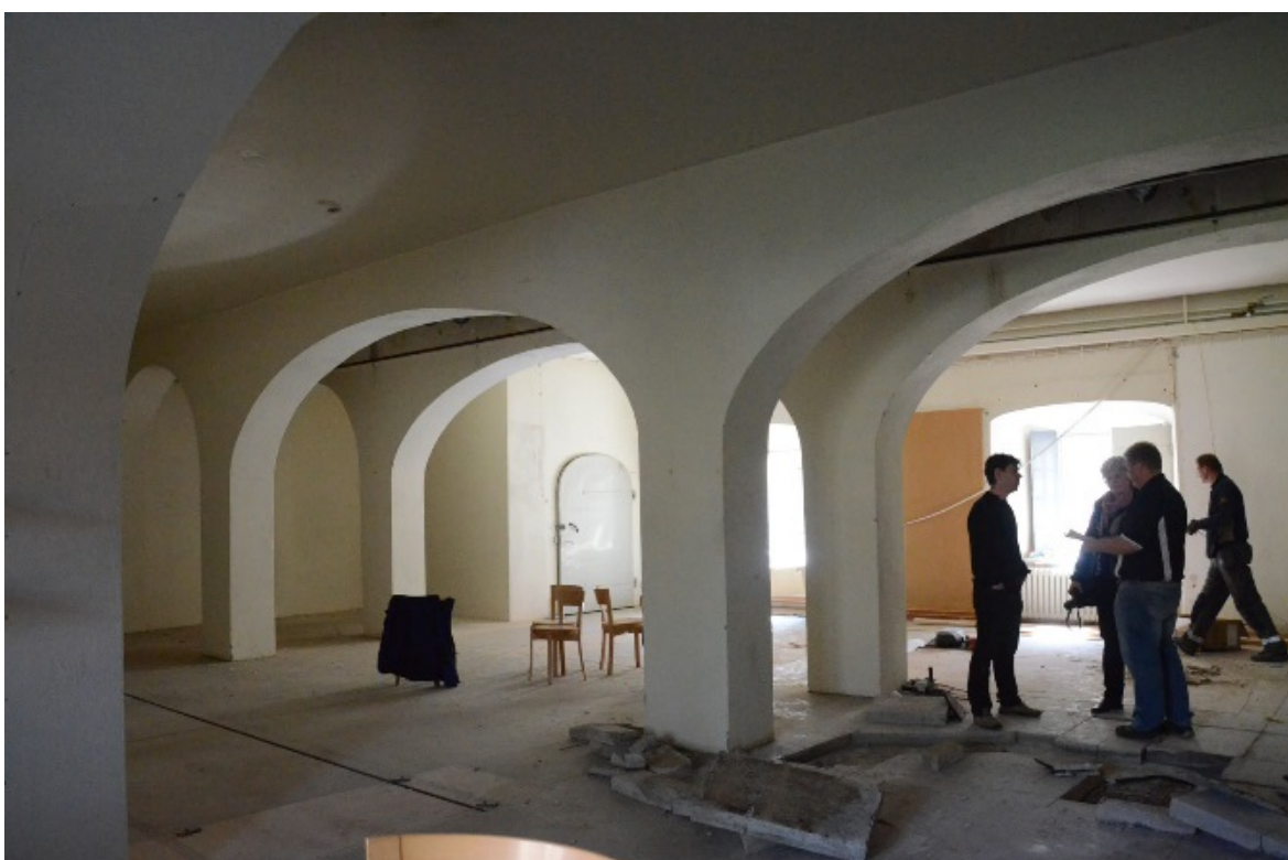
6-7. Rum 117 under rivningsarbetet.
