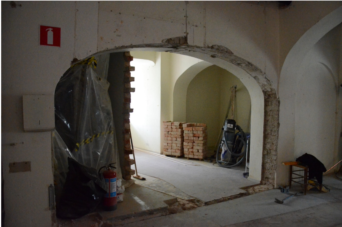
37. Efter rivning av väggen. Väggen rivs för att få mer dagsljus in i ett av kontorsrummen.
