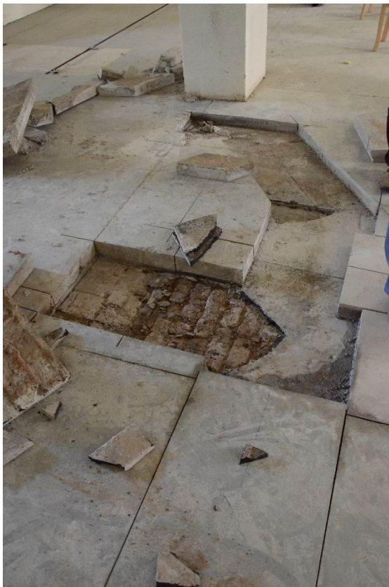
10-15. Ledningar från ovanvåningens toaletter frilades. Det gjutna golvet lyftes och under ligger ett äldre tegelgolv.
