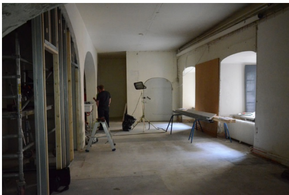
18–19. Nya väggar sätts upp i rum 017. De äldre elementen tas bort och ersätts med nya.
