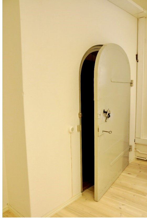
55 – 56. Från trapphuset i öst. Den äldre plåtdörren målades och fick nytt lås. Dörren ställs i uppställt läge ur utrymningssynpunkt.
