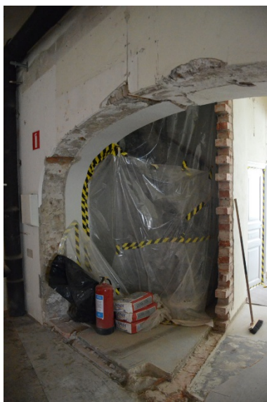
28-36. Rum 019 och 020 under ombyggnationen. Delar av väggen mot rum 017 rivs.
