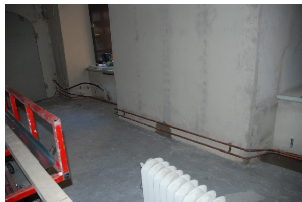
18–19. Nya väggar sätts upp i rum 017. De äldre elementen tas bort och ersätts med nya.
