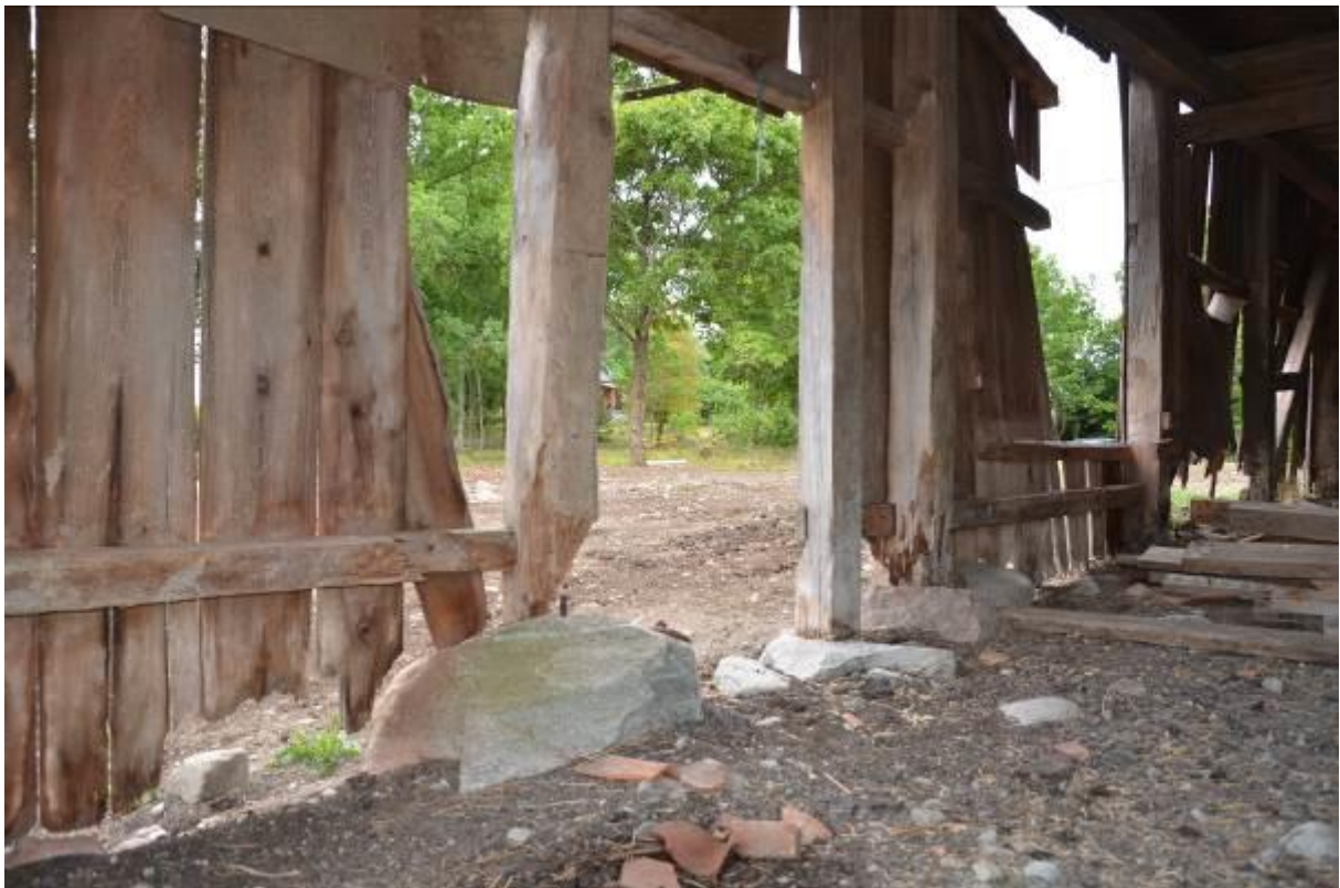
Vlm_kmvSB-782. Stolparna var i dåligt skick och många hade förlorat sin bärighet.
