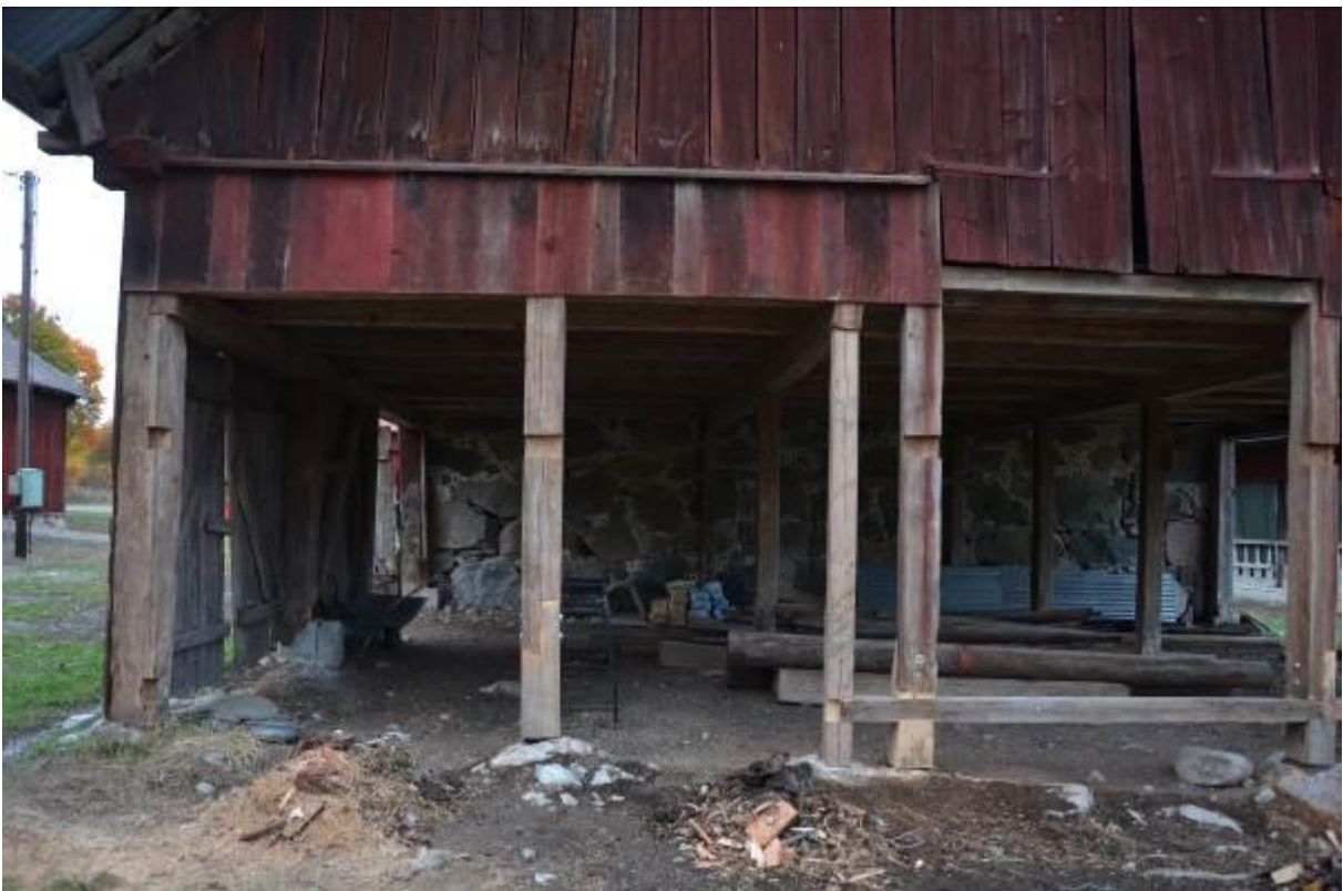
Vlm_kmvSB-1026 Stolpar efter åtgärder. Ladugårdens gavel syns i bakgrunden
