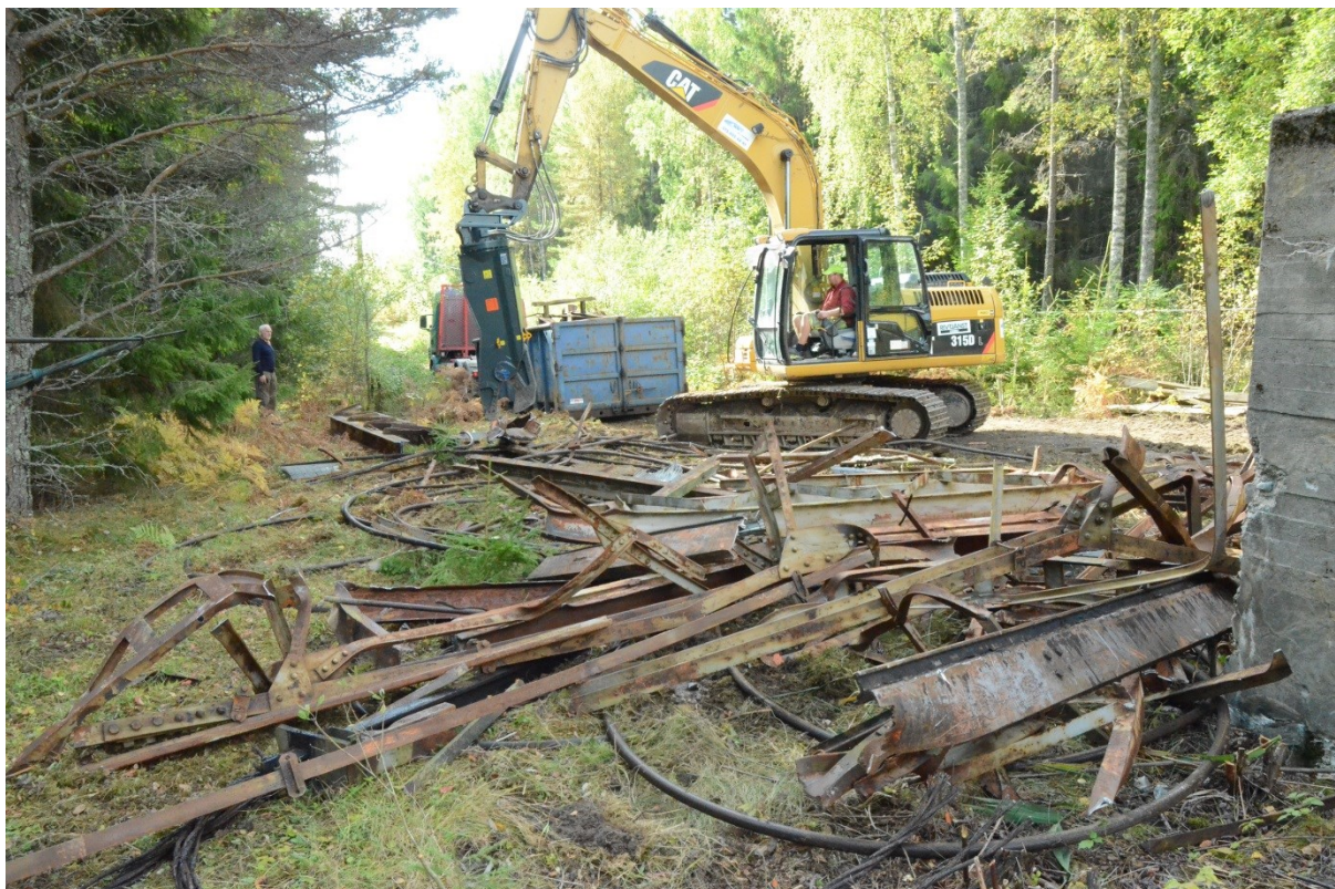
Rivningen av spännstationen var redan genomförd när dokumentationen ägde rum. Man höll på att plocka bort resterna. Foto: Vlm_kmvFE-3767
