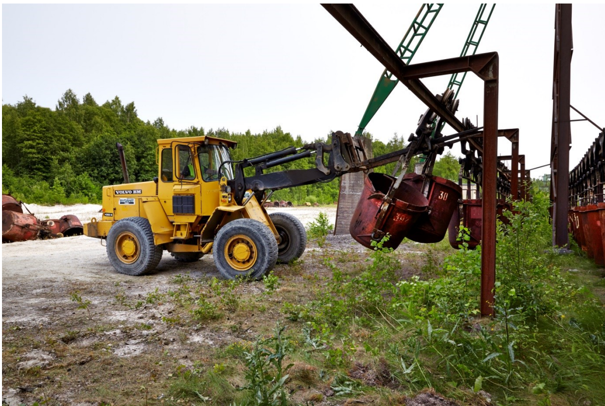
Korgarna lyftes av stålbanorna med en hjullastare och lades sedan på hög i väntan på vidare transport. Foto: Lasse Fredriksson
