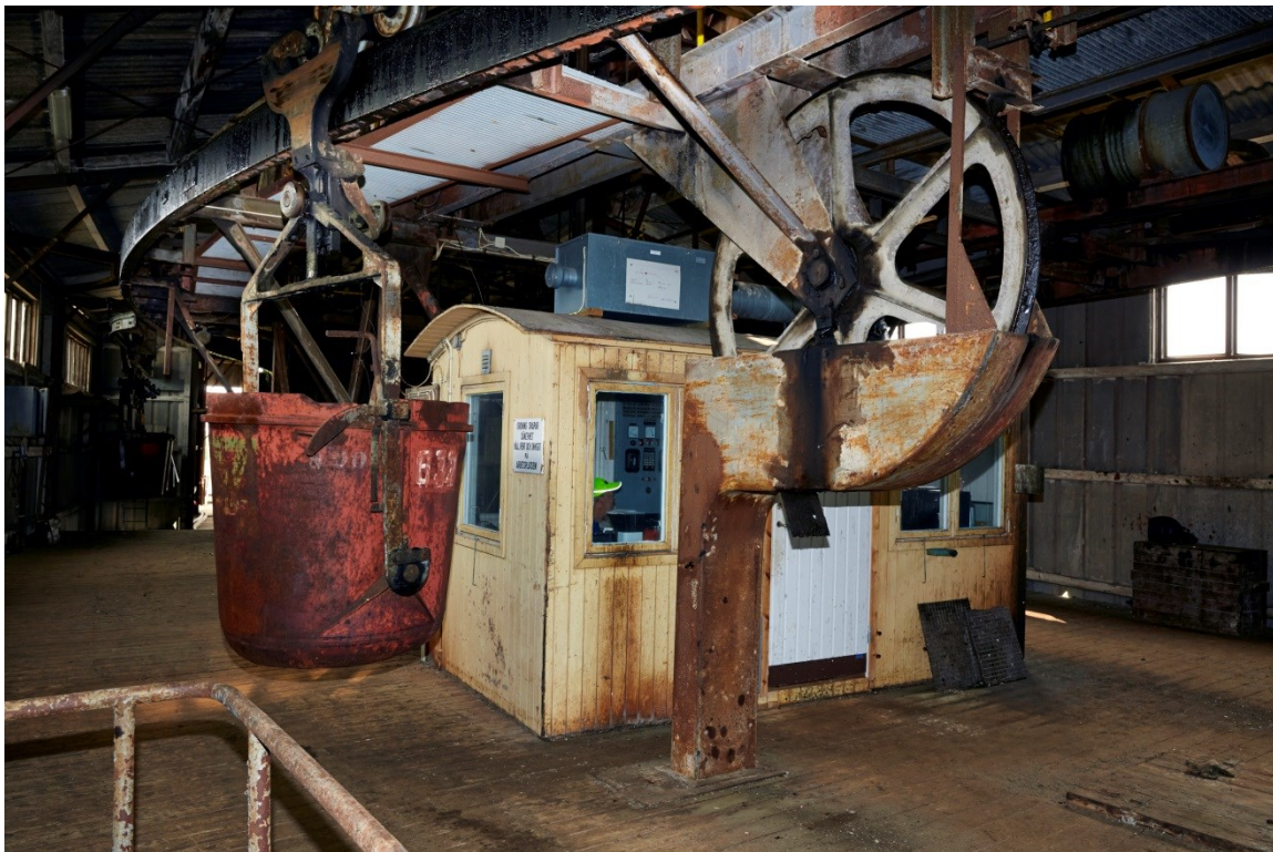
Interiör i stationen i Malmberga. Hytt för arbetare vid linbanestationen varifrån korgarna kan inspekteras. Foto: Lasse Fredriksson
