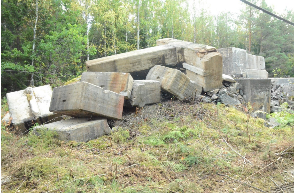
Rester av betongkonstruktion vid spännstationen. Vlm_kmvFE-3775
