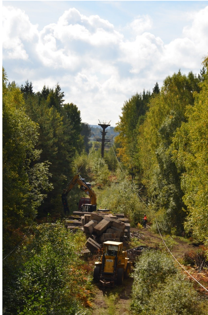
Utsikt från stolpe vid spännstationen under rivning och nedplockning av linor. Vlm_kmvFE-3798
