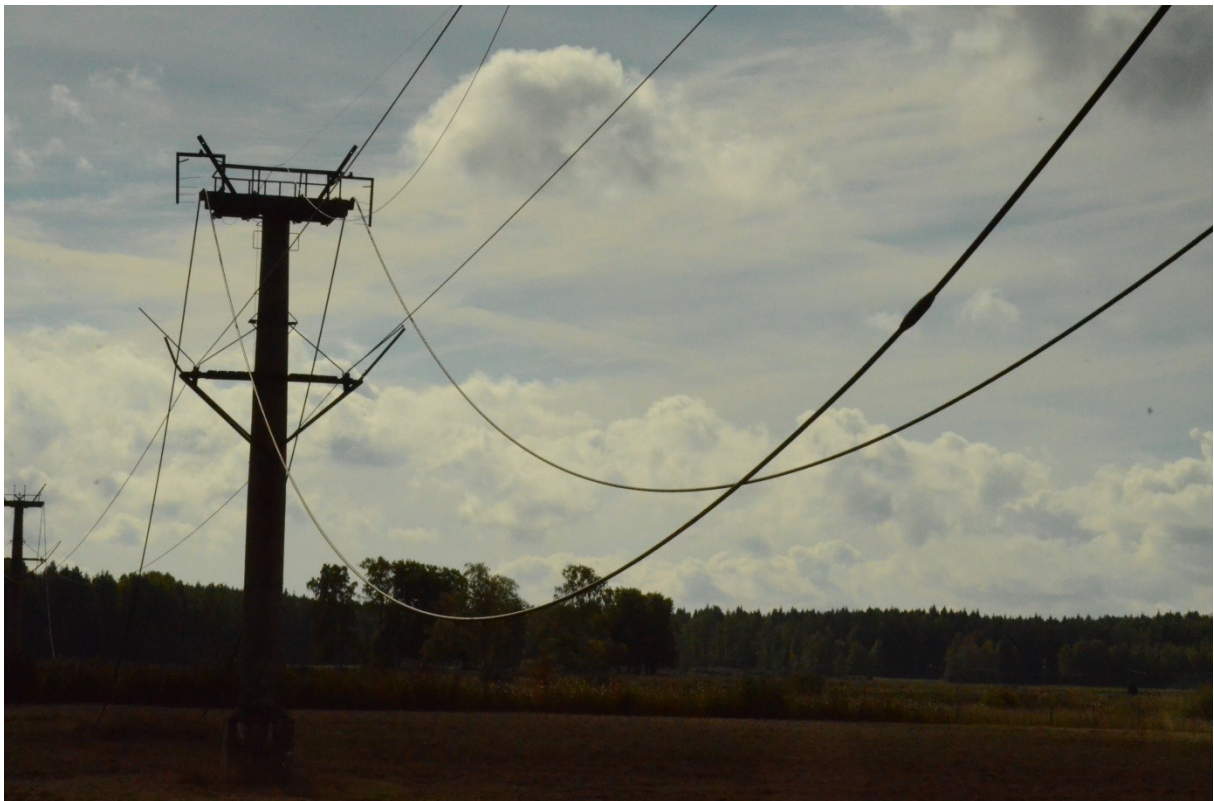
Linorna hängde ner längs stora delar av banan under nedplockningen. Bilden visar stolpar vid Malmberga spännstation. Vlm_kmvFE-3813
