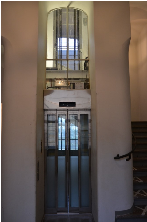
Bild 20, den nya hissen monterad
