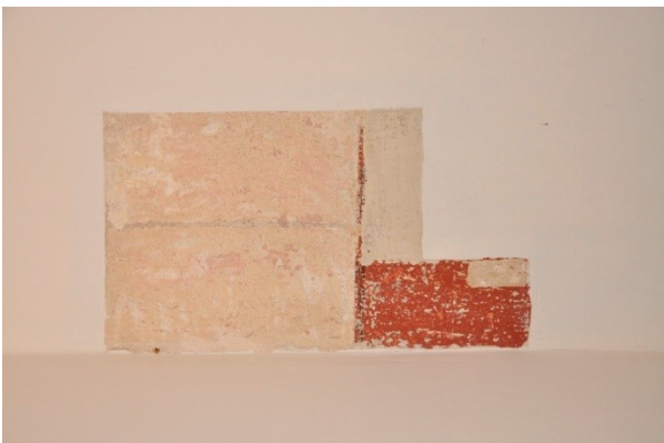
Bild 12, Äldre putslager och tegel framskrapat i schaktet
