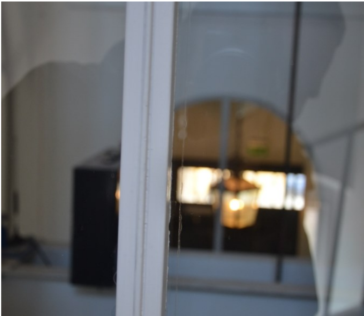
Bild 24, plastfilm monterad på glaset parti mot hisschaktet för att hindra fallskador
