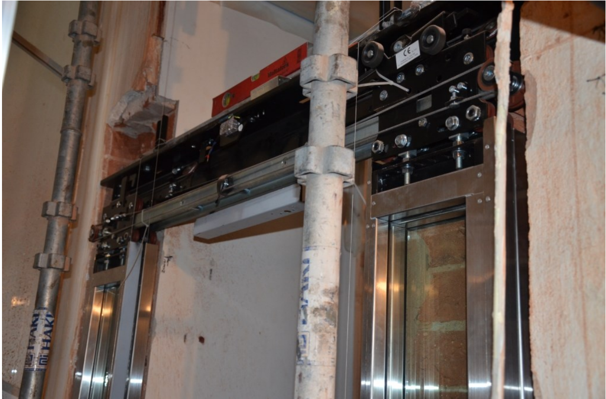
Bild 14, den nya hissdörrens montering i det ursäågade partiet i hisschaktet
