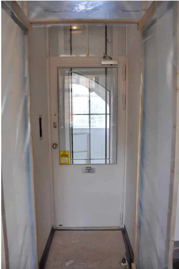
Bild 4, Befintlig dörr till 1940-talshissen
