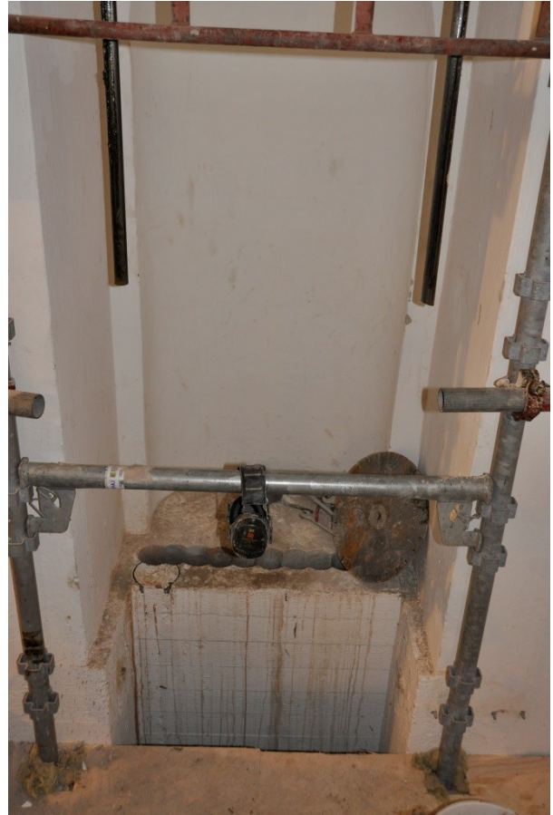
Bild 7, Under pågående borrhning
