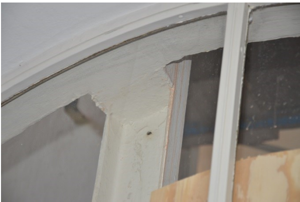
Bild 10, Gejdens utseende innan åtgärd
