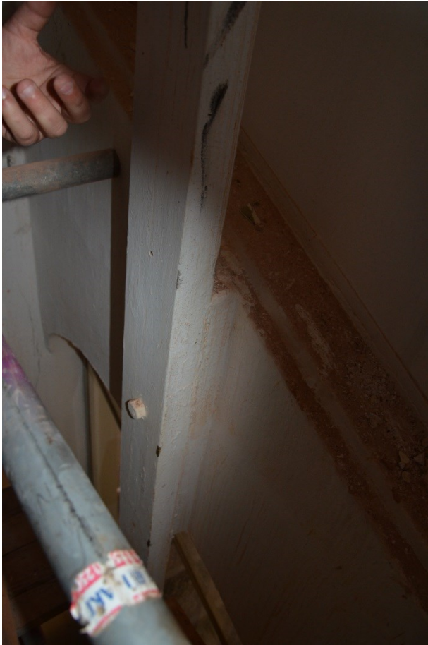
Bild 9, Gejderna satt för tätt för den nya hissen. För att inte ändra trapphusets uttryck där gejderna gick synligt längsmed ljusinsläppet, flyttades de ut och kapades mellan våningarna.
