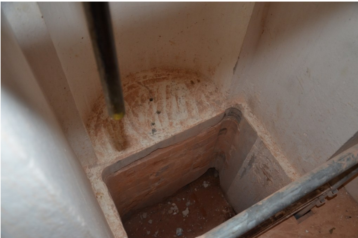
Bild 8, närbild på hyllan i hisschaktets botten efter borrhning och bortbilning.
