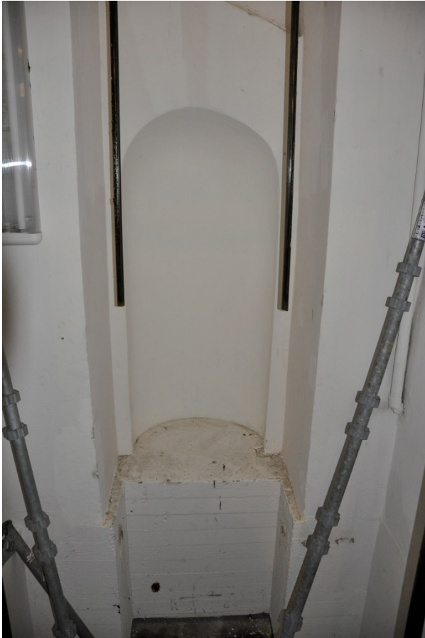
Bild 6, Hylla i hisschaktets botten innan borrhning
