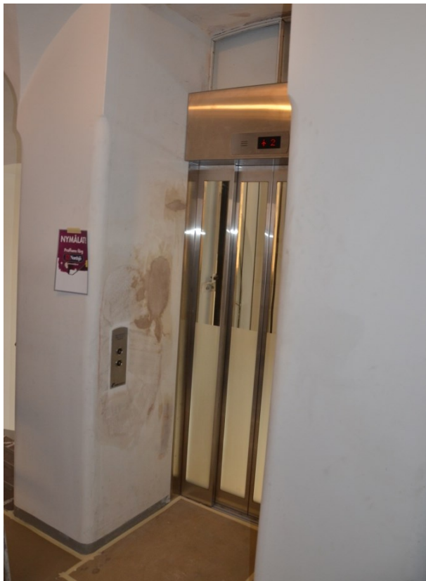
Bild 15, Nya knappsatser monterades och frästes in i putsen. Yterna putsades sedan igen och målades.
