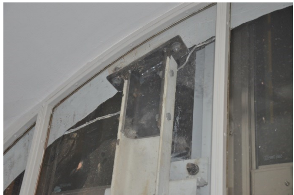
Bild 11, Gejdens utseende efter åtgärd
