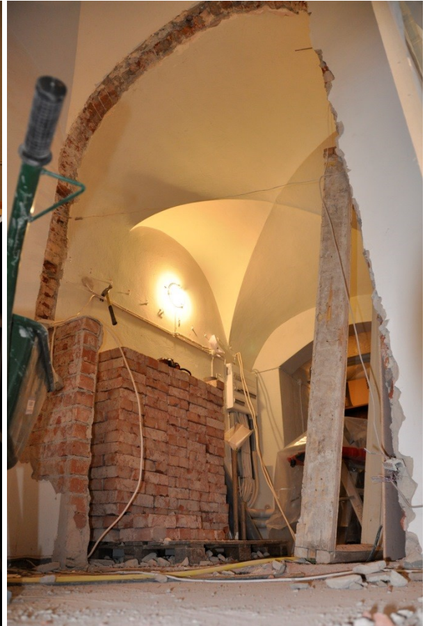
Bild 17, väggen mellan rum 022 och 023 under rivning
