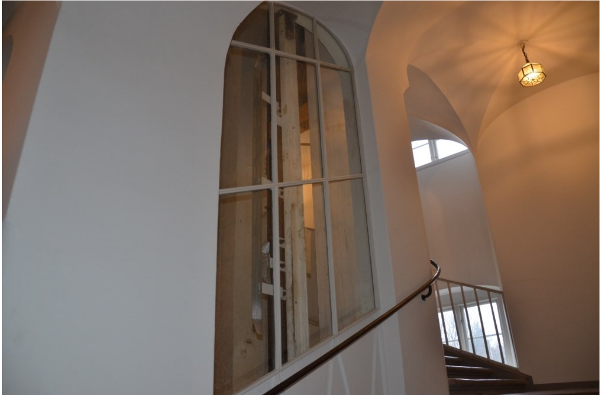
Bild 22, Gejdens utseende efter kapning och inmontering i fönsternischerna
