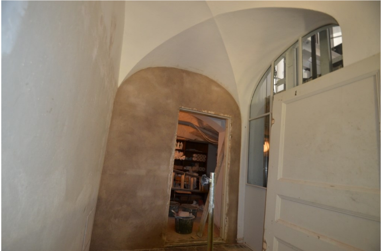
Bild 19, vägg mellan rum 022 och 023 flyttad och den tidigare igensatta ljusöppningen in mot hisschaktet rekonstruerad
