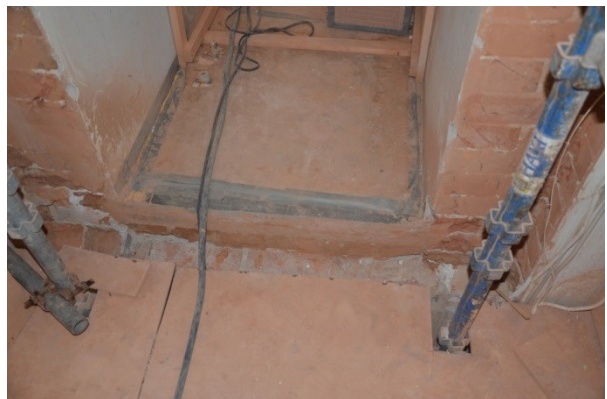
Bild 13, sågning genomförd för den större hissdörren
