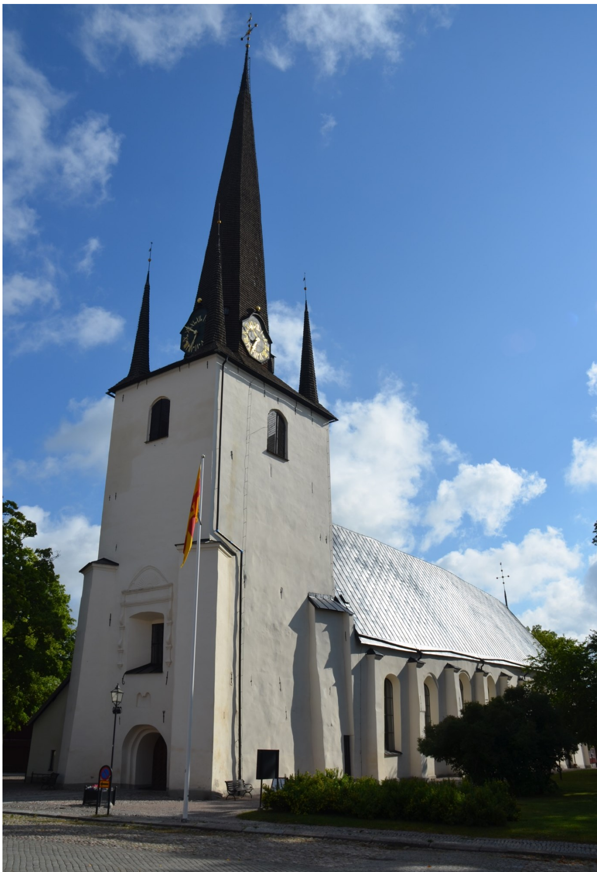
Heliga Trefaldighetskyrkan i Arboga efter genomförd målning av skeppstaket samt tjärstrykning av tornspiran. Vlm_kmvFE-3480.
