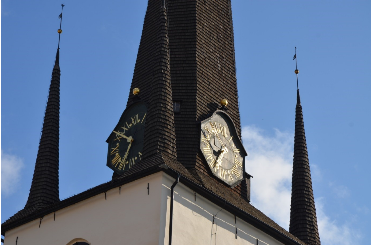
Tornspirans och fialerna efter tjärstrykning. Vlm_kmvFE-3481
