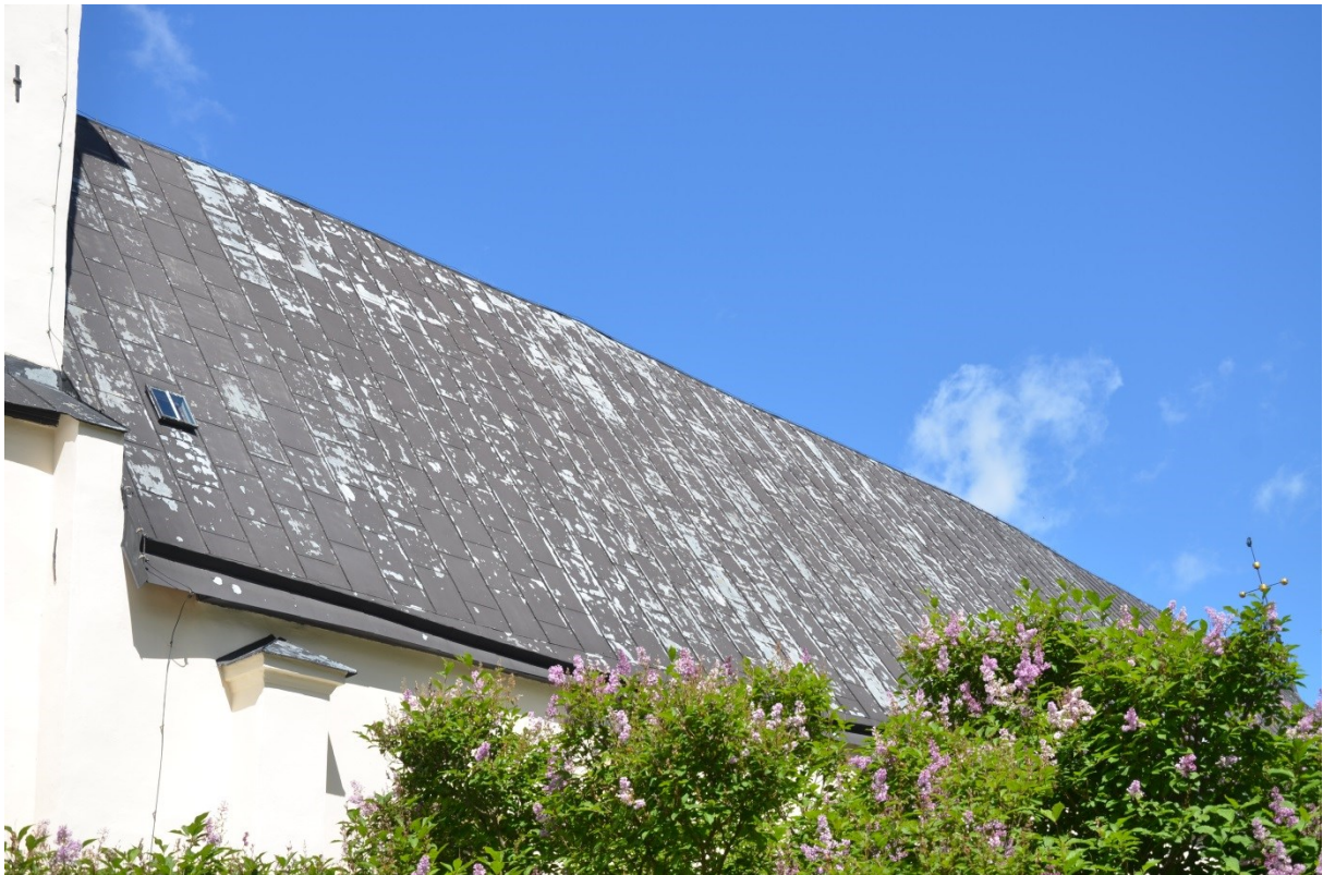
Plåttaket innan ommålning, färgflagor. Vlm_kmvFE-3099
