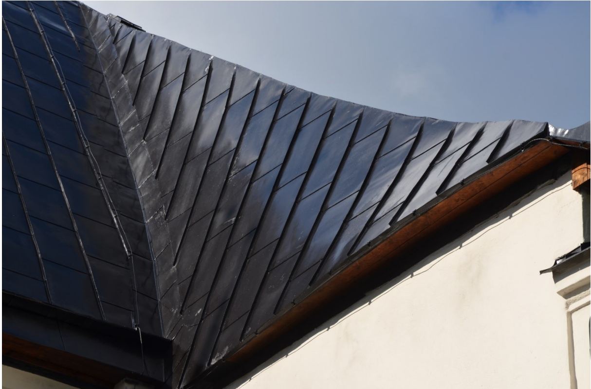
Plåttaket efter målning. Vlm_kmvFE-3476
