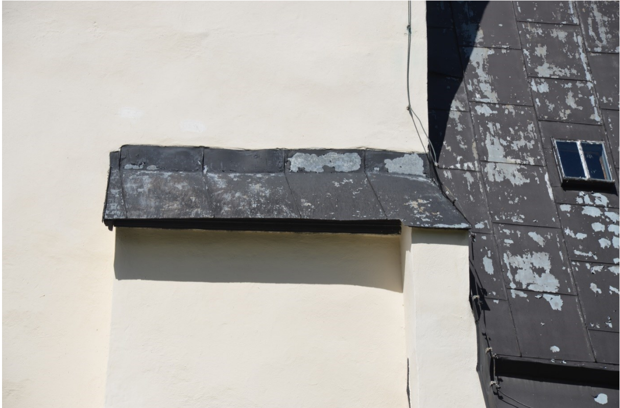
Färg flagade även på plåt som täckte strävpelare och solbänkar. Vlm_kmvFE-3102
