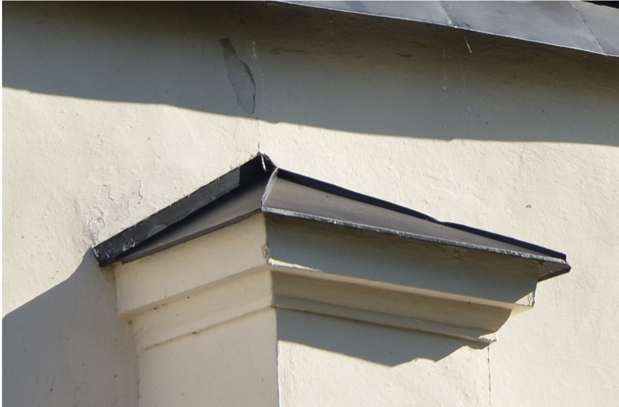
Skyddsplåt över strävpelare, nymålad. Vlm_kmvFE-3490
