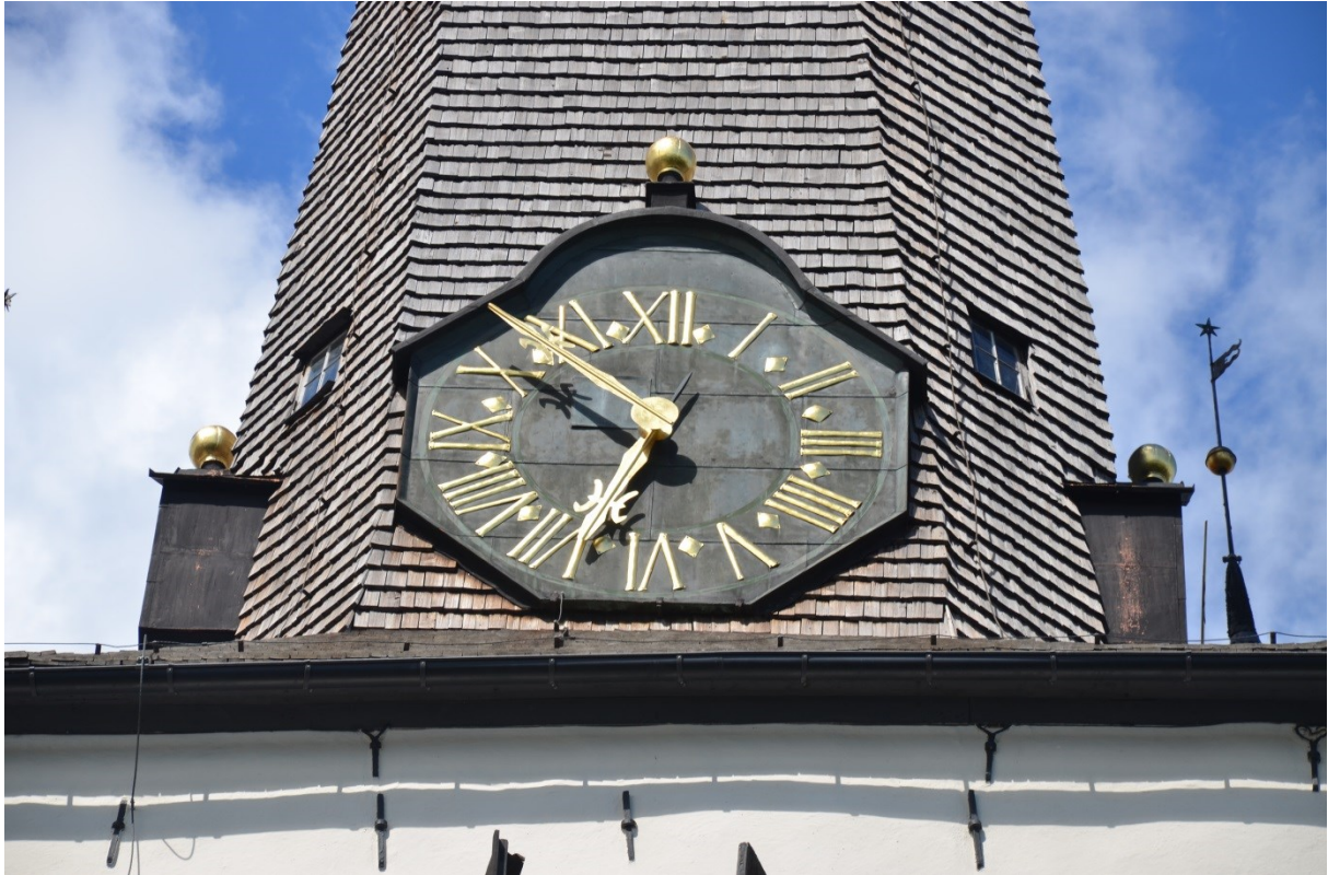
Tornspirans nedre del med klocktavlan, innan tjärstrykning. Vlm_kmvFE-3101
