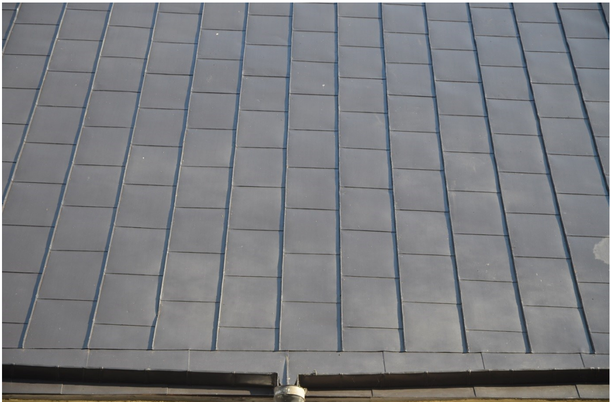
Plåttaket efter målning. Vlm_kmvFE-3469
