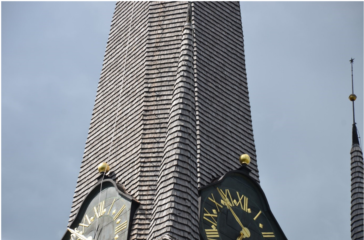
Tornspiran innan tjärstrykning. Vlm_kmvFE-3105
