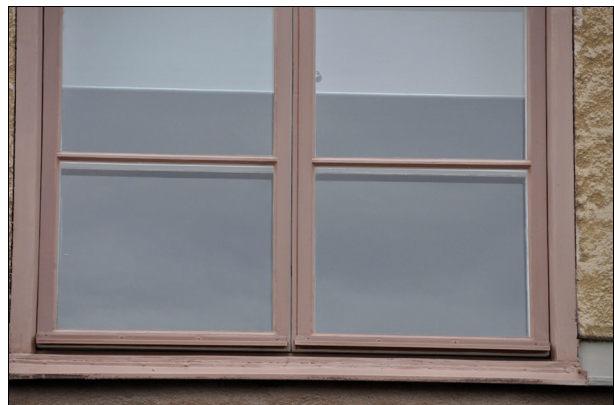
Bild 7: Nedre delen av ett fönster efter restaurering.
