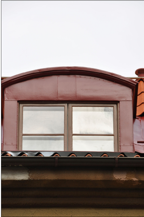
Bild 8: Restaurerat fönster på en av takkuporna.
