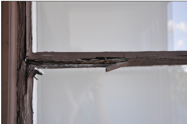
Bild 4: Ett fåtal rötskador förekom, här på en spröjs...
