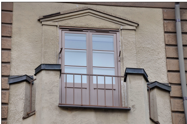
Bild 6: Byggnadens enda balkong mot gatan med restaurerad dörr.
