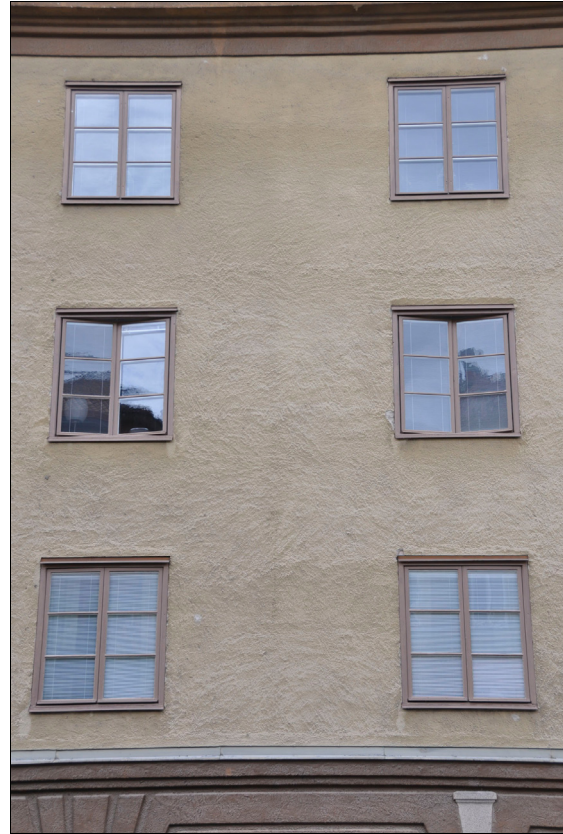
Bild 9: Detaljbild av fasaden efter fönsterrestaurering.
