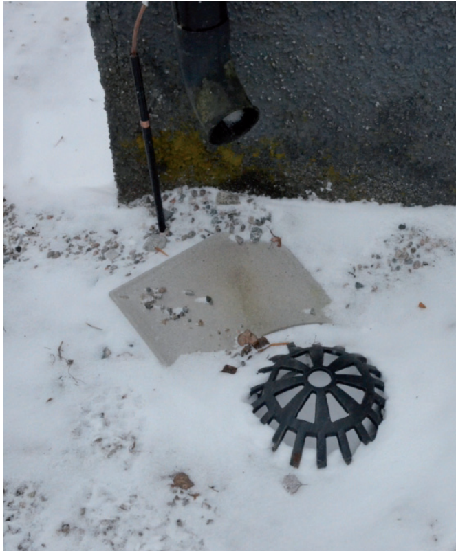
Nya brunnslock och fasad sten efter åtgärderna. Vlm_km-vFE-2314.
