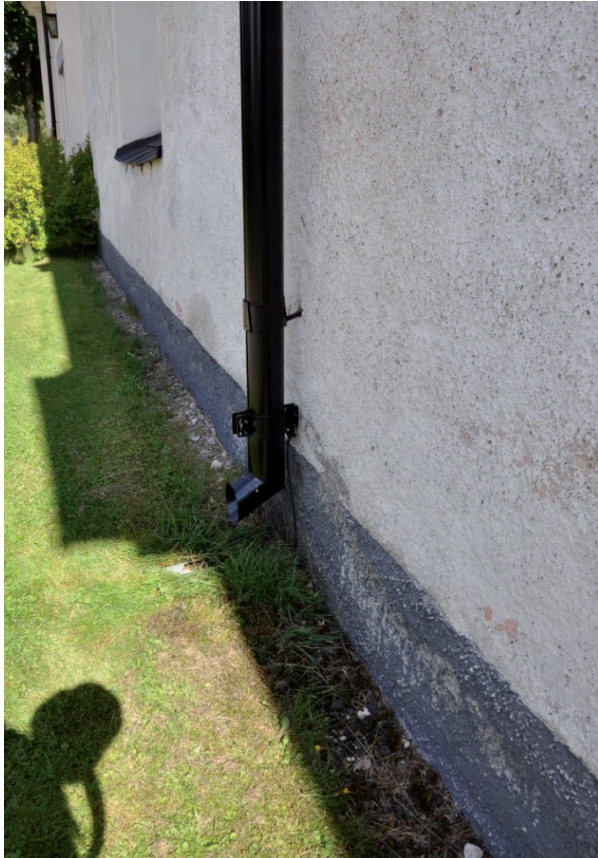
Stuprör och avrinning innan åtgärderna genomfördes. Vlm_kmvFE-1543.
