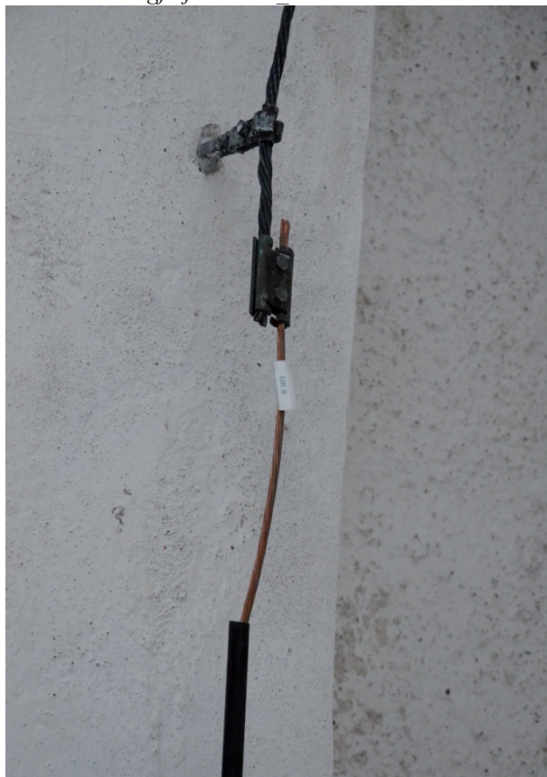
Åskledare kopplades ihop med nya anslutningar. Vlm_kmvFE-2317.
