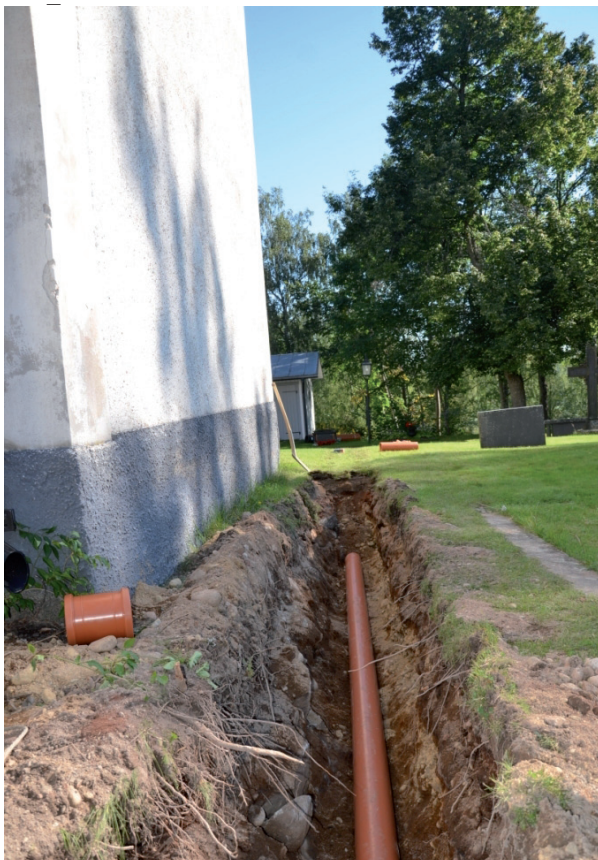
Schaktning och nedläggning av nya rör utanför koret. Stengången plockades bort under tiden. Vlm_kmvFE-1617.
