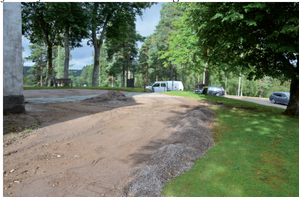
Schaktning slutförd utanför kyrkans torn, mot NV.
