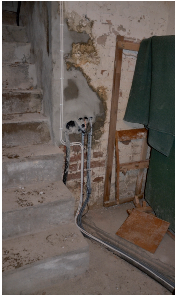
I sakristians källare drogs ledningarna genom befintliga kanaler. Skador i putsen och i muren som fanns innan åtgärderna reparerades. Vlm_kmvFE-2330
