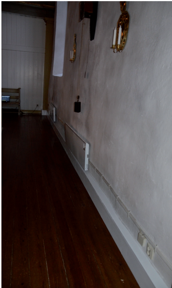
Lösningen blev istället att lägga ledningarna i en nytillverkad list som målades in i väggen kulör. I framtiden kan även andra ledningar placeras i listen och radiatorerna planeras att avlägnas. Vlm_kmvFE-2333.
