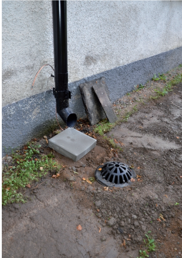
Stuprör och avrinning under arbetets gång. Nya brunnslock av gjutjärn. Vlm_kmvFE-1681
