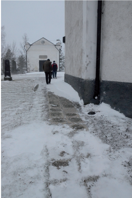
Foto mot SV vid kyrkans kor. Gång med stenplattor återställd efter schaktningsarbeten. Vlm_km-vFE-2319.
