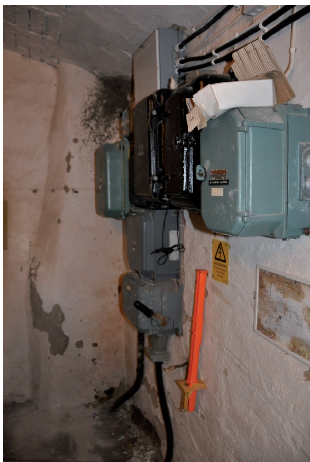
Sakristians elcentral innan nya ledningsdragningar. Den gråa putsen i takhörnet täcker hålet för befintlig dragnig. Putsen avlägsnades och nya ledningar drogs genom befintlig kanal. Vlm_kmvFE-1550.
