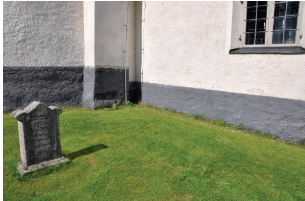
Kyrkans SÖ fasad innan åtgärderna. Gravarna låg tätt intill de planerade schakten. Vlm_kmvFE-1546.
