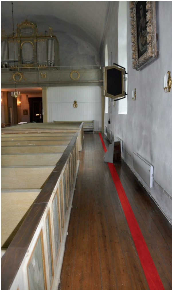
Ledningsdragningen från styrenheten diskuterades på plats. Ett alternativ var att lägga ledningar under golvet och därmed lyfta upp golvplank. Diskuterad ledningsdragning är markerad i rött. Vlm_kmvFE-1555.
