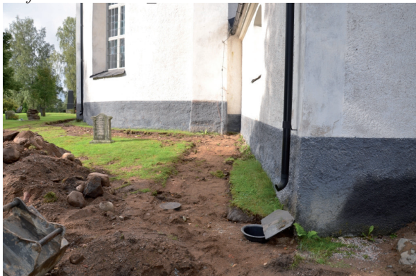
Schaktning vid kyrkans kor och sakristians källarvägg. Vlm_kmvFE-1686.
