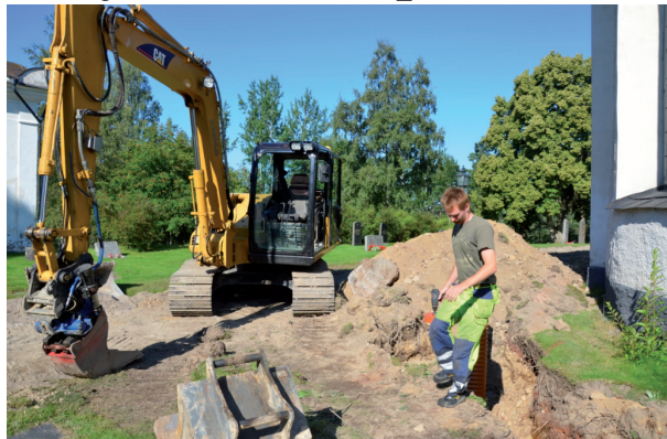
Schaktning vid kyrkans kor. Vlm_kmvFE-1618
