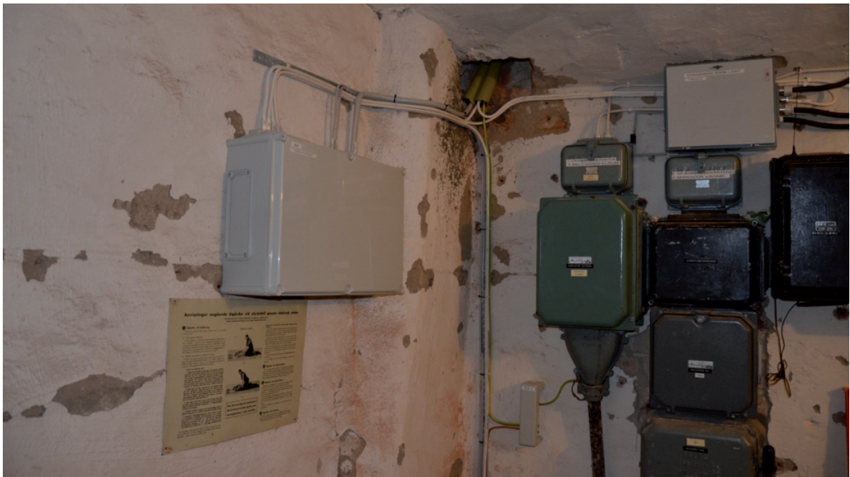
Sakristian källare efter att nya ledningsdragningar var färdigställda. Vlm_kmvFE-2332.
