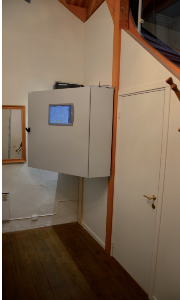
Personlutrymmet efter montering av styrenhet. Vlm_ kmvFE-2360.
