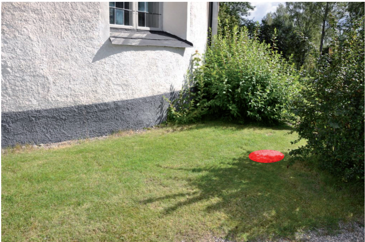
Bild tagen vid kyrkans kor mot NO innan arbete. Ungefärlig placering av nya jordplåtar är markerad med rött. Vlm_kmvFE-1545.
