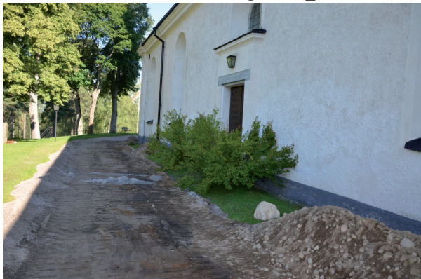
Kyrkans SV fasad under schaktning. Gruset i gången har banats av. Vlm_kmvFE-1613
