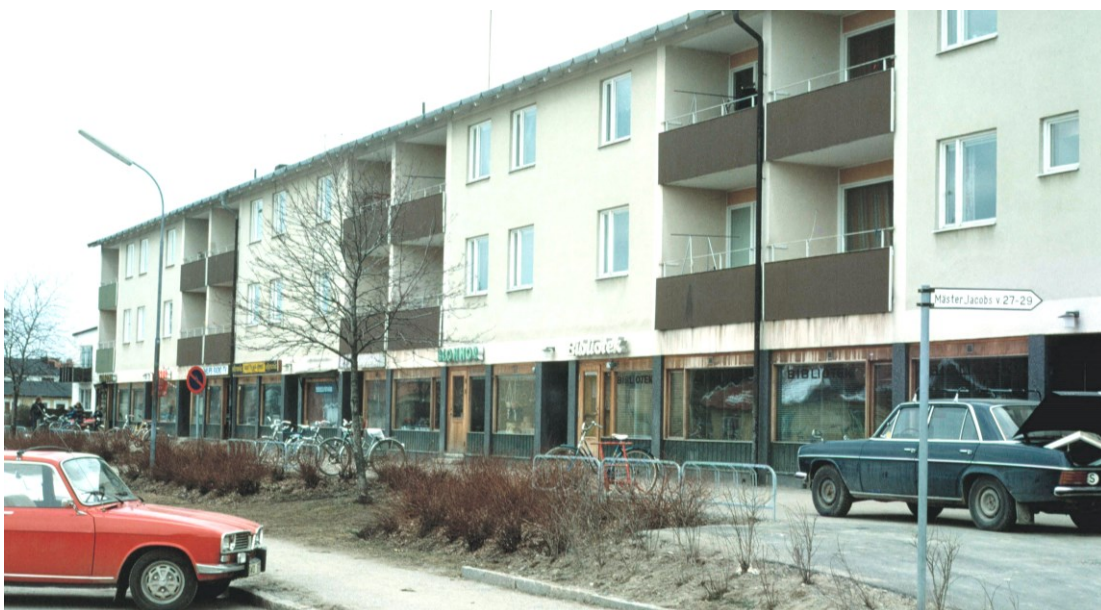
Flerbostadshus uppfört 1950-tal med affärslokaler i bottenplan. Källa: Västerås stadsarkiv
