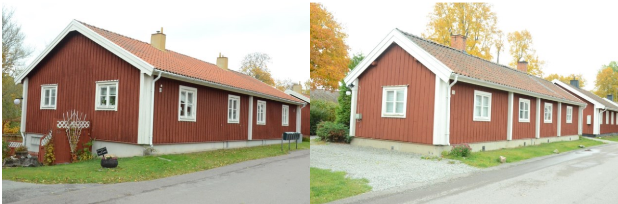
Bilden till vänster visar ett nybyggt hus på Bruksgatan. Bilden till höger visar ett av de bevarade husen från 1700-talet. Vlm_skuFE-138 och Vlm_skuFE-130.
