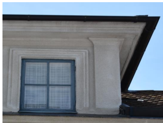
Bild 10. Bevarade enkelfönster på övervåningen. Vlm_kmvTL-211
