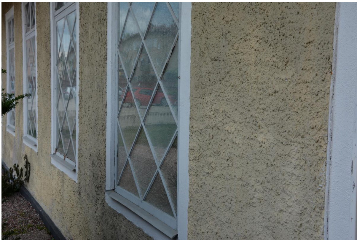
Bild 7. Fönstrens uttryck och byggnadsmaterialen är viktiga för det kulturhistoriska värdet. Vlm_kmvTL-203.
