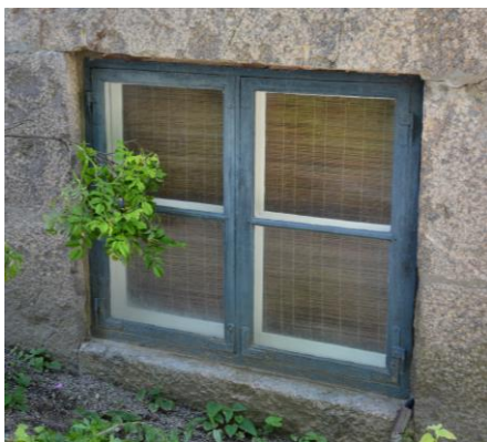
Bild 9. Bevarade enkelfönster i källarplan. Vlm_kmvTL-200
