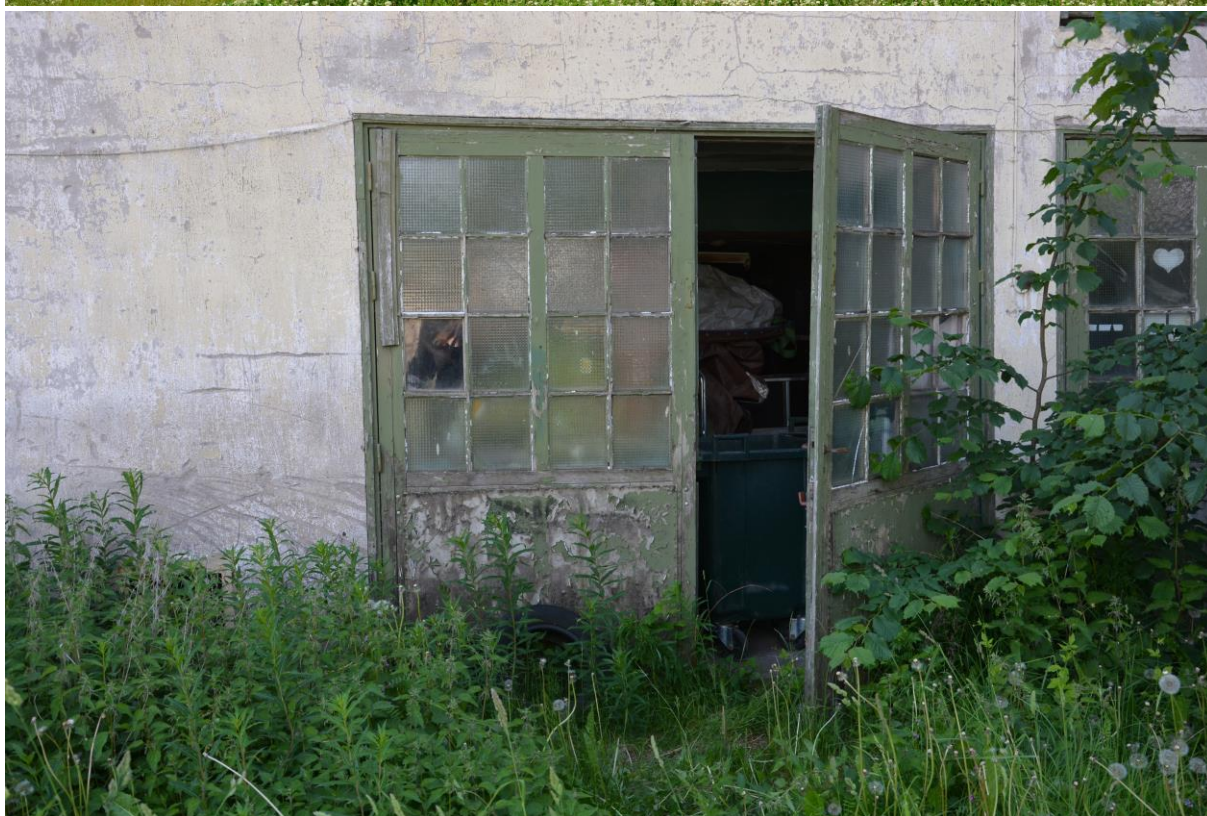
Bild 28. Överst. Lagerbyggnaden sedd från innergården. vlm-kmvek-906. Bild 29. Nederst. Dubbeldörr in till lagerbyggnaden. vlm-kmvek-1378.
