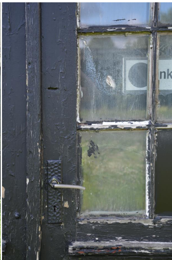
Bild 38. Ovan t.h. Detalj av port och ursprungligt nyckellås som har målats över med svart färg vid ett senare tillfälle. vlm-kmvek-917.
