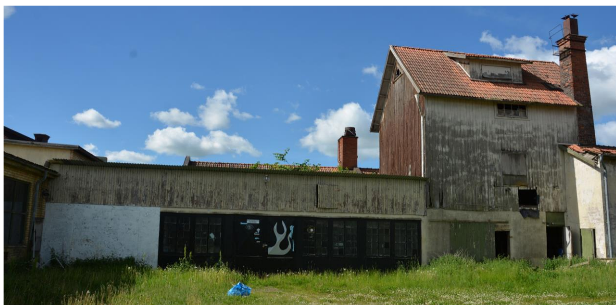
Bild 36. Lagerlokal. Den lägre byggnaden till vänster i bild. Sedd från innergården. vlm-kmvek-908.
