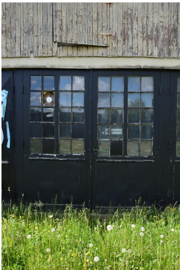
Bild 37. Ovan t.v. Port in till lagerlokal. vlm-kmvek-915.
