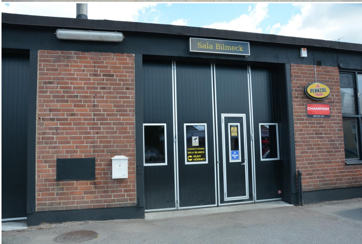
Bild 68. Överst. Verkstads hallen sedd från Norrbygatan. vlm-kmvek-1170. Bild 69. Nederst. Verkstads hallens nyinstallerade portar. vlm-kmvek-1172.
