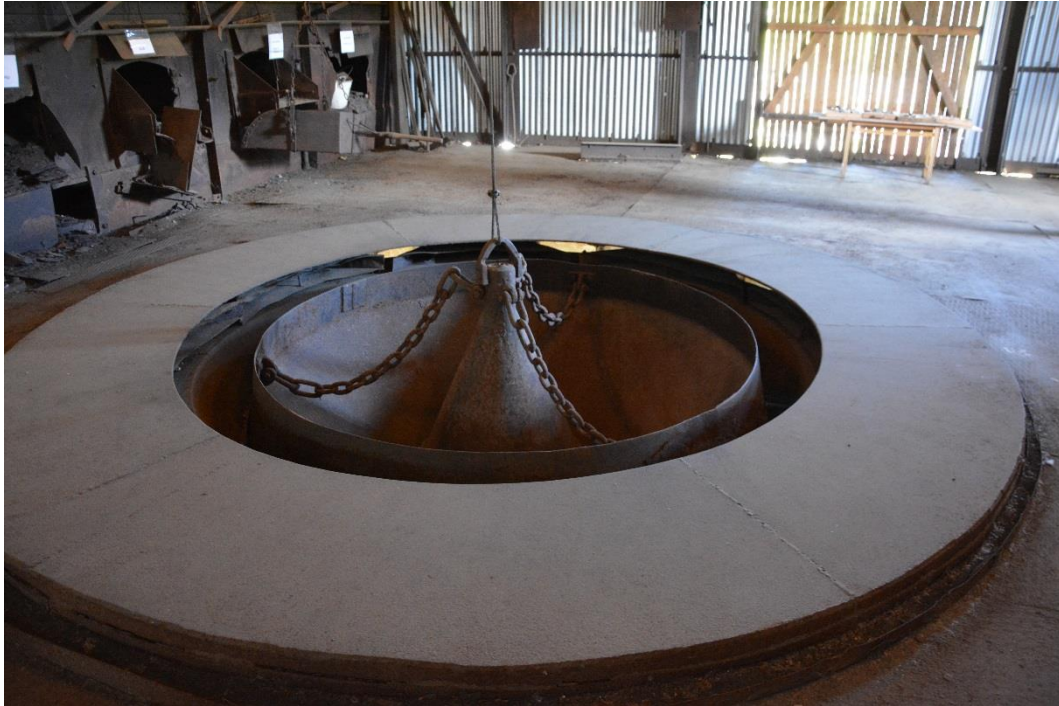
Masugnspipan öppning i kransvåningen.
