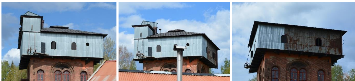
Kransvåningens södra fasader. På mittersta bilden syns ventilationshus och skorsten. Till höger syns den äldre fasadplåten.
