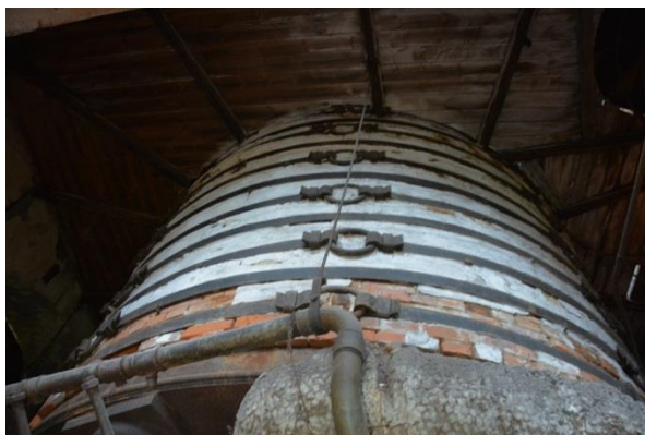
Masugnspipans nedre del där stor del av putsen återstår samt dragjärn i gott skick utan korrosionsskador.
