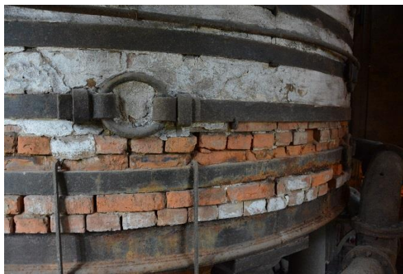
Masugnspipans nedre del där stor del av putsen återstår samt dragjärn i gott skick utan korrosionsskador.
