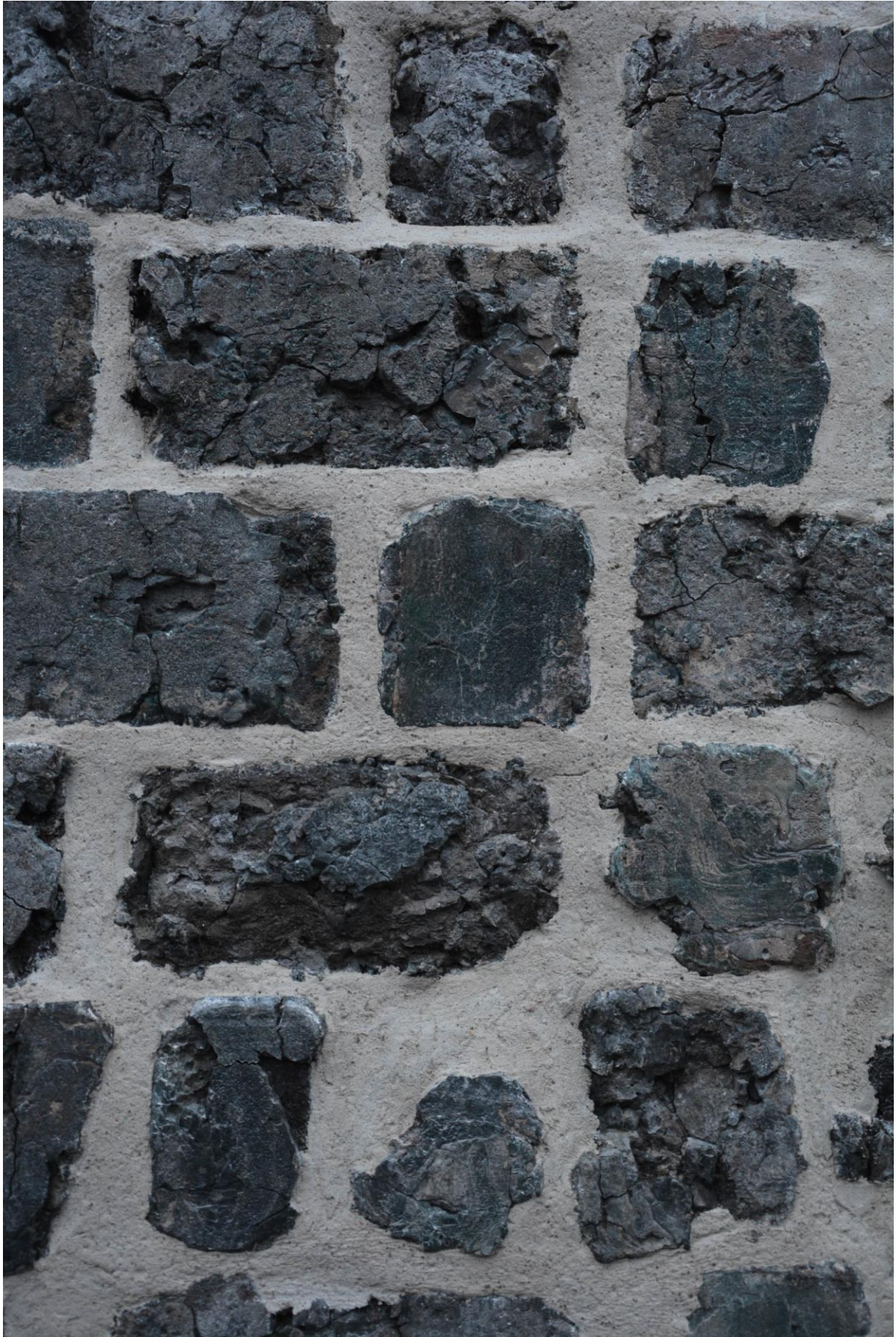
Detaljbild på färdigrestaurerad slaggstenspelare, foto taget i november 2020. Vlm-kmvek-2936.
