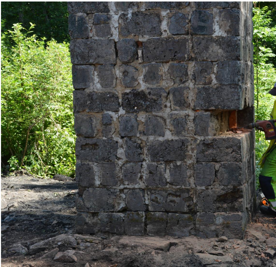
Rensning av fogar på pelare har inletts. Tegel i fogarna syns. Foto taget i början av juni 2018. Vlm-kmvek-2016.
