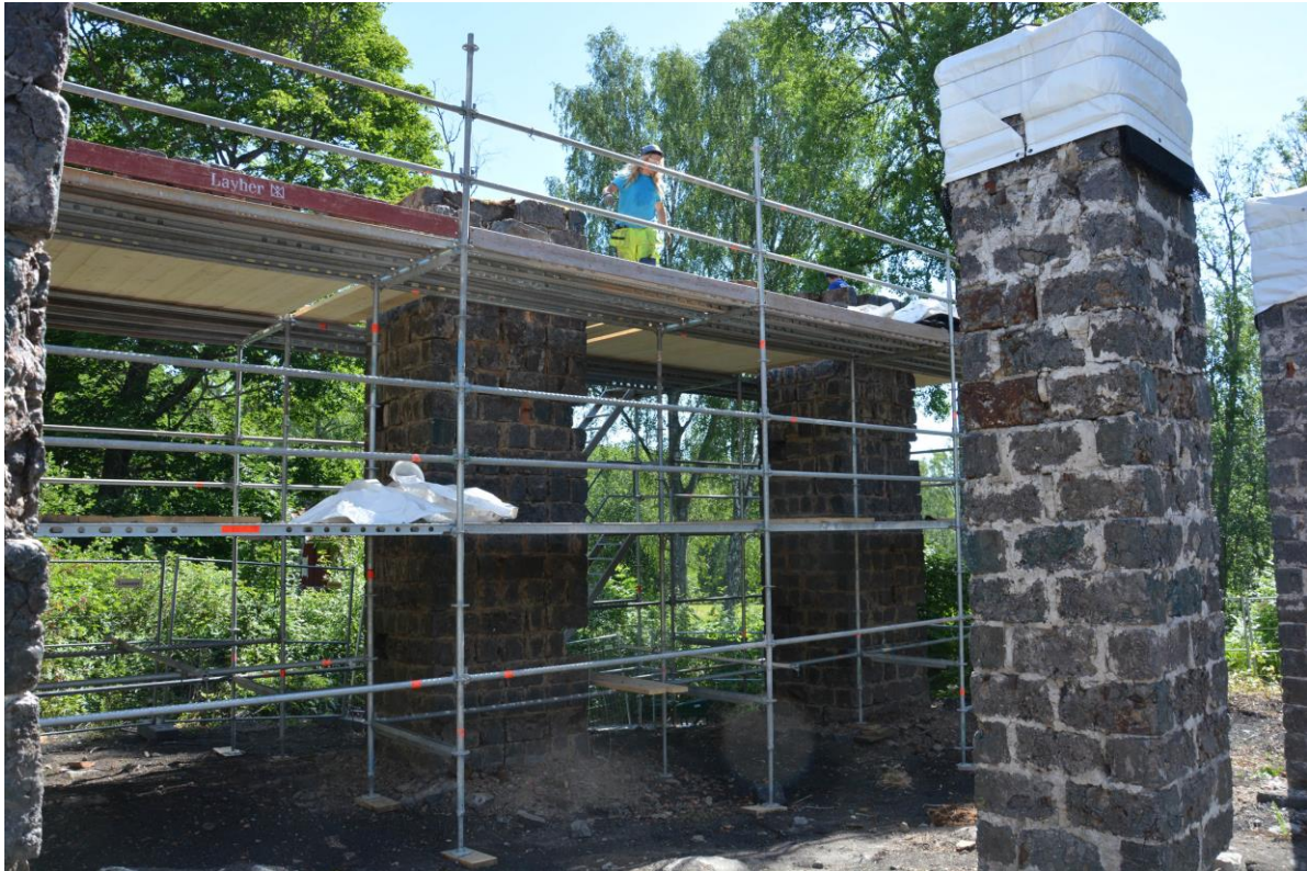
Stora byggnadsställningar har monterats för att kunna arbeta med tre pelare samtidigt. Arbete med rensning av fogar, foto taget i slutet av juni 2018. Vlm-kmvek-2032.
