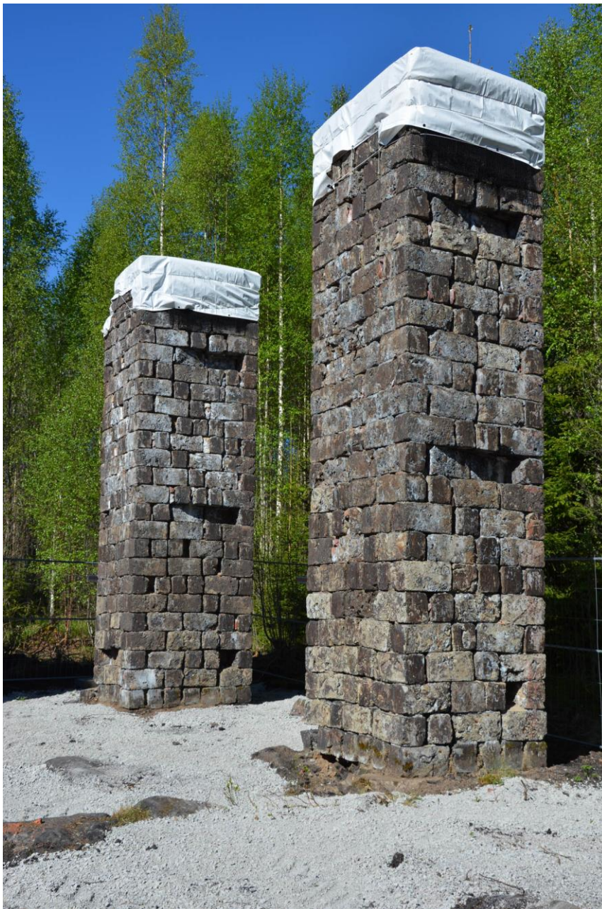
Två pelare innan restaureringsarbetet har inletts, fotograferat i maj 2016. Vlm-knvsb-4948.
