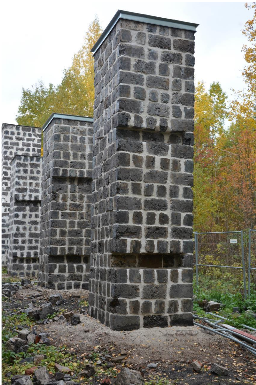
Färdigrestaurerade pelare 23 och 24. Notera topphuvar i avvikande utformning. Vlm-kmvek-2045.
