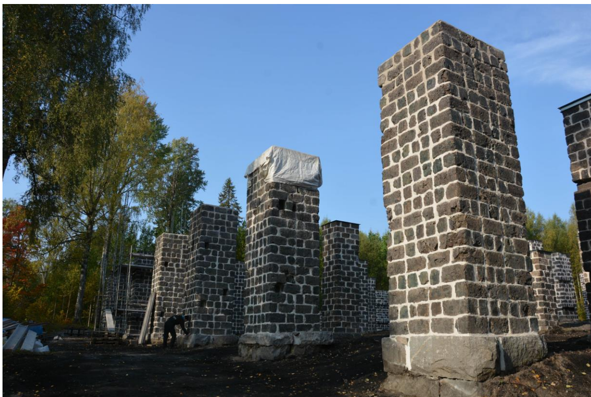
Slaggstenspelare inom etapp VII i princip färdigrestaurerade vid säsongens tredje byggmöte i slutet av september. Bland annat återstod topphuvar. Vlm-kmveb-0117.
