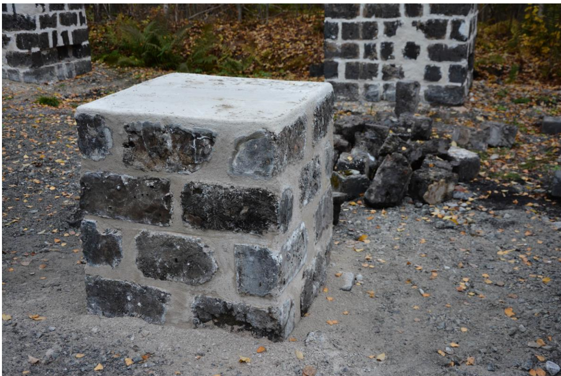
Nedrasad pelare som murades upp en meter och fick smeknamnet "Stubben". Vlm-kmvsb-5681.
