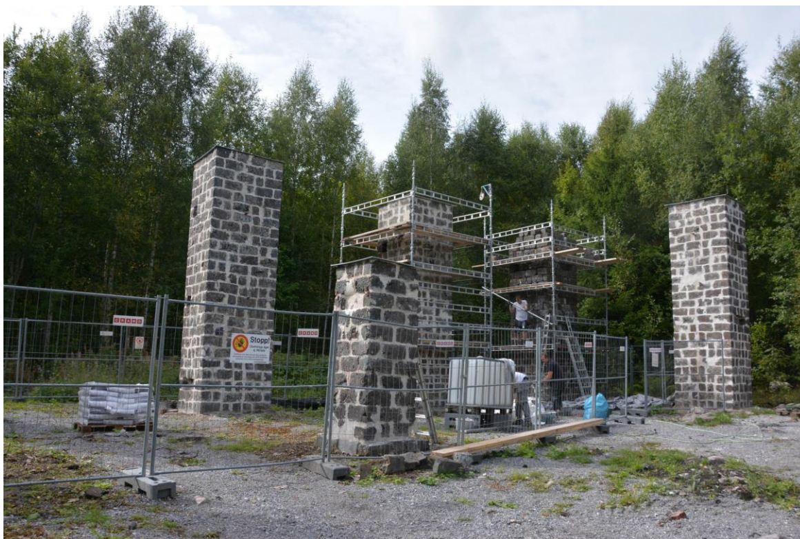
Restaureringsarbetet etapp II och III i full gång, fotograferat i slutet av augusti 2016. Vlm-kmvsb-5249.
