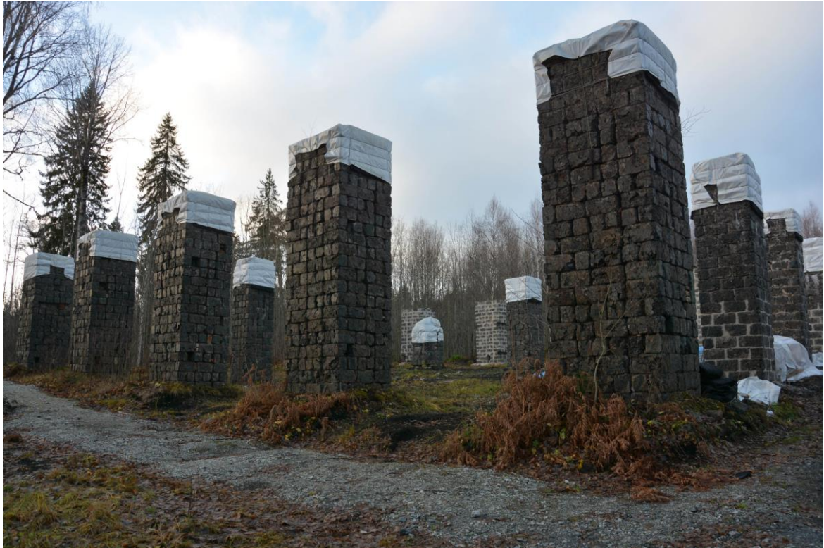
Pelare i den södra raden närmast i bild inom etapp VII innan restaureringsåtgärder. Fotot taget i november 2018. Vlm-kmvek-2096.
