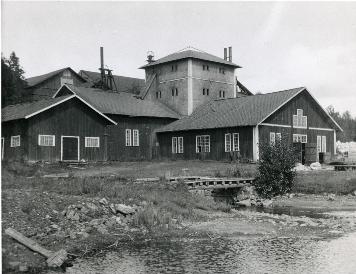
Trummelsbergs hytta avfotad 1904. Till vänster syns ångmaskinhuset. Byggnaden intill inhyste blåsmaskin, kvartskross, masugn och rostugn. I bakgrunden syns taknocken på kolskjutet och kolhuset. Fotograf okänd. Källa: Västmanlands läns museums arkiv, Vlm-E 6628.
