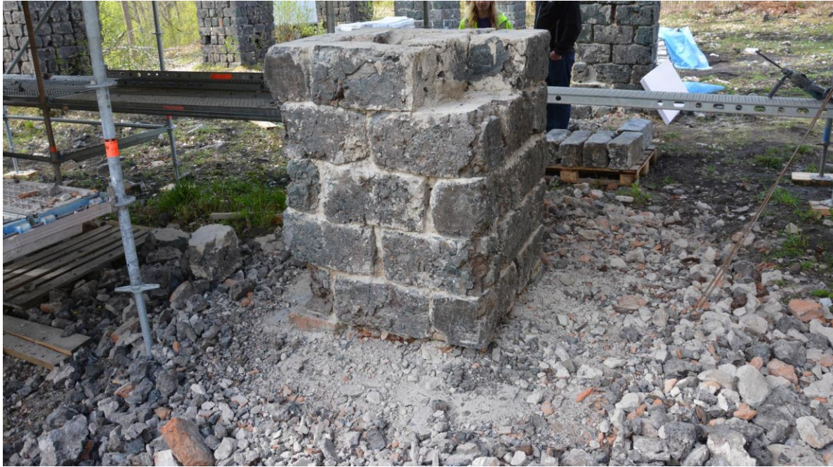
Nedrasad pelare med söndervittrat hörn nederst, fotograferat i början av maj 2019. Vlm-kmvehw-1887.
