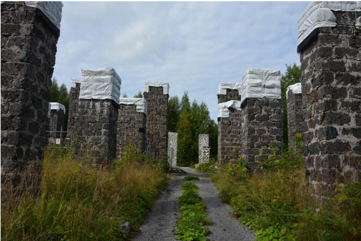
Skyddtäckta slaggstenspelare innan restaurering i förgrunden. Notera de söndervittrade fogarna. I fonden syns restaurerade pelare. Foto taget augusti 2016. Vlm-kmvsb-5248.
