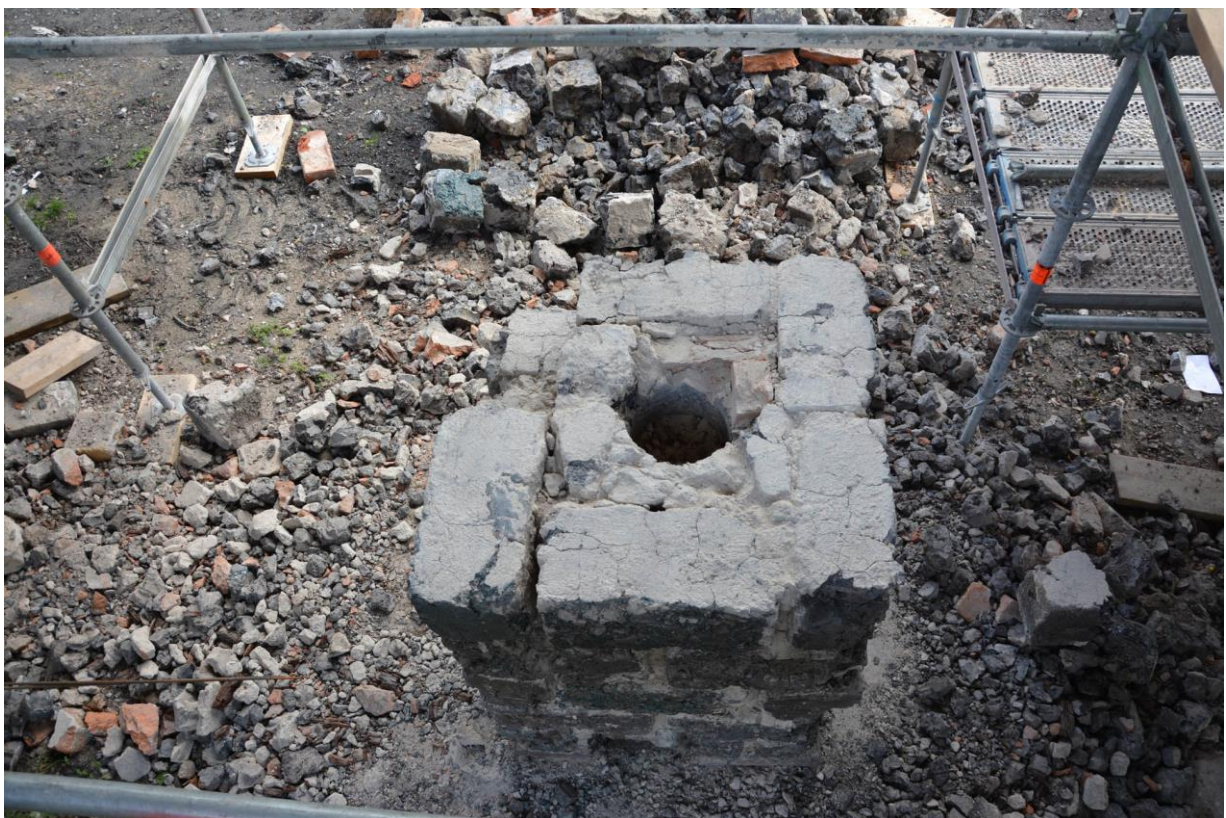
Slaggstenspelare med hål i mitten, fotograferat juni 2019. Vlm-kmvehw-1885.
