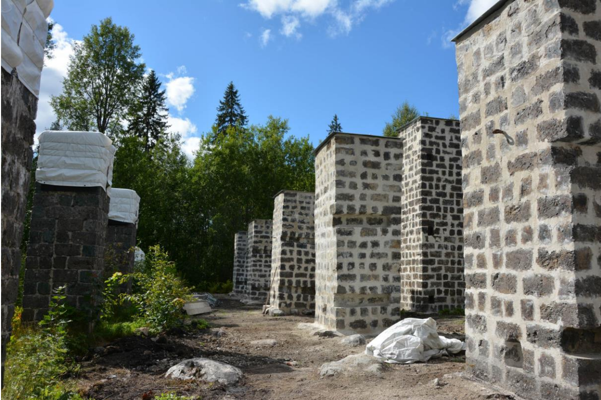
Ettapp IV:s pelare nästintill färdigrestaurerade, fotograferat i slutet av augusti 2017. Vlm-kmvsb-5963.
