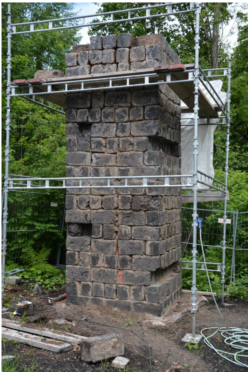
Byggnadsställningar kring pelare vid rensning av fogar och borttagning av stenar och skift som ska muras om eller lagas i. Vlm-kmvek-1611.
