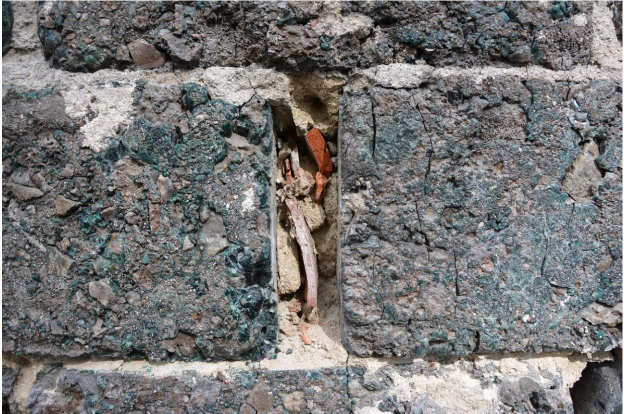
Detaljbild på slaggsten från pelare i Trummelsberg. Notera även tegel i fog. Foto taget maj 2019. Vlm-kmvehw-1881.
