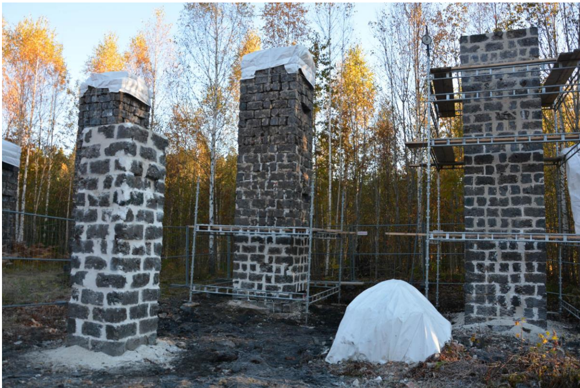
Slaggstenspelare under restaurering i oktober 2015. Vlm-kmvsb-4266.
