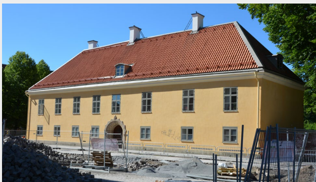
■ Biskopsgården i två våningar med de äldsta delarna från medeltiden. Byggnaden har slätputsade gula fasader och valmat sadeltak täckt av enkupigt tegel (Hagbard 4). Foto: Vlm-vasvb-0008.
