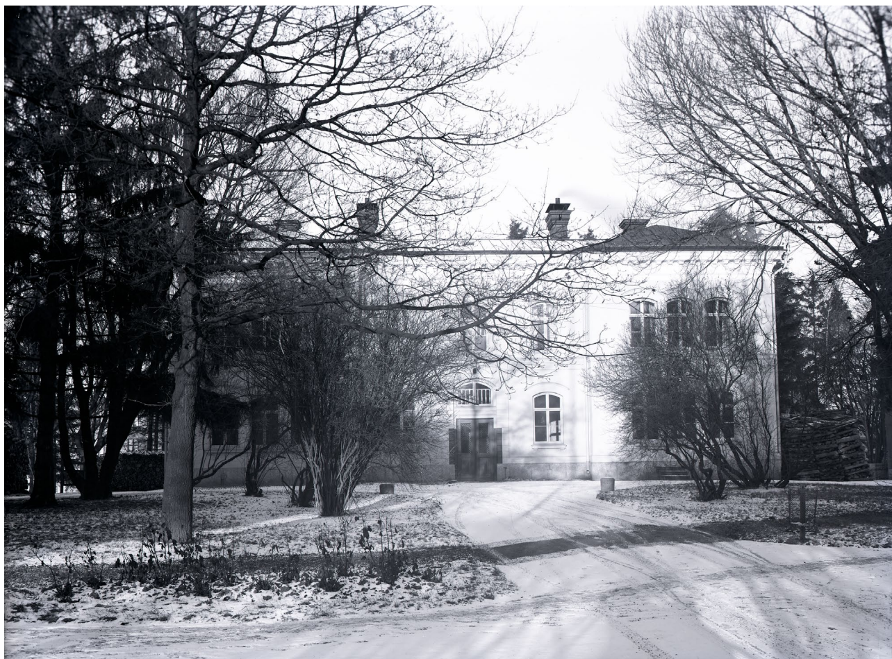
■ Den äldsta byggnaden tillhörande epidemisjukhuset som låg på Herrgärdet, idag riven. Byggnaden i två våningar med fasader i puts stod färdig 1887. Foto: Ernst Blom, Vlm-Blom 815.
