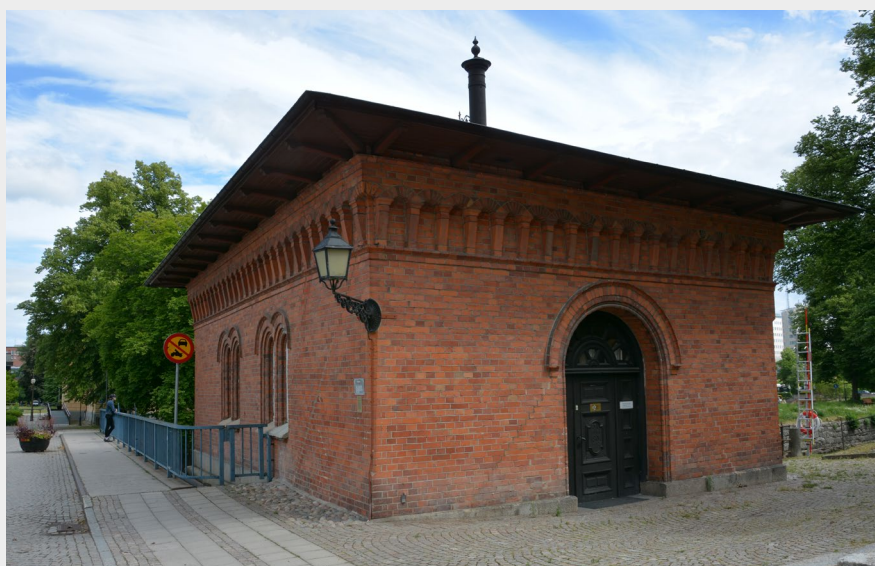
■ Turbinhuset från 1891 med vattenspegel och damm. Byggnaden har fasader i rött tegel, utskjutande takfot och plåttäckt tak (Västerås 1:230). Foto: Vlm-vasek-0938.
