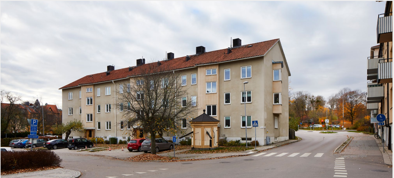
■ Flerbostadshus från 1945. Byggnaden har gråputsade fasader, utskjutande trapphus och tegeltäckt sadeltak (Naima 12). Foto: Lasse Fredriksson, Vlm-Fre-4159.
