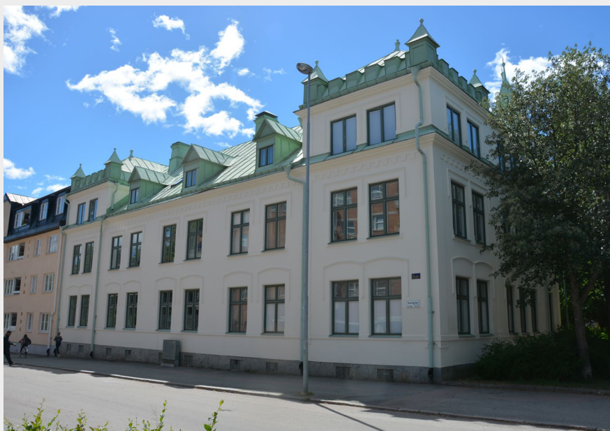
■ Bostadshus ritad av arkitekt Emil Bewfe i eklektisk stil och uppfört 1904. Byggnaden har ljus slätputsade fasader, dekorativa fönsteromfattningar och tornliknade byggnadsdel (Hugo 11). Foto: Vlm-vasek-0294.
