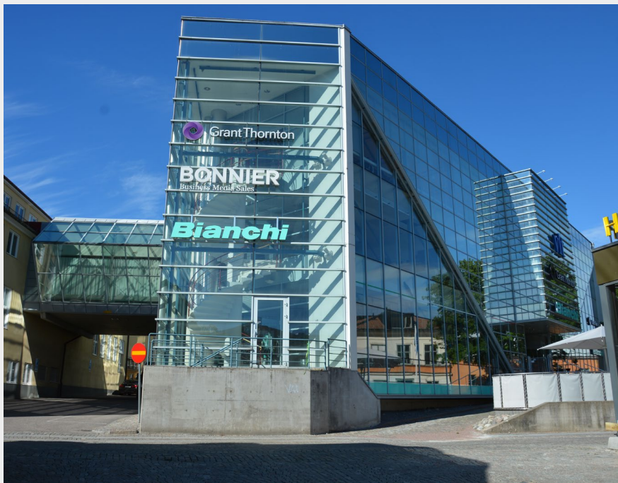
■ VLT-huset uppfört 1988-1990. Den nymodernistiska byggnaden har glasade fasader och stålstångskonstruktion (Livia 16). Foto: Vlm-vasek-1248.
