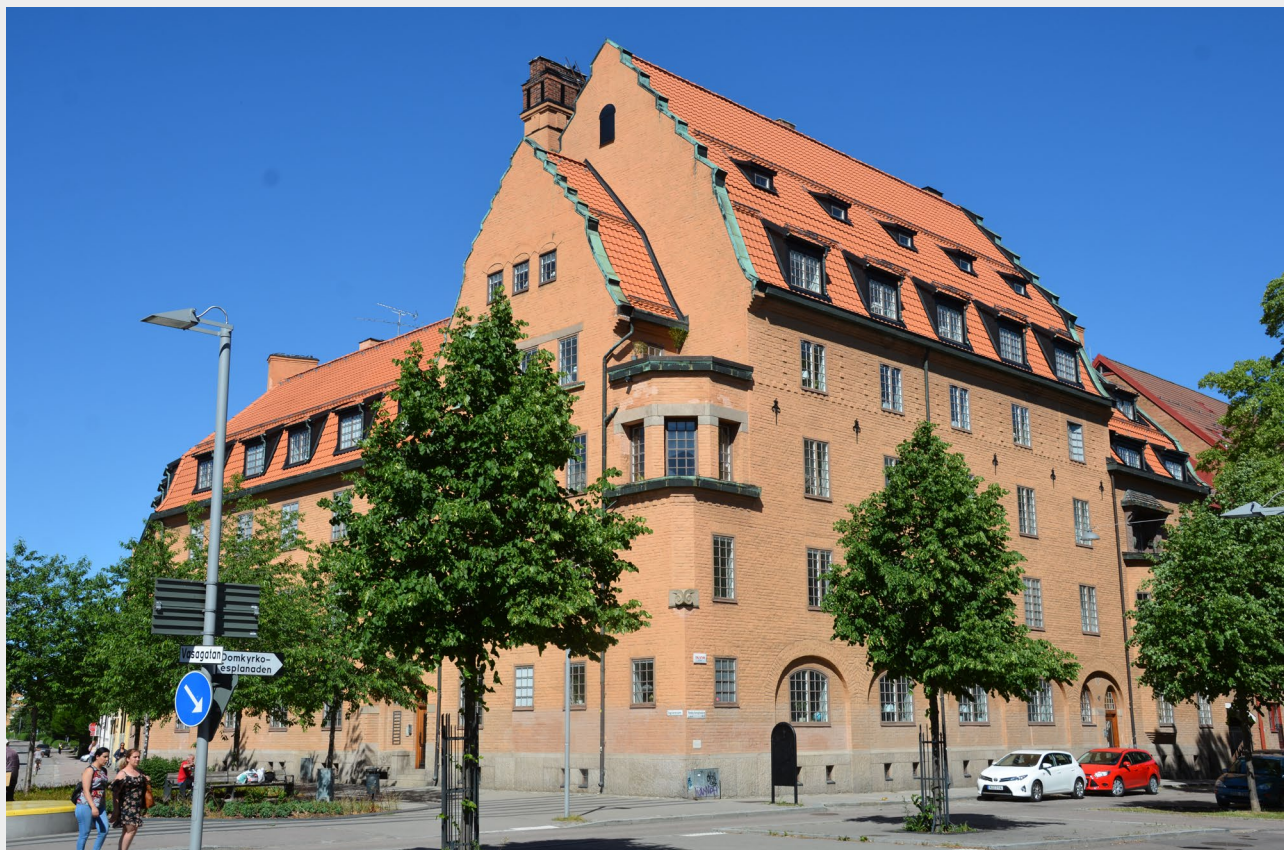
■ Hahr'ska huset, ritat 1913 av arkitekt Erik Hahr i nationalromantisk stil. Byggnaden har slammade tegelfasader, branta tegeltäckta sadeltaket, fönster med småspröjs och koppardetaljer (Henrik 6). Foto: Vlm-vasek-0195.
