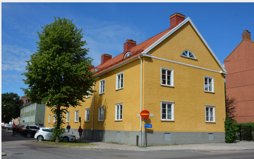
■ Bostadshus i två och en halv våning med gulputsad fasad, tandsnittsfris, lunettfönster och tegeltäckt sadeltak (Hubert 3). Foto: Vlm-vasek-0503.
