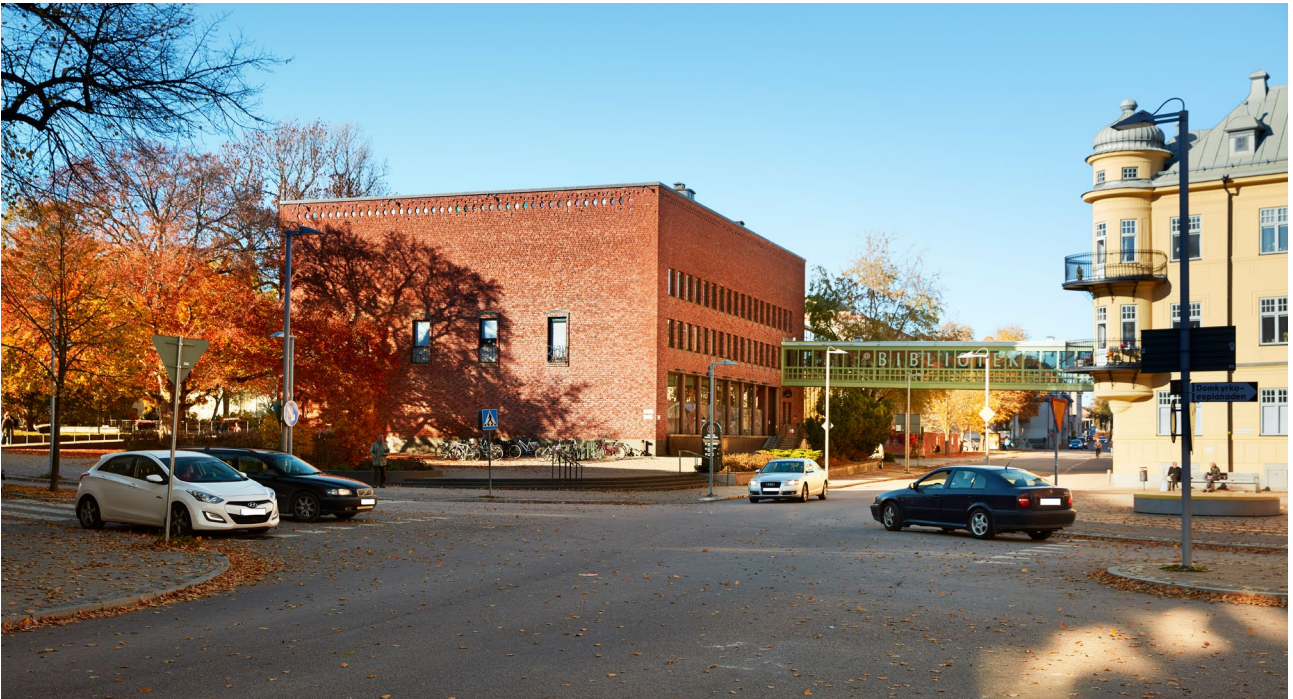
■ Stadsbibliotekets slutna fasad av handslaget rött Veberödsteegel med konstverk som är integrerade i byggnaden (Heimer 5). Foto: Lasse Fredriksson, Vlm-Fre-4002.
