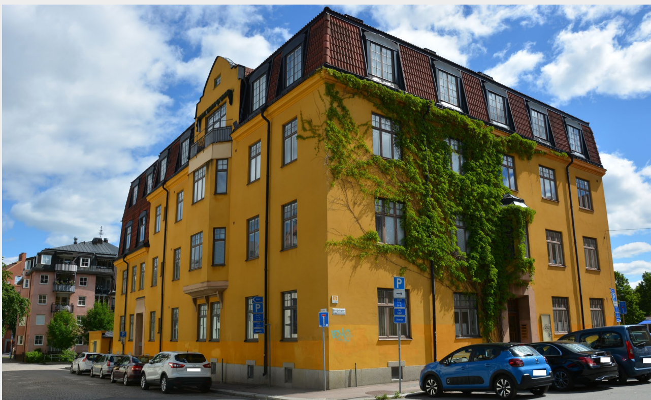
■ Bostadshus ritad av den välkände västmanländske arkitekten Arvid Grane i jugendstil, uppförd 1913. Byggnaden i tre våningar har gult slätputsade fasader, burspråk och fönster med de övre bågarna småspröjsade (Hugo 13). Foto: Vlm-vasek-0253.
