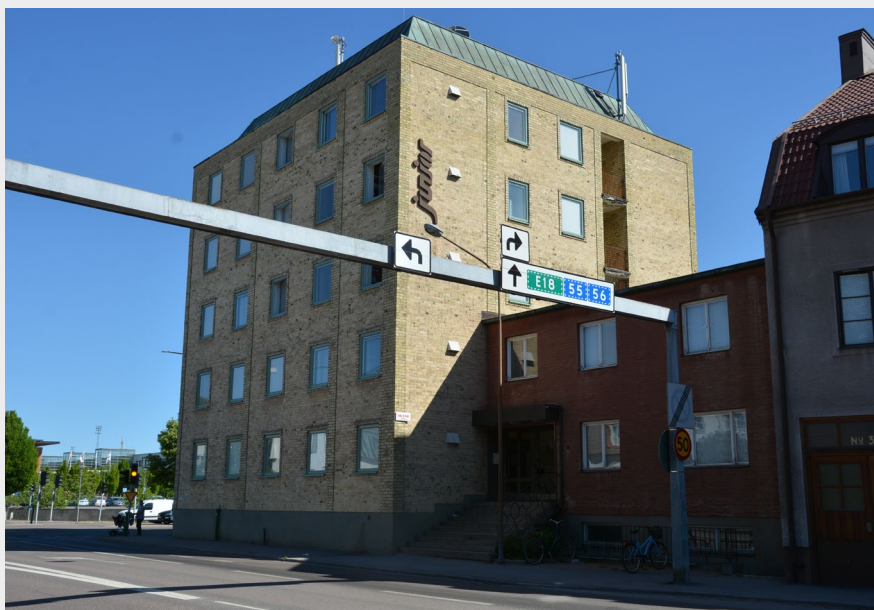
■ Punkthus i exponerat läge intill Norra Ringvägen. Byggnaden i fem våningar har fasader av gult fasadtegel och valmat plåttäckt tak (Fjolner 8). Foto: Vlm-vasek-0005.
