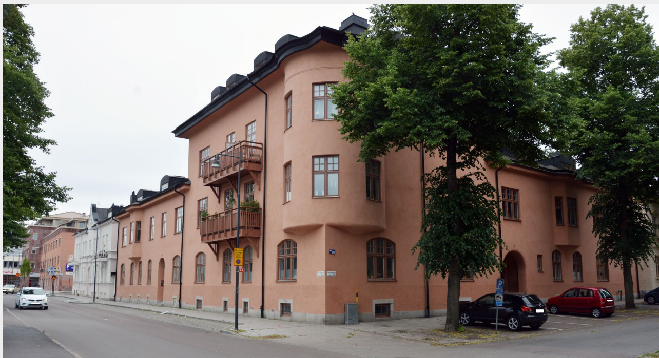
■ Korsningen Källgatan/Kristinagatan med byggnad i jugendstil. Fasaden är putsad i en ljus rosa kulör och taket plåttäckt (Klara 16). Foto: Vlm-vasek-1227.
