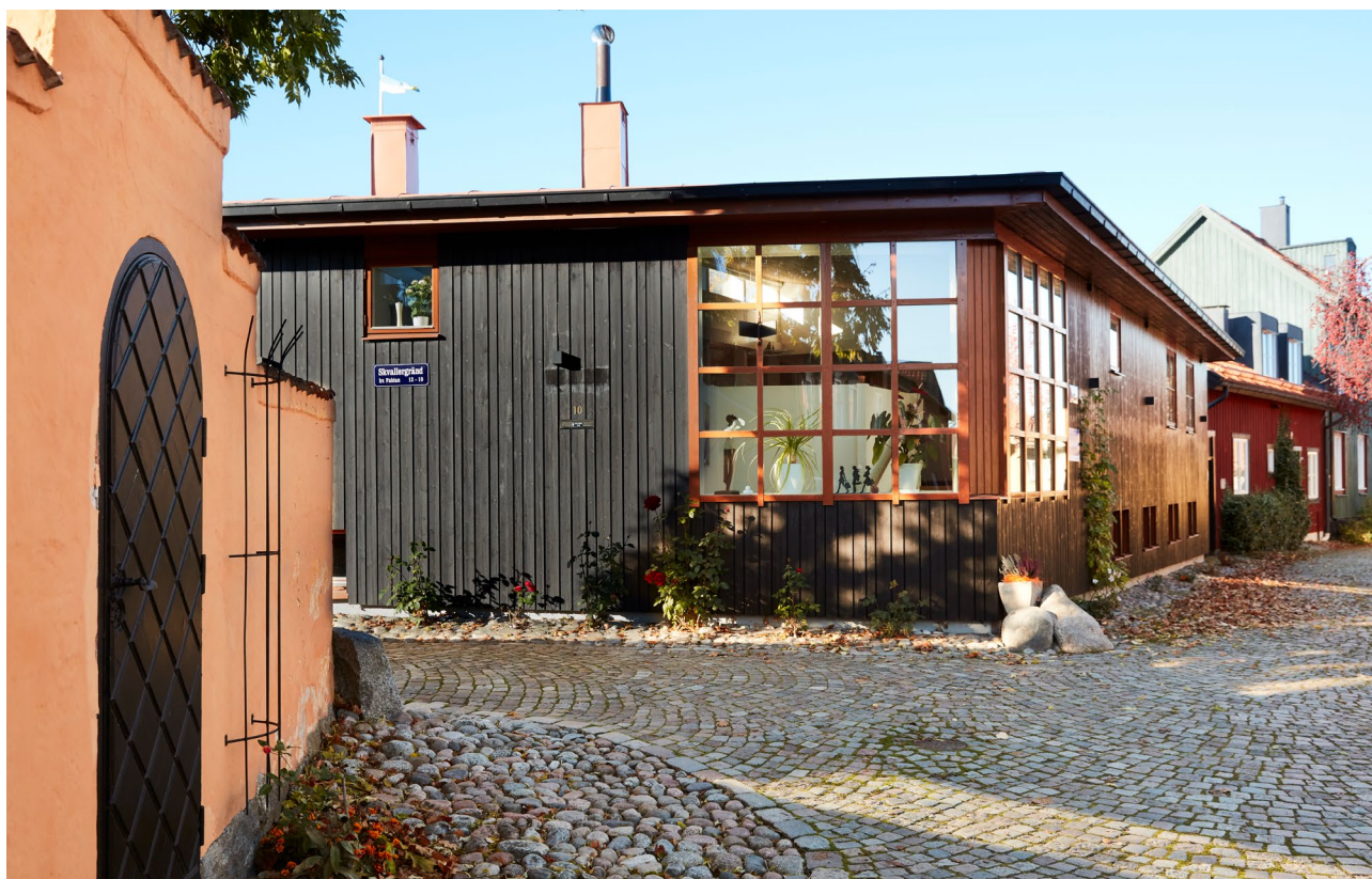
■ Bostadsbebyggelse i kullerstensgränd från 1973. Byggnaden har modern utformning med fasader av svartmålad träpanel och orangeröda fönsterbågar (Fabian 10). Foto: Lasse Fredriksson, Vlm-Fre-4037.
