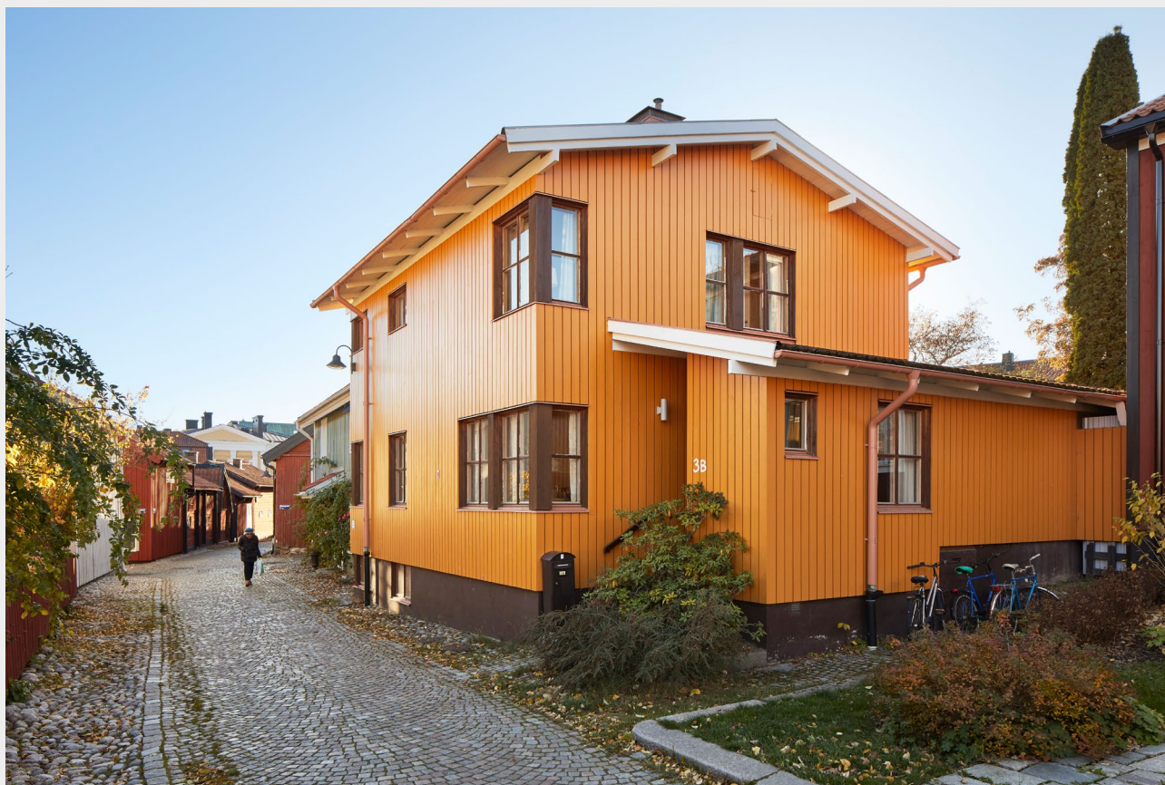
■ Modernistisk villa från 1970-talet på Kyrkbacken med gula fasader och brunmålade spröjsade fönster. Foto: Lasse Fredriksson, Vlm-Fre-4059.
