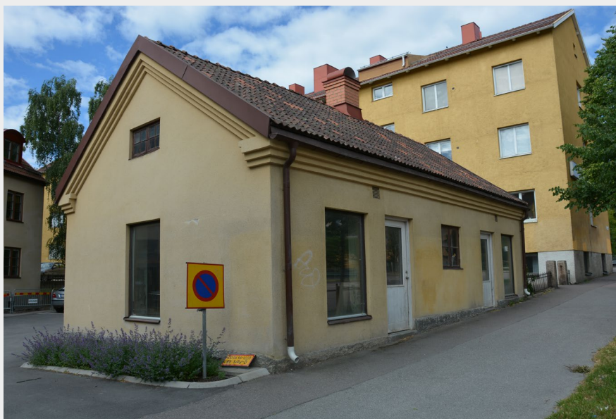
■ Byggnaden uppfördes som butiks- och uthus 1923 efter ritningar av arkitekt signerade N Ramqvist. Den har ljus gult putsade fasader, profilerad takfot och tegeltäckt sadeltak. Foto: Vlm-vasek-0440.
