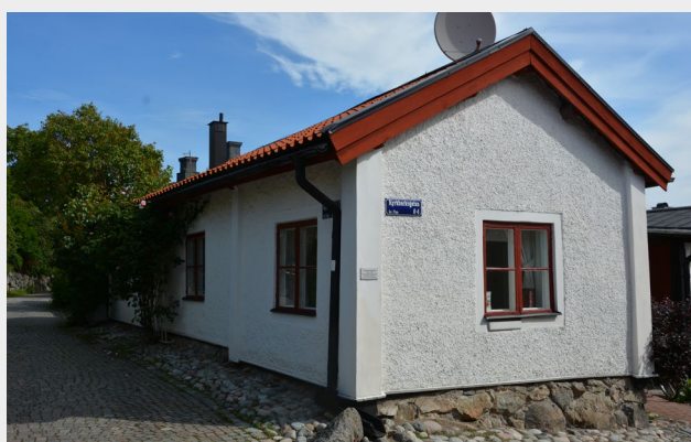
■ Putsad byggnad från 1700-talet som länge var delad i två lägenheter. Fönstren har äldre kloformade fönsterbeslag av 1700-talstyp (Finn 13). Foto: Vlm-vasek-1492.
