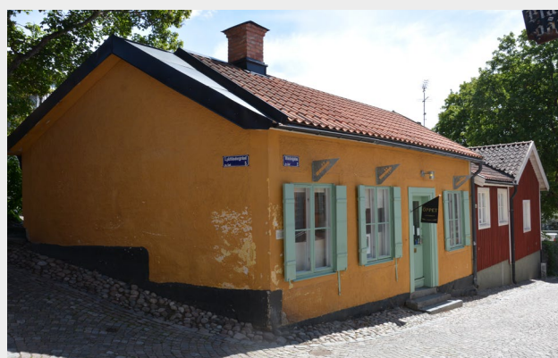
■ Byggnad som gjordes om från stall till handelsbod i slutet av 1800-talet. Byggnaden har en våning, putsade fasader i ockrakulör och tegeltäckt sadeltak och inrymmer sedan 1990-talet en violinateljé (Gad 3). Foto: Vlm-vasek-1583.
