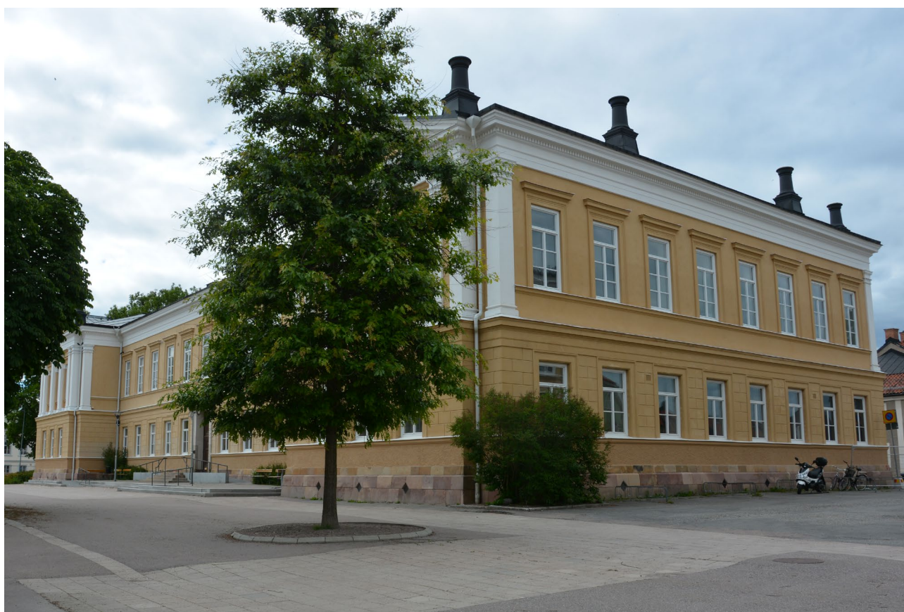
■ Rudbeckianska gymnasiet, ritad i nyklassicistisk och empirestil 1852 av arkitekt Pehr Johan Ekman. Byggnaden i två och en halv våning har fasader i gul slätputs och svart plåttäckt tak (Domkyrkan 2). Foto: Vlm-vasek-1418.
