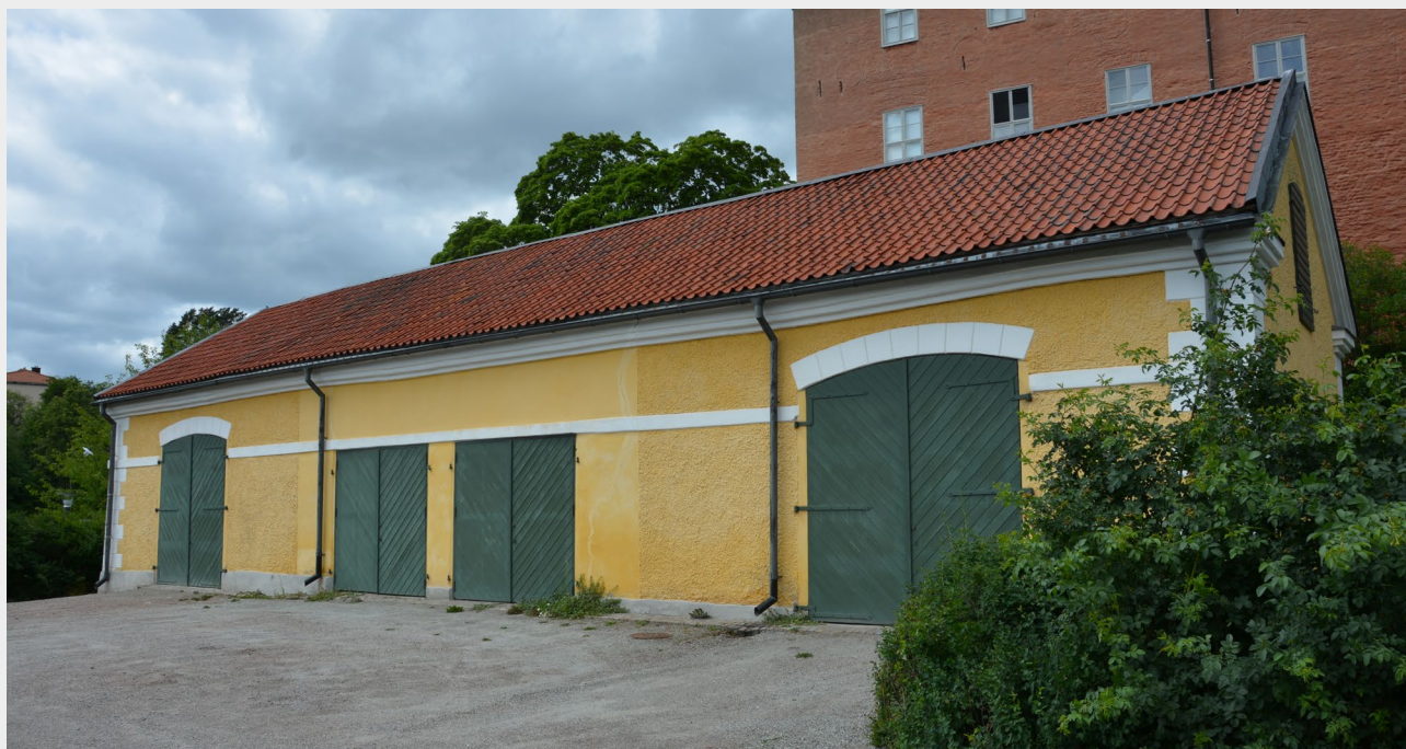
■ Före detta stallbyggnad i gul och vit puts, grönmålade dörrar och enkupigt tegeltäckt sadeltak (Olympia 3). Foto: Vlm-vasek-0961.
