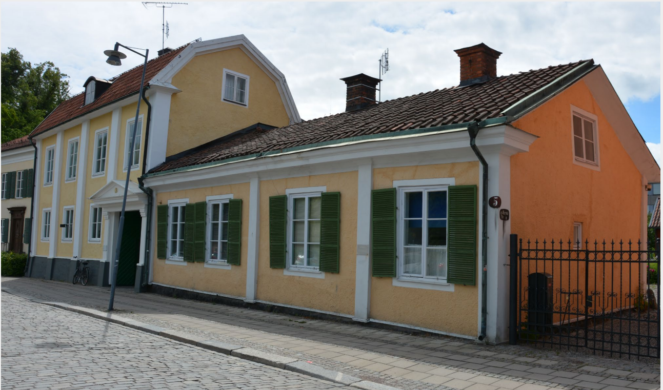
■ Byggnader troligen från slutet av 1700- och 1800-talet. De är i en och två våningar med gulputsade fasader och tegeltäckta sadeltak och brutet tak (Norna 24 och 25). Foto: Vlm-vasek-0931.
