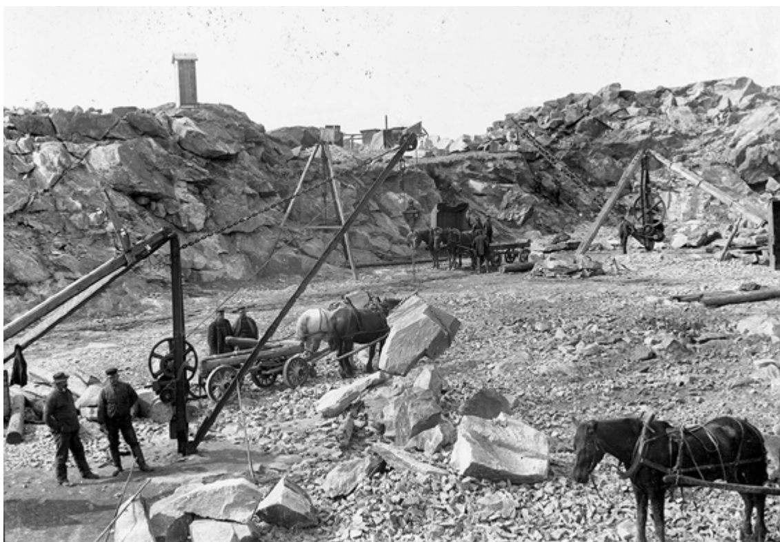
← 2 och 3,5 tons elektriska stenkrantar. Denna typ av krantar tillverkades i Aseas mekaniska verkstad i Sigurdsområdet i Västerås. Foto: Asea. Cirka år 1900.
