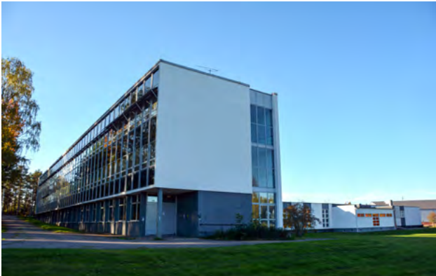
■ Lindboskolan väster i området uppfördes 1960 och ritades av västeråsarkitekten Sven Ahlbom. Foto: Vlm-halsb-533.
