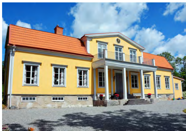
■ Valsta gårds huvudbyggnad brann ned 1858 men byggdes upp igen. Den fick då sitt nuvarande utseende. Foto: Vlm-halsbx-1167.
