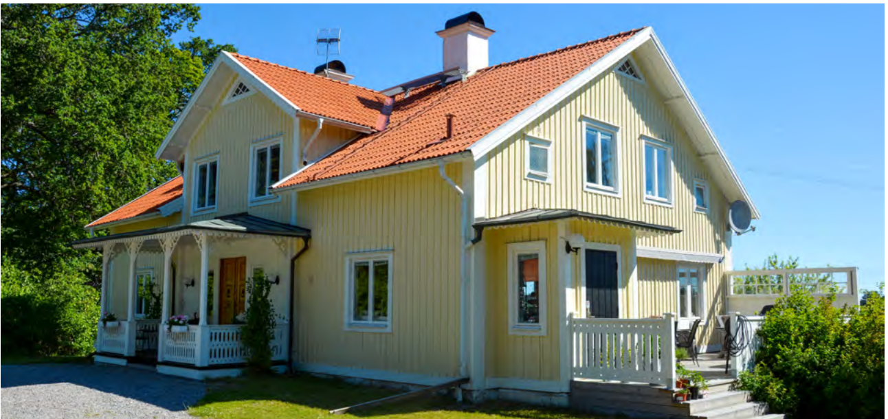
■ Mangårdsbyggnaden vid Skälby gård. Foto: Vlm-halekx-0609.
