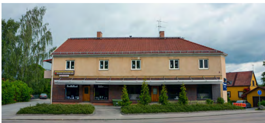
■ Byggnad med fasad mot Nygatan. Foto: Vlm-halsb-238.
