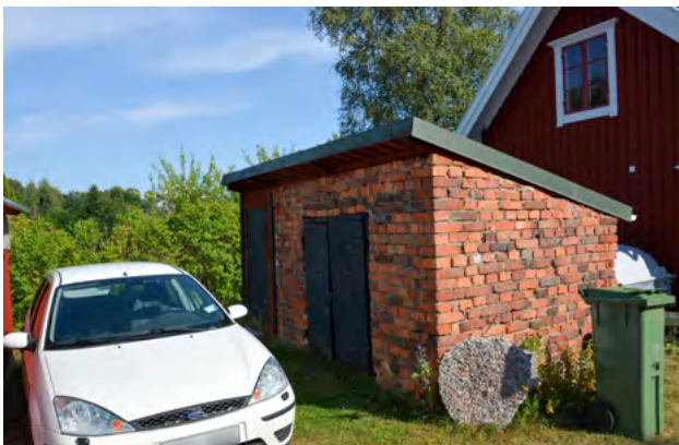
■ Svinhus uppfört av tegel i slutet av 1800-talet på Brunnsvägen. Foto: Vlm-halehw-194.
