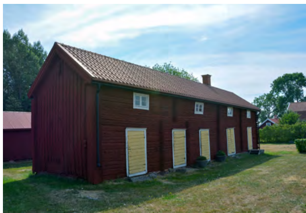
■ Bodlänga i Hälsta, uppfört under 1800-talets andra hälft och hitflyttad 1900. Foto: Vlm-halehwx-0405.
