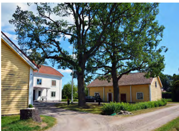
■ Gården Amstas flygelbyggnader är äldre än mangårdsbyggnaden som uppfördes 1843. Foto: Vlm-halehwx-0053.
