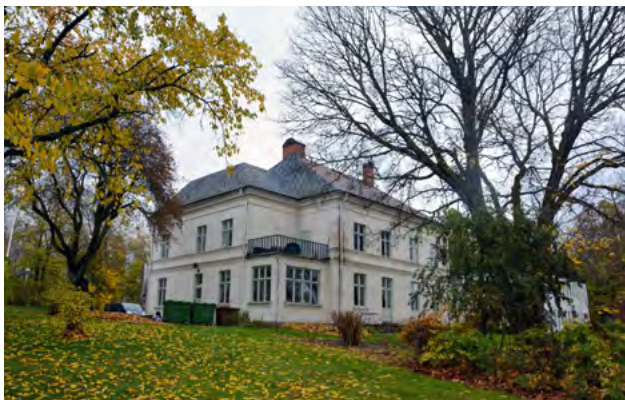
■ Rallsta herrgård från 1903 uppfördes som disponentbostad för Rallsta tegelbruk. Foto: Vlm-halsb-737.
