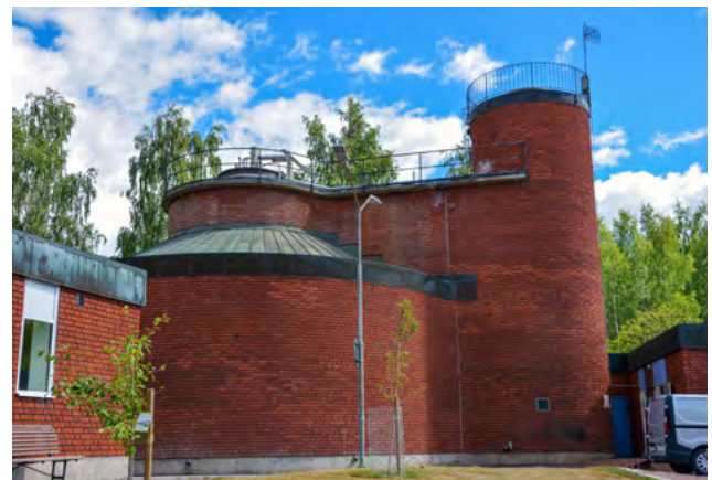
■ Slamavskilningsbyggnaden vid reningsverket i Mölntorp. Hela anläggningen har ett genomgående oförändrat uttryck. Foto: Vlm-halsbx-0504.
