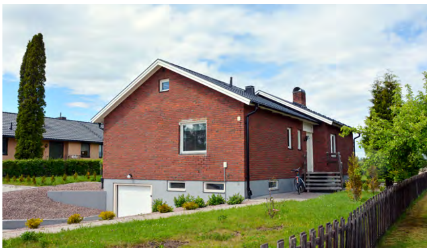
■ Villa på Agnevägen byggd under slutet av 1960-talet. Foto: Vlm-halvb-0004.
