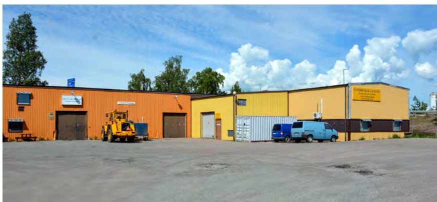
■ I områdets östra del finns industribyggnad från 1960- och 1970-talen. Foto: Vlm-halekx-0126.
