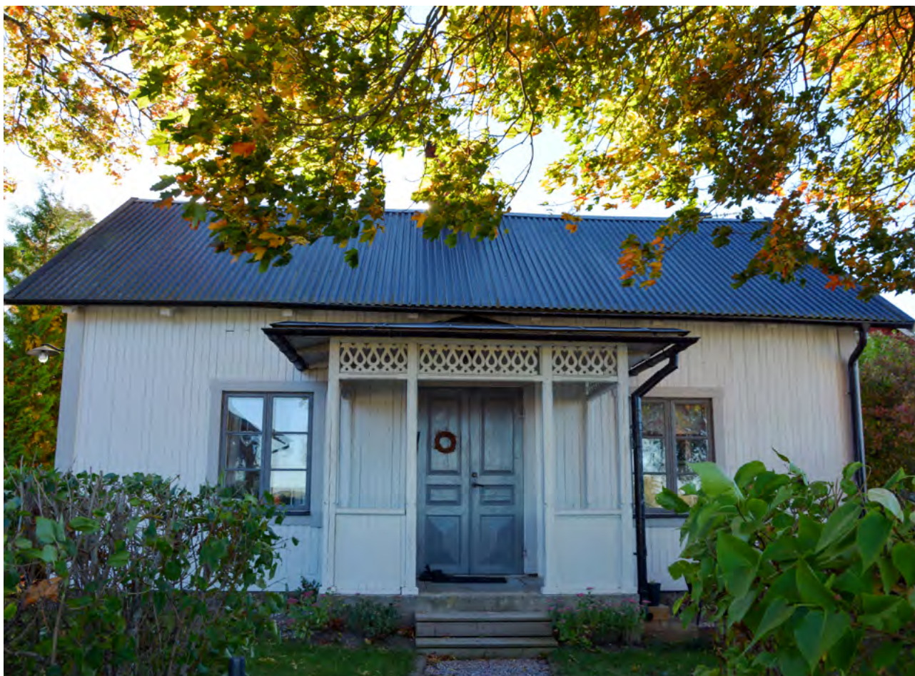
■ Bostadshus uppfört på 1890-talet på Sörsta Norrgården. Foto: Vlm-kmvsb-3175.
