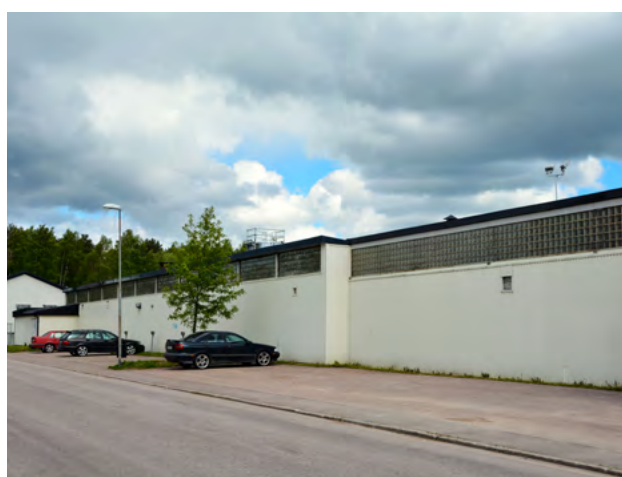
■ Maskinhallar med vit fasadplåt och fönsterband av glasbetong. Foto: Vlm-halsb-1619.
