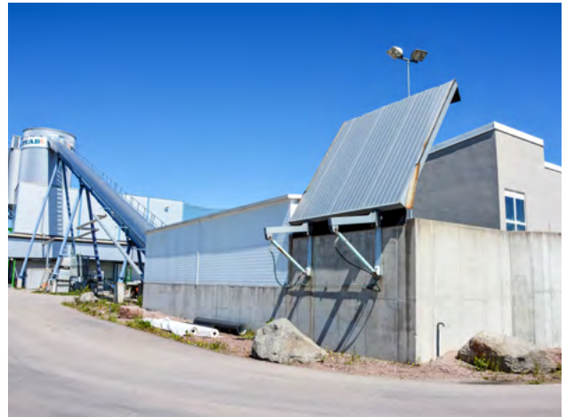
■ Betongfabrik i områdets södra del. Foto: Vlm-halsb-2807.
