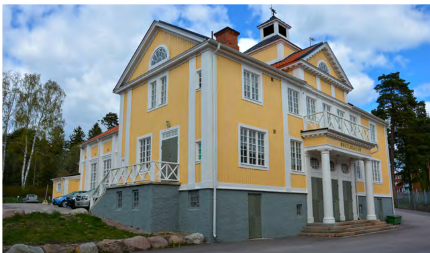
■ Bultlokalen från 1914, efter renovering färdig april 2020. Foto: Vlm-kmvek-2888.
