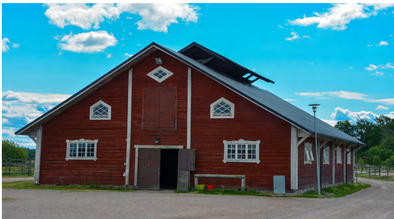
■ Före detta bevärringsbarack från 1879 vid Utnäs. Foto: Vlm-halsbx-0637.
