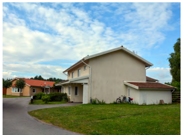
■ Bostadsbebyggelse i ljus puts från slutet av 1900-talet i mitten av området. Foto: Vlm-halsb-192.
