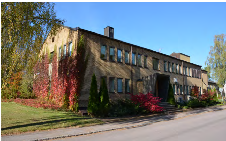
■ Hallstahammars kommunhus, byggt 1949. Foto: Vlm-halsb-578.
