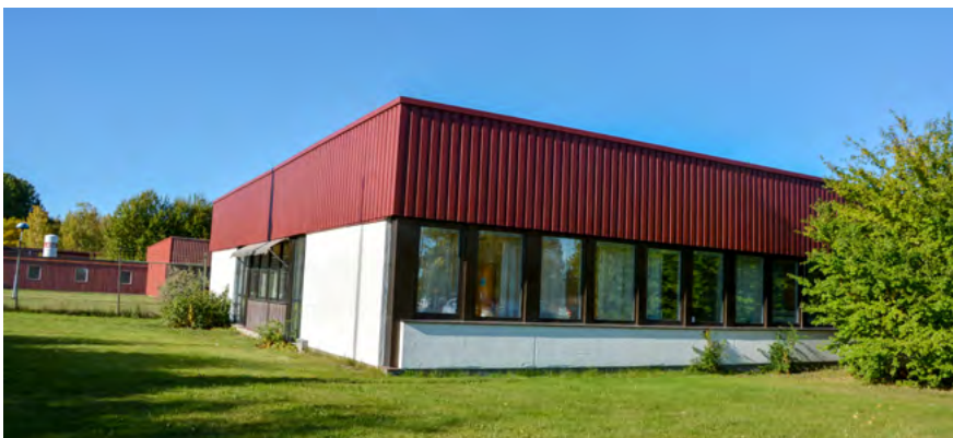
■ Kontor från 1970-talet med tidstypiskt kraftigt takkrön och fönsterband. Foto: Vlm-halsb-3350.
