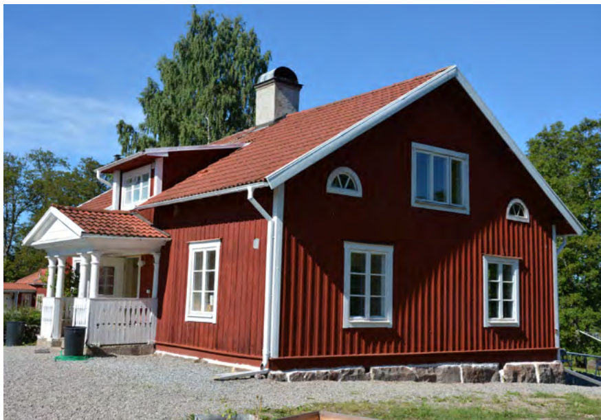
■ Arbetarbostad från 1905 vid Mölntorps fabriker, ursprungligen med tre lägenheter. Foto: Vlm-halsbx-0533.
