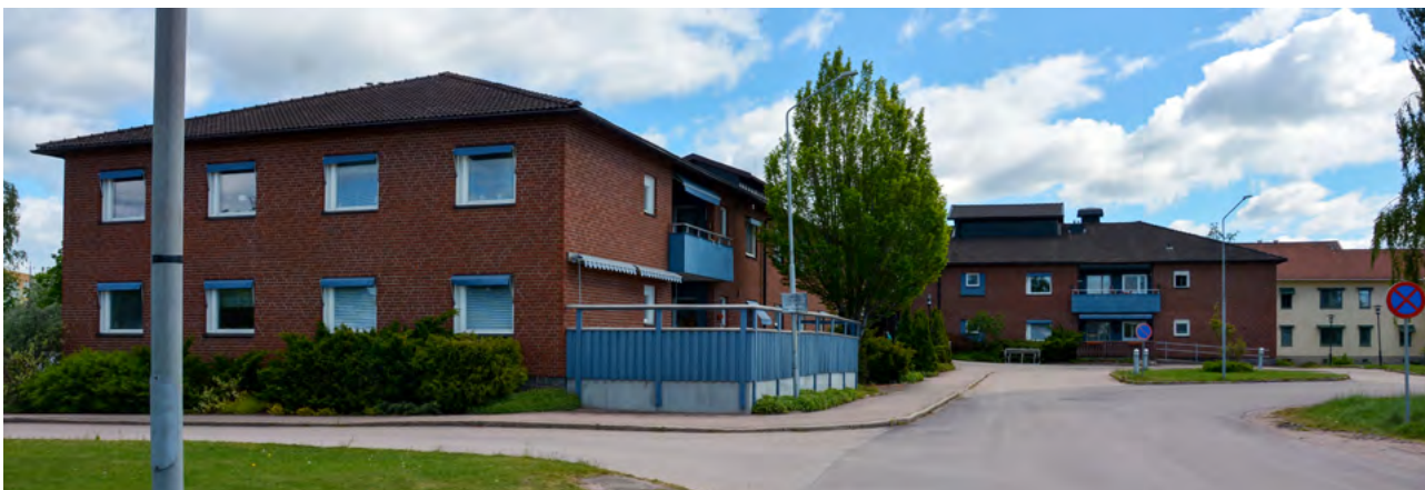
■ Äldreboendet Strandgården med den senare byggda delen från 1973. Foto: Vlm-halek-1010.
