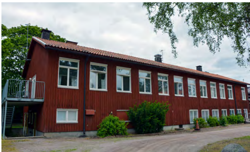
■ Internatboende för gymnasieelever uppfört 1952 i områdets norra del kring ridskolan Strömsholm. Foto: Vlm-halvb-0646.
