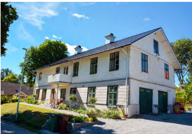
■ Byggnad uppförd under sent 1800-tal som mejeri. Byggnaden är numera ombyggd till tvåfamiljshus. Foto: Vlm-halvb-0323.
