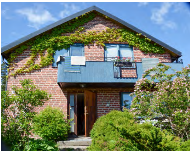
■ Välbevarad villa från 1950-talet med väl utformade detaljer på Bergsgatan. Foto: Vlm-halekx-0063.
