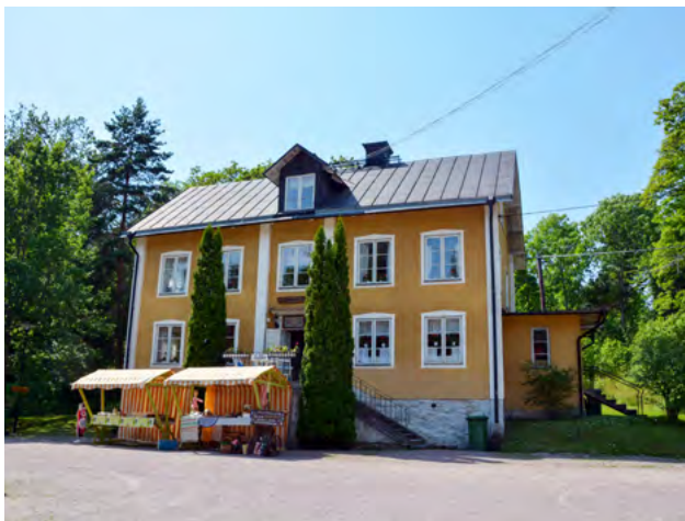
■ Kanalbolagets Mekanikusbostad uppförd 1790. Idag håller Svedvi Berg hembygdsförening till i lokalen. Foto: Vlm-halsb-47.
