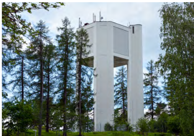
■ Vattentornet byggdes 1958 på grusåsen som löper i nord-sydlig riktning genom samhället. Foto: Vlm-halsbx-0204.
