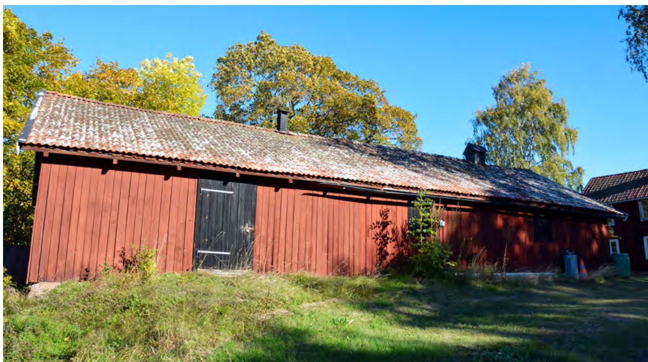
■ Gemensam torkvind för arbetarbostäderna i området uppförd på 1880-talet i Sörsta. Foto: Vlm-halsb-3191.
