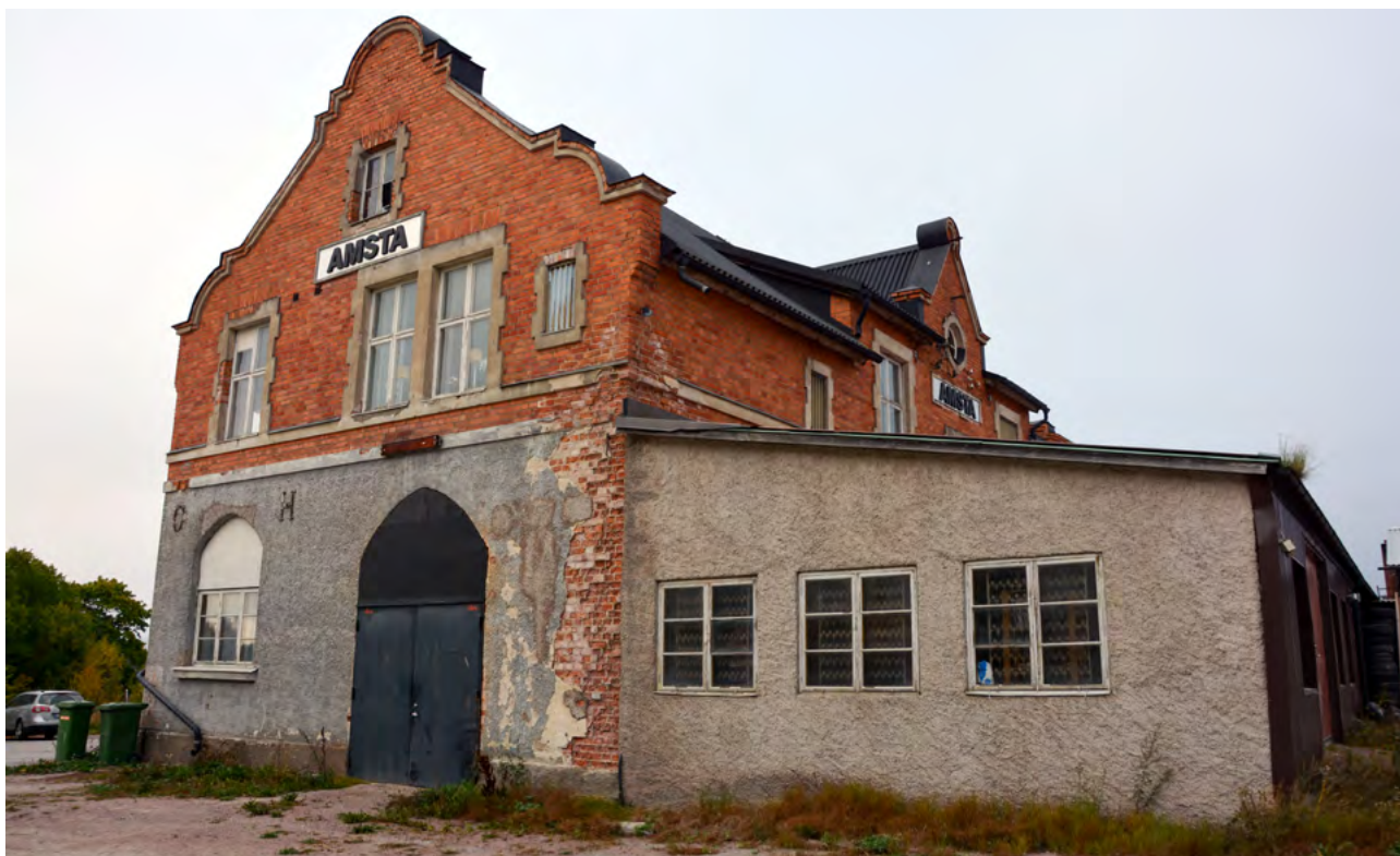
■ Skolbyggnad i Amsta uppförd 1904–1906. Byggnaden har byggts om till industrilokal. Foto: Vlm-halsb-3057.
