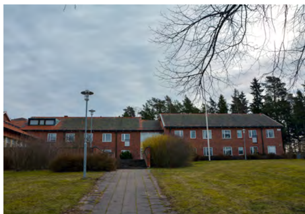
Lövåsens äldreboende byggdes under 1960-talet i sydvästra Lövboås. Foto: Vlm-halsb-952.
