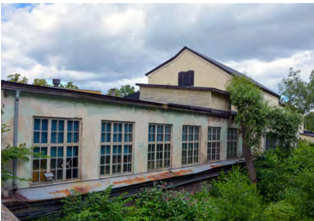
■ Den äldre delen av Mölntorps fabrik som vetter mot Kolbäcksån. Foto: Vlm-halsbx-0513.
