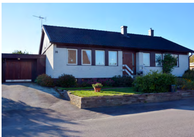
■ Villa i kalksandsten byggd på 1970-talet på Johan Forsells väg. Foto: Vlm-halek-404.
