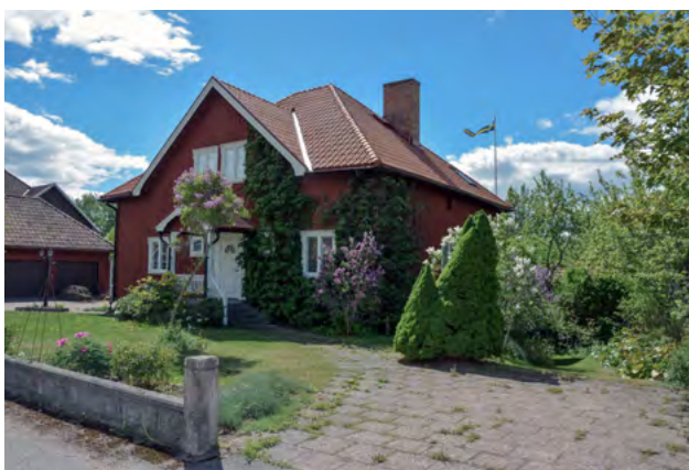
■ En av arbetarbostäderna på Strandvägen som uppfördes för SJ:s räkning. Foto: Vlm-halsb-3530.
