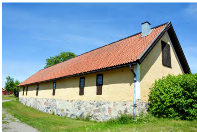
■ Tidigare stalldrängarnas ladugård uppförd 1811–1813 i gjuthusteknik. Foto: Vlm-halvb-0599.
