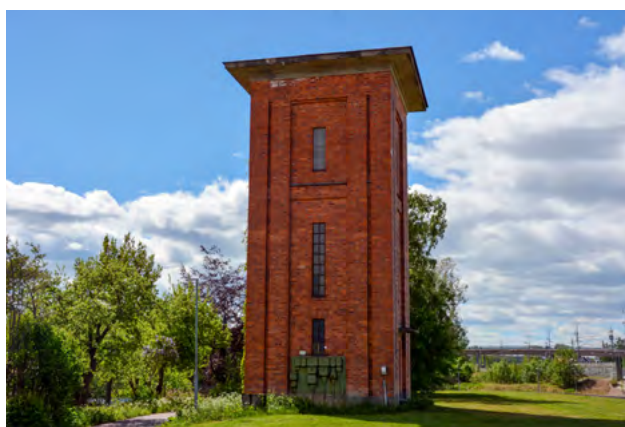
■ Vattentorn (pumphus) för ångloken som trafikerade järnvägen. Vattentornet är uppfört 1877. Foto: Vlm-halsb-3529.
