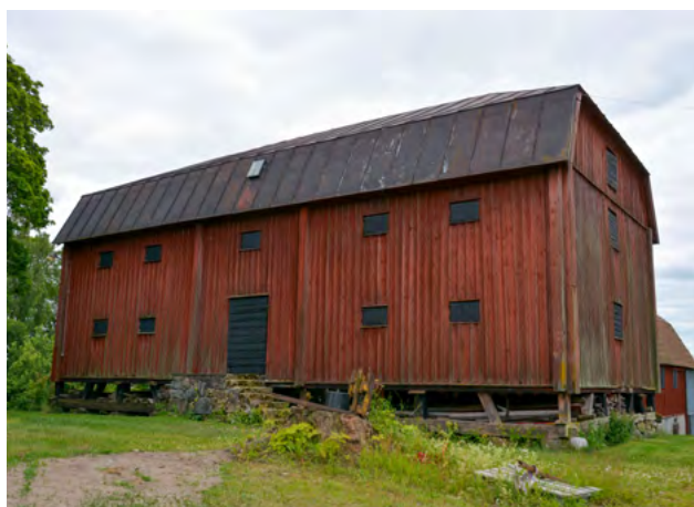
■ Magasinsbyggnad till Kungsladugården uppförd cirka 1860. Foto: Vlm-halekx-0467.
