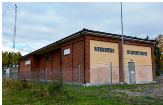
■ Ställverksbyggnad från 1950-talet norr i området. Foto: Vlm-halsb-726.
