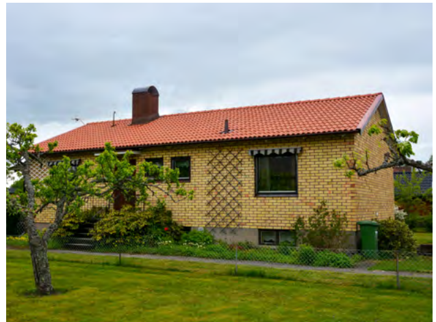
■ Bostadshus uppfört 1959–1960 av anställda vid Bulten genom bostadslån av arbetsgivaren, Vallaregatan. Foto: Vlm-halsb-1640.
