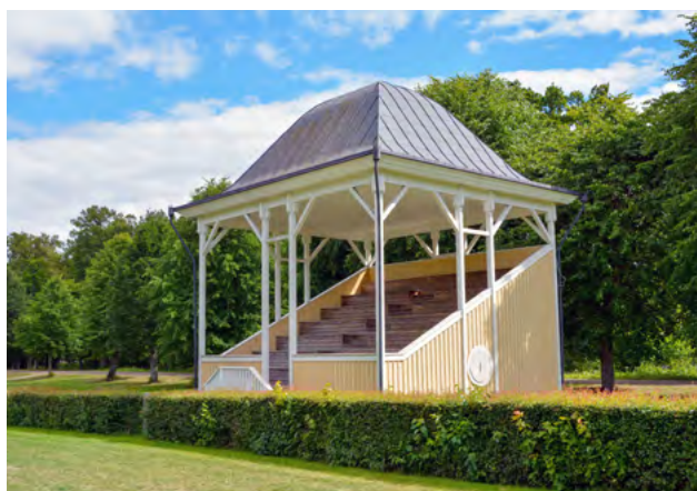
■ Läktarbyggnad från 1948 intill travbanan. Foto: Vlm-halvb-0699.
