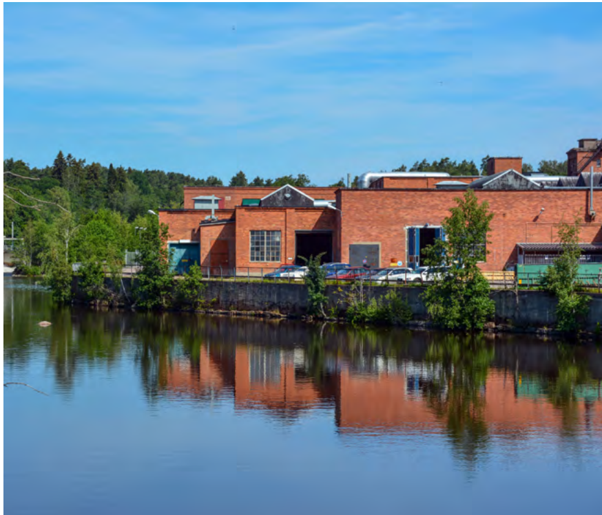
■ Industribebyggelse med tegelfasader och storskaliga byggnadskroppar. Foto: Vlm-halfe-46.
