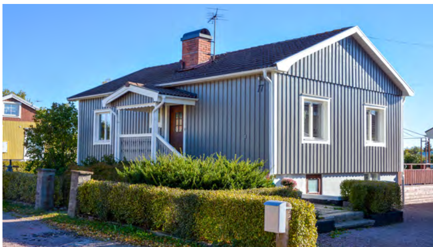
■ Villa byggd kring slutet av 1940-talet. Flera av dessa villor i området har fått tilläggsisolering, ny fasadpanel, nytt tak eller ny veranda. Foto: Vlm-kmvsb-3211.
