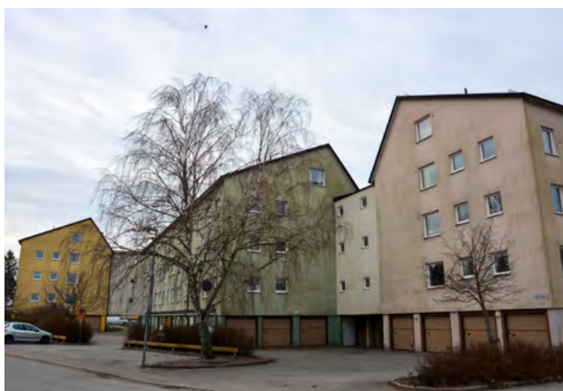
Flerbostadshus från 1950-talet med ljus putsade fasader i sydvästra Lövboås i kvarteret Väskan. Foto: Vlm-halehw-440.
