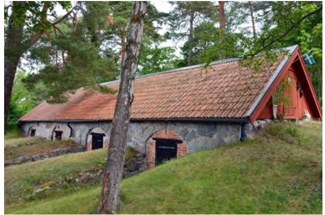
■ Jordkällare i söder från tidigt 1800-tal. Foto: Vlm-halekx-0394.
