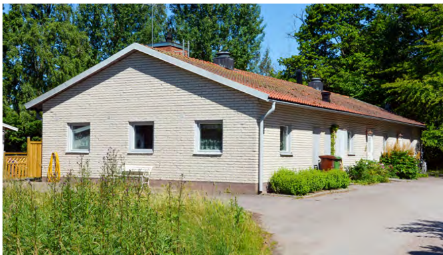
■ Byggnad som uppfördes som tvättstuga inom verksamheten vid Olfsta tillhörande Sofielunds vårdhem. Foto: Vlm-halexx-0636.
