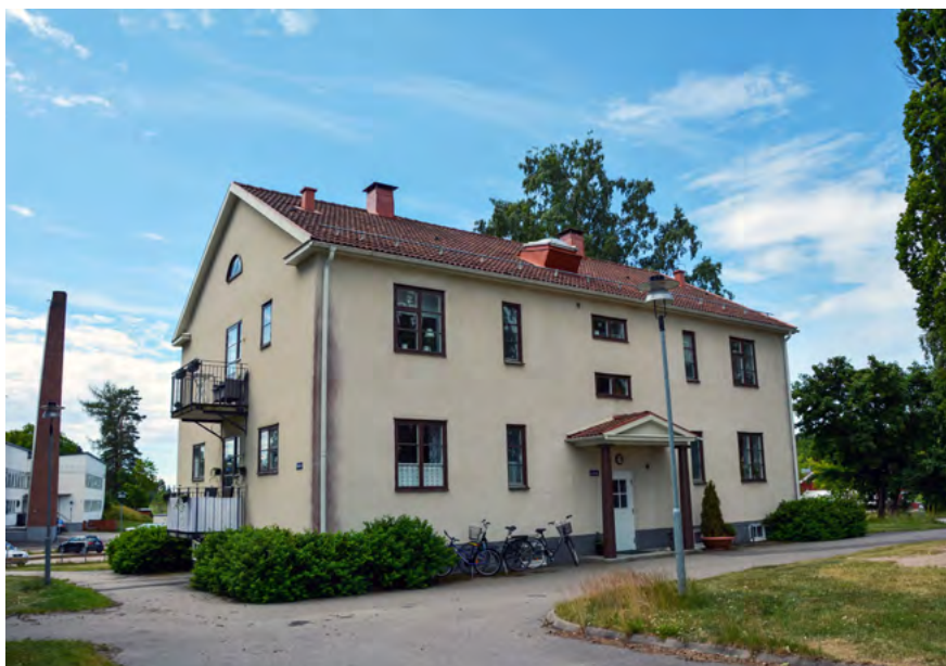
■ Byggnaden uppfördes 1932 som personalbostad och byggdes under mitten av 1900-talet om till barnhem. Foto: Vlm-halvb-0735.
