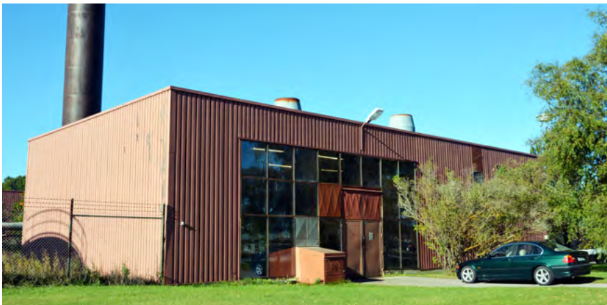
■ Industribyggnad från 1970-talet med tidstypisk plåtfasad. Foto: Vlm-halsb-3347.
