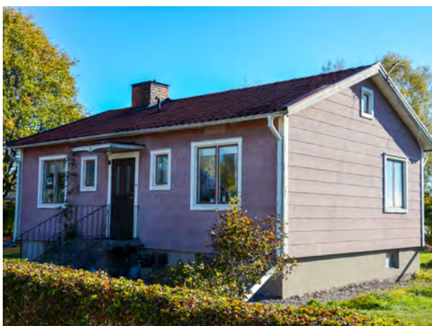
■ Villa med eternitbeklädnad byggd i slutet av 1940-talet på Södra Idrottsvägen. Foto: Vlm-kmvsb-3197.
