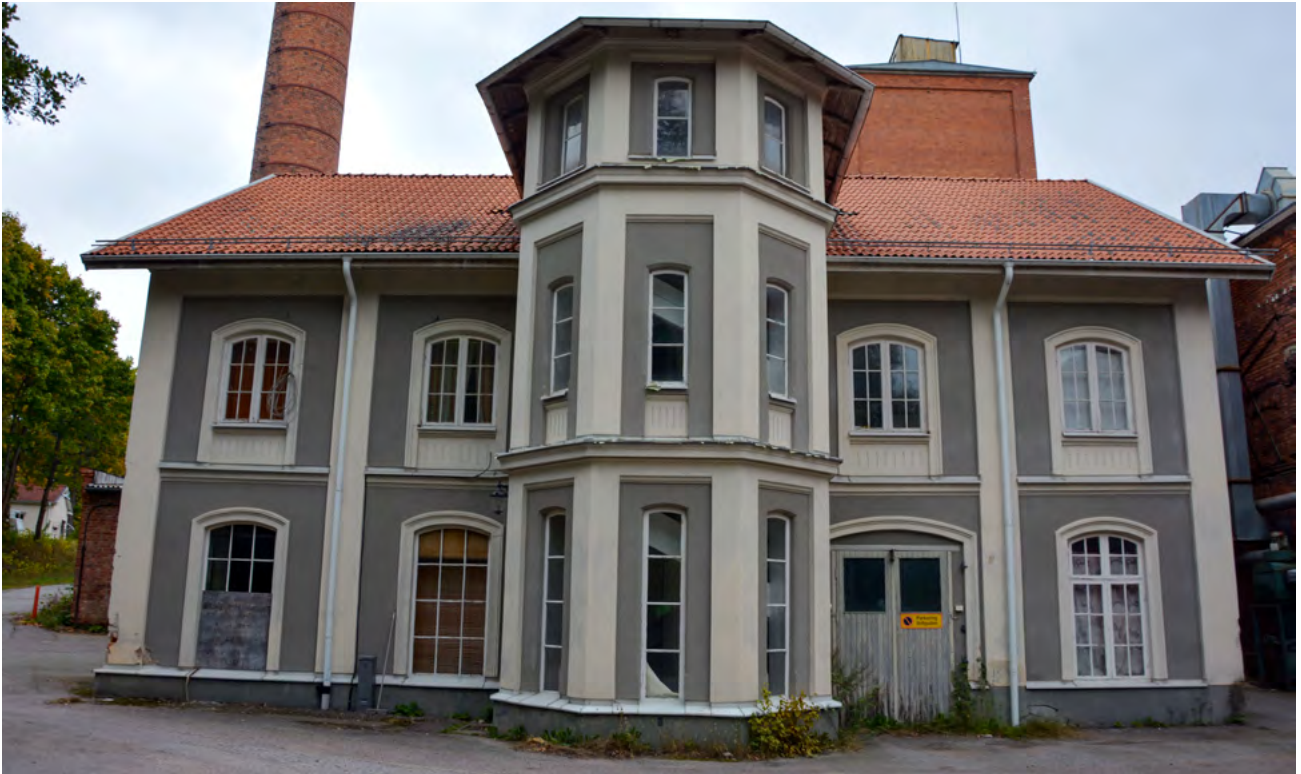
■ Ingenjörskontoret från slutet av 1800-talet med putsade fasader. Foto: Vlm-halsb-3102.
