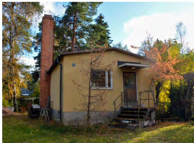
■ Gemensam tvätt-, frys och värmecentral till kedjehusen uppförda 1962 åt lägre ingenjörer i södra delen av området. Foto: Vlm-halsb-783.
