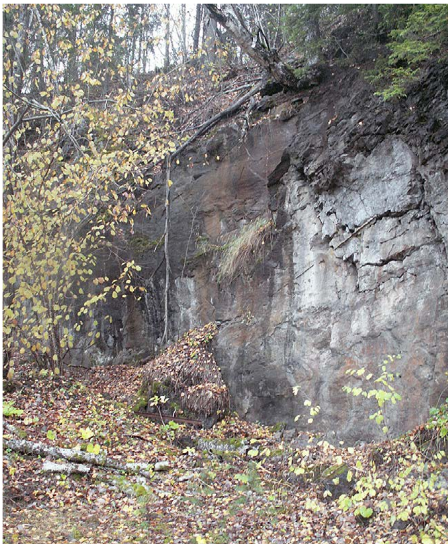
■ Figur 4. Bergssida med spår efter tillmakning, Klackbergsgruvan. Foto: Ing-Marie Pettersson Jensen.
