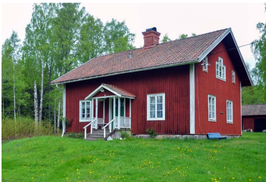
■ Nybygget, välbevarat bostadshus från 1800-talets slut. Foto: Vlm-nbgehw-664.
