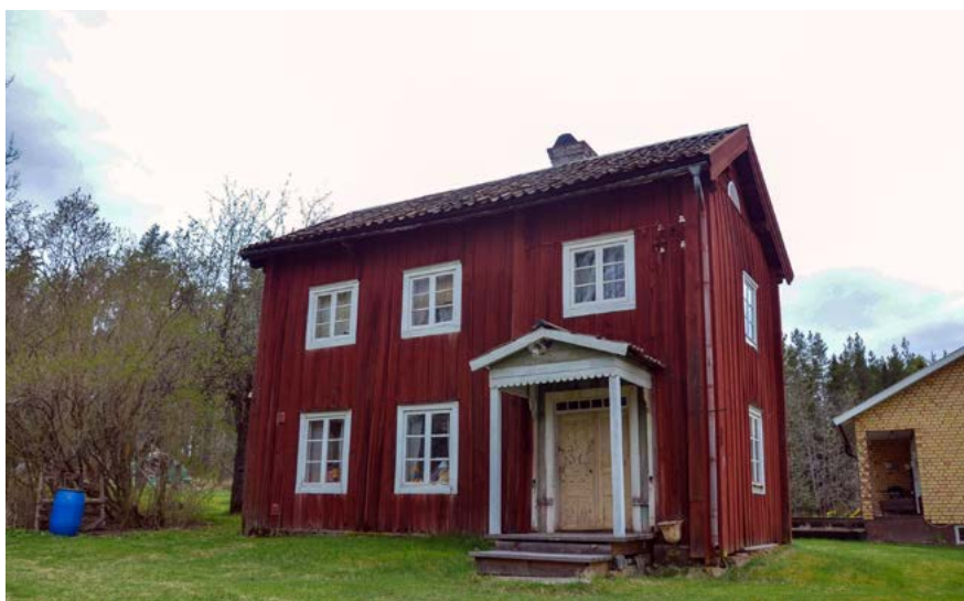
■ Bostadshus i två våningar från tidigt 1800-tal med rödslammad fasad, vita snickerier och dekorerad farstuvikst. Foto: Vlm-nbgehw-231.
