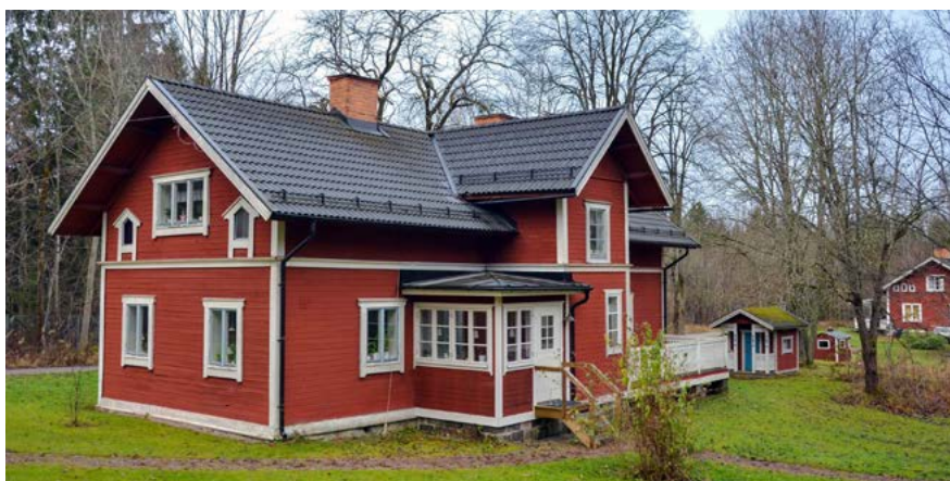
■ Arbetarbostad i Kallmorberg uppförd runt sekelskiftet 1900. Vlm-nbgsb-1570.
