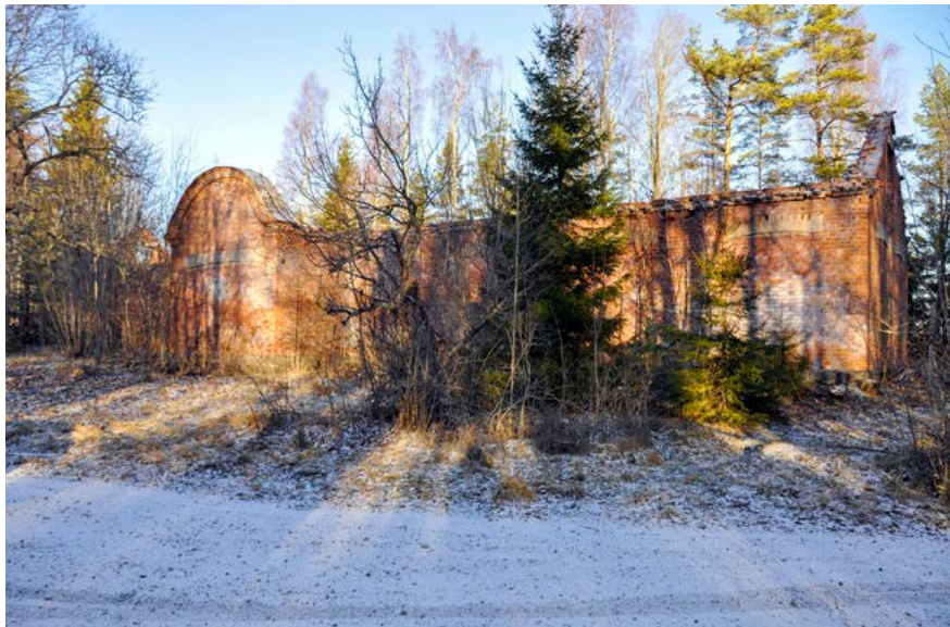
■ Ruin efter anrikningsverket som uppfördes 1905 i byägens västra del. Foto: Vlm-nbgfe-2065.
