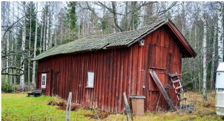
■ Småskalig ekonomibyggnad i Abrahamsbo. Foto: Vlm-nbgbsb-1627.
