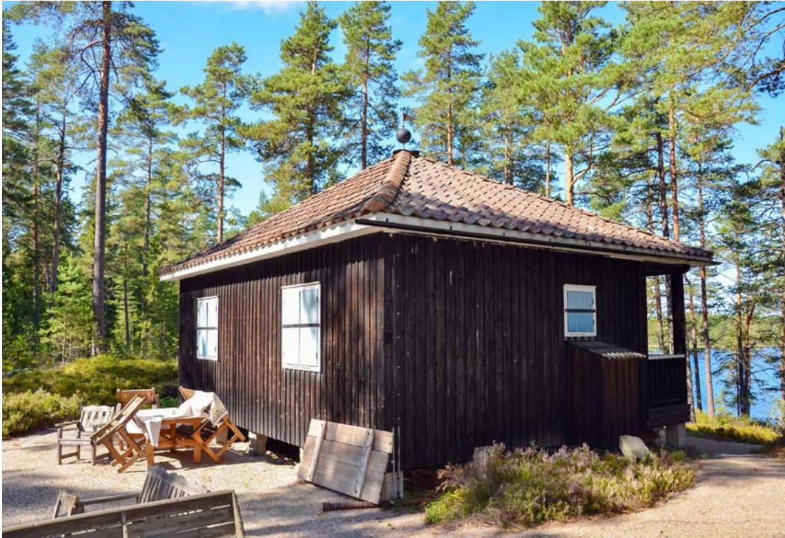
■ Fritidshus intill sjön Ungen, uppfört för anställda vid Fagersta Bruk. Foto: Vlm-nbgsb-921.
