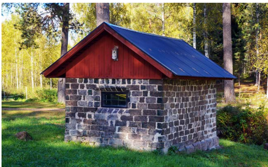
■ Tvättstuga i slaggtegel vid den äldre bruksbebyggelsen. Foto: Vlm-nbgsb-1471.
