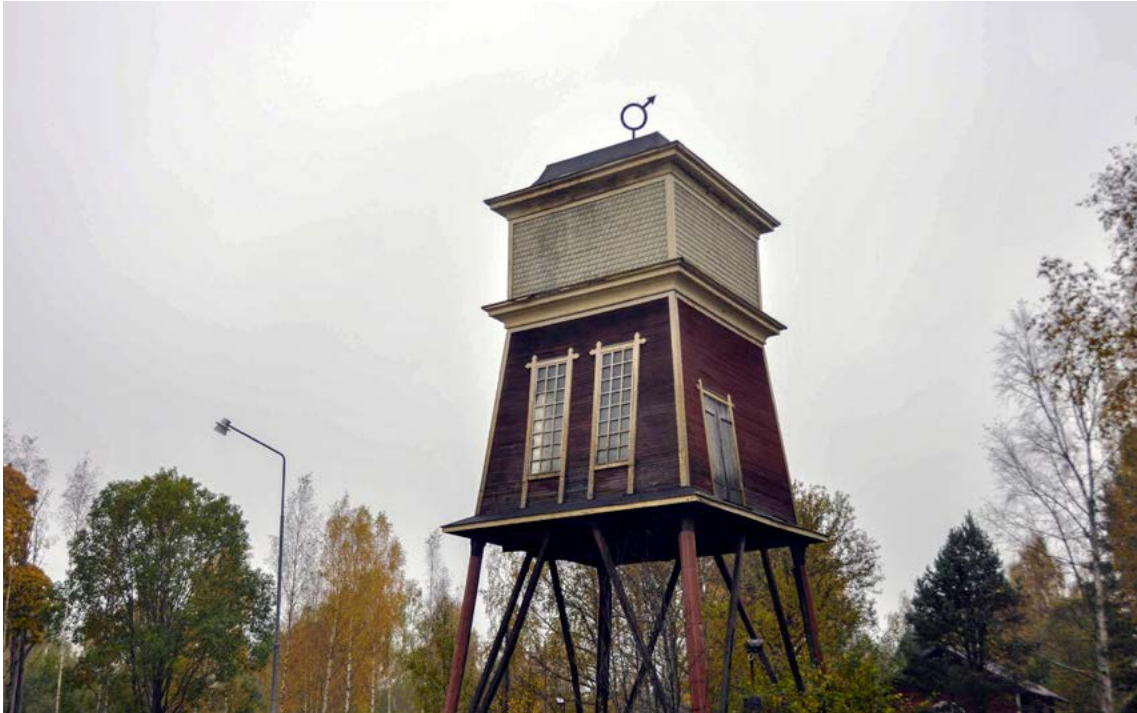
■ Södra schaktets gruvlave uppfördes 1902. Foto: Vlm-nbgim-1155.
