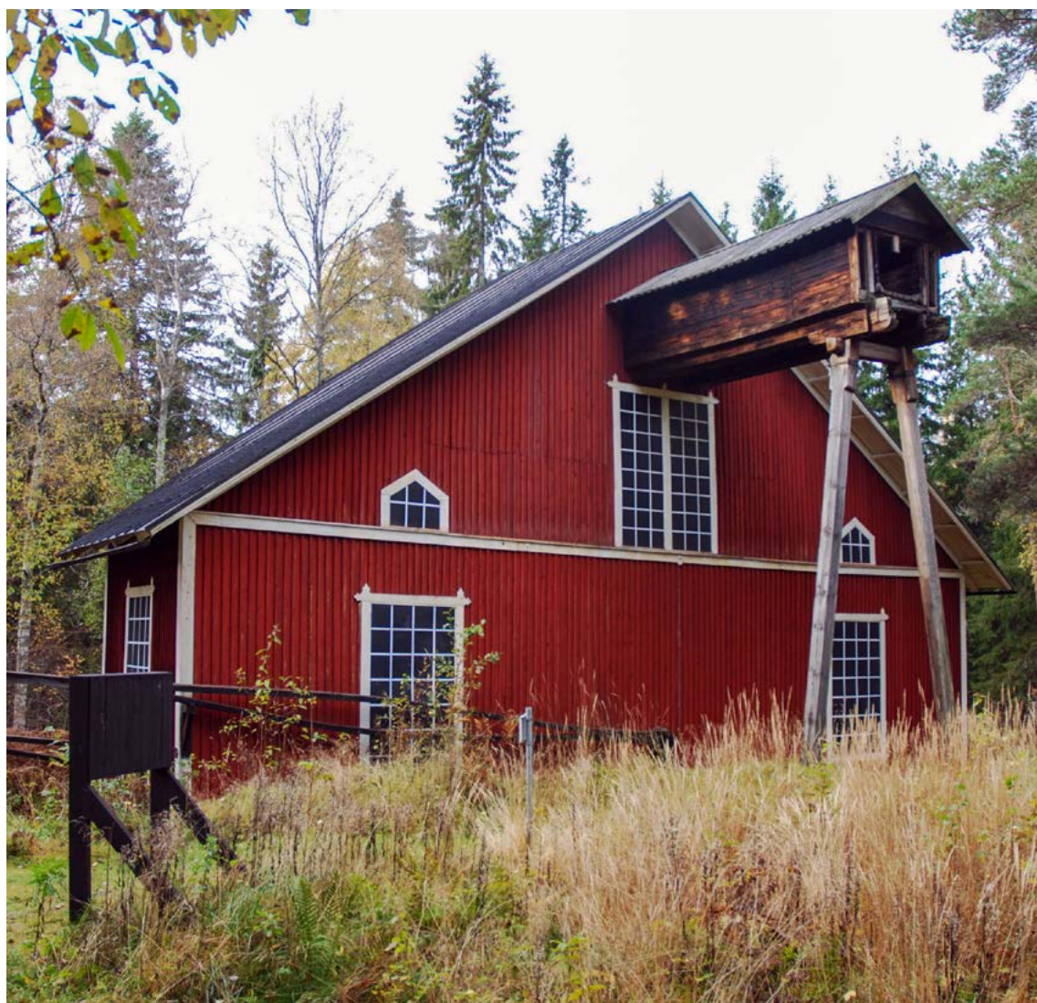
■ Byggnadsminnet Polhemshjulet med stora blindfönster sedd från norr. Foto: Vlm-nbgm-759.
