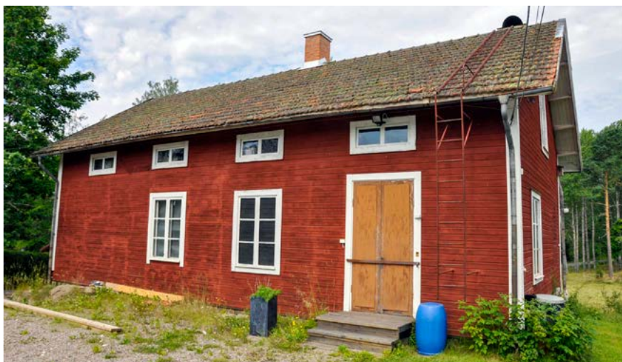
■ Den före detta lanthandelsbyggnad invid vägen mellan Årnebo och Bråfors. Byggnaden har lokala och traditionella byggmaterial som slaggstensgrund och hjärttegel som taktäckning. Foto: Vlm-nbgfe-801.
