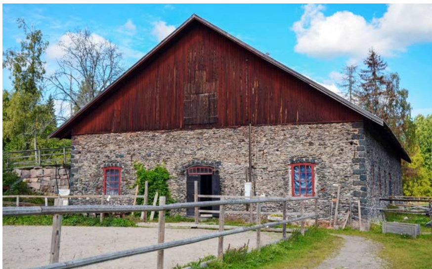
■ Ladugård från 1800-talet uppförd i slaggflis med markerade hörn i staggtegel. Foto: Vlm-nbgsb-1027.
