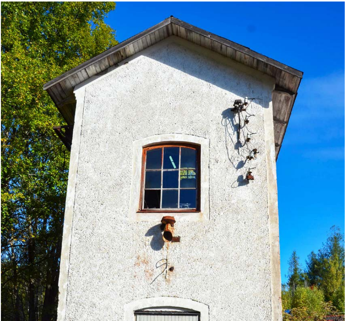
■ Transformatorbyggnad med putsade fasader vid Bondgruvan från 1800-talet. Foto: Vlm-nbgbsb-1402.
