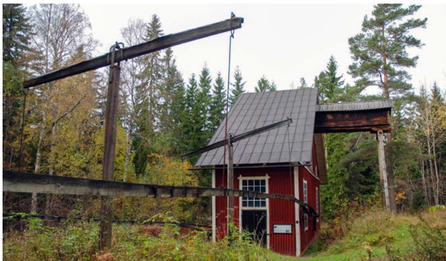
■ Polhemshjulets överbyggnad samt delar av stånggången som rörde sig av vattenhjulets kraft. Foto: Vlm-nbgm-760.
