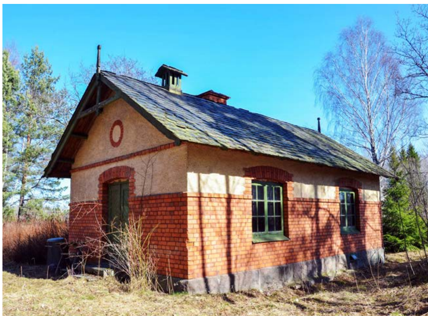
■ Den tidigare tvättstugan i intill platsen där Snytsbo station låg. Foto: Vlm-nbgsb-2156.
