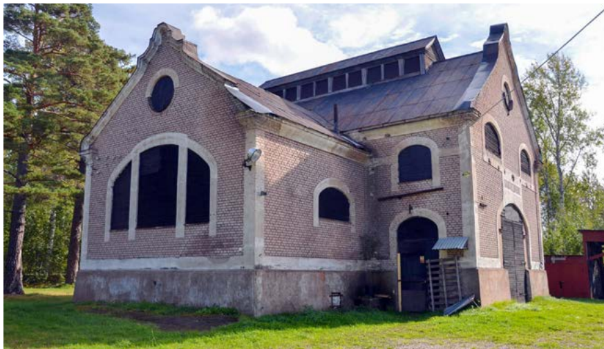
■ Kraftstation från 1910 belägen vid Mimerlaven. Foto: Vlm-nbgfe-1089.
