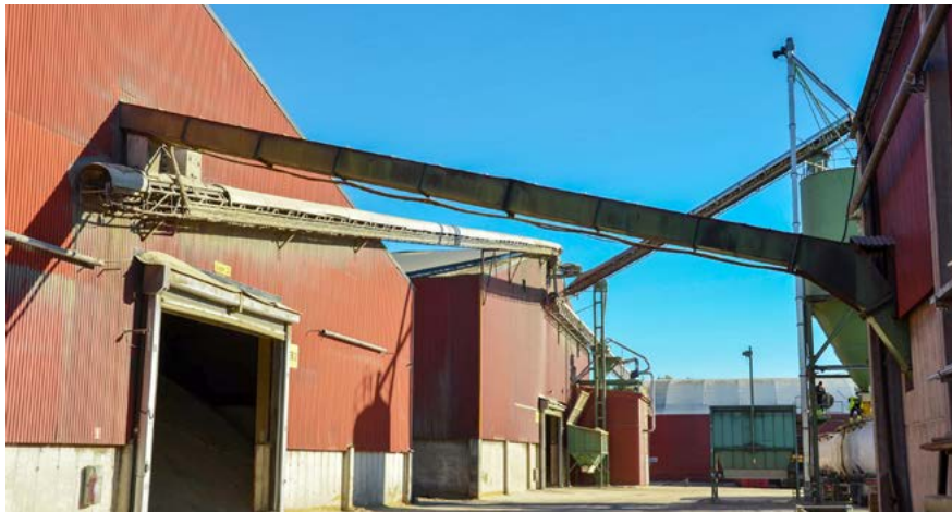
■ Industribyggnader vid Spännarhyttans norra del. Foto: Vlm-nbgsb-1379.
