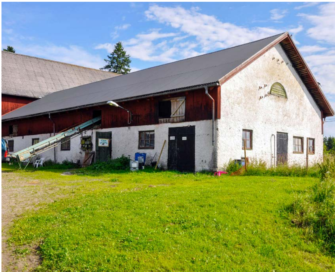
■ Ladugård på Stora Årnebo gård där stommen är putsad och träfasaden rödmålad. Foto: Vlm-nbgfe-786.
