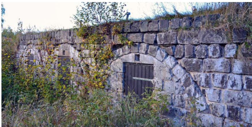
■ Längs riksväg 68 syns källare i slaggsten efter Spännarhyttans arbetarbostäder. Foto: Vlm-nbgsb-1458.
