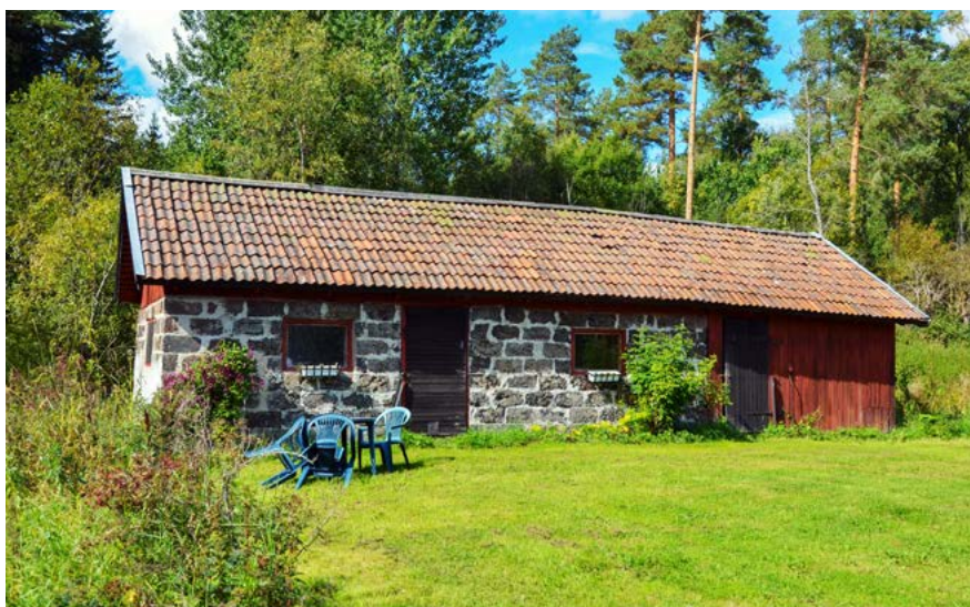
■ Ekonomibyggnad delvis uppförd i slaggtegel. Foto: Vlm-nbgsb-1030.
