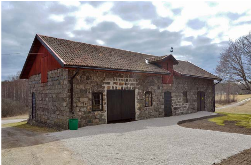
■ Ladugård från slutet av 1800-talet i Ön uppförd i det lokalt vanliga byggmaterialet slaggsten. Foto: Vlm-nbgsb-2338.
