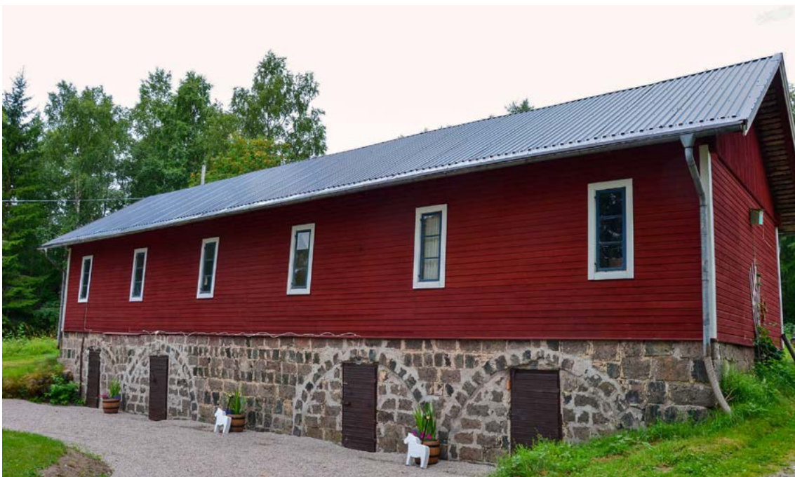
■ Förrådsbyggnad med slaggstensgrund. Foto: Vlm-nbgsb-746.
