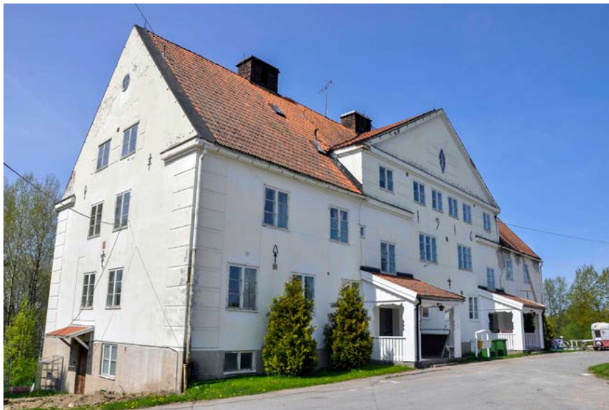
■ Byggnad uppförd år 1916 som under åren har använts för fattigvård, ålderdomshem och mentalsjukvård. Foto: Vlm-nbgfe-686.
