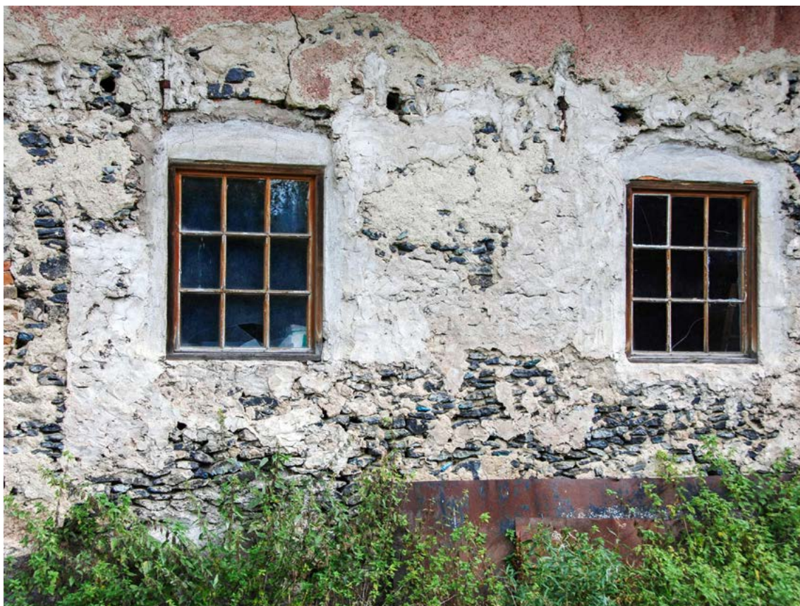
■ Detalj av ladugård uppförd med slaggsten. Foto: Vlm-nbgfe-22.
