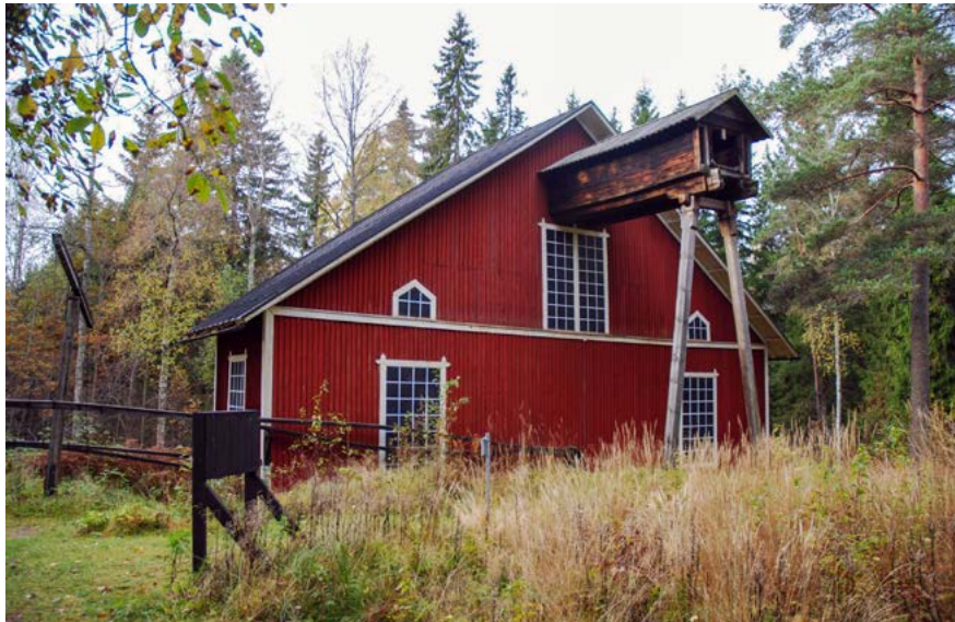
■ Byggnadsminnet Polhemshjulet med stora blindfönster sedd från norr. Foto: Vlm-nbgtn-759.
