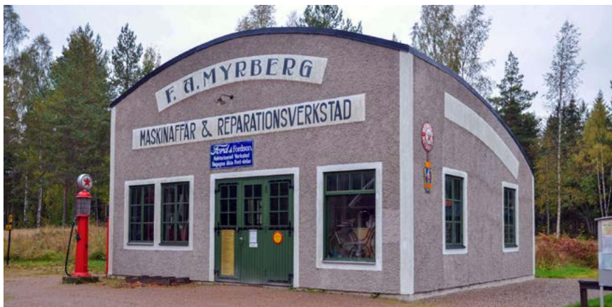
■ Myrbergs verkstad som troligen flyttades till Karlberg samtidigt som stationshuset. Foto: Vlm-nbgfe-1233.
