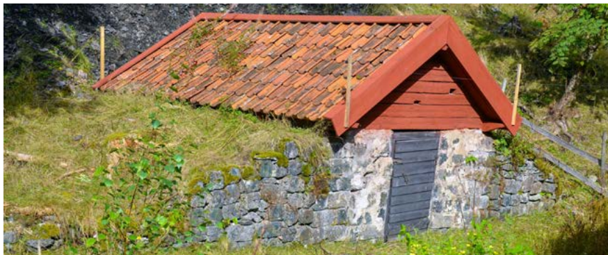
■ Dynamitkällare i slaggsten. Foto: Vlm-nbgfe-1014.
