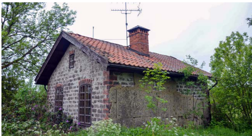
■ En stor gårdssmedja från sent 1800-tal i slaggsten. Foto: Vlm-nbgehw-1300.
