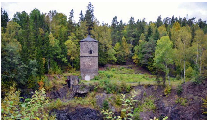
Exempel på bebyggelse i Gröndals gruvmiljö med gruvlave i slaggsten från 1880-talet. Foto: Vlm-nbgfe-1203.
