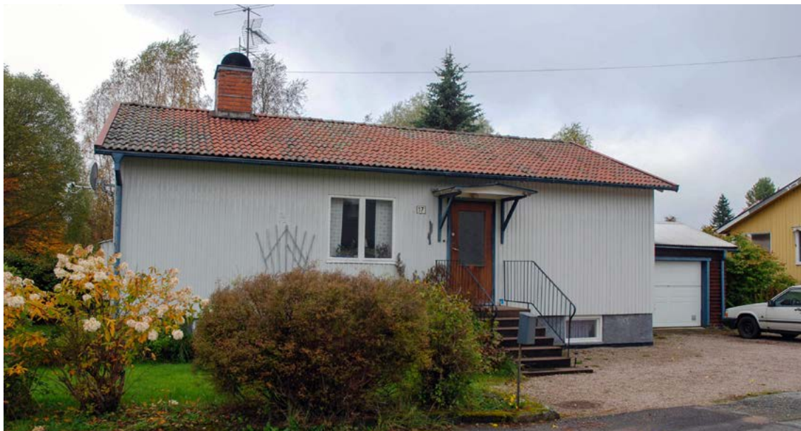
■ Exempel på kulturhistoriskt värdefull byggnad i området. Foto: Vlm-nbgtn-592.
