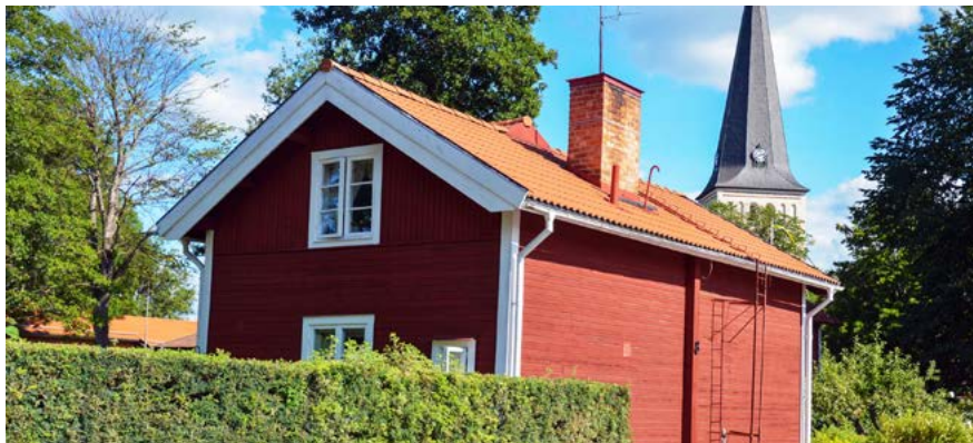
■ Falurödfärgad bebyggelse på kyrkbyns nordvästra utkant längs med Kvarngatan. Foto: Vlm-nbgfe-820.
