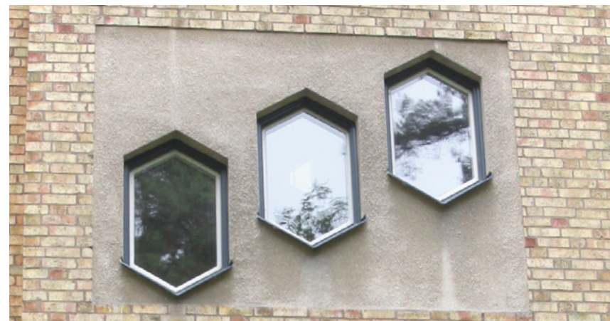
Trapphusen kunde markeras med flerkantiga fönster som tydligt talade om den separata funktionen hos utrymmet innanför.
