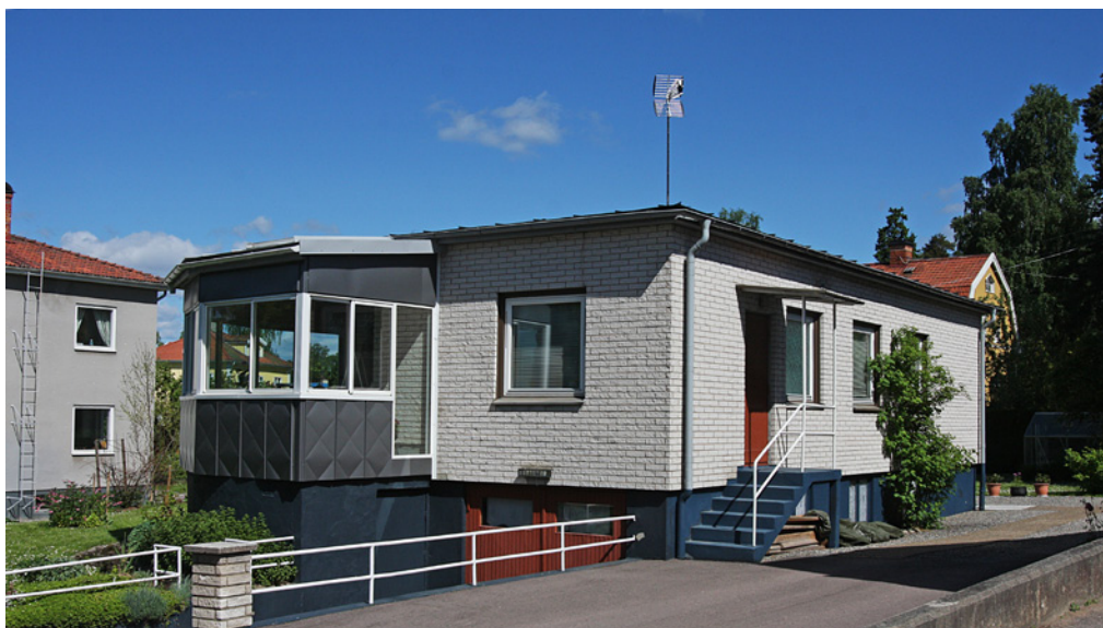
1960-talets fönsterbågar var oftast brunbetsade. Även kulör är viktigt att ha i åtanke vid ett eventuellt byte av fönster.
