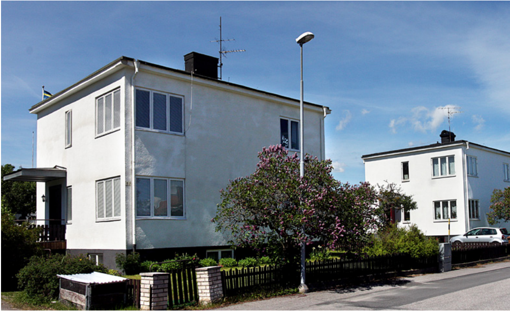
Stora fönster, placerade nära byggnadens hörn är mycket tidstypiskt för 1930-talets funktionalistiska bebyggelse.
