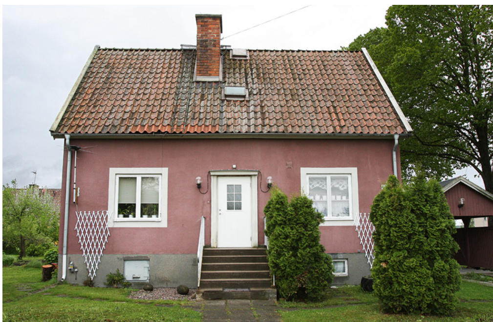
Både hängning och proportioner är viktiga. Ett sidohängt fönster bör inte ersättas med ett pivåhängt.
