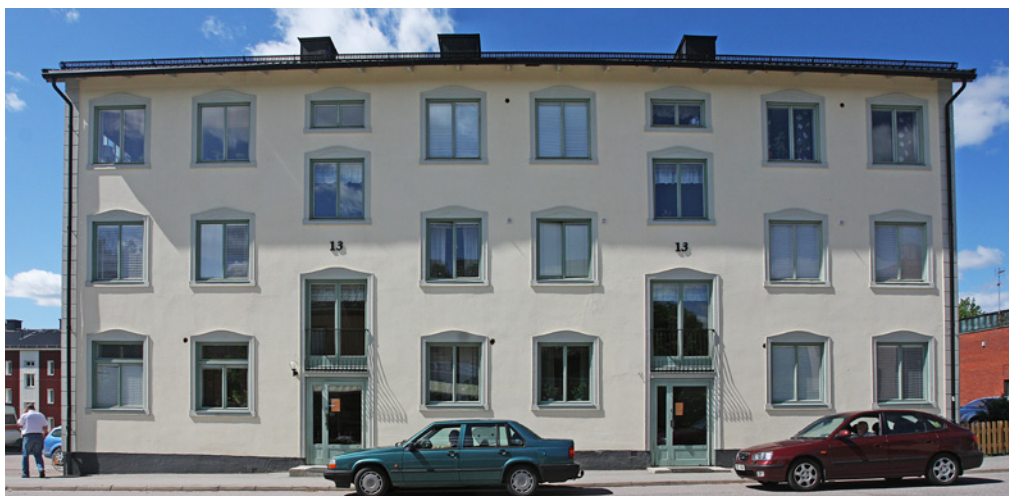
Regelbunden fönstersättning med tunna originalbågar. Att renovera fönstren är ofta både en antikvarisk och ekonomisk vinst jämför med ett byte.
