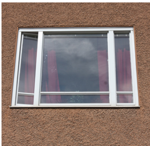
| Fönster med asymmetriskt placerad spröjs.
