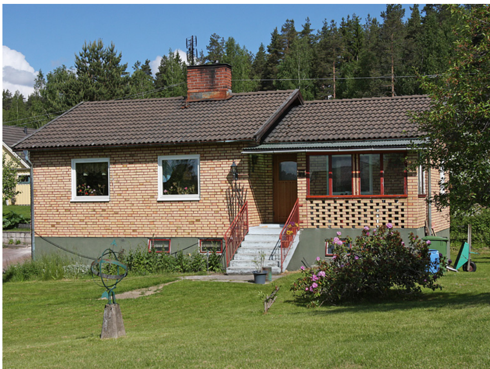
| På 1950-talet blev det vanligt med större, i det närmaste kvadratiska fönster.
